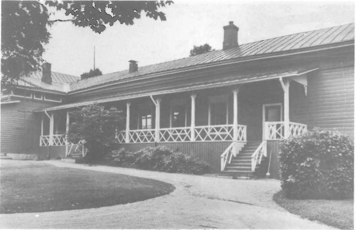
Kauppalan virastotalo pihan puolelta.
