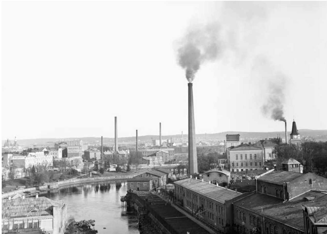
Kuva 13. Näkymä Tammerkoskelle kohti etelää Satakunnan sillan paikkeilta Tampellasta katsottuna 1930-luvulla. Kuvan oikeassa reunassa näkyvät Frenckellin rakennukset. Kookkain piippu on Frenckellin piippu. Vanhan kirkon tapuli näkyy kuvan oikeassa reunassa. Sen ja korkeimman piipun välissä näkyvät kirjastorakennuksen pääty ja osa teatterirakennuksesta. Kirjaston molemmin puolin on puistoa. Pannuhuoneen ympärillä ja lumppusiiven edustan penkereellä ei vielä kasva puita. (Frenckell, rakennushistoriallinen selvitys, 2019 [Tampereen museot, kuva-arkisto. Numero: 448:7925].)
