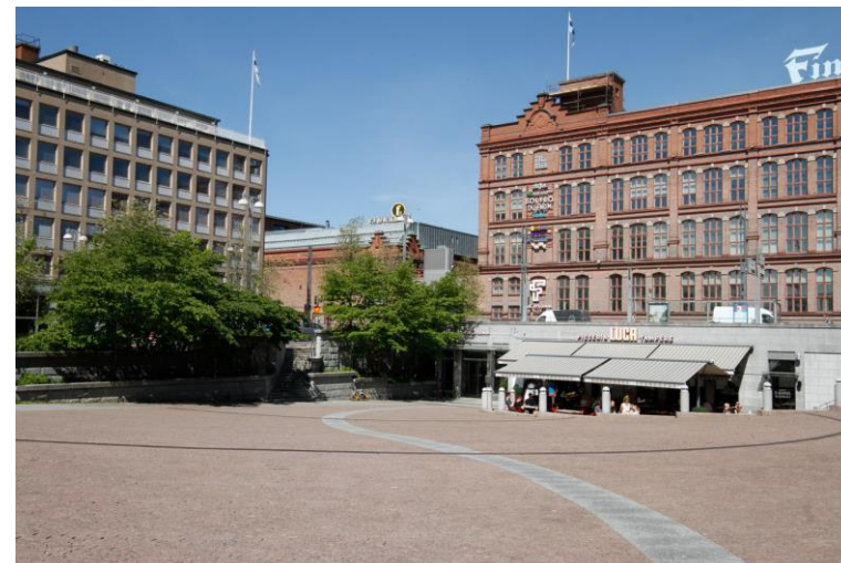
Kuva 36. Näkymä Frencellin edustalta Frencellin aukion yli kohti Satakunnan katua ja kadun alle rakennettuja liiketiloja.
