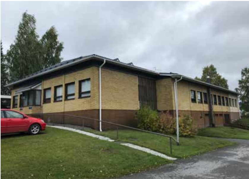
Terveysasema kuvattuna idästä. Kuva: Olli Joukio
