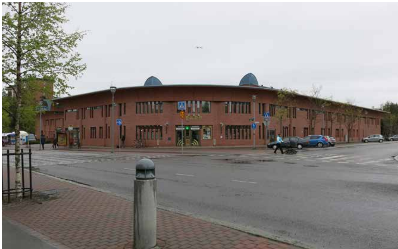
Hervannan Toimintakeskus, terveysaseman julkisivu. Kuva: Anna-Leena Lehto 2014
