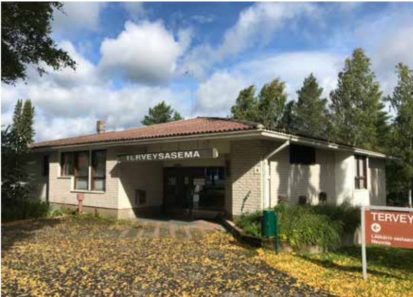
Terveysasema kuvattuna lounaasta.
