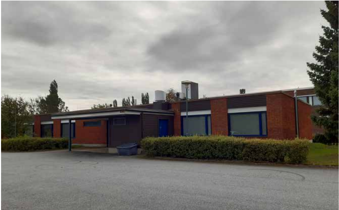
Terveysasema kuvattuna pohjoisesta. Kuva: Olli Joukio
