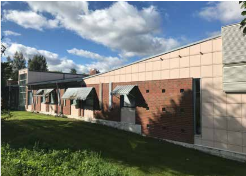
Terveysaseman kaakkoissivua kuvattuna idästä. Kuva: Olli Joukio
