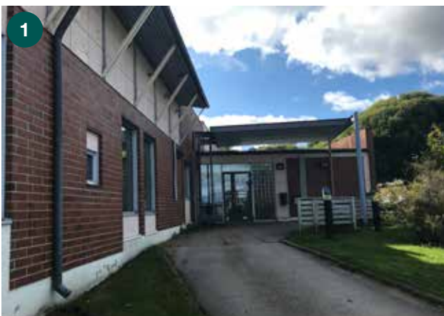
1 Terveysaseman pääsisäänkäynti koillisesta.
