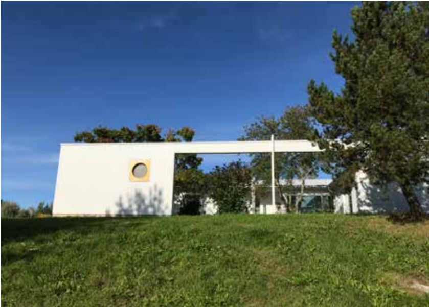
Pergolaseinämä/varasto kuvattuna etelän suunnalta. Kuva: Olli Joukio
