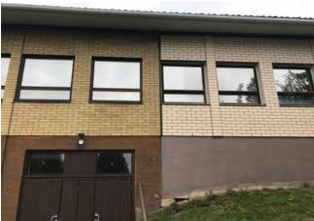
Vuonna 1990 valmistunut laajennus on toteutettu sopimaan alkuperäisilmeeseen, mutta erottuu väritään selkeästi rakennuksen julkisivuilla. Kuva: Olli Joukio
