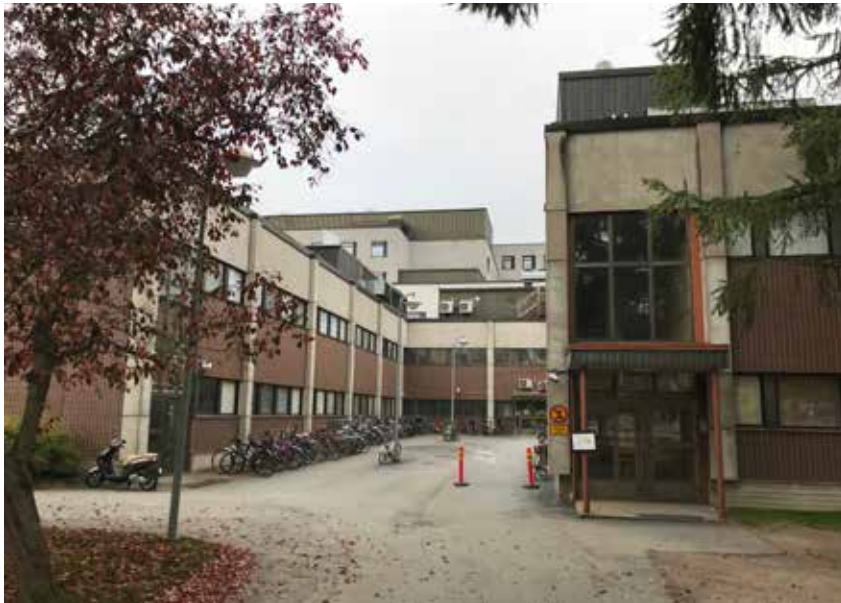
Terveysasema kuvattuna idästä. Kuva: Olli Joukio
