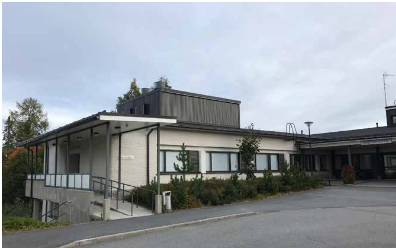
Terveyskeskuksen länsipäädyn neuvolan sisäänkäyntiparveke ja oikealla pääsisäänkäynti. Kuva: Olli Joukio
