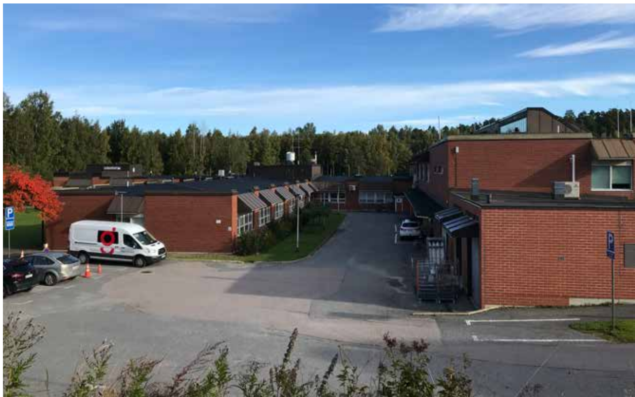
Rakennuksen alkuperäistä, vuonna 1984 valmistunutta osaa kuvattuna lounaasta. Kuva: Olli Joukio
