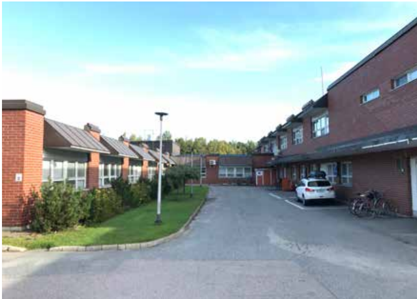
Rakennuksen alkuperäistä, vuonna 1984 valmistunutta osaa kuvattuna lounaasta. Kuva: Olli Joukio
