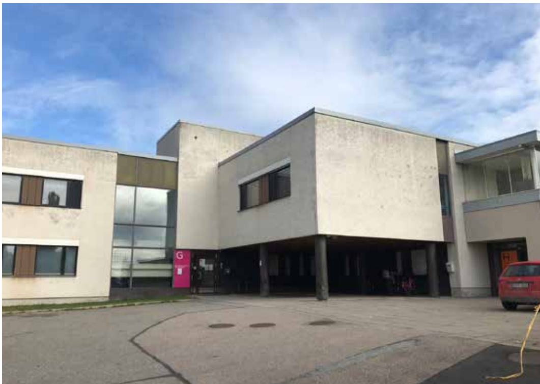
Terveyskeskuksen osasto 1:n sisäänkäynti. Kyseessä ilmeisesti alkuperäinen pääsisäänkäynti terveyskeskukseen. Kuva: Olli Joukio
