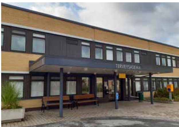
Terveysaseman pääsisäänkäynti kuvattuna kaakosta.
