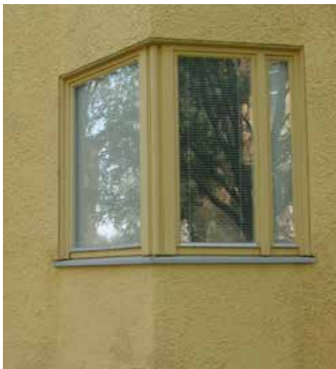
Kunnostettu erkkeri-ikkuna, as.oy Koskentie
