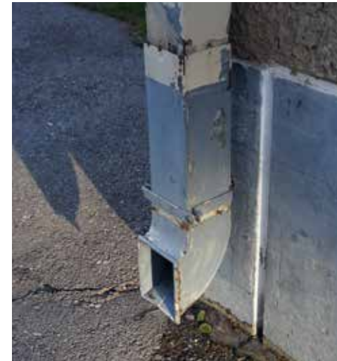
Alkuperäinen paikalla maalattu syöksytorvi, as.oy Sammonkatu 21-23
