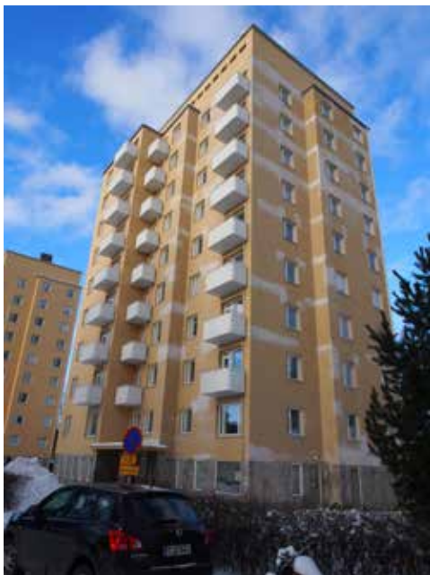
Rappauksen paikkauskorjausta as.oy Ilmarintorneissa
