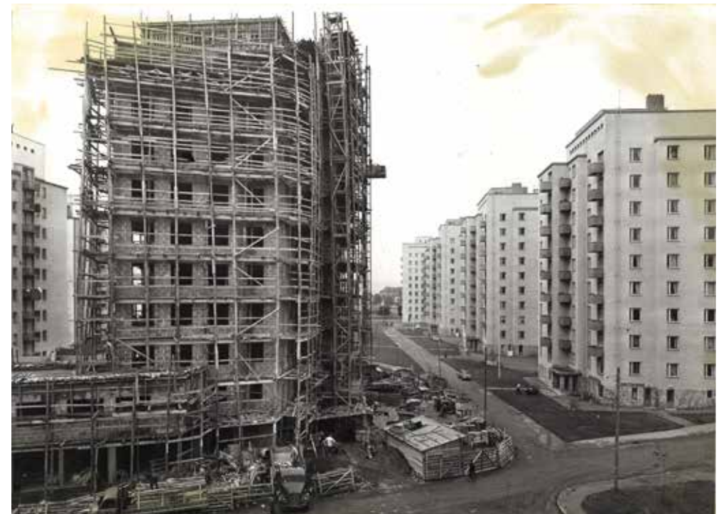
Kalevan tornit, viimeinen, nk. miljoonatorni rakenteilla vuonna 1955. Kuva E. M. Staf, Tampere-seuran kuva-arkisto.
