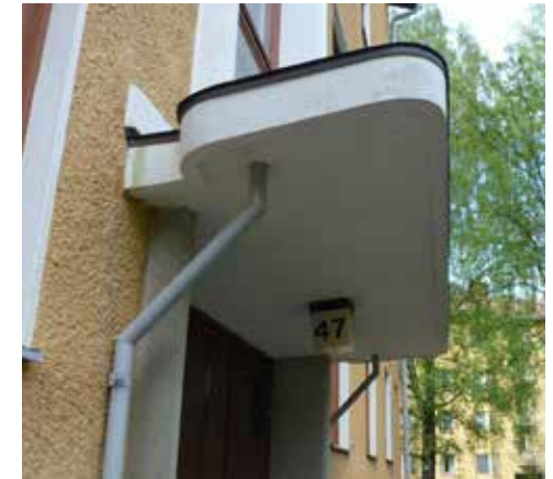
Porrashuoneen sisäänkäynnin betonirakenteinen katos, as.oy Koskentie.
