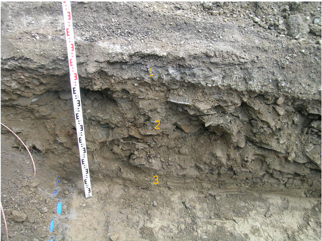
Kuva 2. Maakaapelikaivannon koillisprofiliia. Kuvassa erottuvat 1) sorapäälyste ja sen alapuoliset asfalttikerrokset asennushiekkoinen, 2) kivikerros (nykyaikainen tierakenne), 3) pohjasavi. Kuva: Sami Raninen. KYY 160:3.
