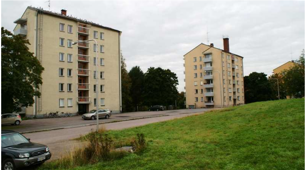
Kylmänojankadun pistetaloja. Yhtenäisen talonryhmän perässä, Kylmänojankadun päässä on arkkitehti Aarne Heinon suunnittelema pistetalo, joka valmistui vuonna 1964 kauppalan vuokrataloksi, ja uusi vuonna 1999 valmistunut pistetalo.
