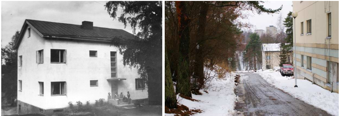
Välikatu 2 kivirakennus on säilynyt suuremmilta muutoksilta. Sisäänkäynnin lippa on vaihdettu peltiseen. Kuva Nokian kaupungin valokuvakokoelmasta.
