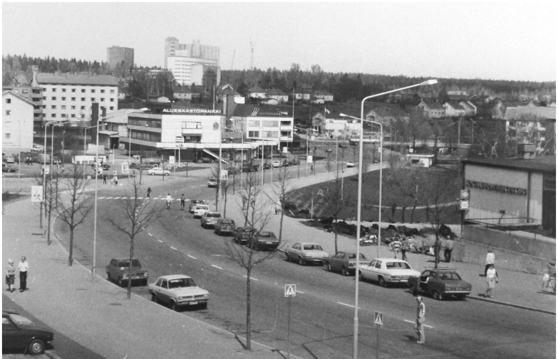
Kuvassa Härkitien ympäristöä n. 1970-luvun lopulla. Keskellä Aluesäästöpankki ja Pelkosen talo, johon on jo muuttanut Osuuspankki. Osuuspankkitalo on rakennusselostuksen mukaan perustettu kokonaan puupaalutuksen varaan, kantava runko on teräsbetonista, lisäksi kennotiilimuuraus, välipohjina teräsbetonilaatat. /Nokian kaupungin valokuvakokoelma
