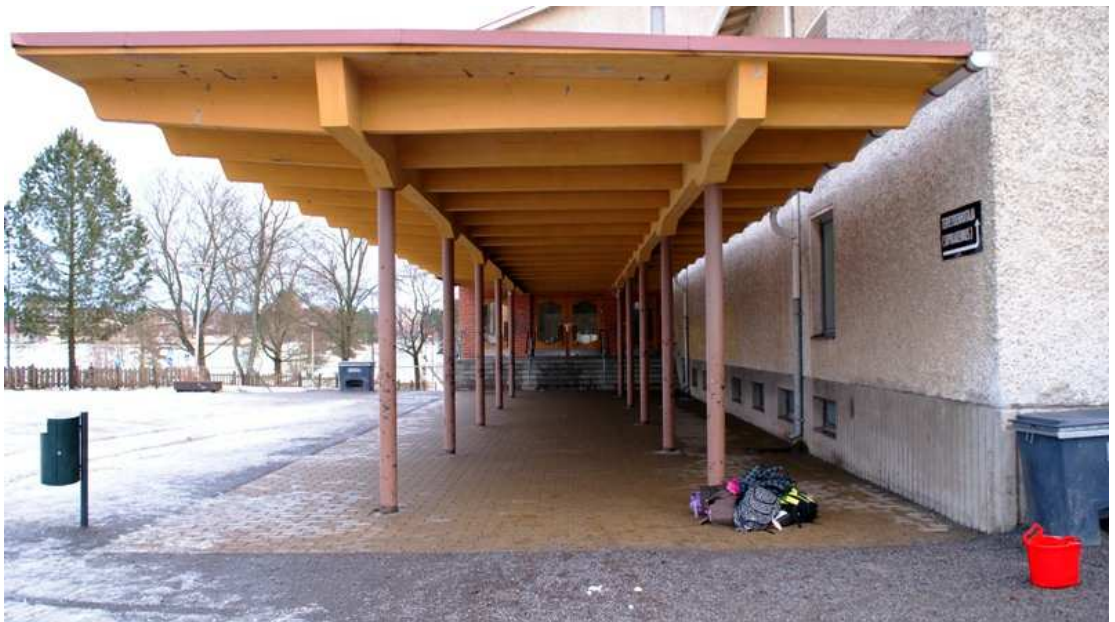
Kankaantaan koulun katos pääsisäänkäynnin edustalla. Rakennus on säilynyt erittäin hyvin alkuperäisessä asussaan.
