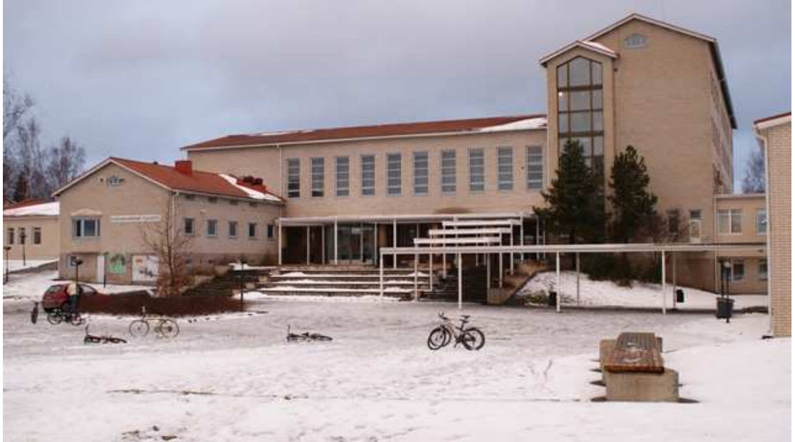
Nokianvirran koulun vuonna 1954 valmistunut rakennus, johon liittyy kuvan ulkopuolelle jäävät, kokonaisuuteen hyvin sovitetut laajennusosat
