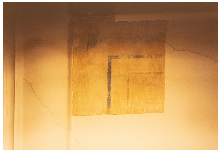
Porrashuone 121 kattomaalausta länsisivulla. 1. kerros sin. leveä raita 2. kerros sin. ja pun. kapeat raidat. Väritutkimus, valokuvat 7.10.1997. AF
