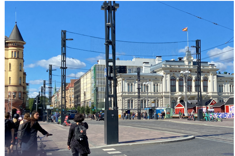
Näkymä Keskustorilta kohti raatihuonetta elokuussa 2024
