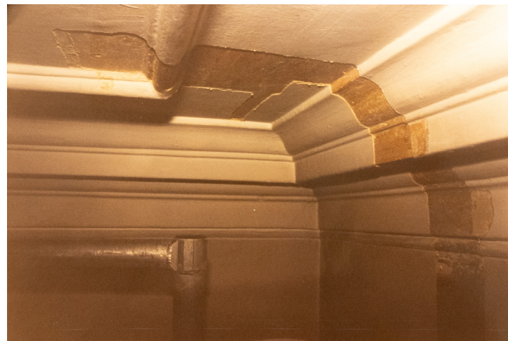
Huone 127 eteläseinä oik. Väritutkimus, valokuvat 7.10.1997. AF
