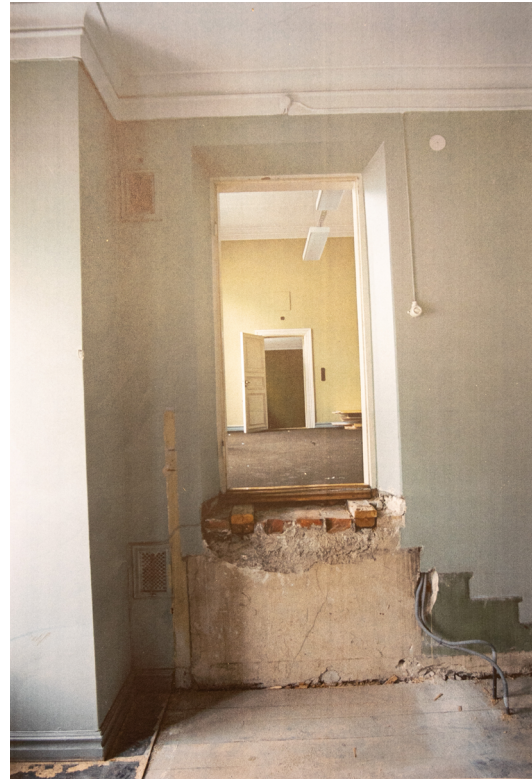
Kuva 2000-luvun alusta ennen peruskorjausta. AF
