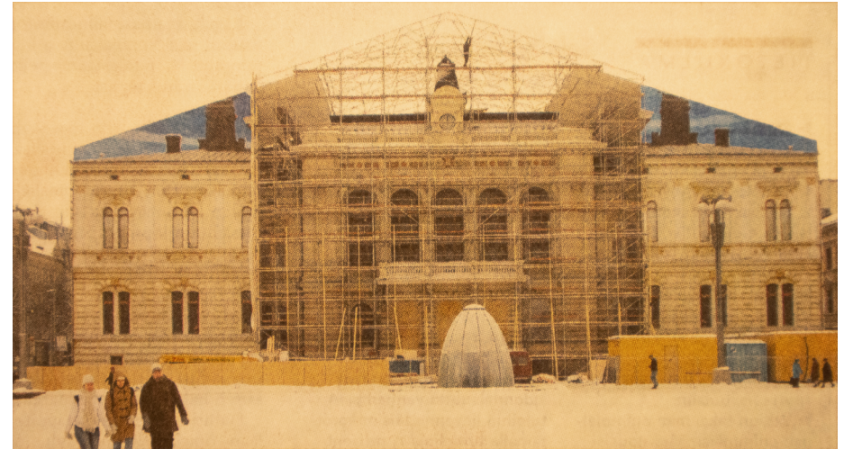
Raatihuoneen näköispeitettä ollaan asentamassa rakennustelineille. Näköispeitteeseen oli käsin maalattu kuva raatihuoneesta. Reijo Hietanen Helsingin sanomat 27.2.2004. AF
