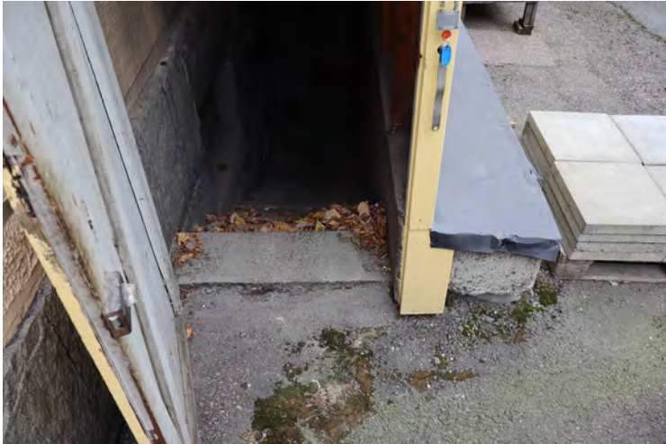
Kellariin johtava ulkoporras on alkuperäinen. Porrasta on kavennettu 1970-luvulla ja katos on rakennettu tämän jälkeen.
