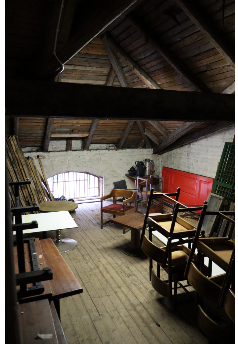
Ullakon parvi jonka alkuperäisessä ikkunassa on kalterit
