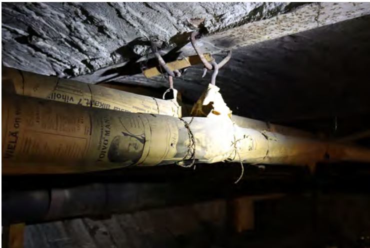
Kellarin putkistoa on peitetty 1940-luvun sanomalehdillä
