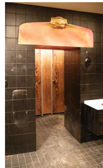
→ Pankinjohtajien kokous- huoneessa sijainnut oven paikka näkyvissä naisten wc-tilassa.
