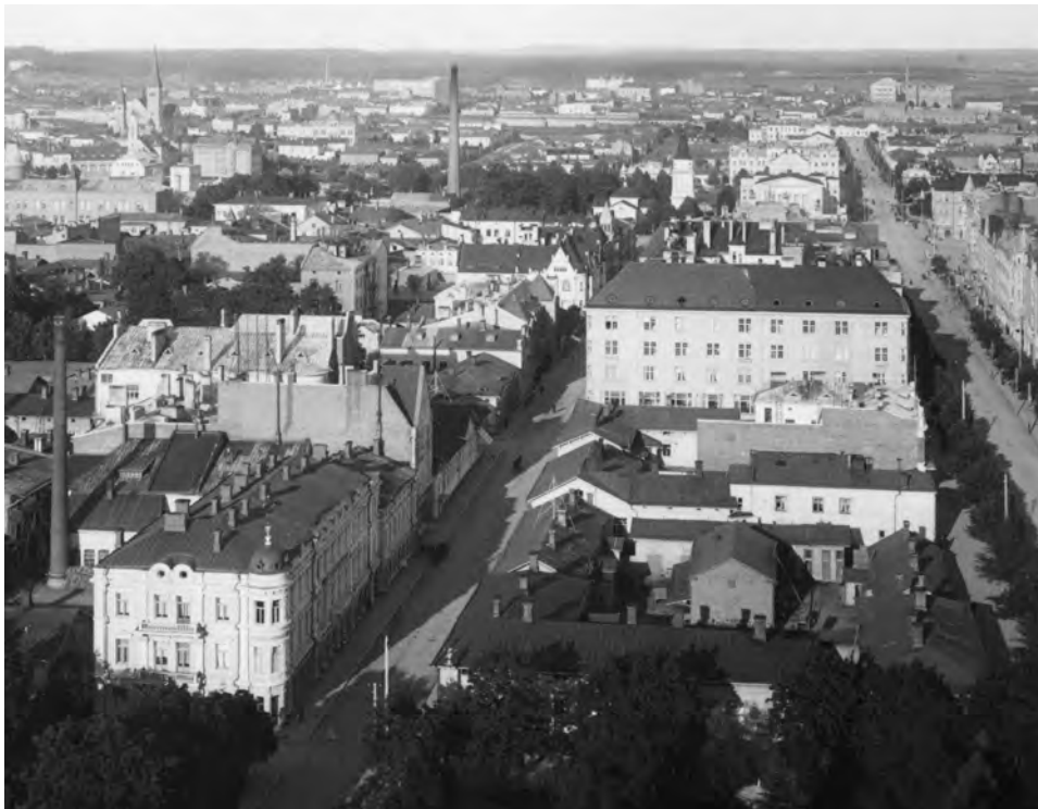
1920-08-10 Eino Antero Bergius Näkymä Tampereen keskustaan kuvattuna Aleksanterin kirkon ristin korjaustelineiltä VKA
