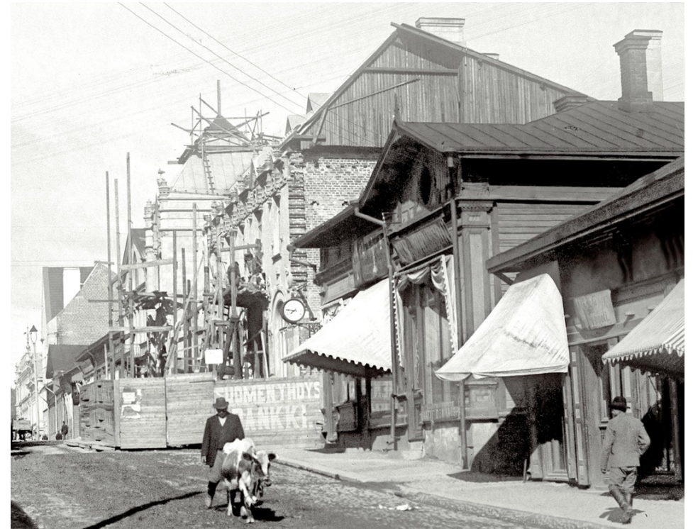
Kauppakatua Suomen Yhdyspankin rakentamisen aikaan. Nyt edellinen liikerakennuskin on purettu kokonaan. Pankkirakennuksen ensimmäinen rakennusvaihe on juuri valmistunut, mutta itäinen pääty puuttuu vielä kokonaan. William Lomax, VKA
