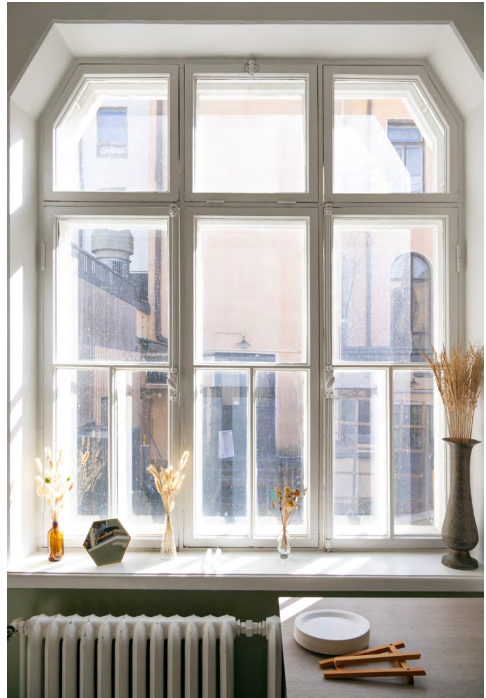
Alkuperäinen etelään on sisäännavautuva pieniruutuinen ikkuna espanjoleteilla.
