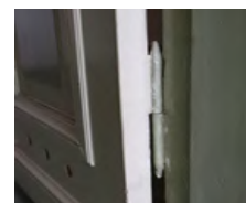
→ Alkuperäinen ovi eteläisessä huonetilassa
