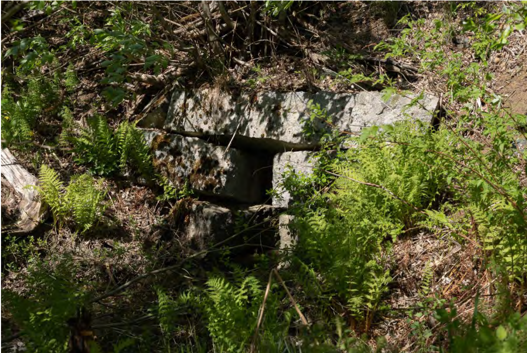
Kuva 202. Alkuperäinen Hämeenlinnan–Tampereen rataosan tyyppirumpu Ihalemman oikaisussa 2000-luvun alussa hylätyllä linjalla. Mikko Itälahti 23.5.2024.
