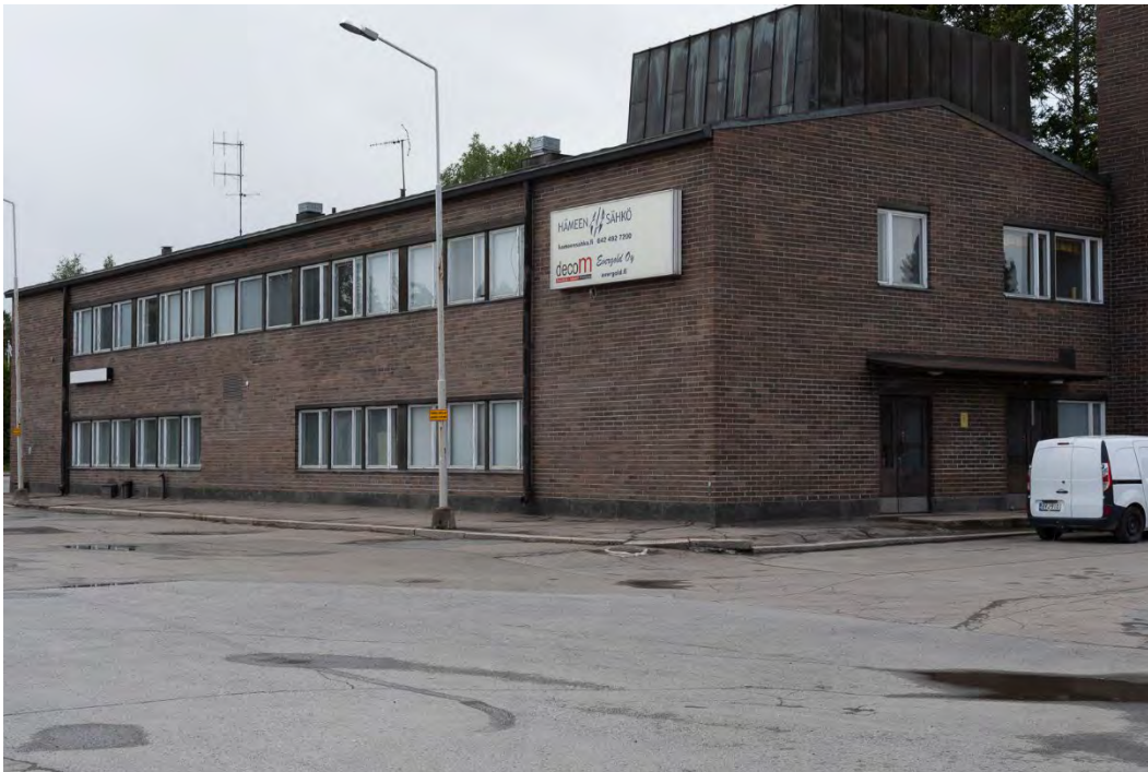
Kuva 75. Alkujaan postitaloksi valmistunut rakennus Toijalan asema-alueella. Mikko Itälahti 7.6.2024.
