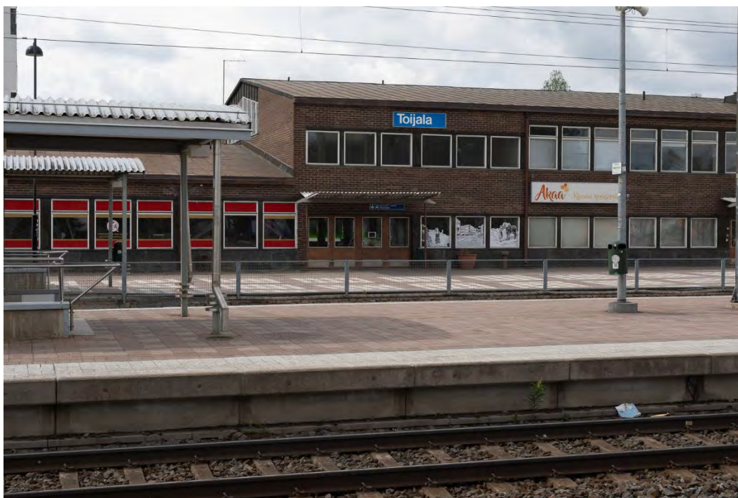
Kuva 74. Toijalan 1963 valmistunut asemarakennus. Mikko Itälahti 7.6.2024.
