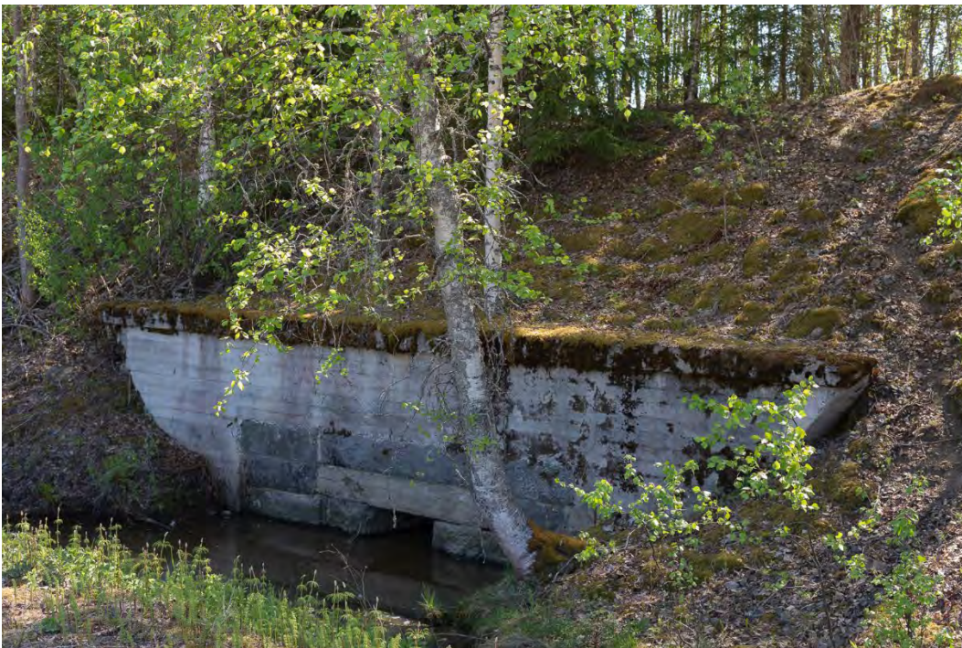
Kuva 203. Ihalemman rummun betonoitu pohjoispää. Rumpua jatkettiin 1960 valmistunutta kaksoisraidetta varten. Mikko Itälahti 23.5.2024.
