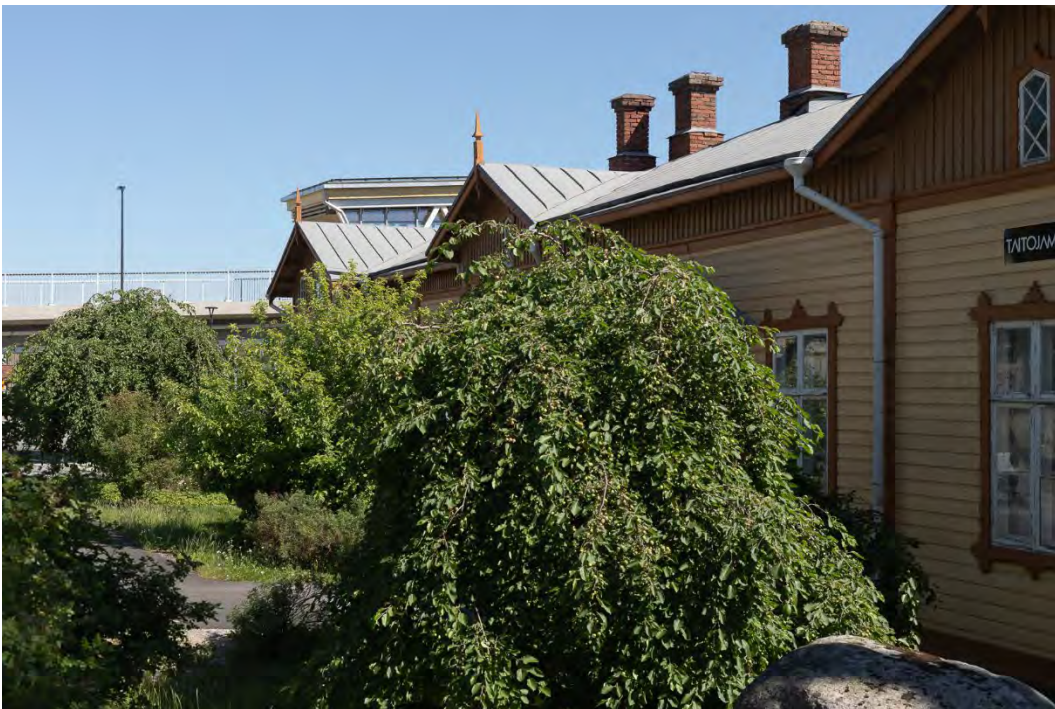
Kuva 93. Lempäälän asemarakennuksen puiston puolella on säilynyt mm. ryhmä rautatieomenapuita. Mikko Itälahti 26.6.2024.
