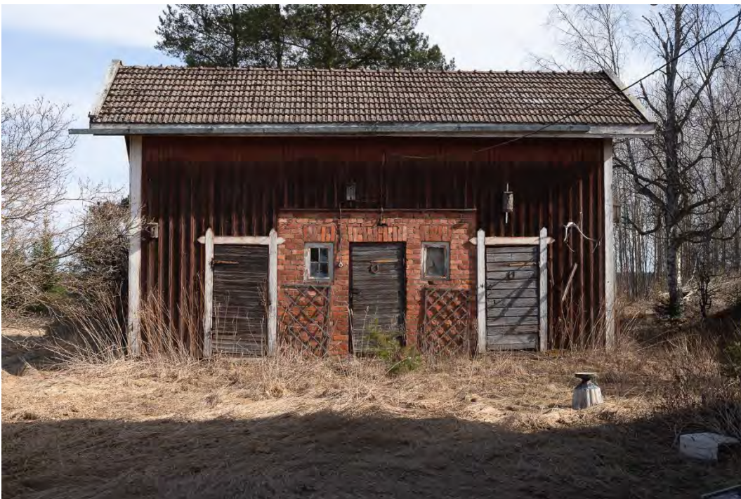
Kuva 72. Osin tiilirakenteinen navettarakennus Kuurilan asema-alueen eteläpäässä. Mikko Itälahti 9.4.2024.
