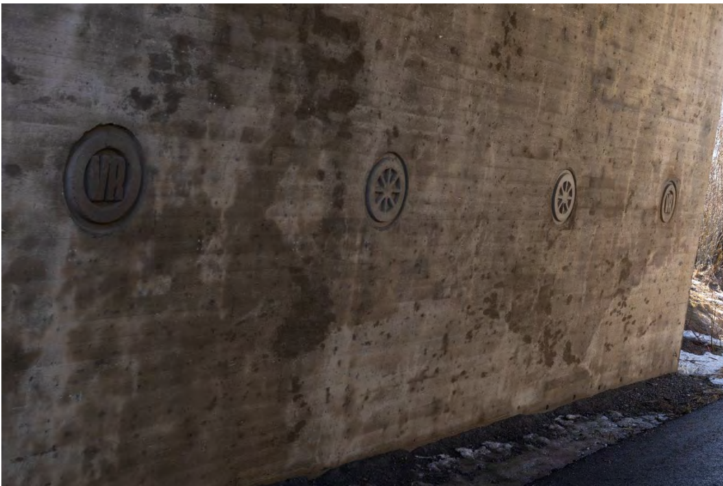
Kuva 199. Pappilan alikulkusillan betonirunkoon on valettu VR-tunnus ja siipipyöräkoristeluja. Mikko Itälahti 8.4.2024.
