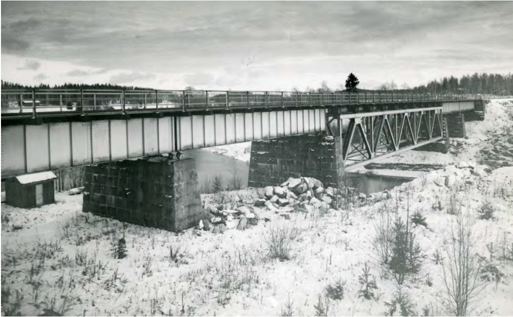
Kuva 185. Leppäkosken 1921 valmistunut uusi terässilta. G. Rafael Roos (Suomen Rautatiemuseon kuvaarkisto, SRMV1: 9429).
