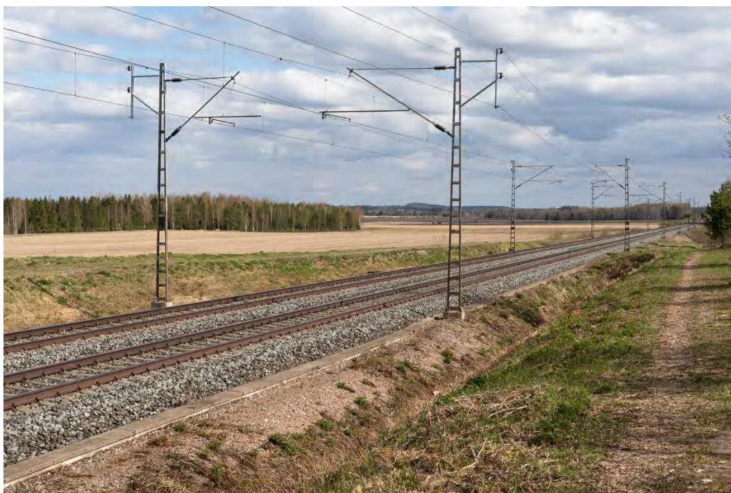
Kuva 177. Pääradan nykytilaa tyypillisimmillään kilometrillä 84. Osuus Riihimäen ja Hämeenlinnan välillä kaksiraiteistettiin 1955–1958 ja sähköistettiin 1970–1974. Kuva-alan keskivaiheilla toimi Kelhän seisake vuosina 1958–1977. Mikko Itälahti 6.5.2024.
