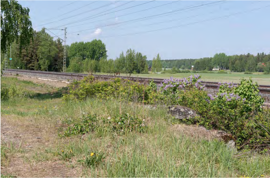
Kuva 140. Suorakaiteen muotoinen kivijalka osoittaa, että kilometrin 122 vahtitupa sijaitsi tyypilliseen tapaan pääty radalle päin. Kalliolle perustetun rakennuksen sokkeli oli matala. Talonpaikan poikki kulkee huoltotie. Mikko Itälahti 30.5.2024.
