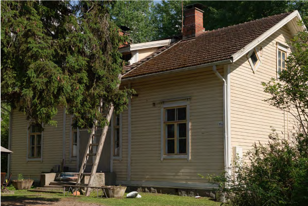
Kuva 52. Parolan asema-alueen eteläisin rakennus muistuttaa esim. Granholmin Karjaan–Turun rataosuuden suuremman tyypin kaksoisvahtitupaa vuodelta 1897.
