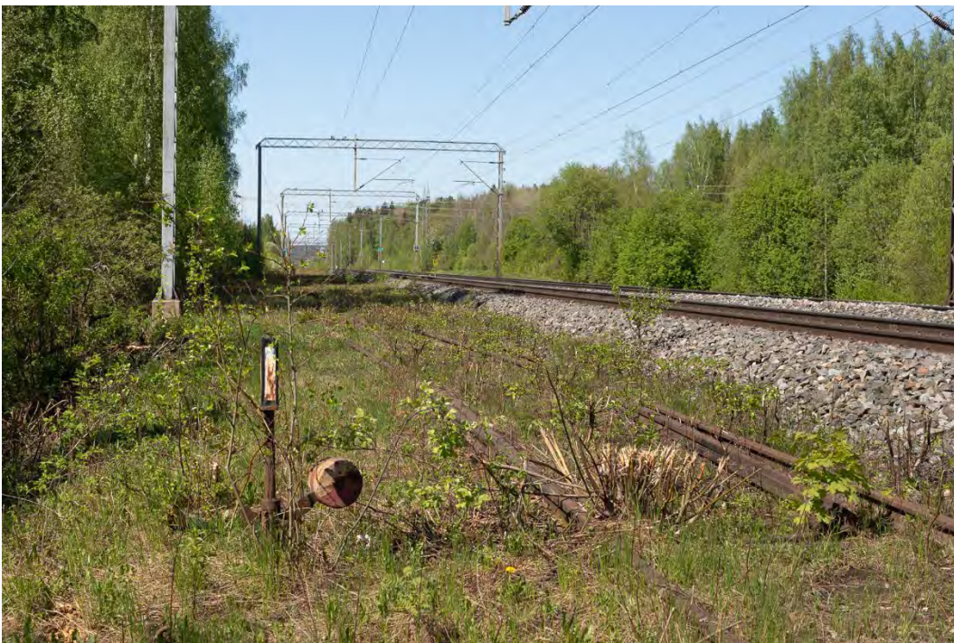
Kuva 111. Pistoraiteet lukuisille Hämeenlinnan teollisuuslaitoksille haarautuivat vuoteen 1960 mennessä rakennetulta yhdys- tai vetoraiteelta. Etualalla Vanajan voimalaitoksen raiteiston käsikäyttöinen vaihde. Mikko Itälahti 17.5.2024.
