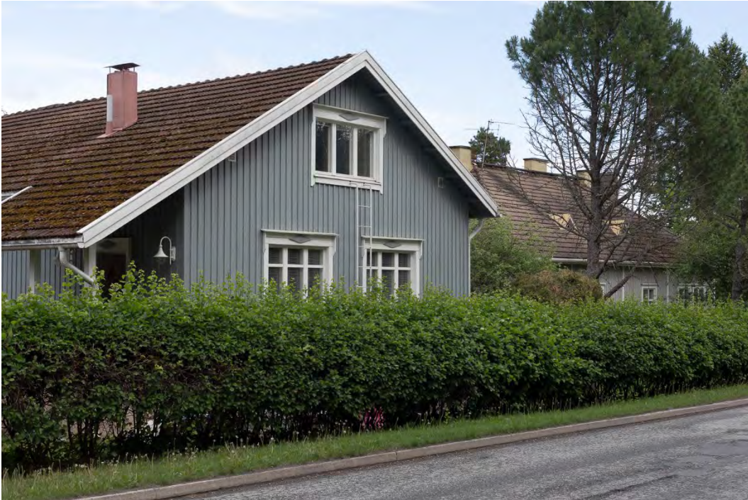
Kuva 76. Pohjoispään asuinrakennuksia. Kuvassa etualalla 1930-luvulla valmistunut Pätsiniementie 4G ja taustalla aumakattoinen, vuonna 1918 valmistunut paritalo osoitteessa Pätsiniementie 4F. Mikko Itälahti 7.6.2024.
