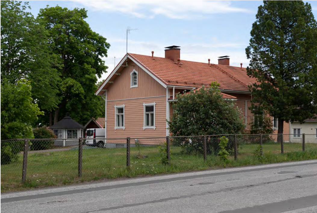
Kuva 78. Ratamestarin ja asemapäällikön asuntona toiminut rakennus Pätsiniementien varressa. Mikko Itälahti 7.6.2024
