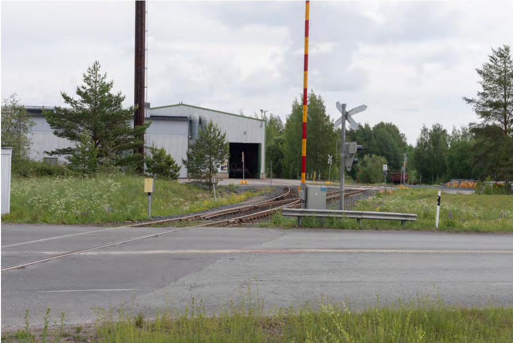
Kuva 117. Liikenne Toijalan satamaradan alkuosalla jatkuu SSAB:n teräsvarastolle. Taustalla liikennöimätön linjaosuus laskeutuu kohti Lontilanjoen siltaa. Mikko Itälahti 7.6.2024.
