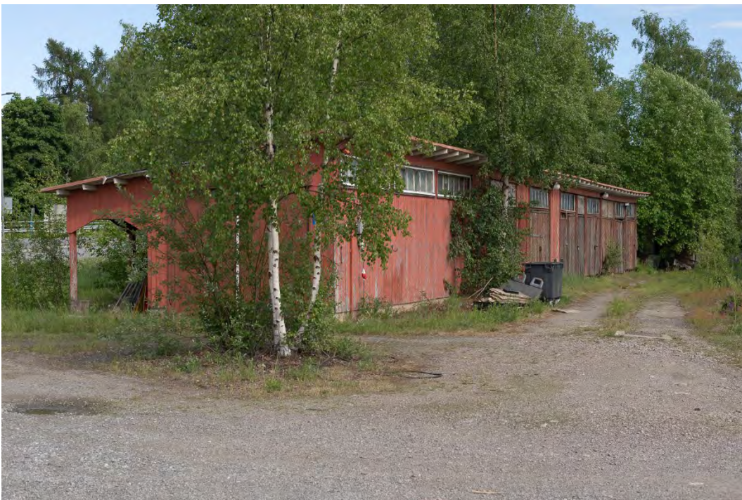
Kuva 87. Todennäköisimmin 1930- tai 1940-luvulle ajoittuva lautarakenteinen vajarakennus Toijalan rata-piha-alueen kaakkoispuolella. Mikko Itälahti 7.6.2024.
