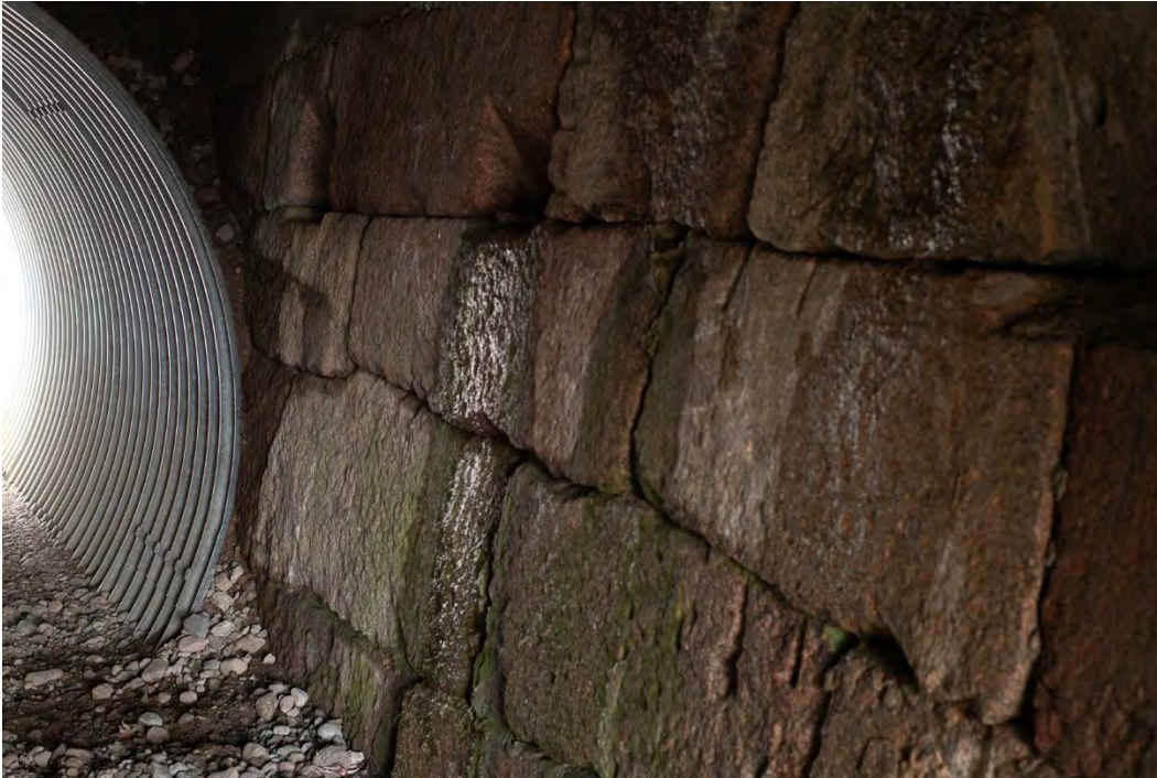
Kuva 197. Tiilitehtaan alikulkusilta leppäkoskella. Mikko Itälahti 12.4.2024.
