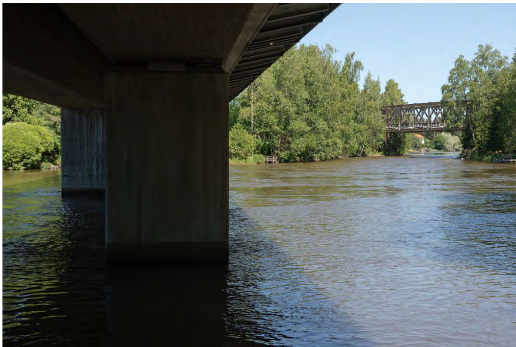
Kuva 193. Näkymä nykyiseltä siltapaikalta. Vanha linjaus ristikkosiltoineen oikealla. Mikko Itälahti 26.6.2024.
