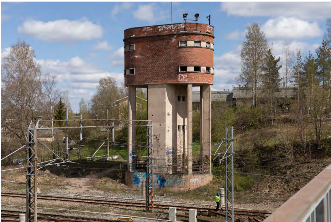
Kuva 22. Riihimäen 1935 valmistunut vesitorni. Mikko Itälahti 6.5.2024.
