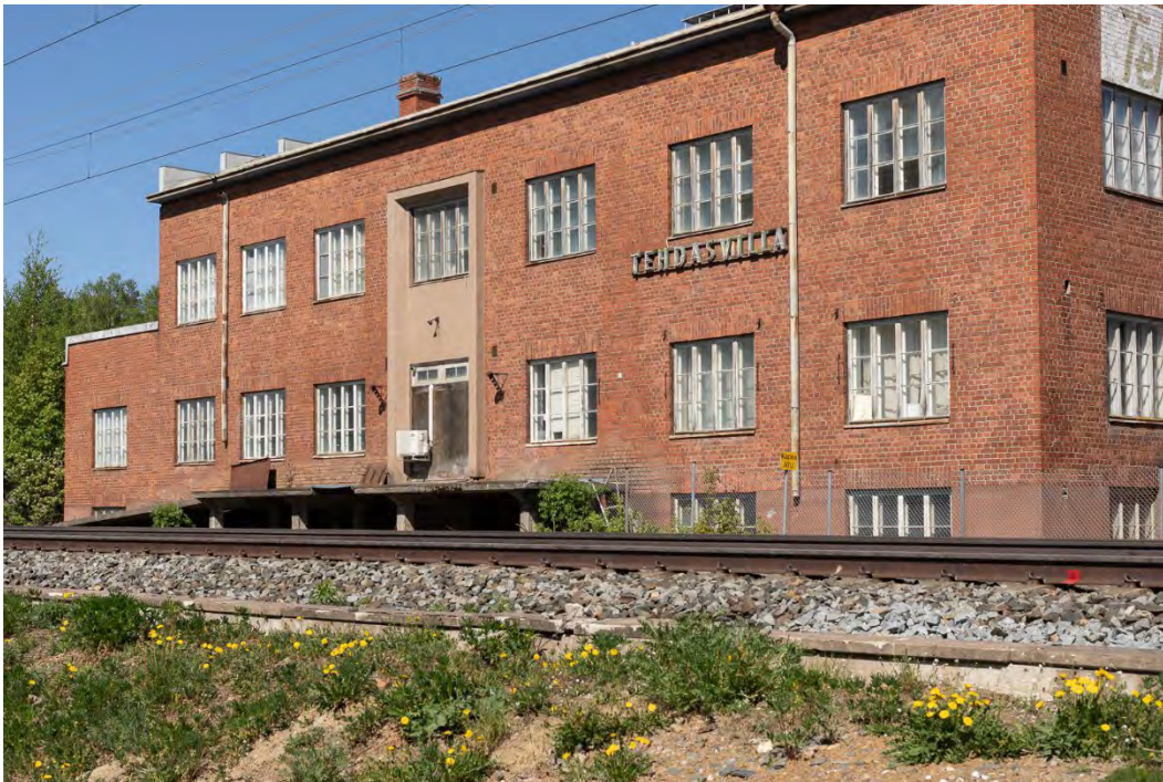
Kuva 115. Tehdasvilla oy:n (vuoteen 1956 asti Marja oy) 1935 valmistunut toimitilarakennus Parolan aseman pohjoispuolella, linjaraiteiden itäpuolella kulkevan Rietoon teollisuusraiteen varressa. Mikko Itälahti 22.5.2024.
