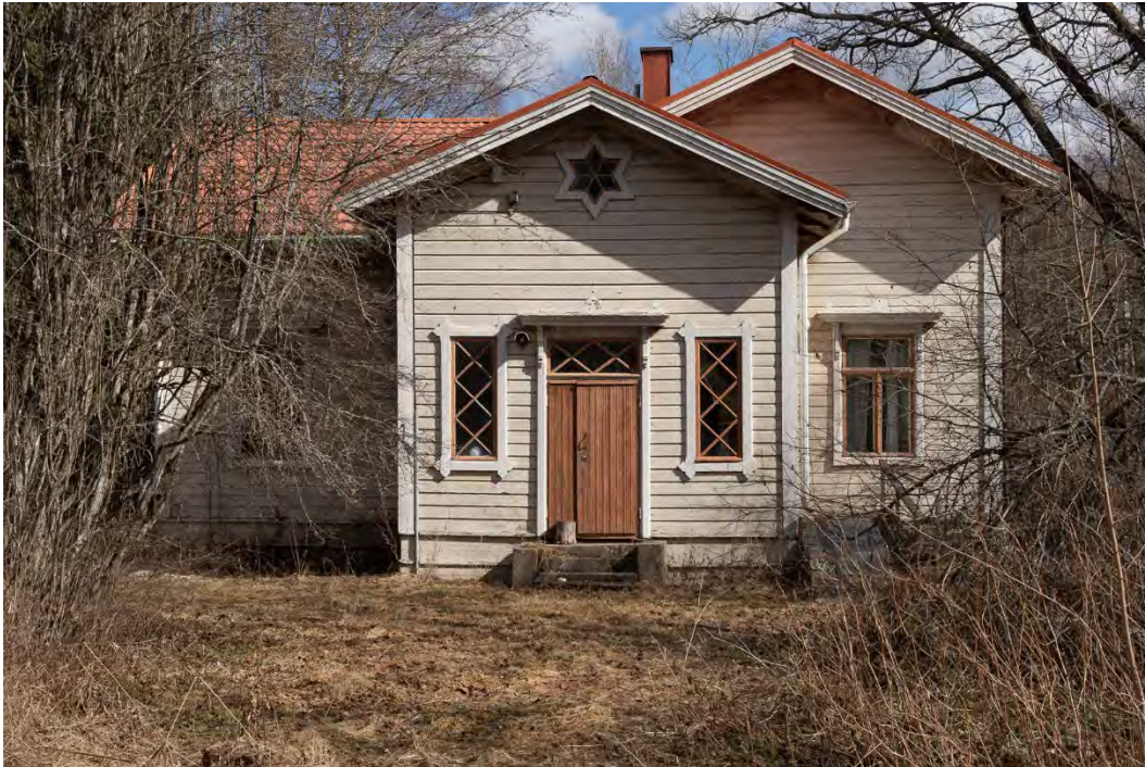
Kuva 33. Leppäkosken asemapäällikön asuinrakennus. Mikko Itälahti 12.4.2024.
