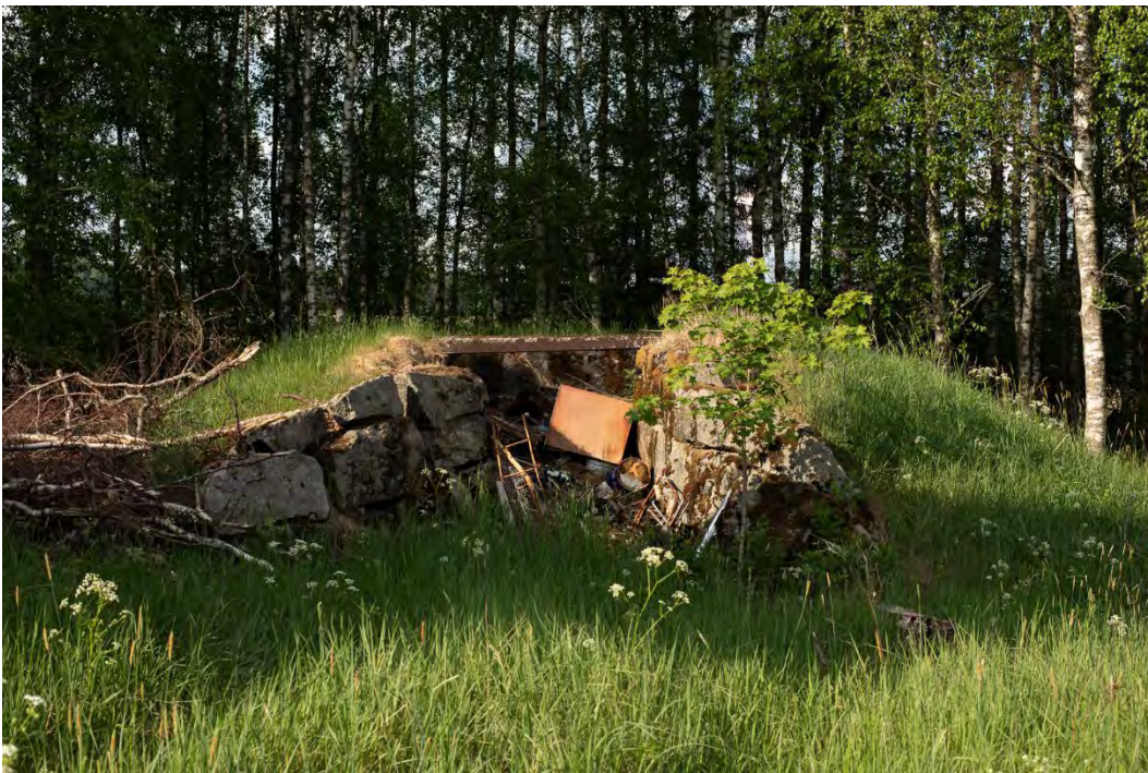
Kuva 68. Asemapäällikön asunnon kellarin perustus Kuurilassa. Mikko Itälahti 3.6.2024.
