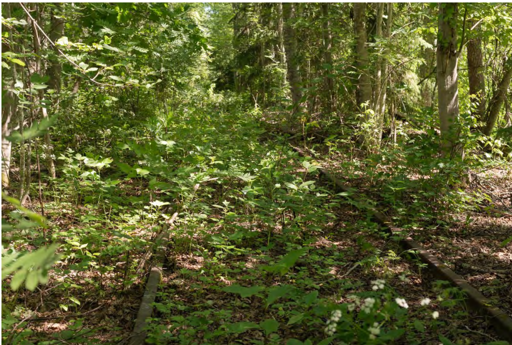
Kuva 119. Viialan vaneritehtaan raiteita. Raiteiston liikennöinti on päättynyt 2004. Mikko Itälahti 18.6.2024.
