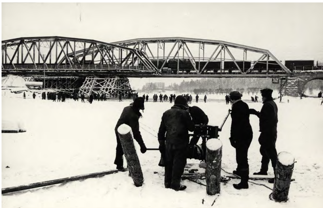
Kuva 187. Vanajaveden läntisen siltajänteen paikalleen veto tapahtui kirpeässä pakkassäässä siirtovaunujen, proomujen ja vintturien avulla. Onni Lehtonen / VR, 12.1.1960 (SRM/VR1: 5653).
