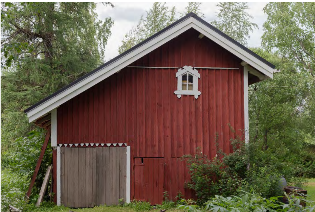
Kuva 148. Hulauksen vahtituvan ulkorakennuksen pääty. Mikko Itälahti 19.6.2024.
