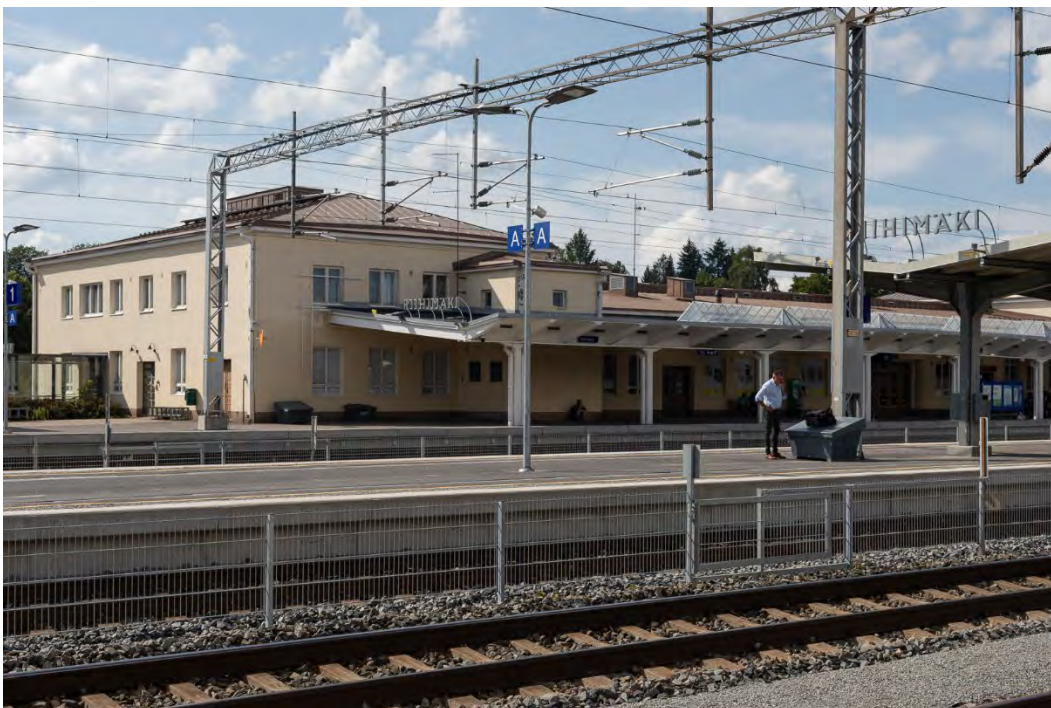
Kuva 20. Riihimäen 1935 valmistunut asemarakennus radan puolelta. Mikko Itälahti 26.7.2024.
