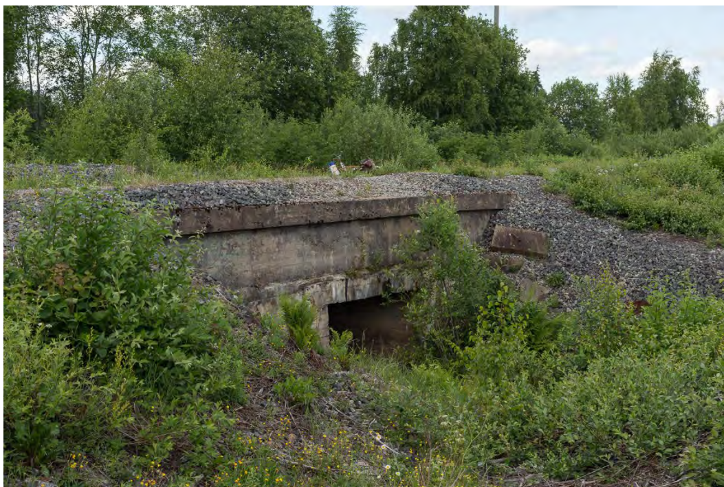
Kuva 204. Vahon huoltotiesilta Viialan pohjoispuolella oli mahdollisesti alun perin avorumpu. Kuva itäpäästä nykyisen radan suunnasta. Mikko Itälahti 18.6.2024.
