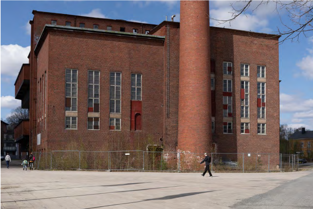
Kuva 18. Paloheimo Oy:n sahan voimalaitos Riihimäen asemanseudulla. 1914 avattu höyryvoimalaitos tuotti sähkön koko Riihimäen asemakylälle.
