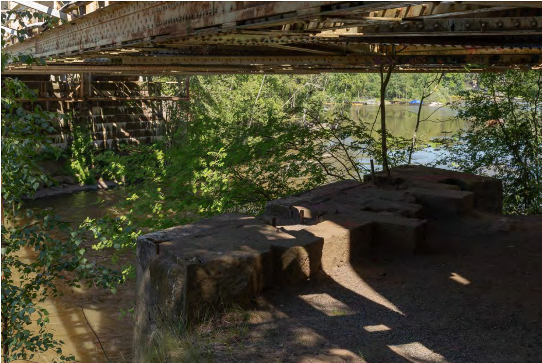
Kuva 192. Alkuperäisen siltaan kuulunut maatuki on säilynyt nuoremman teräsristikkosillan alla. Mikko Itälahti 26.6.2024.
