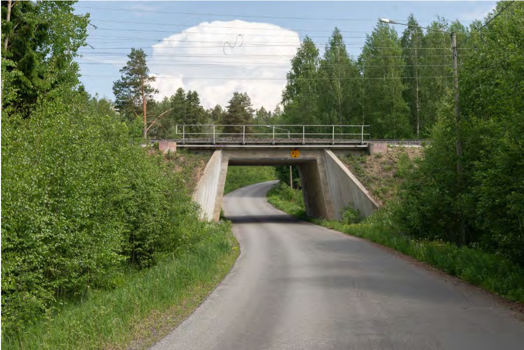
Kuva 198. Pappilan 1983 valmistunut alikulkusilta littalan pohjoispuolella, littalan Kappelin tuntumassa. Mikko Itälahti 30.5.2024.
