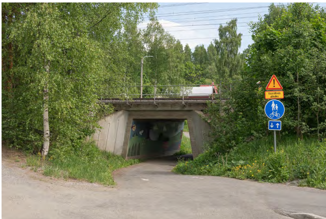
Kuva 200. Tyypillinen alikuluissa käytetty laattakehäsilta, Helteen alikäytävä, littalan keskustassa. Mikko Itälahti 30.5.2024.
