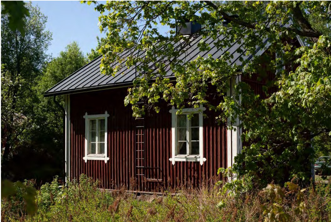
Kuva 53. Parolan asema-alueen historialliseen kokonaisuuteen kuuluva vahtituparakennus ylikulkusillan pohjoispuolella. Mikko Itälahti 23.5.2024.
