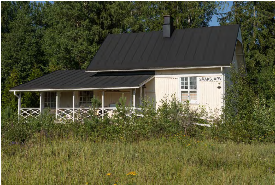
Kuva 101. Sääksjärven pysäkkirakennus. Mikko Itälahti 22.7.2024.
