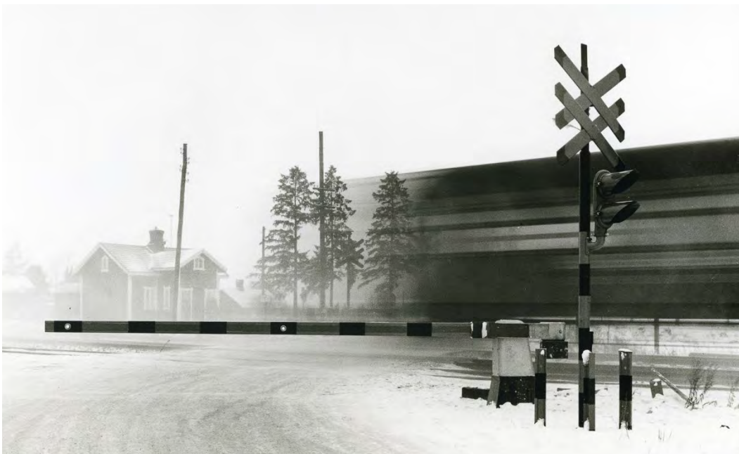
Kuva 178. Puolipuumilaittein varustettu tasoristeys Kuurilassa juuri käyttöön otettuna. Taustan kaksois- vahtitupa on säilynyt (ks. luku Liikennepaikat). Onni Lehtonen /VR 26.11.1965. (SRM / Vr1: 12534).
