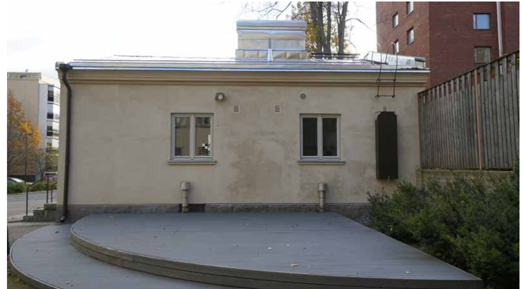
Piharakennuksen kylkeen on rakennettu komposiittinen esiintymislava.
