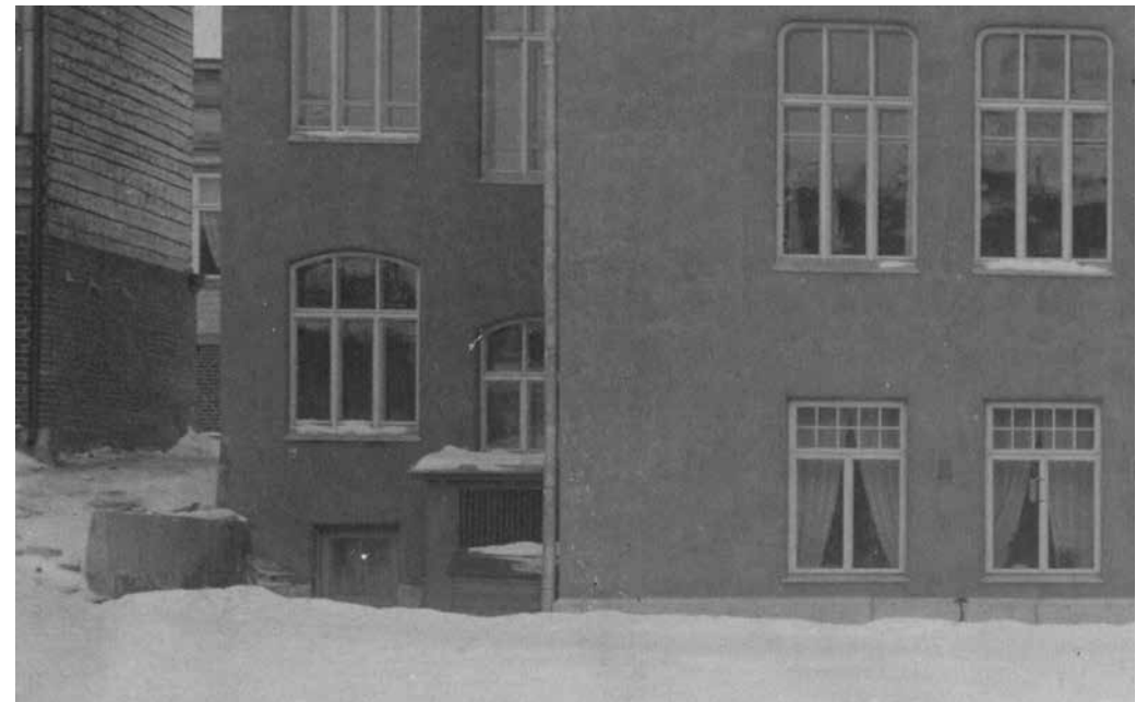
Ylhäällä oikealla: Rakennuksessa kiinni oleva pikkusiipi. Valokuvien perusteella se on ollut paikallaan aina, mutta se on päässyt rapistumaan. Rappaus on voimakkaamman keltainen kuin muussa rakennuksessa.
