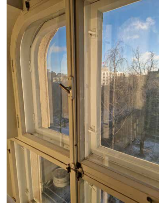
Kuvassa on laajennusosan eteläpään ikkuna heloineen. Helat ovat hieman yksinkertaisempia verrattuna alkuperäiseen osaan.
