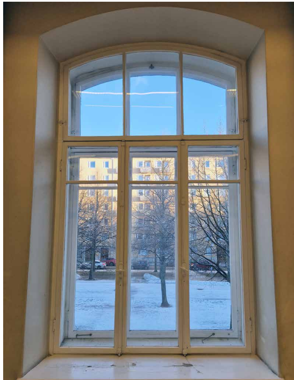
Kuvassa v.1902 valmistuneen osan 1.kerroksen ikkuna, joka on heloitusta myöten säilynyt alkuperäisenä.
