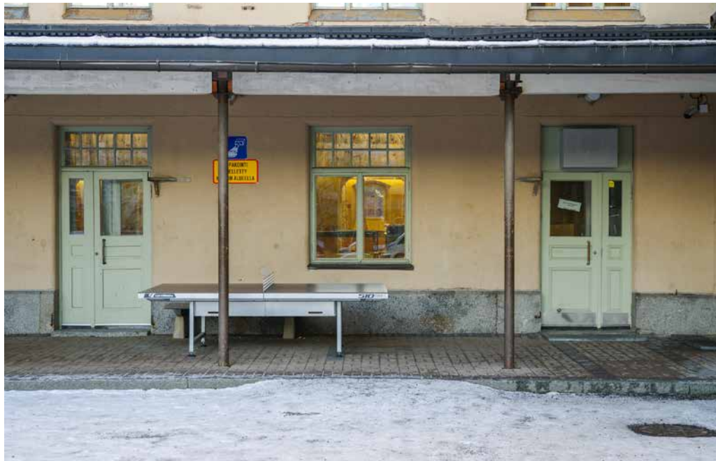
Sisäpihan eteläjulkisivun ikkuna-aukkoja on laajennettu oviksi. Kuvassa keskellä alkuperäinen ikkuna. Myös katos on lisätty rakennukseen varsin myöhäisessä vaiheessa.
