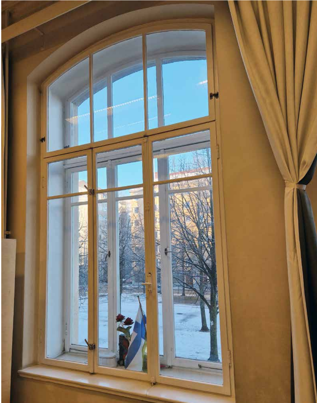
Tässä 1.kerroksen ikkunassa on nähtävissä kokoelma eri aikakausien heloja. Yksi espanjoletti ja yläpuutteen salvat ovat alkuperäisiä, ulkopuitteen pukinsarvimalliset painikkeet vaikuttavat 1930-1950-luvun tyyliisiltä ja sisäpuutteen painikkeet ovat myöhemmältä ajalta.
