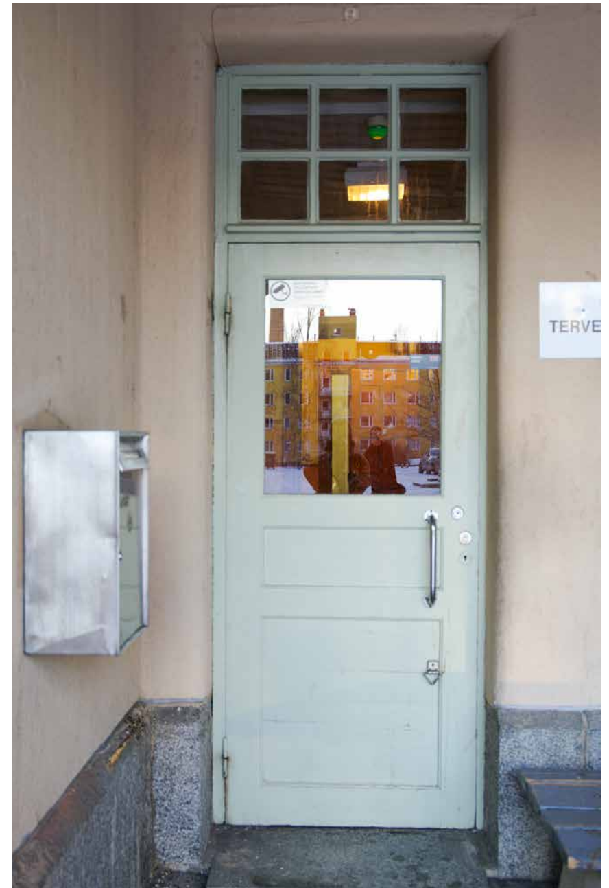
Alkuperäisen parioven tilalle on vaihdettu kapeampi yksilehtinen ovi 1950-luvulla.
