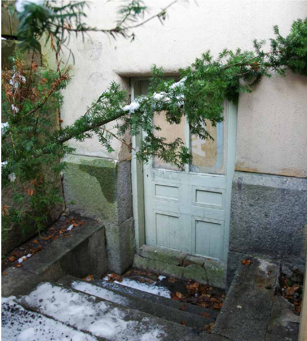
Ylhäällä vasemmalla: Talovaraston ovi rakennuksen eteläjulkisivulla sen länsipäässä on alkuperäinen. Varastossa on säilössä joitakin alkuperäisiä paikaltaan irrotettuja välioivia.
