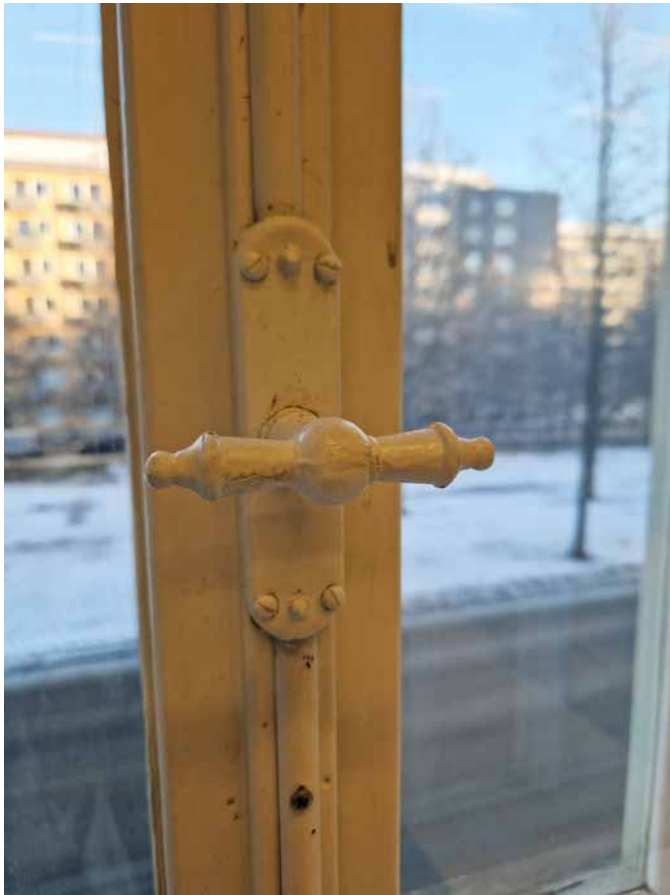
Alkuperäisiä ikkunaheloja v.1902 valmistuneessa osassa. Kuvassa espanjoletin vääntösalpa
