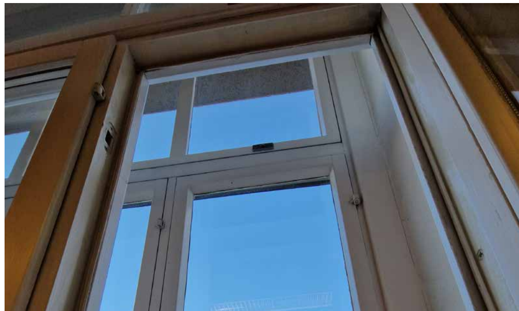
Uusittu ikkuna toisessa kerroksessa. Karmi ja puite ovat leveämpiä kuin alkuperäisissä ikkunoissa ja sisäpuitteessa on lämpölaselementti
