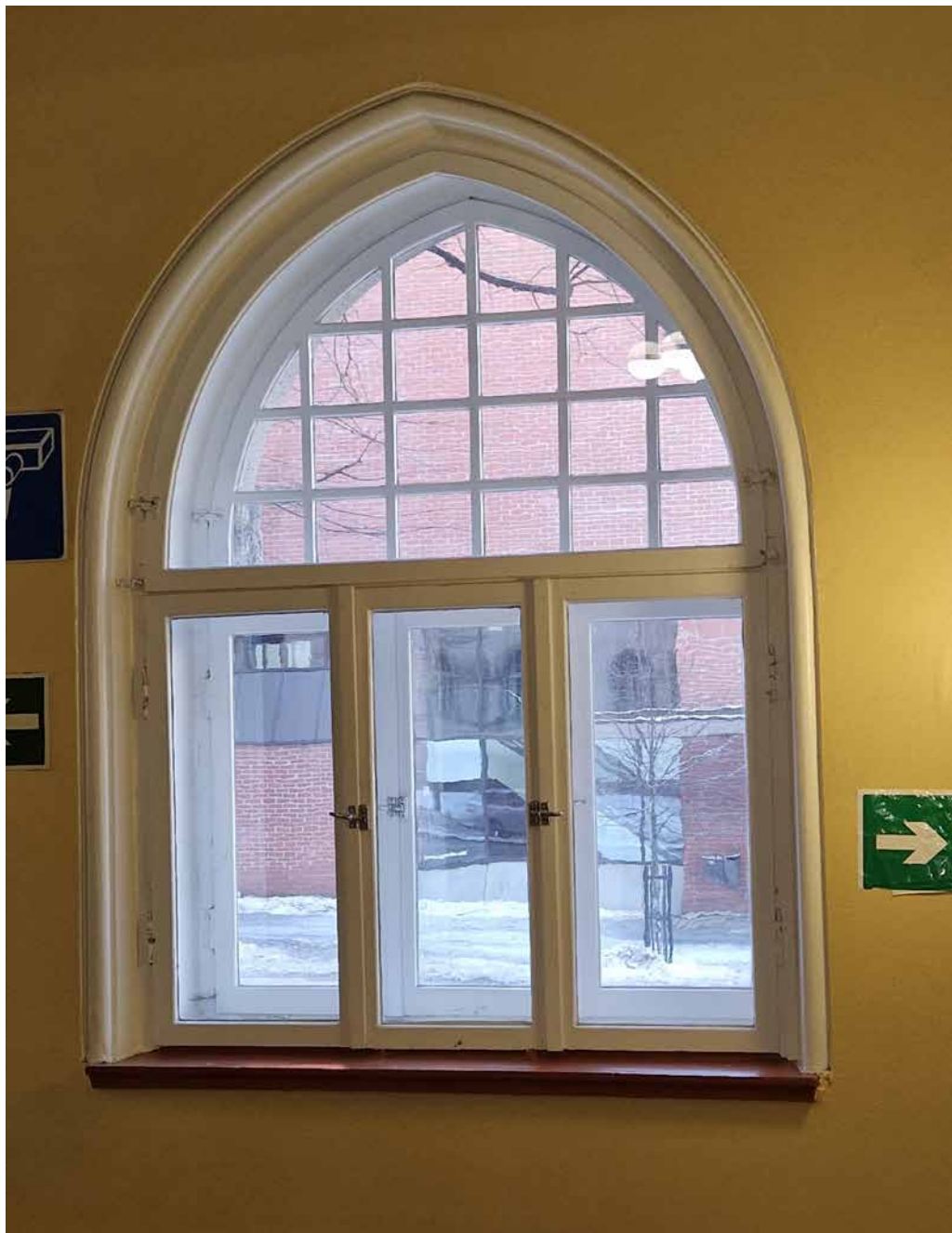
Porrashuoneen ikkuna sisältä päin kuvattuna, ikkunasmyygiä kiittää koristelista ja yläpuitteissa on jäljellä alkuperäiset reunasalvat.
