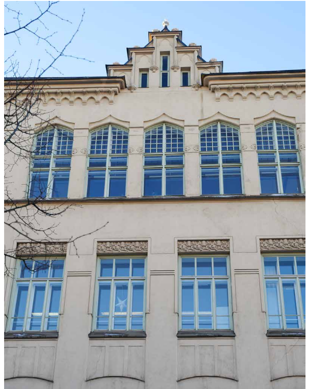
Ikkunat ovat pääosin säilyneet alkuperäisinä, mukaan lukien ylimmän kerroksen yläosastaan pieniruu- tuiset ikkunat. Kuvassa alemmat ikkunat uusittuja 2. kerroksen ikkunoita.
