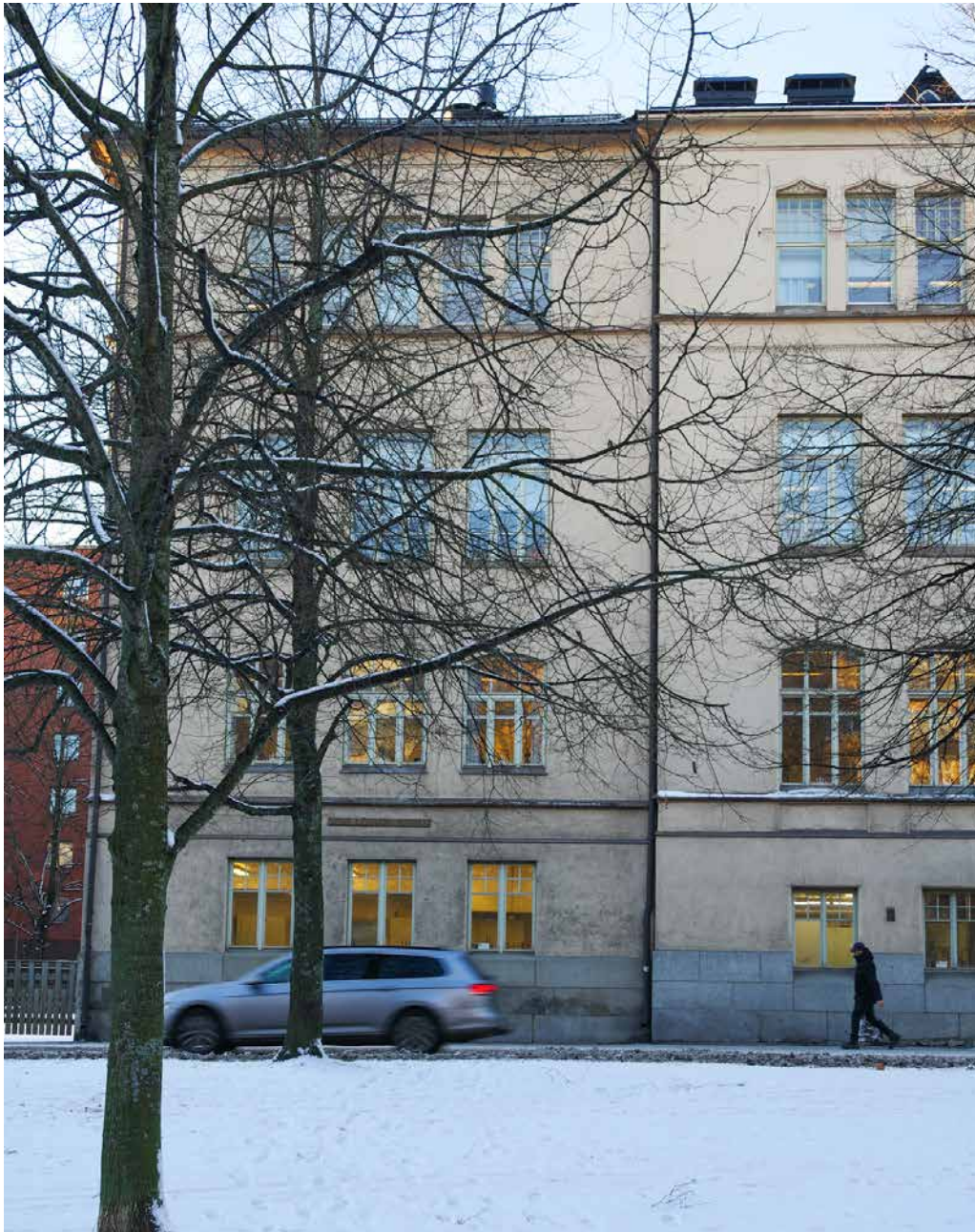
Laajennusosa kuvattuna Hämeenpuistosta. Kuvasta näkee koko laajennusosan vajonneen noin 10 cm. Laajennus on alkuperäistä osaa koruttomampi ja sille alisteinen.
