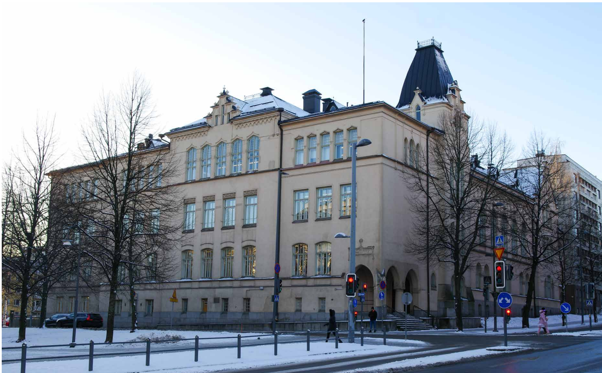
Pyynikin koulu kuvattuna Satamakadun ja Hämeenpuiston risteyksestä. Julkisivut on nykyään rapattu yhdellä sävyllä, joskin koristeaiheet ovat säilyneet alkuperäisinä. Katto on nykyään musta, kun se alunperin oli vain galvanoitua peltiä.
