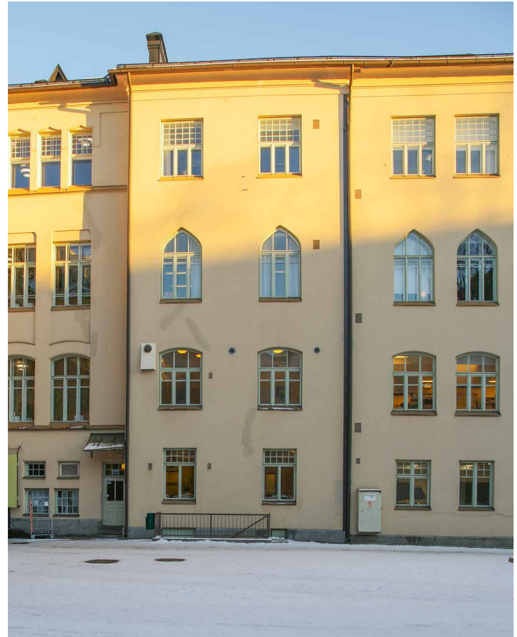
Sisäpihan länsijulkisivu muuttui voimakkaasti koulun laajennuksen yhteydessä v. 1931, kun vuoden 1902 osan julkisivuun tehtiin uusia ikkunoita luokkatiloille. Alakellarille on myös rakennettu ulkopuolinen sisäänkäyntiporras ja sisäporras poistettu käytöstä.
