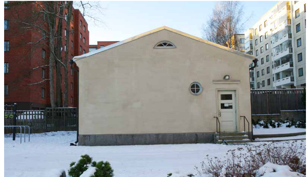
Piharakennus kuvattuna idästä. Tämä julkisivu on säilynyt käytännössä muuttumattomana.
