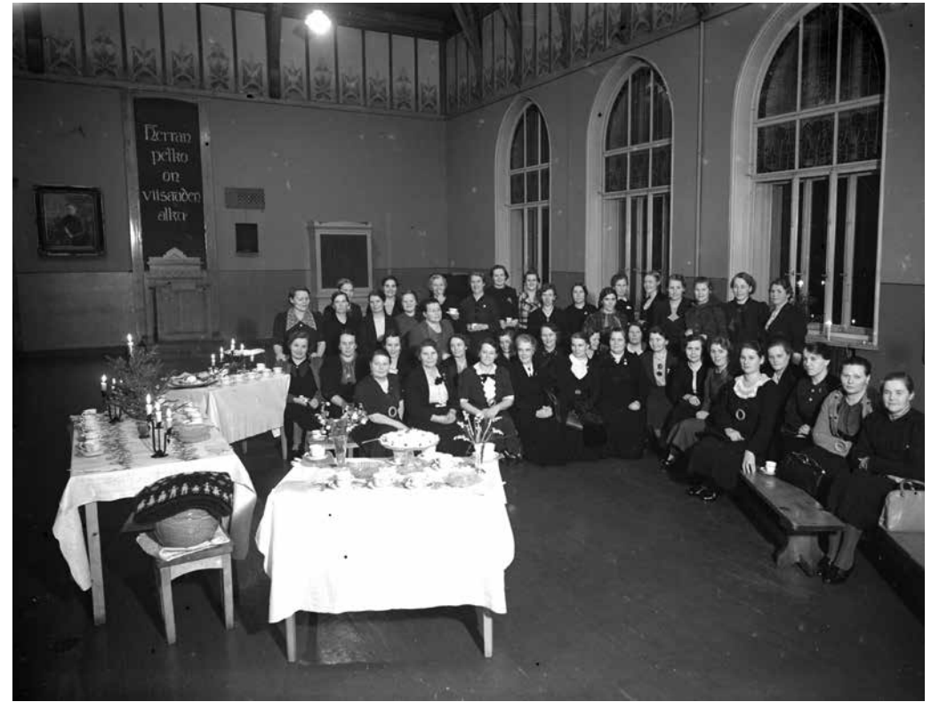
Juhlasalin päätyseinässä oli alunperin puhujan koroke, jonka takana maalaus, jossa luki "Herran pelko on viisauden alku". Seinässä näkyy myös alkuperäisen lämmitysjärjestelmän seinäritilöitä. Kuva: Veikko Kanninen 1937, Vapriikin kuva-arkisto.
