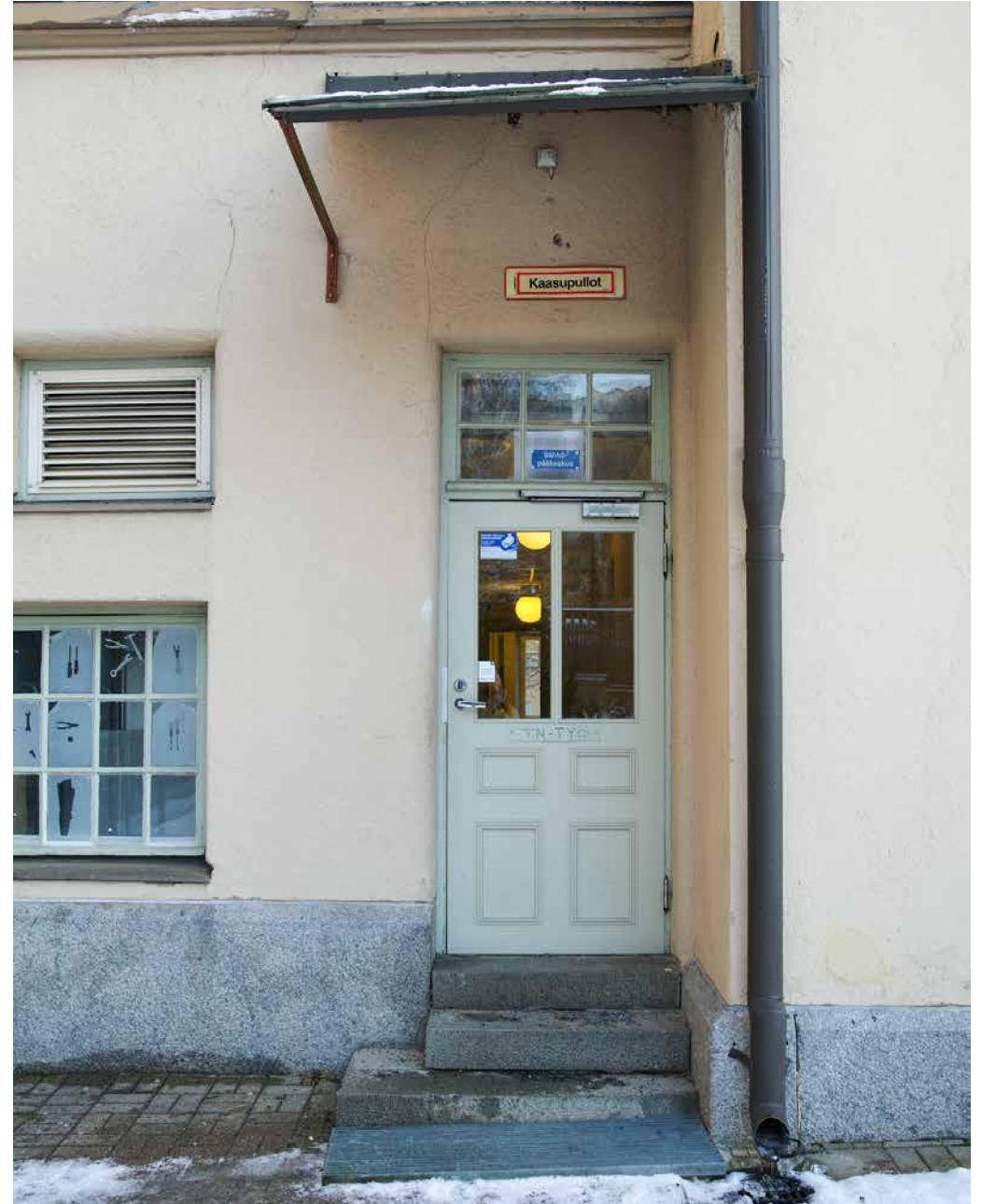
Alkuperäinen sisääkäynti kellarin aputiloihin. Katos ei ole alkuperäinen, mutta lisätty hyvin varhaisessa vaiheessa, valokuvien ajoitusten perusteella ennen vuotta 1919.
