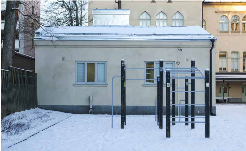
Piharakennus kuvattuna etelästä. Katto on vaihdettu ja se odottaa maalausta. Syöksytorvet ovat valmiiksi tummaksi maalattuja.
