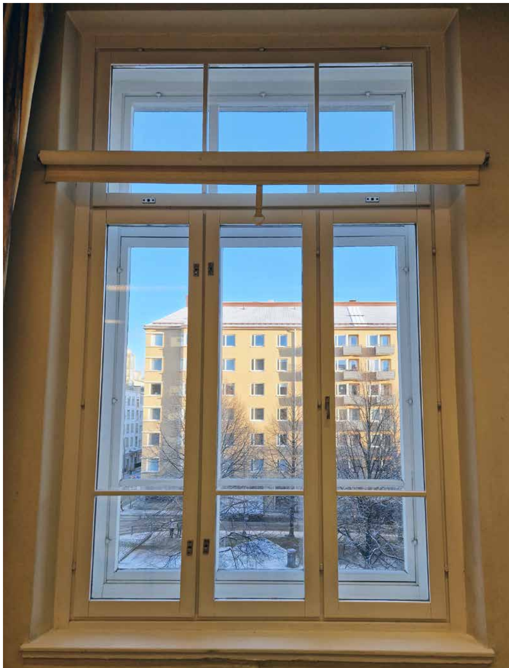
Toisen kerroksen uusittu ikkuna kokonaisuudessaan.
