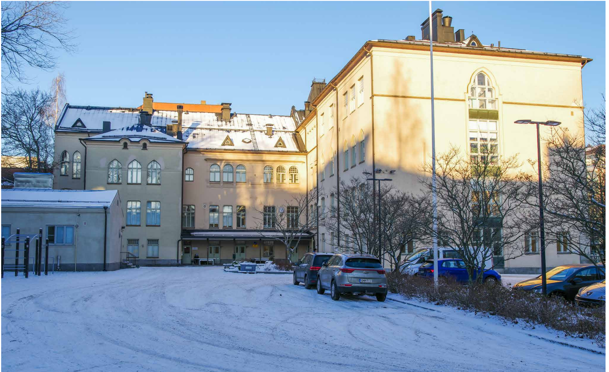
Näkymä sisäpihalta. Tontilla on nykyään pysäköintiä ja välituntipihalla urheiluvälineitä. Myös erillinen vahtimestarin asunnon rakennus on otettu opetuskäyttöön. Kuvan keskellä näkyy syvennykseen lisätty katos, joka suojaa eteläjulkisivuun myöhemmin lisättyjä sisäänkäyntejä.
