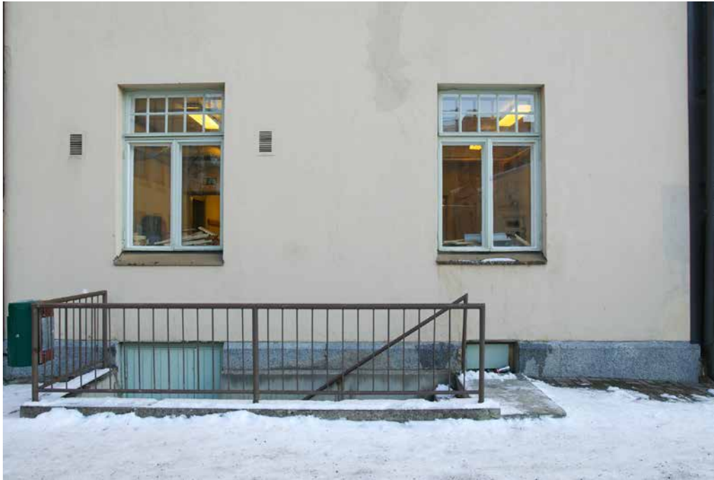
Alakellariin johtava porras sisäpihan puolella.
