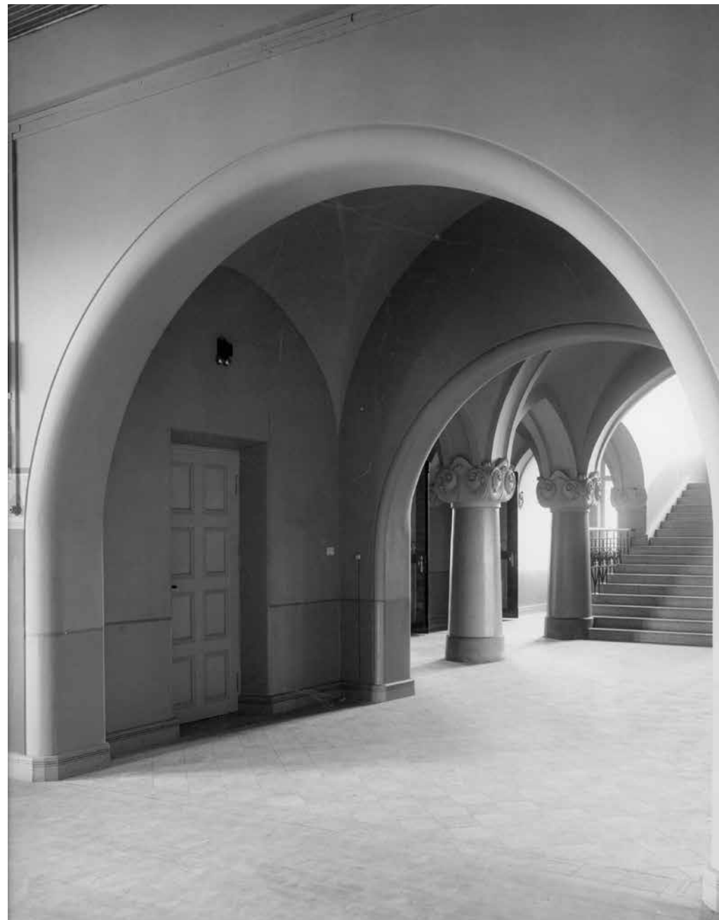
Pääporrashuone kuvattuna 2. kerroksen hallista. Hallin lattia on alunperin ollut lankkua ja porrashuo- neen lattia mosaiikkibetonilaattaa. Kuvaus aika 1902-1919.
