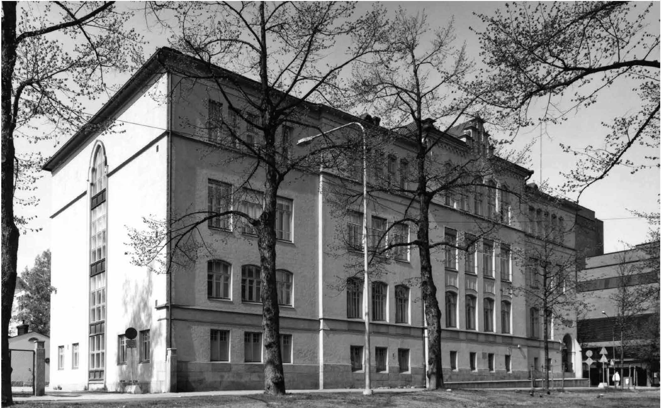
Tampereen tyttölyseo kuvattuna Hämeenpuistosta. Laajennusosan päädyssä korkea ikkuna koristeai- heineen. Laajennusosan aukotus seuraa alkuperäisen osan ikkunoiden rytmiä, mutta on koristeiltaan vaativammampi. Myös ikkunoiden korkeusasemat poikkeavat alkuperäisestä osasta kellarin ja ensim-
