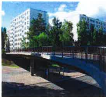
Valtaraitin silta yli Opiskelijankadun.
