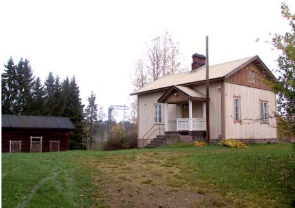
Vanhan asemamiljöön viimeiset rakennukset
