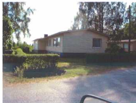
(kuva: Rakennusvalvonnan arkisto)
