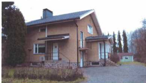
(kuva: Rakennusvalvonnan arkisto)
