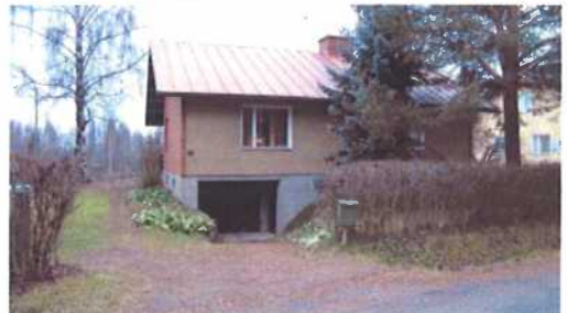
(kuva: Rakennusvalvonnan arkisto)
