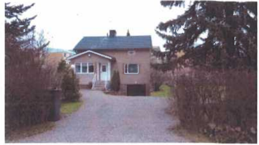
(kuva: Rakennusvalvonnan arkisto)
