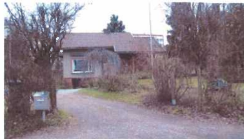
(kuva: Rakennusvalvonnan arkisto)
