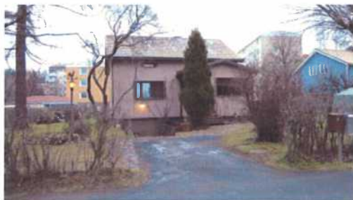
(kuva: Rakennusvalvonnan arkisto)
