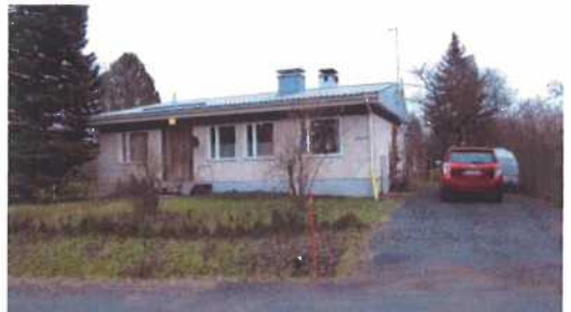
(kuva: Rakennusvalvonnan arkisto)
