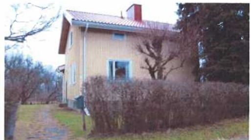
(kuva: Rakennusvalvonnan arkisto)
