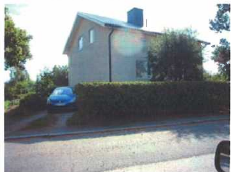
(kuva: Rakennusvalvonnan arkisto)
