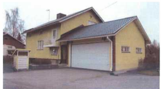
(kuva: Rakennusvalvonnan arkisto)
