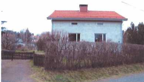
(kuva: Rakennusvalvonnan arkisto)
