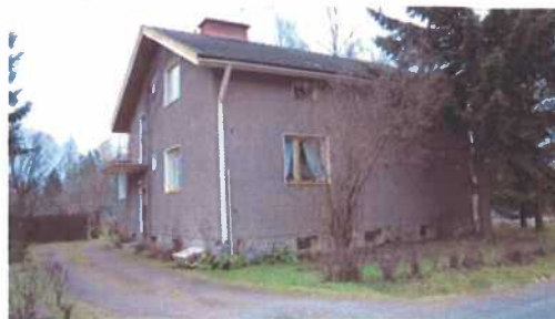
(kuva: Rakennusvalvonnan arkisto)
