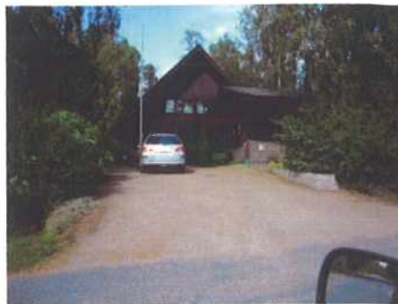
(kuva: Rakennusvalvonnan arkisto)
