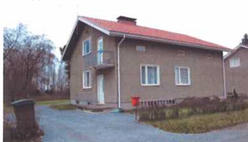
(kuva: Rakennusvalvonnan arkisto)
