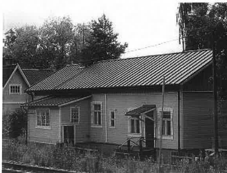
Kuva 10. Ennen vuoden 1956 asemakaavaa rakennettuja, säilyneitä asuinrakennuksia radanvarrelta, 2011.
