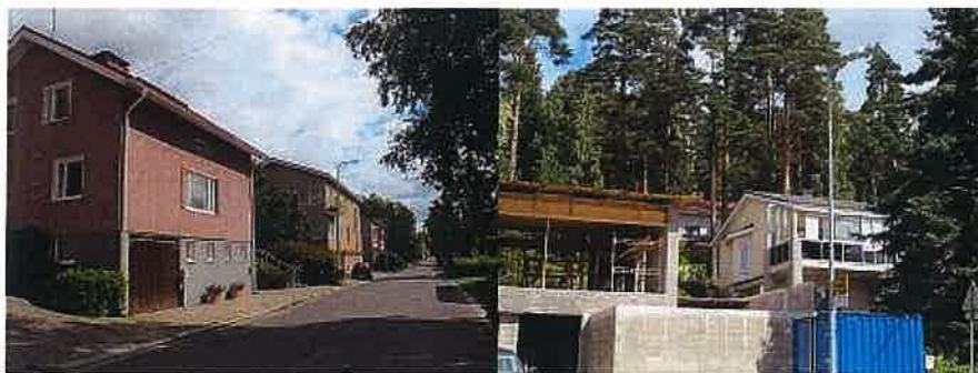
Kuvat 16 ja 17. Vasemmalla Järvensivuntien tarkastelualueen länsipään 1950-luvulla rakennettuja omakotitaloja, oikealla tien itäisen osan rinnetaloja 2000-luvulta.
