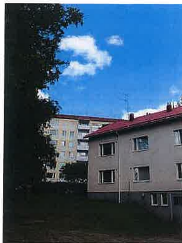
Kuva 12. Edessä kaksikerroksinen pienkerrostalo, takana kuusikerroksinen asuinkerrostalo. Kuvattuna Iidesrannalta päin, 2011.
