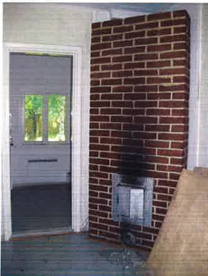
Rakennuksen 3 sisätilaa ja kellari
