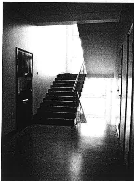
Kuvat 37-38. Lamelli- ja pistetalon porrashuoneet. Merkkittävin muutos on akustiikkalevyjen lisääminen pörrastasanteiden alapintaan.
