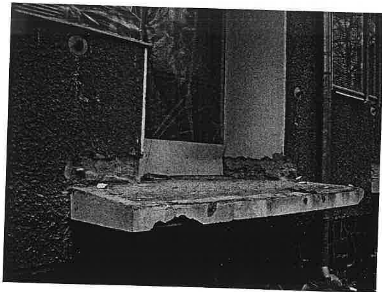
Kuva 45. Parvekelaatan ja kaiteiden peruskorjaus on käynnissä.
