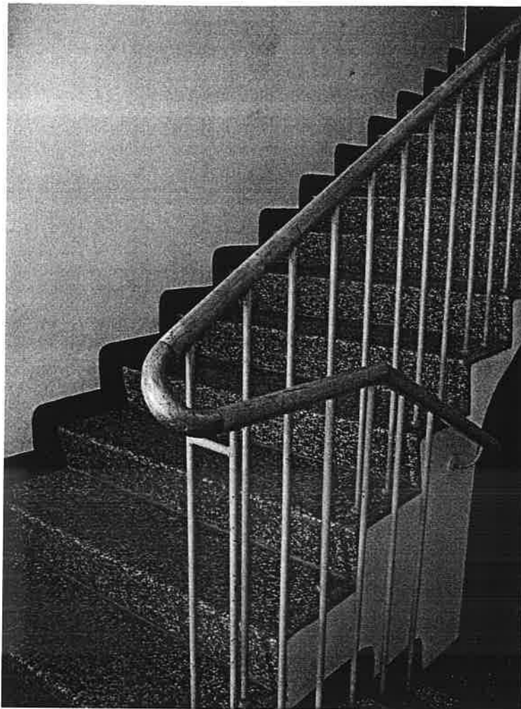
Kuva 39. Askelmien mosaiikkibetoni ja porrassyöksyjen kaiteet ovat säilyneet alkuperäisessä asussaan.
