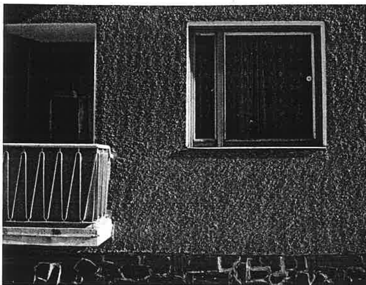
Kuva 15. Viistovalo korostaa roiskerappauksen materiaalituntua.
