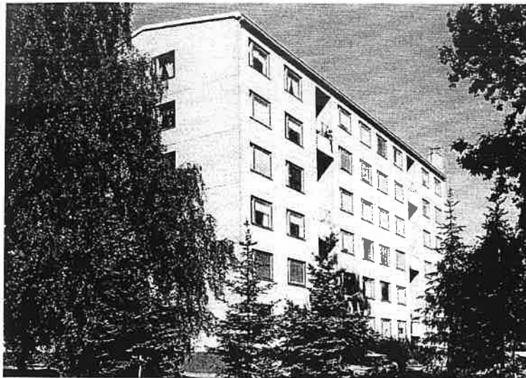
Kuva 54. As Oy Lemminkäisenkatu 2 on Suomen ensimmäinen ruutuelementeistä valmistettu asuinkerrostalo. Kuva: Simo Kaarsalo, Tampereen kaupunginarkisto
