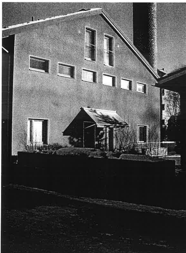
Kuva 28 . Huoltorakennuksen pääty peruskorjauksen jälkeen
