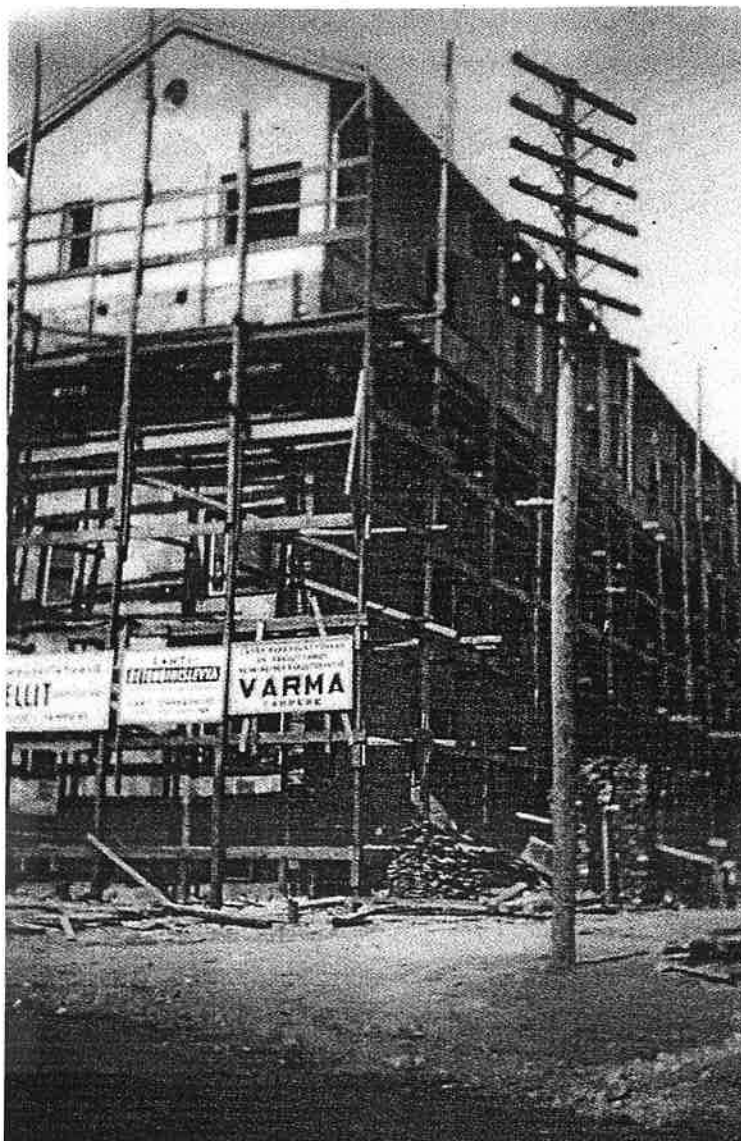
Kuva 21. Ilmarinkatu 47 työmaa. Kuva: Riitta Lehtioksa, Me koskentieläiset
