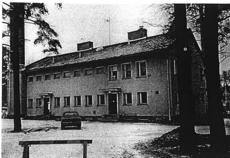
Kuva 29 . Huoltorakennus pihalta katsottuna ennen peruskorjausta. Kuva: Jukka Koskinen 1994
