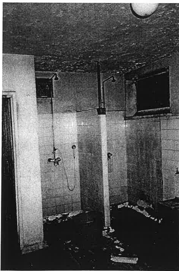
Kuva 23-24. Yleinen sauna ja pesuhuone ennen peruskorjausta. Kuvat: Jukka Koskinen 1994
