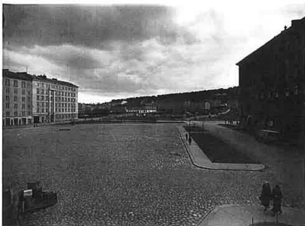
Lyseon rakennustyömaa torin päädyssä huhtikuussa 1934. Lyseon edustan puistoalue on jo muotoutunut. Takana Pyynikinrinteen asuinalue. Veikko Kanninen
