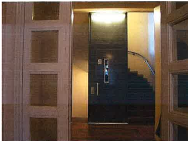
Porraskäytävässä näkyy rakennusajan tyyli. Talon asennettiin hissi jälkiasennuksena vuonna 2002. Tampereen kaupunki
