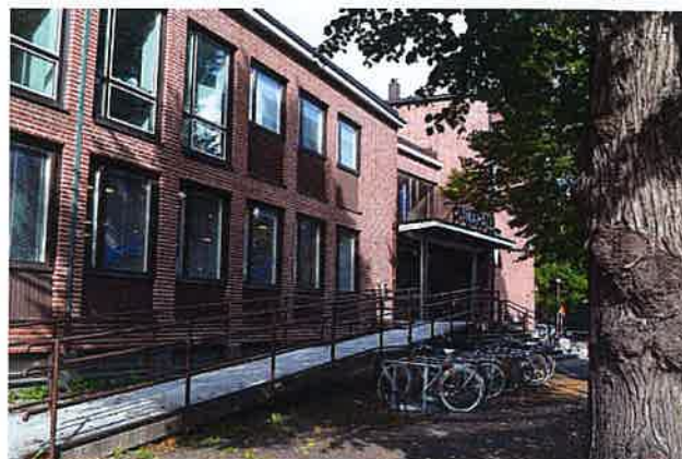
Betoninen invaluiska pääsisäänkäynnille. Anna Lyyra-Seppänen 6.9.2016
