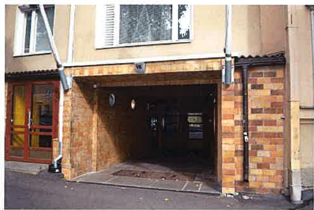
Rakennuksen itänurkasta on sisäänkäynti teatteri Stradaan. Teatteritila sijaitsee alkuperäisellä paikalla.
