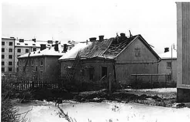
Pommituksen tuhoja 25.12.1939. Keskellä Kisakentänkatu 2 pihan puolelta. Sen vieressä vasemmalla Heinätori 7:n paikalta purettu kaksikerroksinen puutalo.
