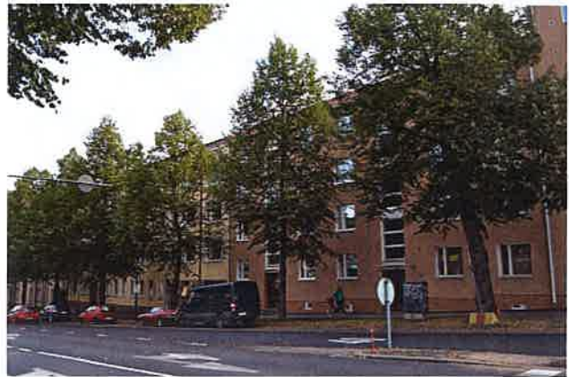
Näkymä Satakunnankadulta. Rakennus sulautuu osaksi yhtenäistä katufasadia. Anna Lyyra-Seppänen 6.9.2016
