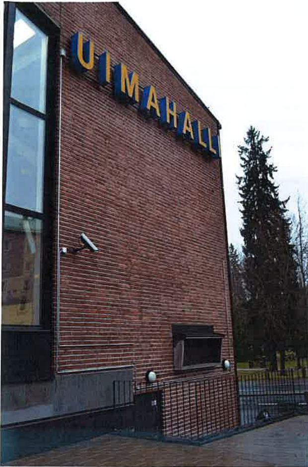
Hallin kyltti länsipäädyssä on alkuperäinen. Anna Lyyra-Seppänen 24.11.2016
