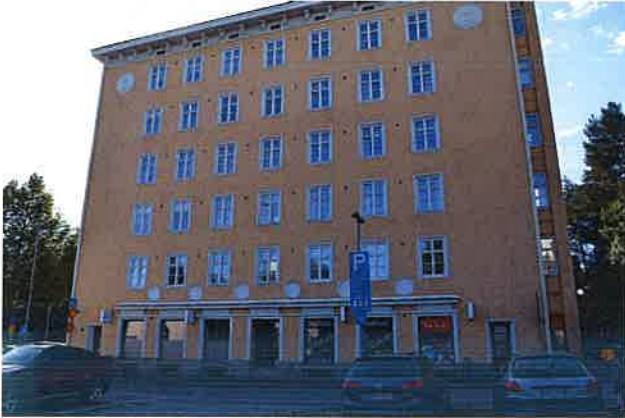
Julkisivu Heinätorin puolelle. Anna Lyyra-Seppänen 6.9.2016
