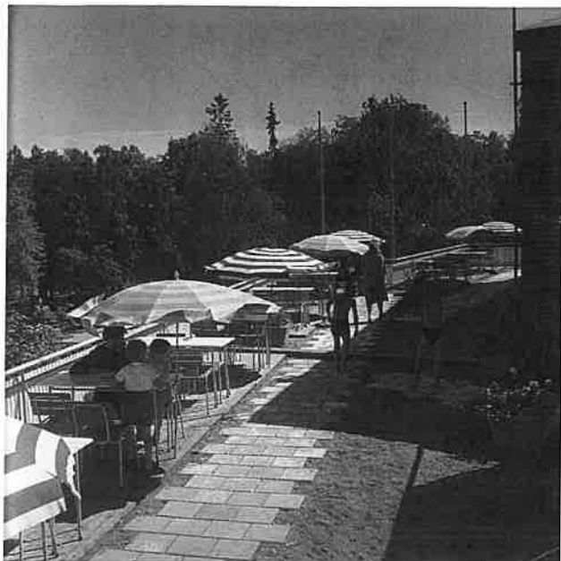
Kahvilan kattoterassi Kortelahdenkadun puoleisella sivulla on sittemmin purettu. Kuva vuodelta 1959. Juhani Riekkola/Vapriikin kuva-arkisto
