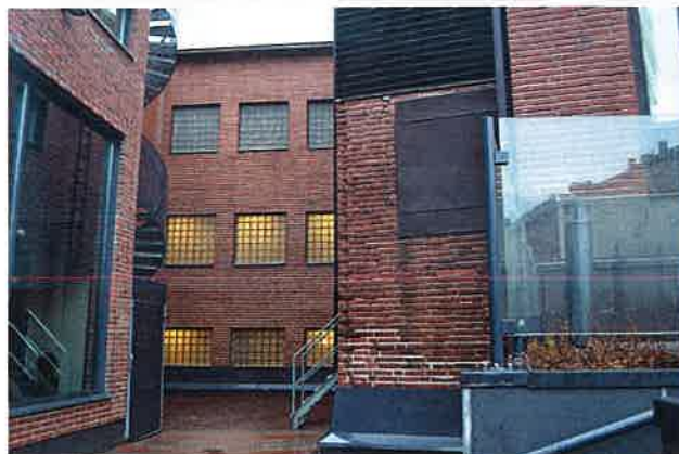
Liitososa uimahallin ja Forenomin välillä. Edustalle muodostuu pieni sisäpiha. Anna Lyyra-Seppänen
