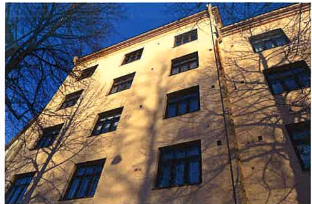
Päädyissä julkisivu kohoaa keskiosaa korkeammaksi. Ennen räystästä tyylitelty friisikoristelu. Anna Lyyra-Seppänen 30.11.2016
