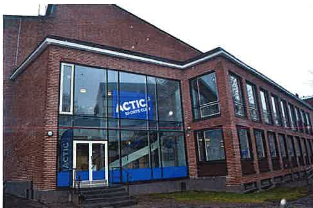
Peruskorjauksessa 2011–2012 rakennuksen kaakkoiskulman ikkuna ja sisäänkäynti palautettiin. Anna Lyyra-Seppänen 24.11.2016
