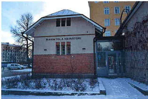
Pääty pohjoiseen, Pirkankadulle päin. Lasiseinäinen yhdysosa yhdistää vanhan ja uudisrakennuksen. Anna Lyyra-Seppänen 30.11.2016
