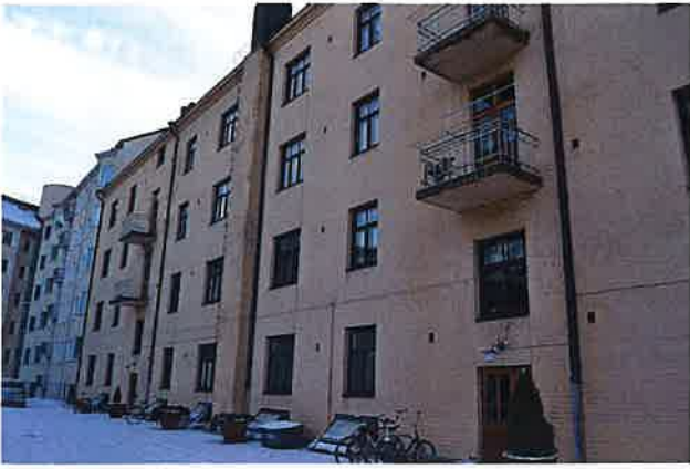
Pihajulkisivulla erottuu tiilipinta rapauksen alta. Anna Lyyra-Seppänen 30.11.2016
