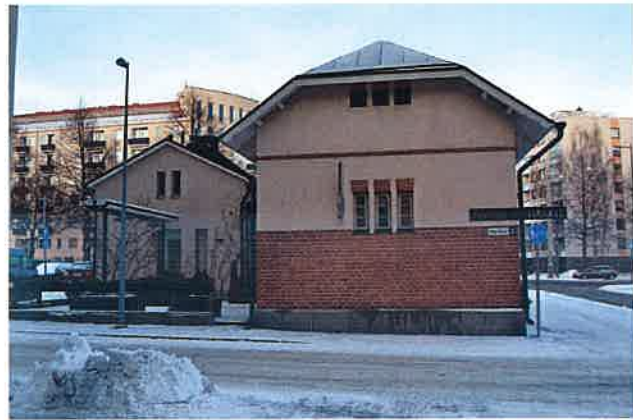
Pääty etelään. Vasemmalla uudisrakennus ja terassi. Anna Lyyra-Seppänen 30.11.2016
