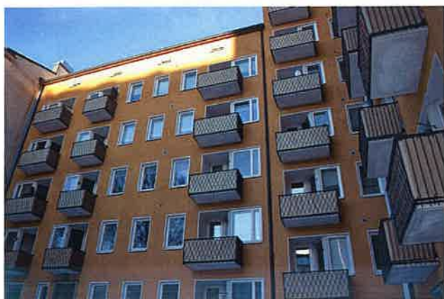
Pihajulkisivu. Anna Lyyra-Seppänen 30.11.2016
