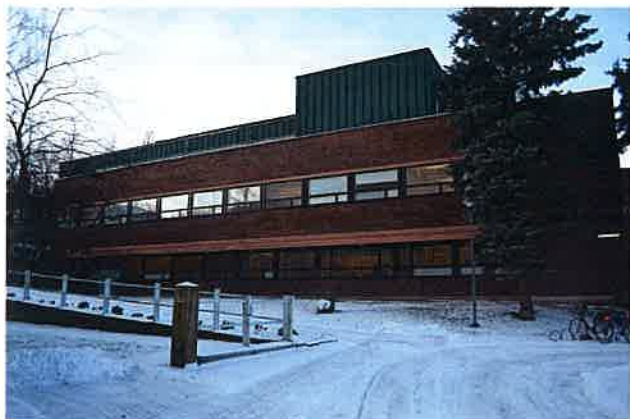
Julkisivu itään. Konservatorion ja lyson välistä kulkee kävely-yhteys Lundelinipolku.
