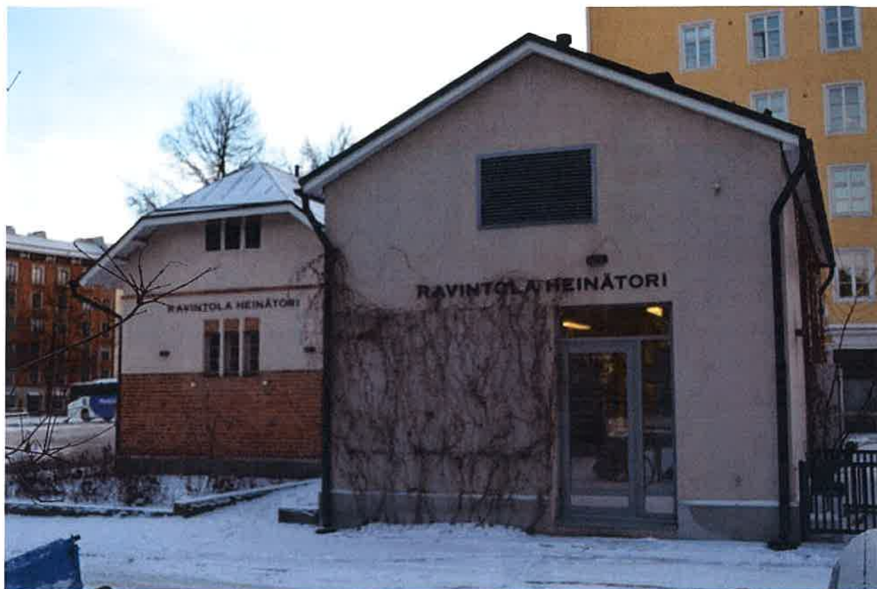
Pääty pohjoiseen. Muodoltaan vastaava uudisrakennus sijaitsee samansuuntaisesti vanhan vaakahuoneen kanssa. Anna Lyyra-Seppänen 30.11.2016 00:00:00
