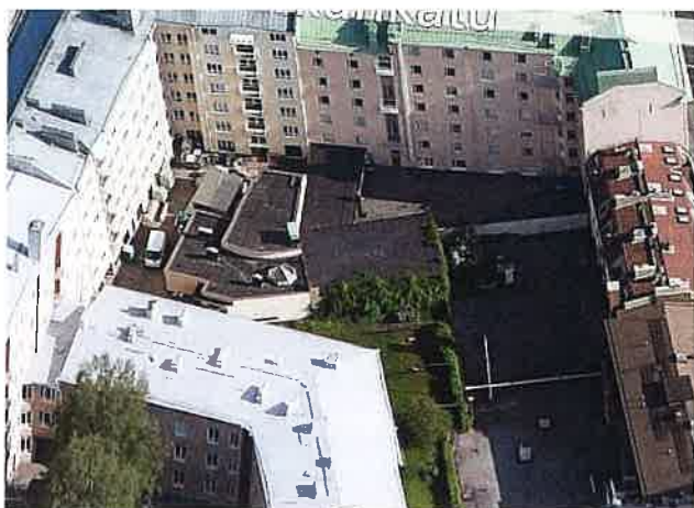
Muodoltaan itsenäinen piharakennus piiloutuu umpikorttelin sisään. Juhlasalin viuhkamainen muoto erottuu keskellä. Rakennuksen kyljessä tilapäinen rakennuskontti.
