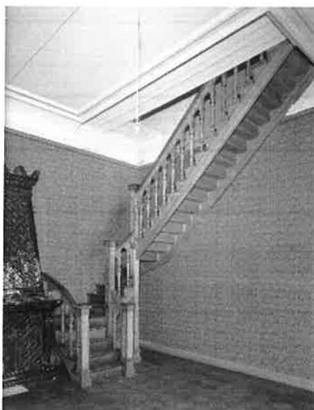
Länsipäädyn alkuperäinen sisäporras, joka on purettu
