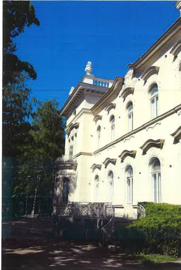
Milavidan eteläpuoleisen julkisivun ikkunat ja terassikaiteet
