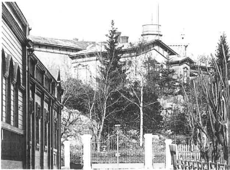
Milavidan koristeellinen aita ja portti olivat nykyisen Näsilinnankadun päässä. Taustalla näkyy vanha puurakenteinen Milavida Näsikallion etelärinteessä.
