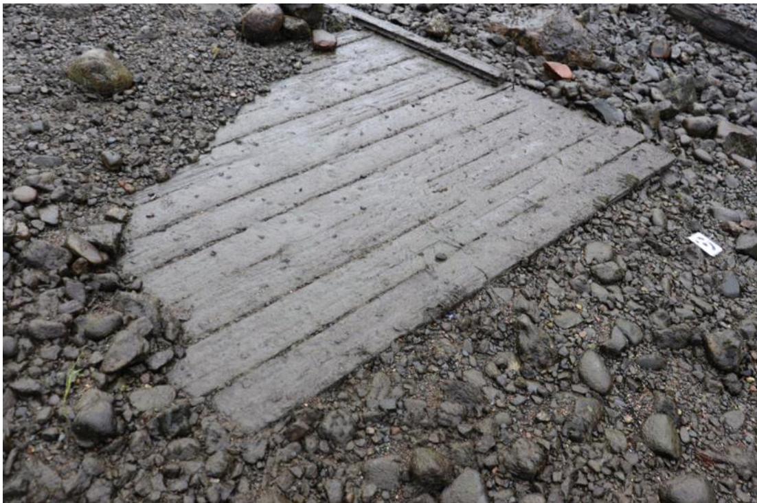
Kuva 17. Verkatehtaan johdinpäätöksen hirsipöytäperustuksen välittömässä läheisyydessä on lattiamainen puurakenne. Kuvattu itä-koillisesta.
