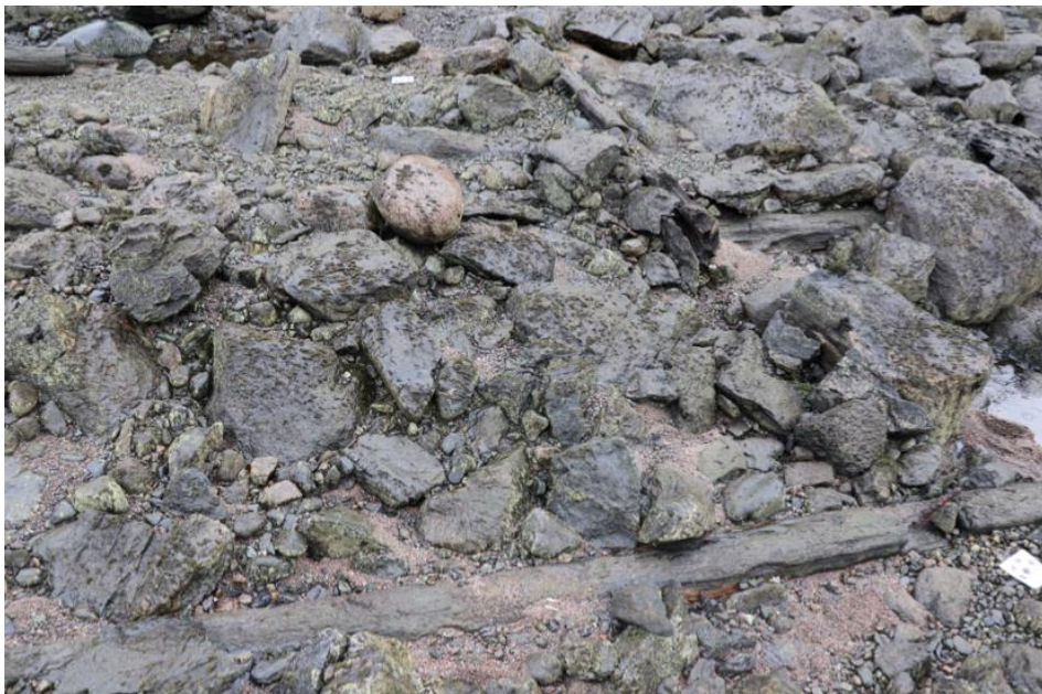
Kuva 22. Hirsiarkkurakenteesta on näkyvissä muutamia hirsii ja kivinen kohouma kosken pohjassa. Kuvattu lännestä.
