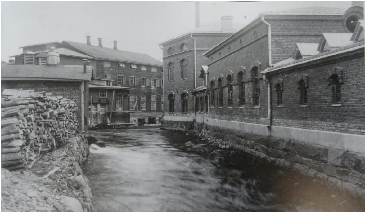
Kuva 3. Oikealla H.Liljeroosin Villakehruu- ja värjäystehtaan rakennuksia Kehräsaarella, keskellä virtaa tehdaskanava ja vasemmalla näkyy Tampereen Kattohuopatehtaan rakennuksia. Kuva 1800-luvun lopusta. (Toiva 2021:63, Vapriikin kuva-arkisto, kuvaaja I.K.Inha.)
