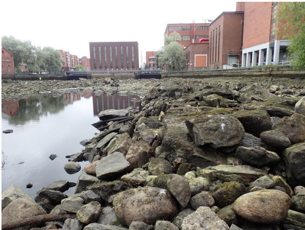
Kuva 18. Hirsiarkuista rakennetun johdinpädon jäänteet uoman länsirannalla. Kuvattu pohjoisesta.
