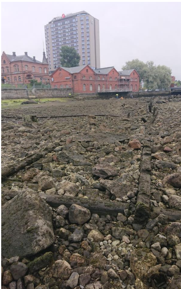
Kuva 15. Verkatehtaan johdinpädon hirsiarkkuperustus ajoittuu 1800-luvun lopulle. Kuvattu luoteesta.
