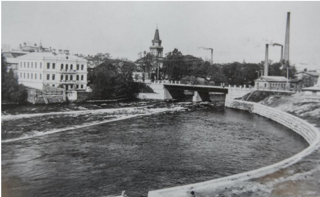
Kuva 5. Tehtaiden johdinpäätökset kosken keskiosassa ohjasivat vettä vesiruuhin. (Toiva 2021:69, Vapriikin kuva-arkisto.)
