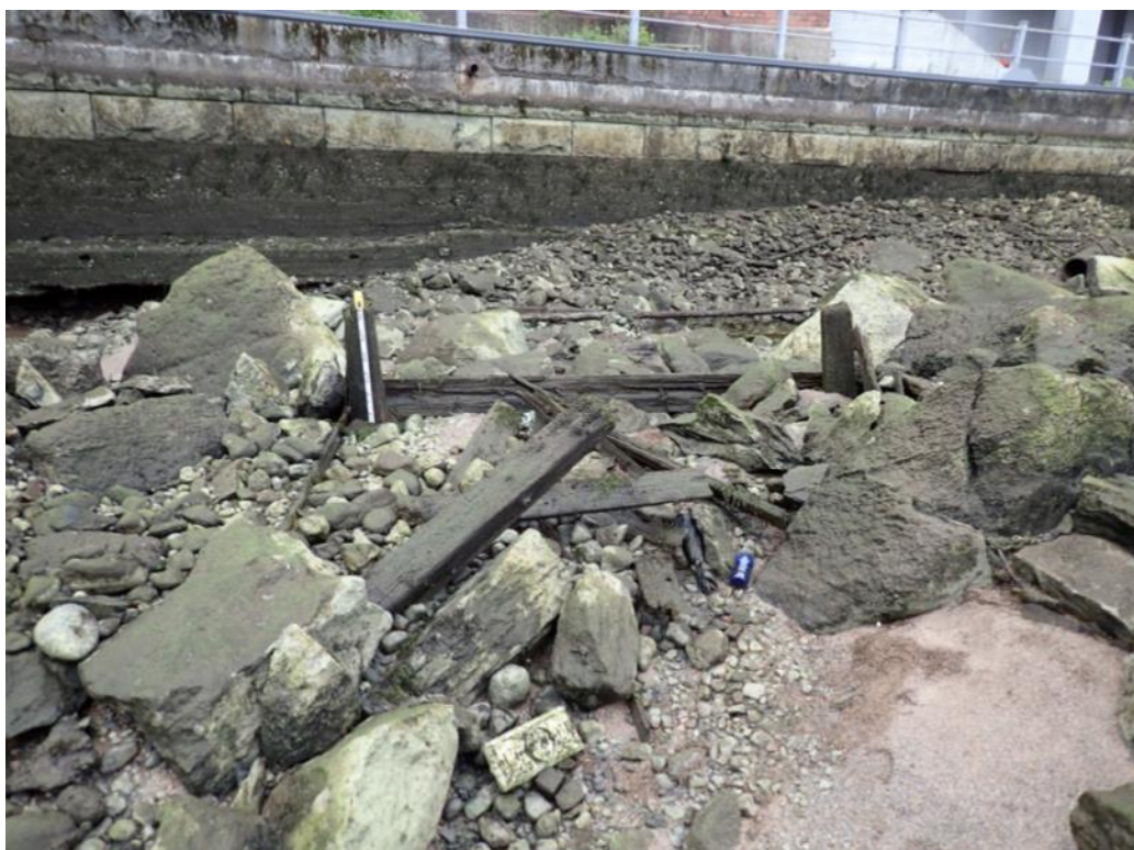
Kuva 19. Johdinpädon puisia rakenteita. Kuvattu kaakosta.
