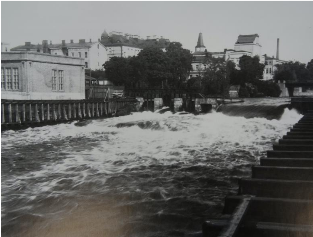
Kuva 8. Alaputouksen neulapato kuvattuna noin 1912–1928. Oikealla Verkatehtaan vesiruuhi ja vasemmalla Kattohuopatehdas ja sen edustalla Liljeroosin tehtaalle Kehräsaareen johtava ruuhi. (Toiva 2021:76, Vapriikin kuva-arkisto, kuvaaja Toivo Paatola.)
