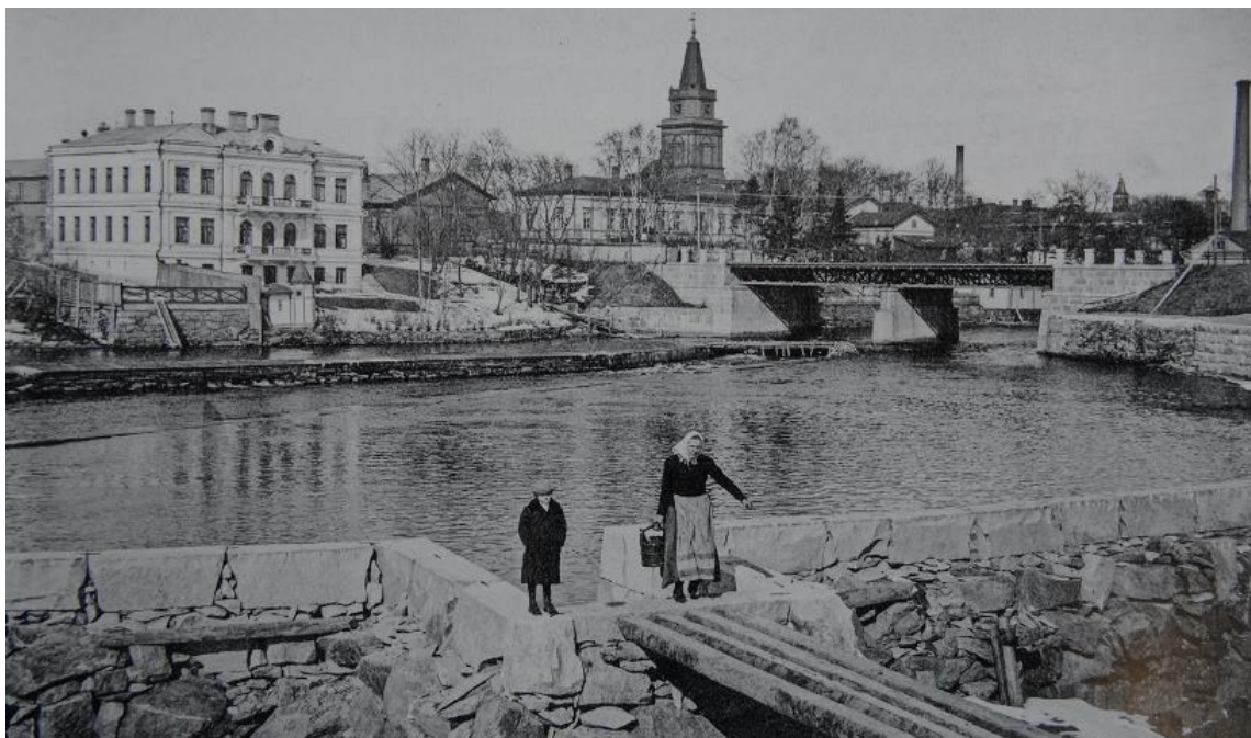
Kuva 10. Rantamuurit rakennusvaiheessa 1890-luvulla. Koskessa näkyvät matalan veden aikaan hyvin tehtaiden johdinpadot. (Toiva 2021:169, Vapriikin kuva-arkisto, kuvaaja Richard Thulé.)
