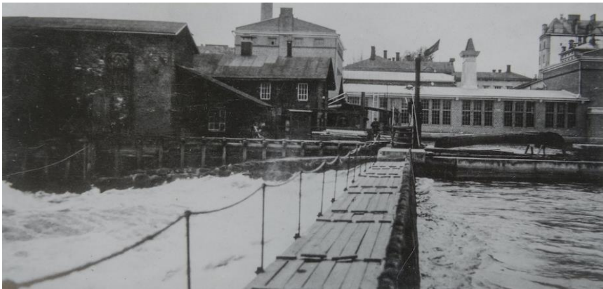
Kuva 14. Neulapato kuvattuna huhtikuussa 1918. Taustalla näkyy Kattohuopatehdas kosken länsirannalla. (Toiva 2021:75, Vapriikin kuva-arkisto, kuvaaja Harald Natvig.)
