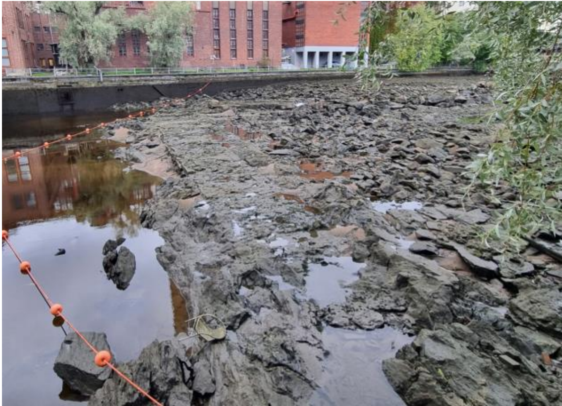
Kuva 12. Kivistä ja betonista tehtyä neulapadon perustusta. Kuvattu itä-kaakosta.
