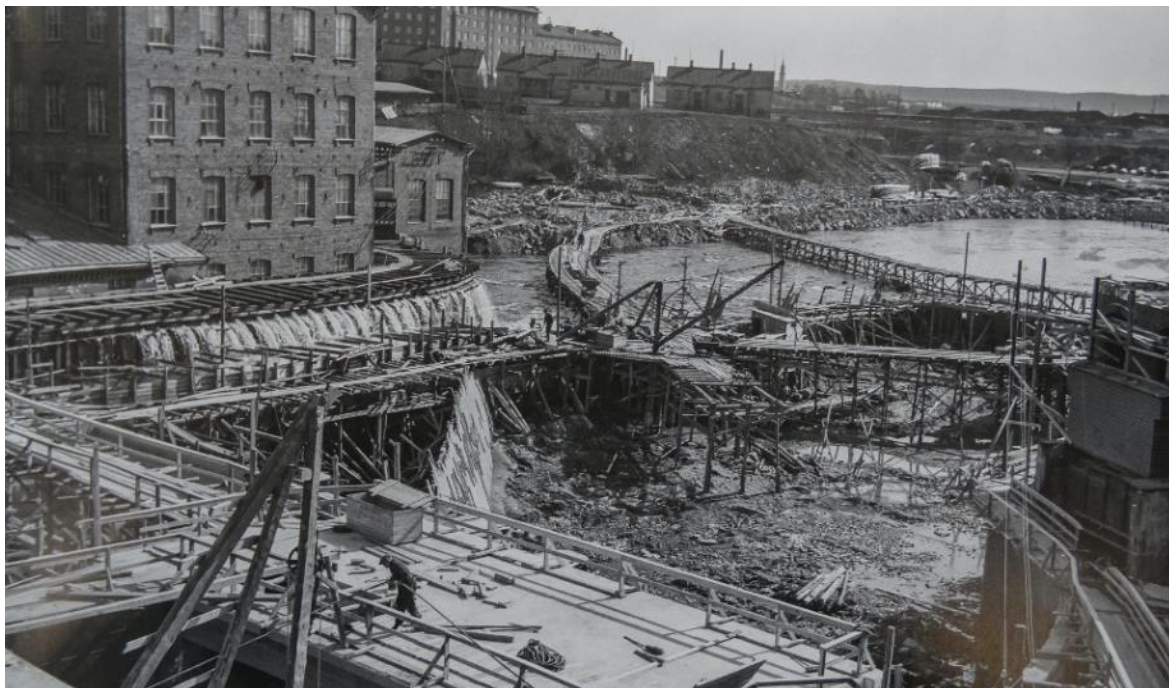
Kuva 9. Alakoski Oy:n vesivoimalaitoksen rakennustyömaa kuvattuna 16.4.1937. Taustalla näkyy Verkatehtaan rakennuksia. (Toiva 2021:161, Vapriikin kuva-arkisto, kuvaaja HM Staf.)
