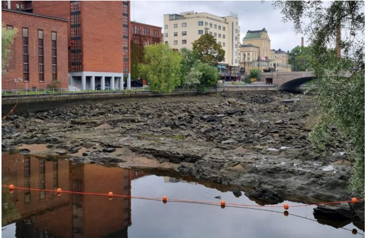
Kuva 11. Neulapadon jäänteet sijaitsevat vesirajan kuvassa heti yläpuolella. Kuvattu kaakosta.
