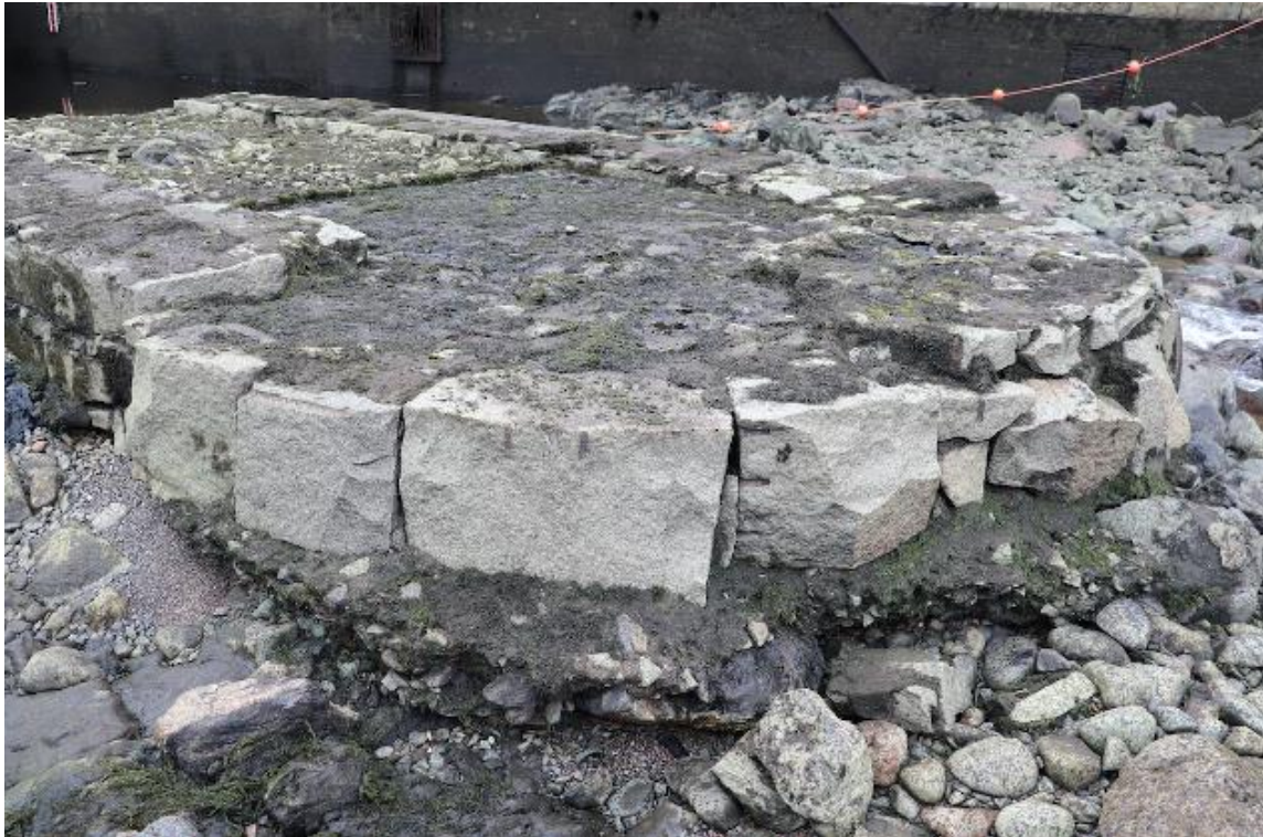
Kuva 13. Kivistä ja betonista tehtyä neulapadon perustusta rakenteen länsipäässä. Kuvattu koillisesta.
