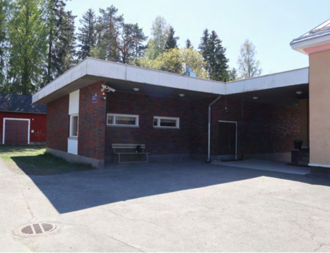
Tarttilan koulun 1968 valmistunut laajennusosa. Valkoiset rappaus- ja mineriittilevyypinnat luovat kontrastia tummaan tiiliverhoukseen.
