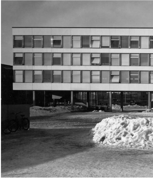
Sampolan rakennus valmistui kansalaiskouluksi ja työväenopistoksi vuonna 1962.
