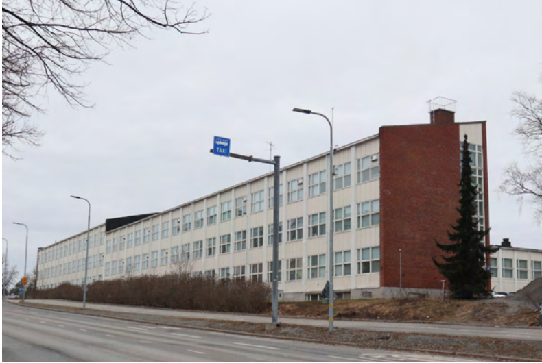
Hatanpään koulu Tampereella edustaa aikakaudelle hyvin tyypillistä kouluarkkitehtuuria puhtaaksimuurattuine tiilipäätyineen ja pitkine julkisivuineen, joissa on nauhaikkunat ja mineriittilevyverhous. Porrashuoneita sijoitettiin luokkahuonesiipien päätyihin, mikä loi näyttävän aiheen julkisivuun korkeiden ikkunoidensa ansiosta.
