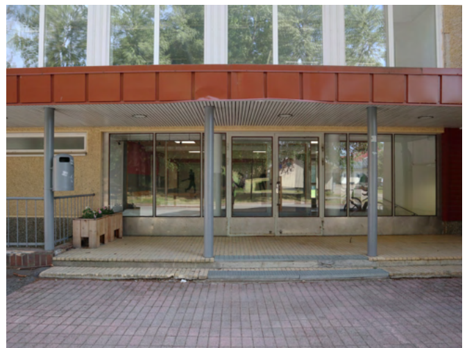
Koulun pääsisäänkäynti länsijulkisivulla. Pilarien kannatte- lemassa katoksessa on pitkänmallinen laatoitus, joista on muodostettu myös porrasaskelmat.
