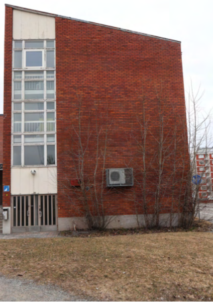
Luokkahuonesiiven tiiliverhottu eteläpääty ja porrashuoneen puuikkunat.
