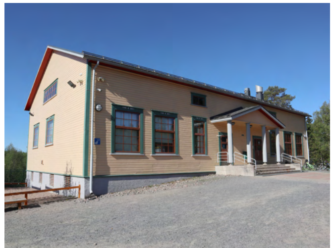
Terälä on rakennettu 1930-luvulla suojelus kuntataloksi. Rakennuksessa sijaitsee juhla- ja liikuntasali.
