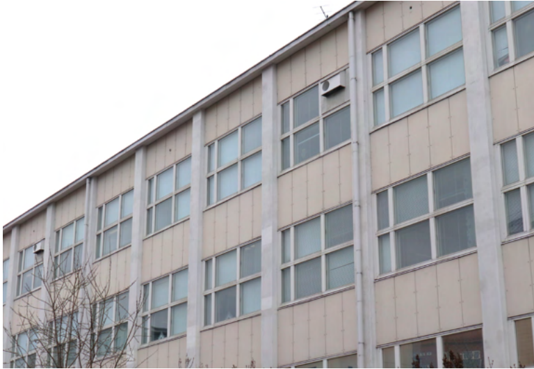
Hatanpään koulun nauhaikkunajulkisivu on jäsenetty betonisin ikkunapilarein ja mineriittilevyin.
