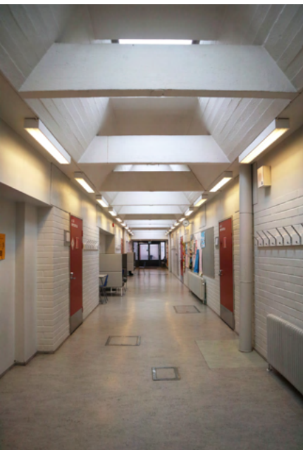
Luokahuonesiivissä on keskikäytävän yläpuolella kattoikkunat ja näyttävät betonivalurakenteet.
