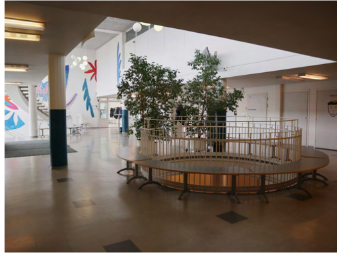
Aulassa on pyöreä valoaukko kellarikerrokseen. Pilareissa näkyy lautamuottipinta.
