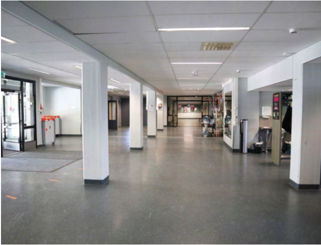
Sisäänkäyntiaula avautuu halliin, jossa on lautamuottivaletut betonipilarit. Pintamateriaaleja on uusittu saneerauksessa.
