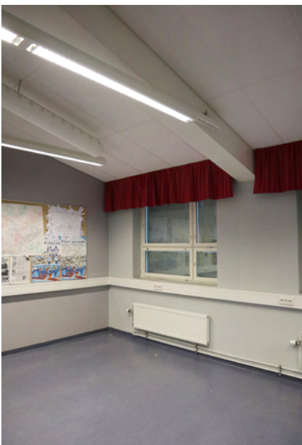
1960-luvulla rakennettu luokkahuone betonipalkkeineen.
