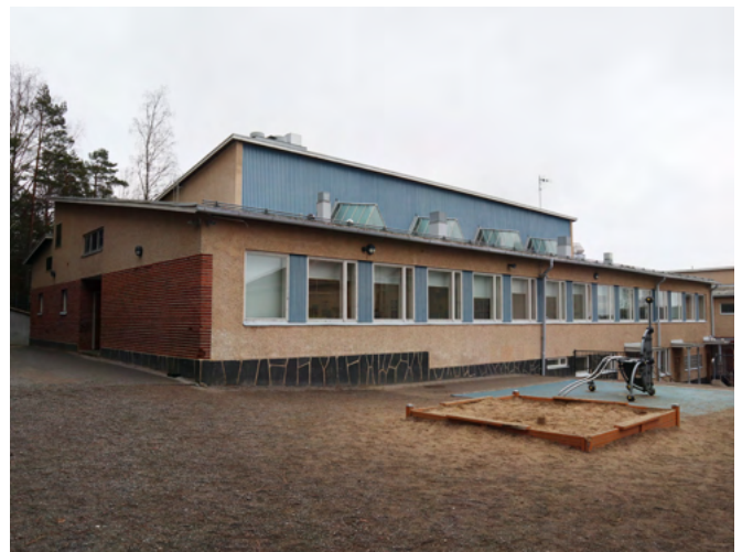
Laajennusosan julkisivuissa on käytetty vaaleansinistä pellitystä, nauhamaiset ikkunat sekä rappaus- ja punatiilipintaa.
