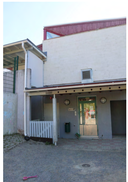
Rakennuksen pohjakerroksessa sijaitsee luontokoulu sekä päiväkoti, jolla on oma aidattu piha-alueensa länsipuolella.
