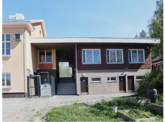
Tarttilan koulu kuvattuna lännen puolelta. 1960-luvun laajennus erottuu selkeästi erilaisena klassistisen 1930-luvun koulun rinnalla.
