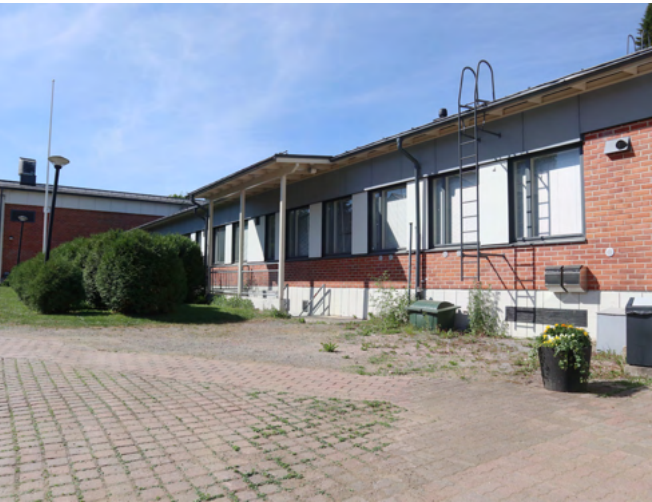
Luokkahuonesiipi on itäpuoleltaan yksikerroksinen, toinen kerros on sisäävedetty julkisivulinjasta. Alkuperäisinä materiaaleina rakennuksessa on säilynyt punatiili, mineriittilevyjä on korvattu muulla levytyksellä.
