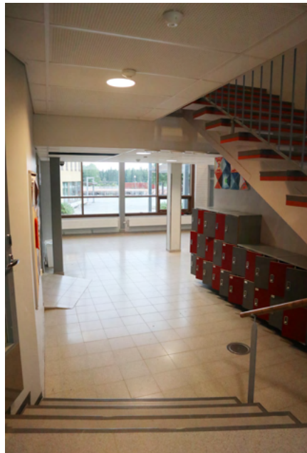
1960-luvun osan portaikkoa. Taustalla 2010-luvun aulalaajennusta.
