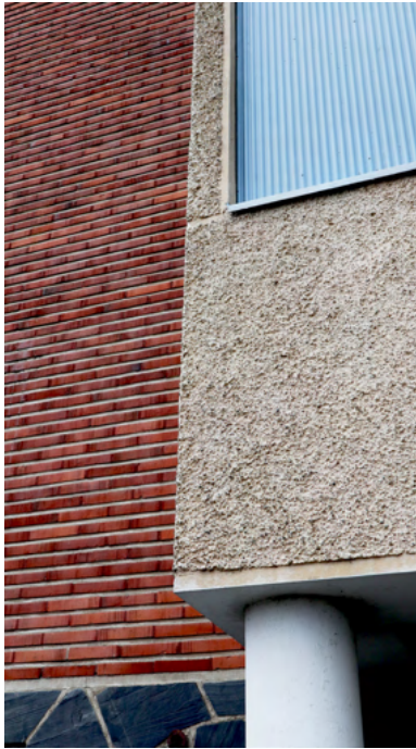
Kangasalan Kirkkoharjun koulun materiaaleja: puhtaaksimuurattua tiiltä, roiskerappausta ja liuskekiveä.
