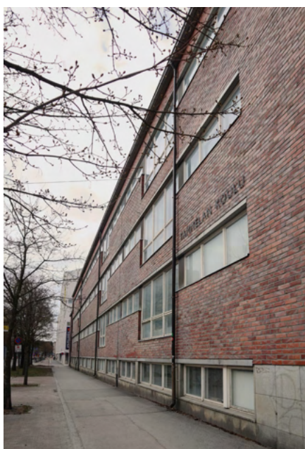
Tammelan koulun pitkää, Kalevan puistotien suuntaista julkisivua, johon nauhamainen ikkuna luo keveyden tunnun.
