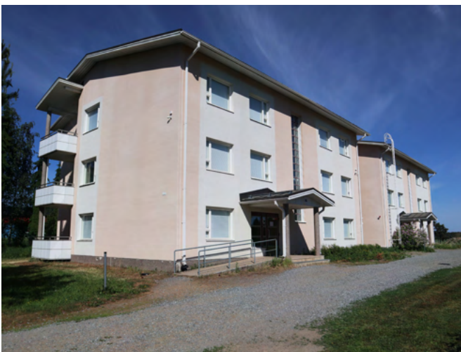
Kaksi samankaltaista asuntolarakennusta on rakennettu 2000-luvulla. Kuvassa vuonna 2004 valmistunut Tapiola.
