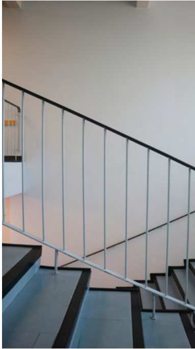
Vammalan lukion porrashuone. Metalliset pinnakaiteet muovi- tai kumipäälysteisellä käsijohteella olivat ajalle tyypilliset.
