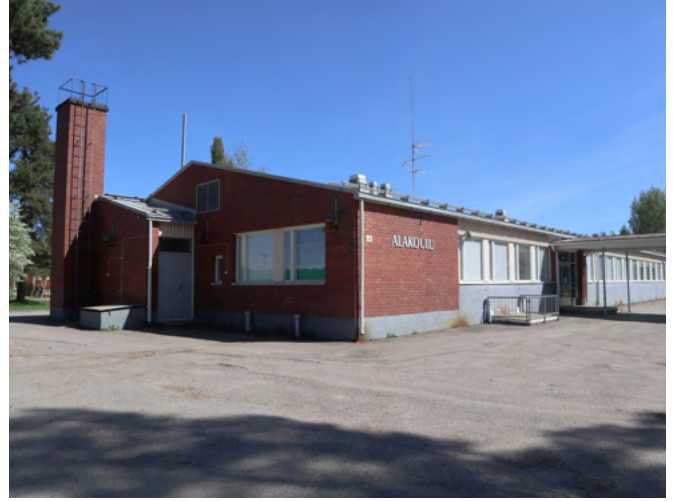
Alakoulun luoteispääty on punatiilinen. Piippu vasemmassa reunassa ja oikealla julkisivun edustalla näkyvä täyttöluukku muistuttavat vanhasta lämmitysmuodosta.
