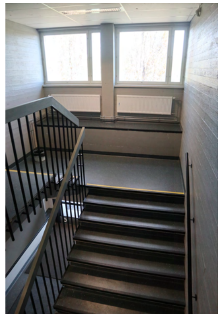
Pohjoisjulkisivun porrashuoneen kohdalla nauhaikkunat jatkuvat ja lattian korkotaso eroaa perustasosta.
