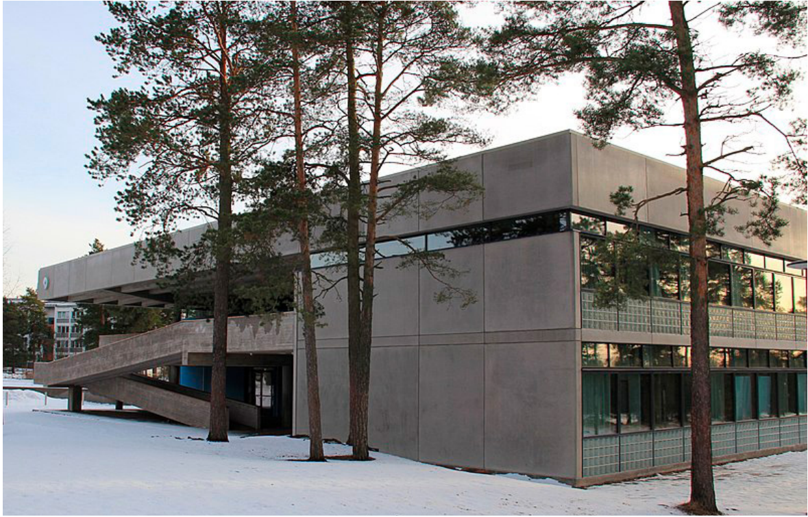
Helsingin Roihuvuoren koulu peruskorjattiin huolellisesti vuosien 2013-2016 aikana. (Kuva: Wikimedia Commons.)
