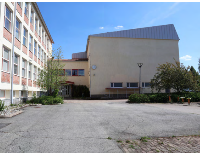
Laajennuksen länsijulkisivua välituntipihalta. Tästä suunnasta julkisivut ovat rapatut. Pellitetty pulpettikatto saa hallitsevan roolin ulkoasussa.
