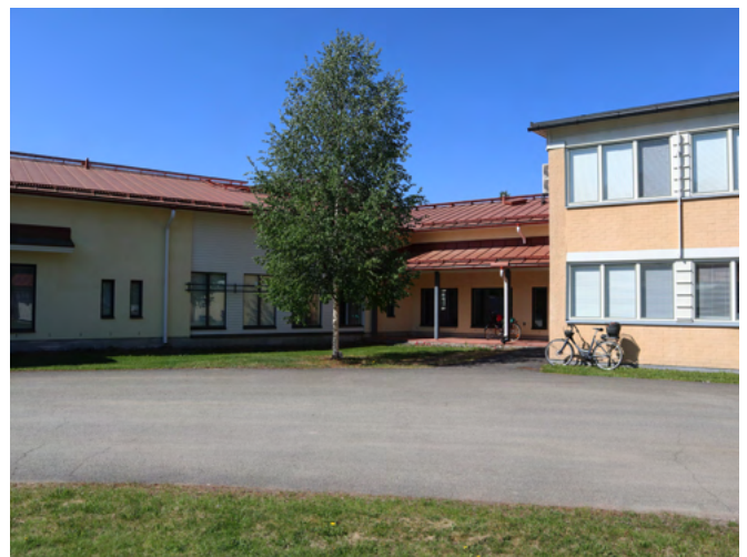
Nivelkohta vuosien 2013 ja 1965 valmistuneiden osien välissä. 2000-luvun osan julkisivussa on käytetty samoja materiaaleja: ohutrappattua tiiltä sekä valkeaa puuverhousta. Muun muassa vaaleampi sävy maailma, vino massoittelu sekä julkisivusommitelu paljastavat sen kuitenkin uudemmaksi osaksi.
