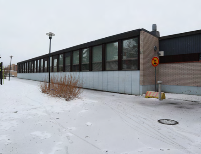
Alkuperäistä 1960-luvun itäjulkisivua. Lautamuottivalettu betoni on maalattu vaaleansiniseksi, nauhamaiset ikkunat karmeineen ovat tummanruskeita.
