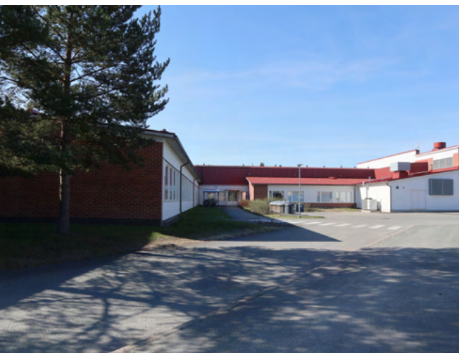
Vasemmalla koulun alkuperäinen punatiilipääty ja suoraan edessä 1990-luvun laajennus. Rakennus laajeni vielä vuonna 2010 uudella osalla, josta osa näkyy oikeassa reunassa.
