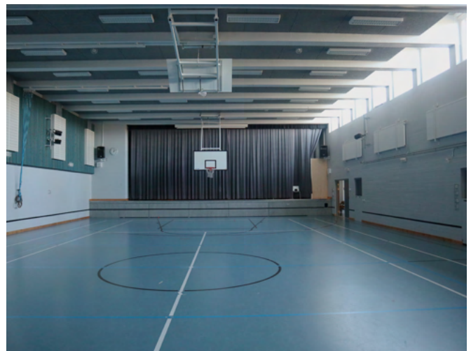
Liikuntasalissa on yläikkunat sekä kantavat betonirakenteet.
