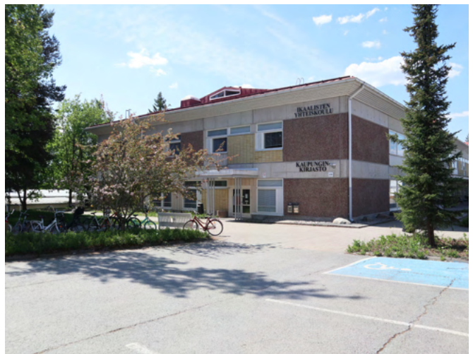
Vuonna 1976 valmistui yläkoulurakennus, johon sijoittuvat myös kirjaston tilat. Rakennuksen alkuperäinen tasakatto on muutettu aumakatoksi.
