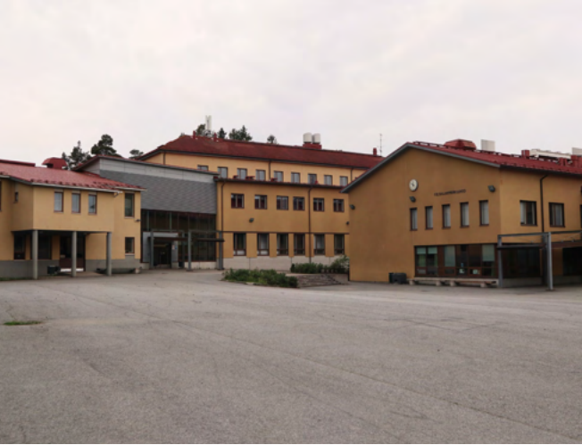
Koulukokonaisuuden vanhin osa on muita rakennuksia korkeampi. 1970-luvulla sen eteen sijoitettiin hallintosiipi. Vasemmalla näkyy laajennus 1990-luvulta, oikealla oleva laajennus on 2010-luvulta, jolloin myös sisäänkäyntiosa rakennettiin.
