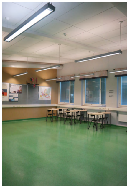
Luokahuonetilassa kattopalkisto on näkyvissä.
