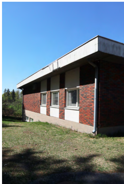
Eteläjulkisivussa ikkunoiden ylä- ja alapuolella on valkoista rappausta. Vesikatto on aumattu, mutta mineriittilevyt luovat vaikutelman tasakattoisuudesta.
