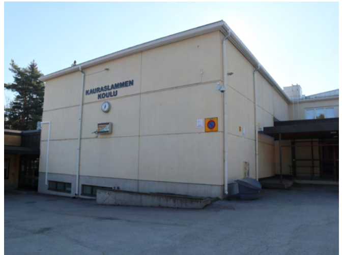
Alkuperäinen liikuntasali vuodelta 1961. Salin julkisivut ovat umpinaiset.
