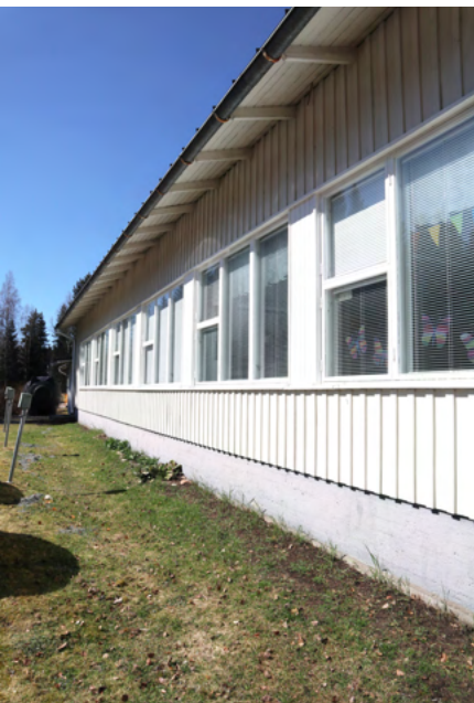
Eteläjulkisivussa on nauhamaisesti jäsennetyt ikkunat puisilla ikkunavälipilareilla.
