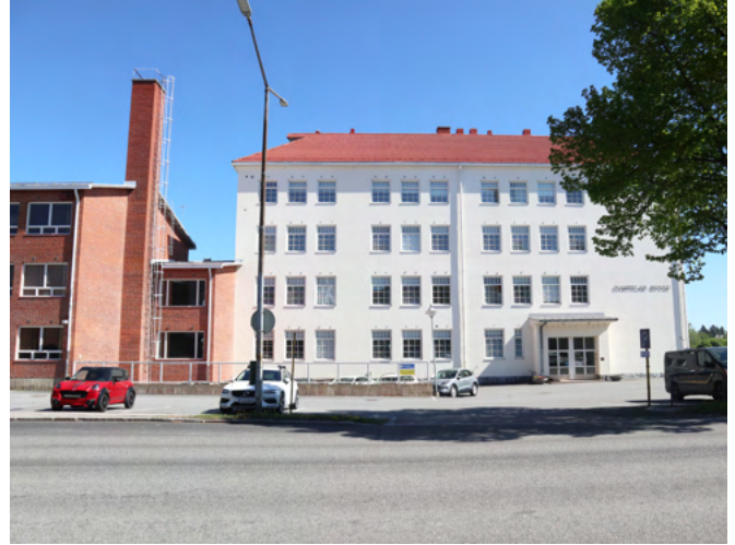
Vammalan lukio liittyy osaksi Marttilan koulua. Valkeaksi rapatun rakennuksen alimmat kerrokset ovat vuodelta 1921, korotuskerrokset 1950-luvulta.
