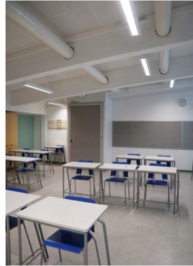
Normaalikoulun luokahuoneessa näkyy kantava betonipalkkisto ja lapekaton muoto.
