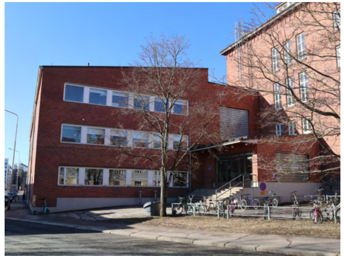
Pääsisäänkäynti on sijoitettu koilliskulmaan. Nauhaikkunoiden lisäksi julkisivuissa on käytetty suuria lasitiilipintoja.
