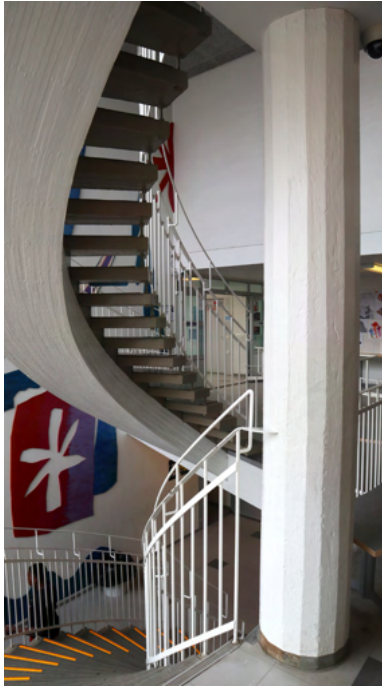
Takahuodin koulun lautamuottivalettuja betonirakenteita.
