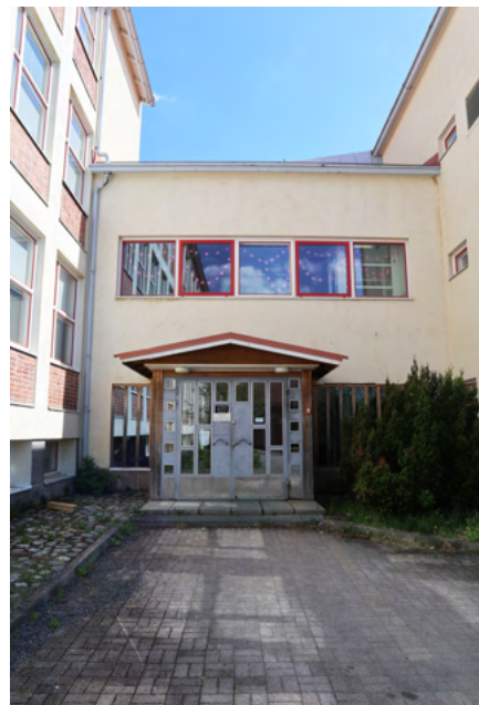
Sisäänkäynti laajennusosassa, vasemmalla 50-luvun rakennusta. Rakennuksen ikkunoita on uusittu.
