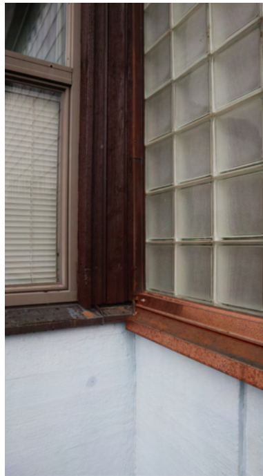
Tampereen Normaalikoulussa on lasitiili-ikkunat kuparipellityksillä sekä vaaleansiniseksi maalatut lautamuottivalupinnat.
