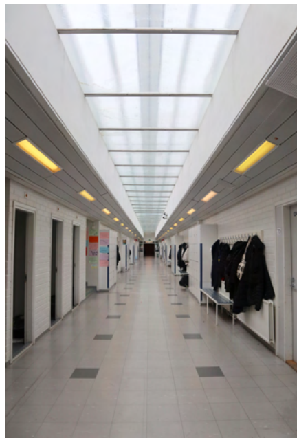
Keskikäytävällisessä luokkahuonesiivessä on valoa tuova kattolyhty.
