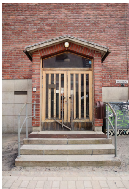
Rakennuksen eteläpäässä sijaitseva sisäänkäynti omalla satulakatollaan.
