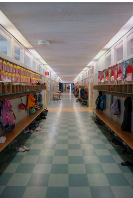
Alkuperäistä keskikäytävää. Kattoikkunat on purettu, mutta yläikkunat luokkahuoneisiin on säilytetty.
