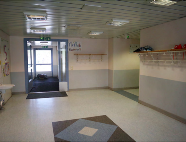
1961 valmistuneen alakoulun aulatila. Rakennus peruskorjattiin 1990-luvun alussa, ja sisätilan värimaailma ja materiaalit ovatkin tältä ajalta.
