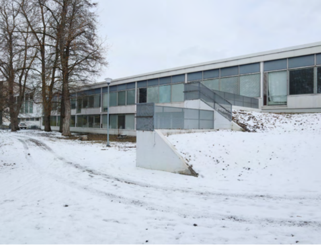
Takahuhdin koulun alkuperäistä luokkahuonesiipeä lounaan suuntaan.
