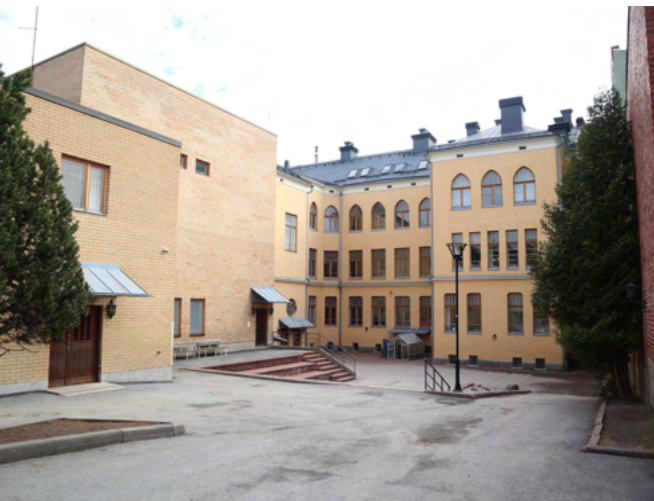
Samskolanin rakennuskokonaisuus sisäpihalta kuvattuna.
