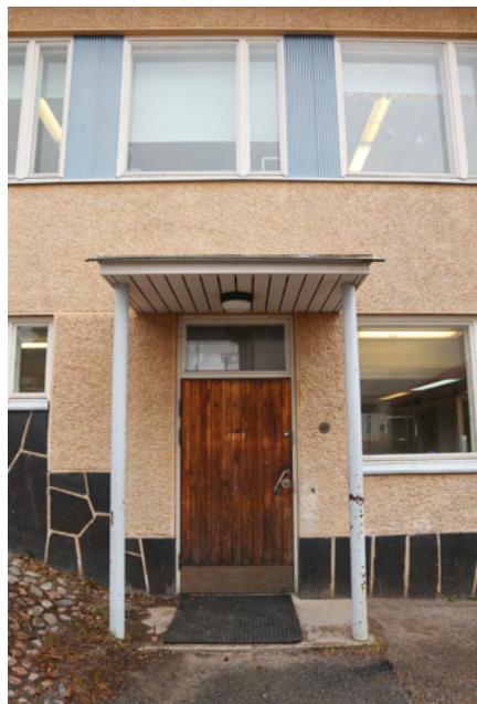
WC- ja keittiötilaan johtavat ovet ovat puisia. Sokkeli on liuskekiveä.
