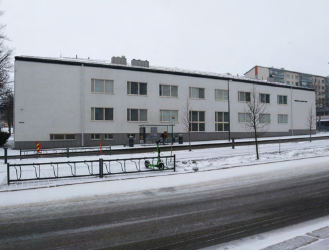
Vuonna 1967 valmistunut lisärakennus sijoittuu Rongankadun varrelle. Tasakatto muutettiin aumakatoksi 1990-luvulla.
