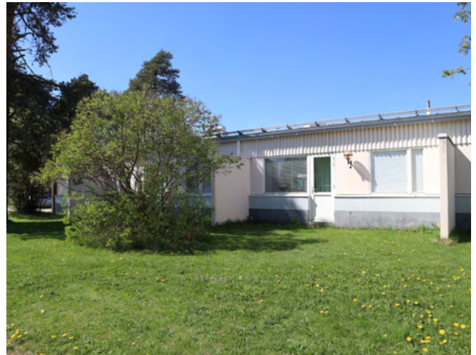
Rakennukset rajaavat koulun piha-alueen suojaisaksi. Rivitalomallisen entisen asuntolasiiven asuntokohtaiset pihat on erotettu toisistaan seinäkkein.
