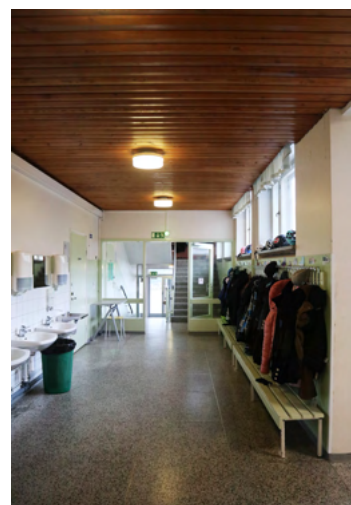
Aulasta erkaneva käytävä ja porashuone. Puupaneloitu katto ja kivilaattalattia lienevät alkuperäisiä 1950-luvun lopulta.
