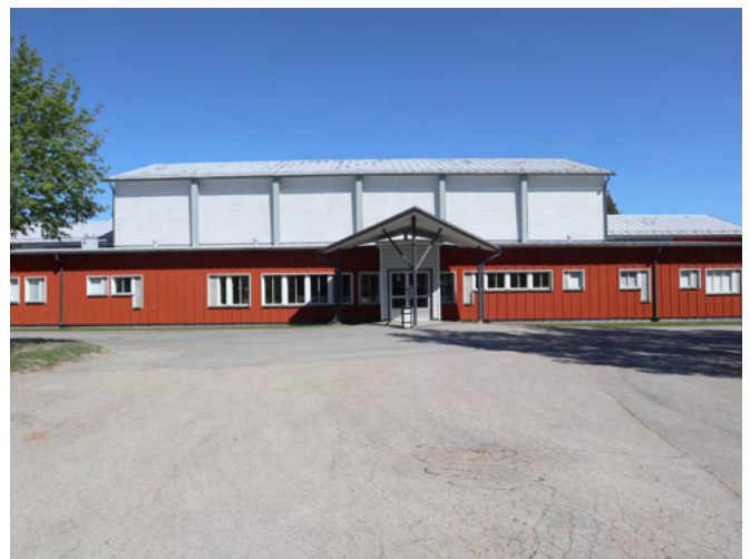
1970-luvulla rakennettu liikuntahalli on muuttunut merkittävästi. 1980-luvun lopulla peruskorjattu ja laajennettu halli sisältää liikuntasalin lisäksi kuntosalitiloja.
