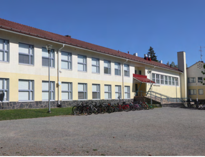
Muistolan koulun vanhempi osa on rakennettu 1950-luvulla. Oikealla näkyy opettajien asuntolasiipi, joka on otettu opetuskäyttöön.
