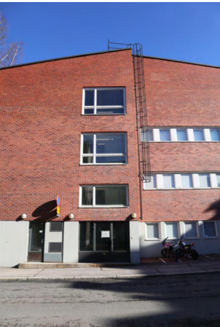
Siukolankadun eteläjulkisivussa on päätyyn sijoitetun porrashuoneen alkuperäisiä puuikkunoita.
