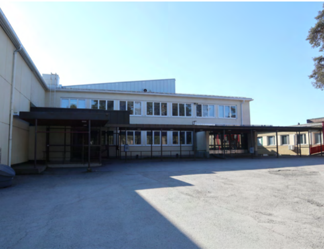
1960-luvun alussa valmistui koulun ensimmäinen osa, jossa nauhamaisesti sijoitetut ikkunat erotettiin mineriittilevyillä. Muutoin julkisivu on rapattua leca-harkkoa.
