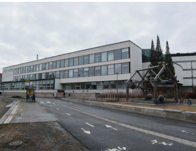
Sampolan kolmikerroksinen luokkahuonesiipi Sammonkadun varressa. Ruokala erottuu ensimmäisen kerroksen ulokeosana.
