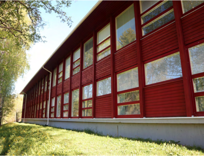
1960-luku on tunnistettavissa julkisivusta nauhamaista ikkunoista, joista joka toisessa on vaakapuitejako. Alun perin rakennuksen julkisivut ovat olleet ilmeisesti tasaista levyä.
