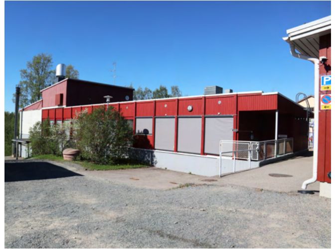
Koulun itäjulkisivua. Rakennusta korotettiin vuonna 2001 ilmanvaihtokonehuoneella, joka näkyy kuvassa vasemmalla.
