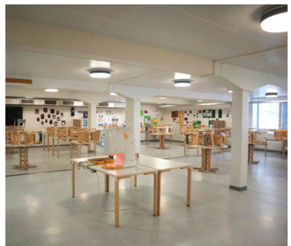
Ruokalassa näkyvät betoniset pilarit ja palkistot. Tila on osin maanvastainen, ikkunat avautuvat itään Sentraalinkujalle.
