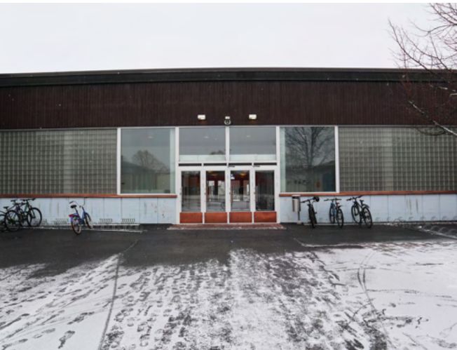
Sisäpihan julkisivuissa on suuria 1960-luvun ikkuna- ja lasitilipintoja.
