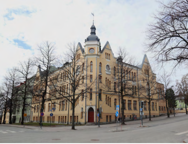
Koulukadun ja Satamakadun kulmassa sijaitseva Samskolan on julkisivuaiheistoltaan runsas ja näyttävä.
