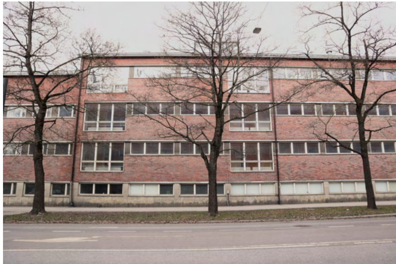
Tampereen Tammelan koulun Kalevan puistontien puoleisessa julkisivussa on nauhaikkunat, jotka sijoittuvat sivukäytävän kohdalle. Suurempia ikkunoita on sijoitettu porrashuoneisiin.
