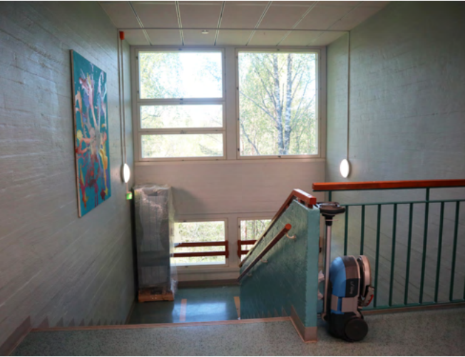
1960-luvun osaan sijoittuu porrashuone, jossa näkyy maalattuja lautamuottivalettuja betonipintoja.
