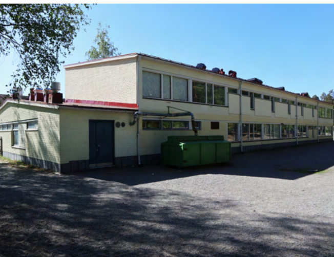
1960-luvun laajennuksen pohjoisjulkisivun ikkunat on sijoitettu nauhamaisesti. T-malliset ikkunat avaavat käytävästä näkymiä myös ympäristöön.
