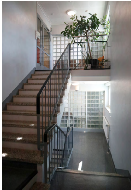
Pohjoispäädyssä oli alun perin oppilasasuntoja. Portaikon lasitiiliseinät olivat ruokailu- ja seurustelutilojen kohdilla.
