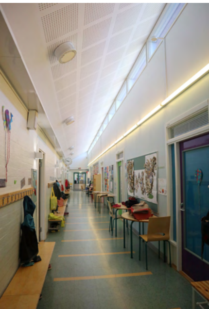
1960-luvun entisestä sivukäytävästä on laajennuksen myötä tullut keskikäytävä. Klerestorioikkunat tuovat valoa tilaan.
