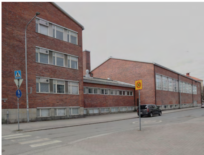
Vuoden 1957 valmistuneet osat porrastuvat eri korkeuksiin. Kaikki ovat satulakattoisia, tiilipintaisia ja nauhaikkunallisia. Ikkunoiden väleissä on pellitystä.
