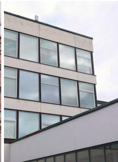
Tampereen Sampolan julkisivu on vaalea, joka oli tiilen lisäksi myös ajanmukainen ratkaisu 60-luvulla.
