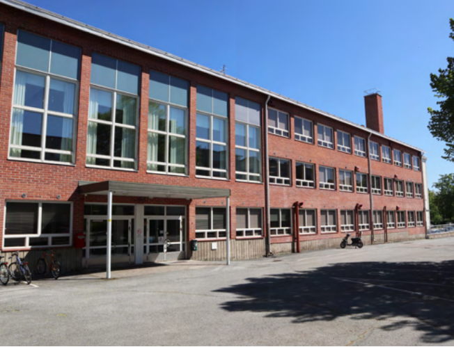
Tiiliverhottu rakennus on valmistunut 1962. Liikuntasalin ylimmät ikkunarudut on peitetty 1990-luvulla.
