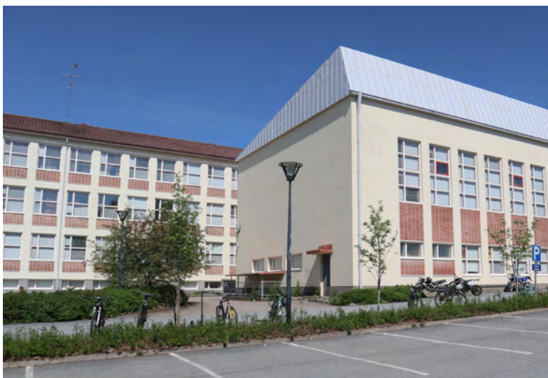
Ikaalisten yhteiskoulurakennuksen 60-luvun laajennus jatkaa 1950-luvun alkuperäisen osan arkkitehtuuria samoilla materiaaleilla.
