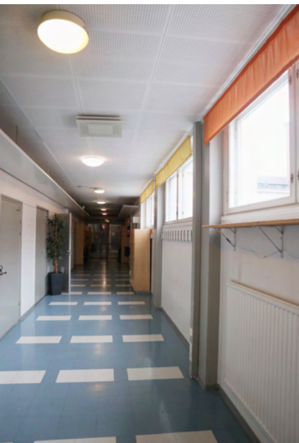
Käytävätila. Puuikkunoiden alla on metallikannatteiset hyllylevyt.
