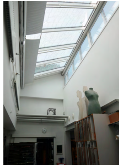
Sampolan matalan T-siiven luokahuoneissa on kattoikkunat.
