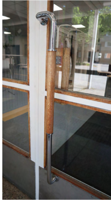
Vammalan lukion pääsisäänkäynnin lankavetimestä on käytetty puuta ja metallia.
