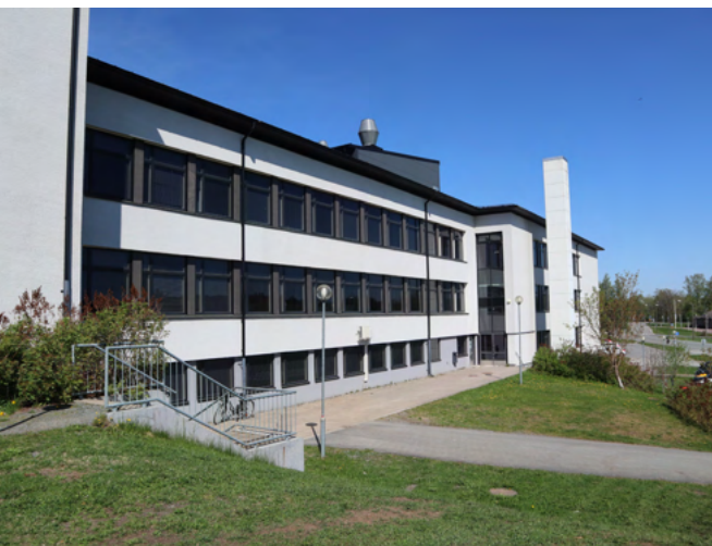
Laajennusosan itäjulkisivua Kurisjärventien suunnalta. Luokahuonesiivet erottuvat nauhamaisiin ikkunarivein, porrashuoneiden ikkunat on sijoitettu ulkoneman kohdalle.
