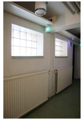
Kellarikerroksen lasitiili-ikkunat tuovat valoa käytävään.
