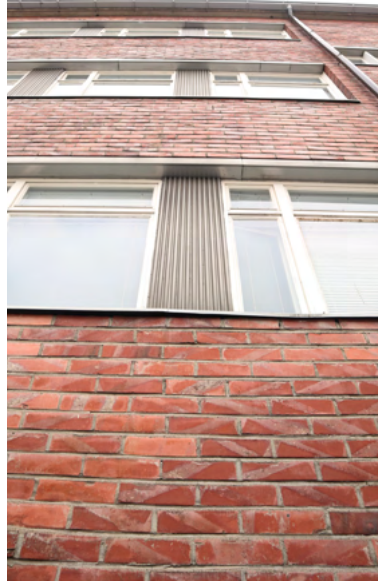
Tammelan koulu Tampereella. Kantavat betonirakenteet vapauttivat julkisivun nauhamaisille ikkunoille.
