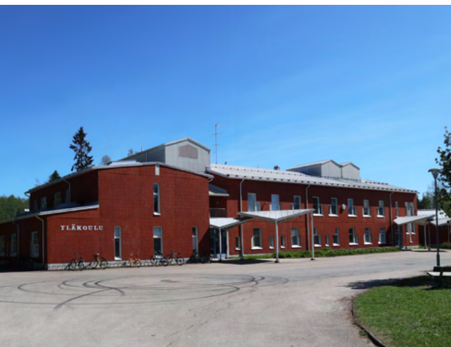
Vuonna 1993 rakennettu yläkoulun rakennus on tiilielementein verhottu. Rakennuksen julkisivulle ilmettä antavat lennokkaat katosrakenteet.
