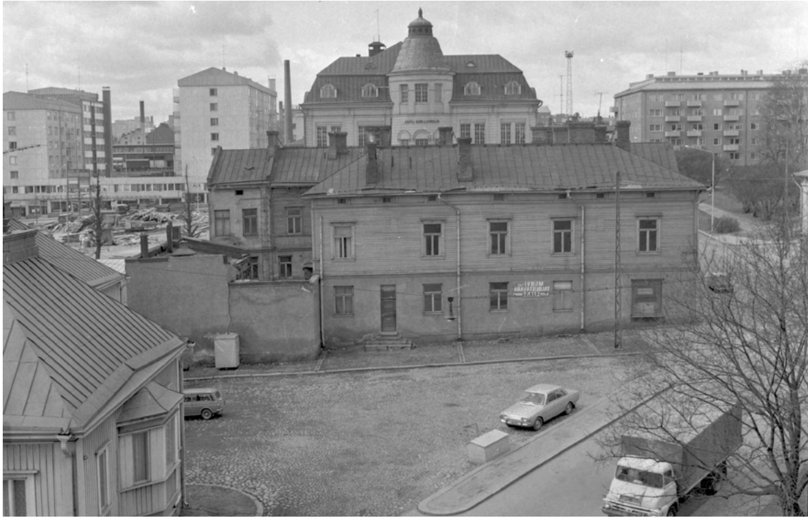
Klassillinen lyseo ja purettavat talot 20.4.1967 Tampereella. Edustalla näkyvän puurakennuksen paikalle rakennettiin klassillisen lyseon laajennus Rongansiipi. (Kuva: Veikko Lintinen, Vapriikin kuva-arkisto.)
