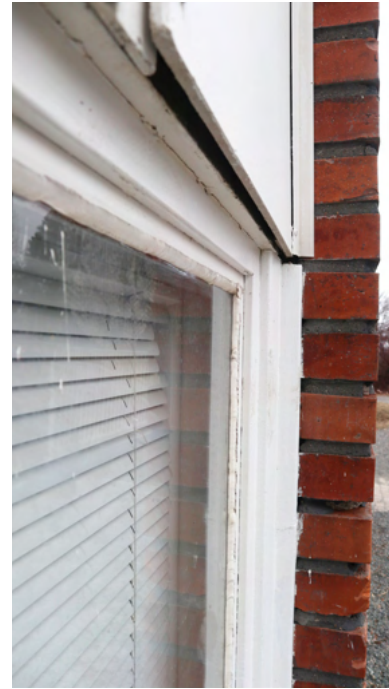
Hatanpään koulu Tampereella on 1960-luvulle tyypillisesti verhoiltu tiilellä ja mineriittilevyllä.
