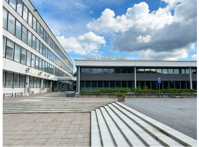
Luokkahuonesiivissä on nauhaikkunat. Sampolan kirjasto erotuu uudempana kerrostumana vanhasta päärakennuksesta, mutta sopeutuu sen yleisilmeeseen. Kuva kesästä 2023.
