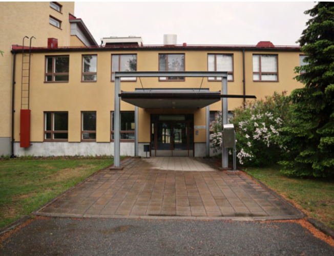
1960-luvulla rakennetun osan julkisivuilme on uudistettu täysin 2010-luvulla. Sisäänkäynti katoksineen on tältä ajalta. Alkuperäiset nauhaikkunat korvattiin pienemmällä aukotuksella.
