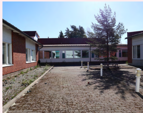
Lempäälän Moision koulu on laajennusten myötä muodostunut atriumkouluksi, jolla on suljettu sisäpiha.
