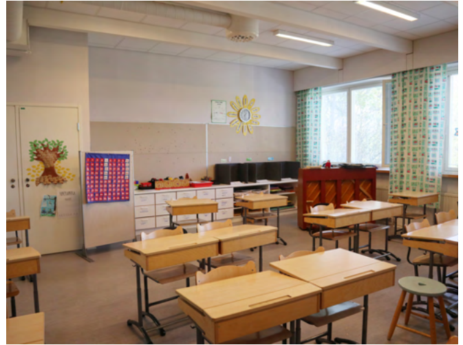
Saman luokkahuoneen toinen pääty. Rakennukseen on toteutettu ilmanvaihtoremontti.
