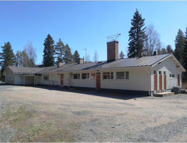
Kotalan koulun pohjoisjulkisivua välituntipihalta kuvattuna. Vasemmalla näkyy vuonna 2001 toteutettu pienehkö laajennus.
