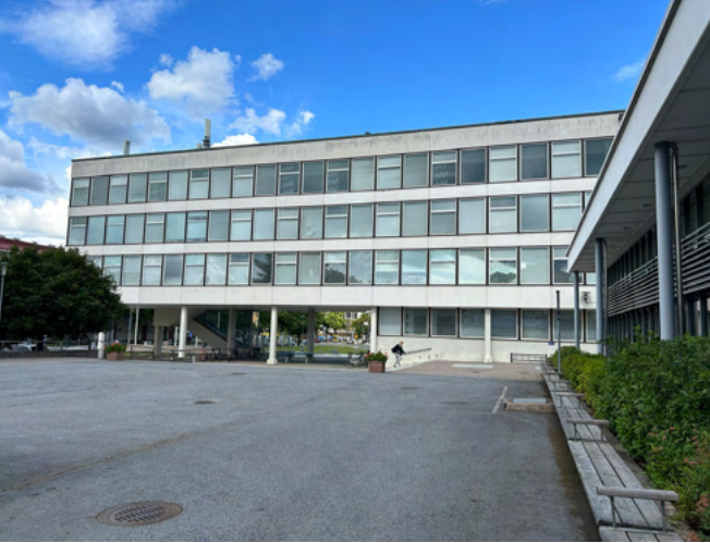
Oikealla sisäpihan kirjastolaajennus vuodelta 2002. Alkuperäinen, osin nelikerroksinen luokkahuonesiipi on nostettu pilareille. Kuva kesästä 2023.
