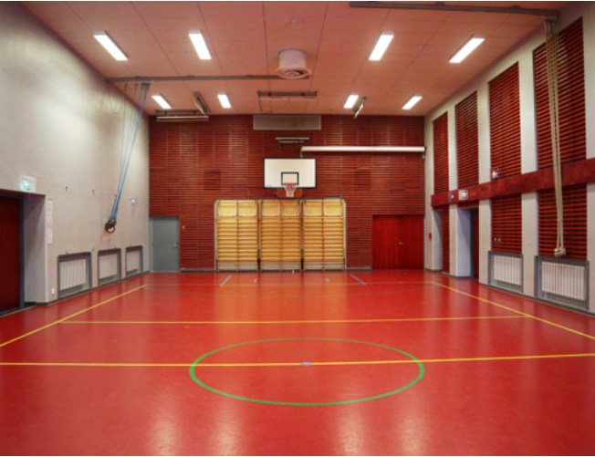
Vuonna 1963 valmistuneen salin ikkunat on peitetty.
