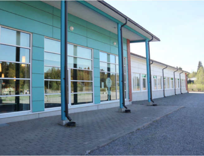
Vuonna 2010 rakennus laajeni suurella massalla tontin länsi-osaan. Sen erottuin osa on sinivihreällä levytyksellä verhottu ruokala.
