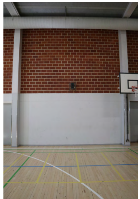
Liikuntasalin reikätiiliseinä on 1960-luvun laajennusvaiheesta.
