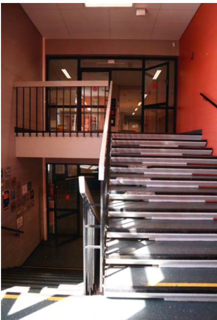
Rakennuksen itäjulkisivun porrashuoneet on sijoitettu niin, että ne saavat runsaasti luonnonvaloa sivuikkunoista.
