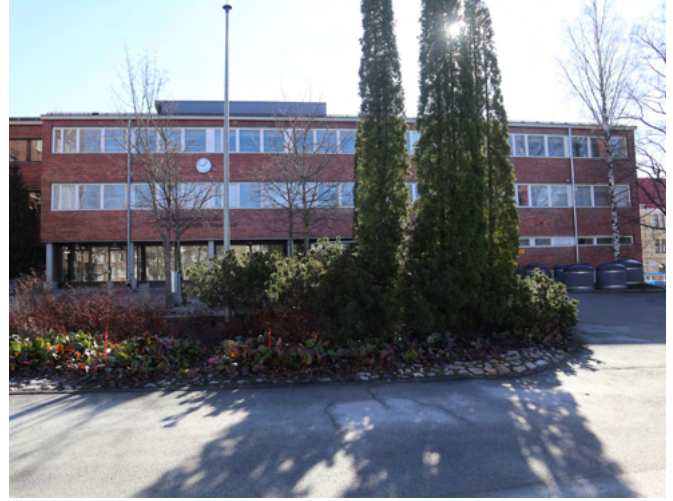
Laajennus on horisontaalinen nauhamaisten ikkunoidensa sekä pitkän arkadikäytävänsä vuoksi.
