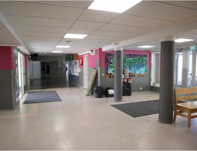
Pääsisäänkäynti. Vasemmalla näkyy pihan puolelle avautuva sisäänkäynti, joka on alkuperäisellä paikallaan. Oikealla länsijulkisivun sisäänkäynti, joka sijoittuu laajennusosaan.
