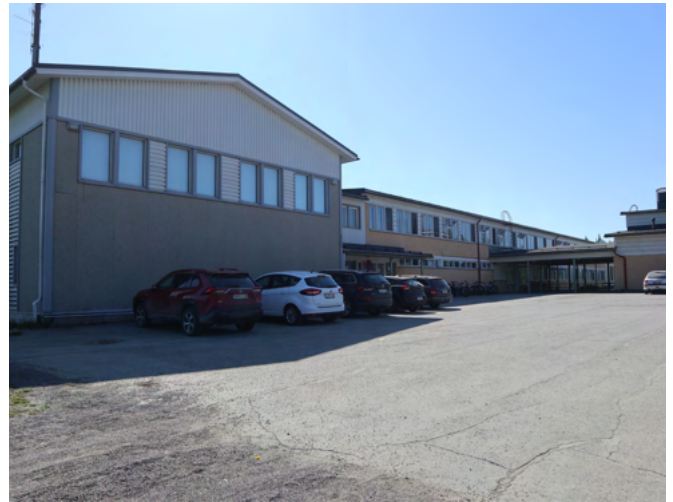
1990-luvun alussa valmistunut liikuntasalisiipi erottuu kontrastisena pellitetyllä ja kivilevyverhotulla julkisivullaan.
