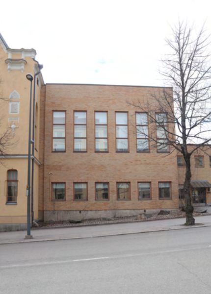
Vuoden 1965 laajennuksessa on korkeat ikkunat toisen kerroksen liikuntasalin kohdalla.
