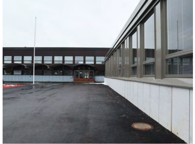
Oikealla näkyvä julkisivu on uudistettu vaaleammaksi. Alun perin se on ollut vaaleansininen alaosastaan ja tummanruskea yläosastaan, kuten muut 1960-luvun osat.
