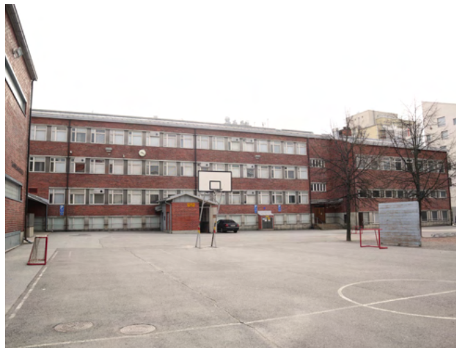
Näkymä välituntipihalta kohti itää. Pitkä julkisivu rajaa välituntipihan Kalevan puistotiestä.
