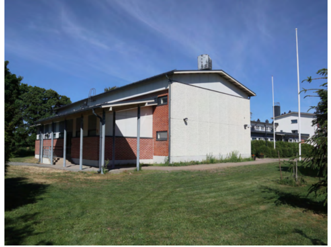
Liikunta-juhlasalin julkisivut ovat pesubetonielementtejä sekä tiiltä. Rakennus on valmistunut 1963. Sitä on sittemmin laajennettu pienellä lisäosalla.
