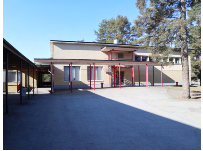
1980-luvun puolivälissä rakennettu hammashoitolan siipi on julkisivultaan keltatiiltä ja rappausta.
