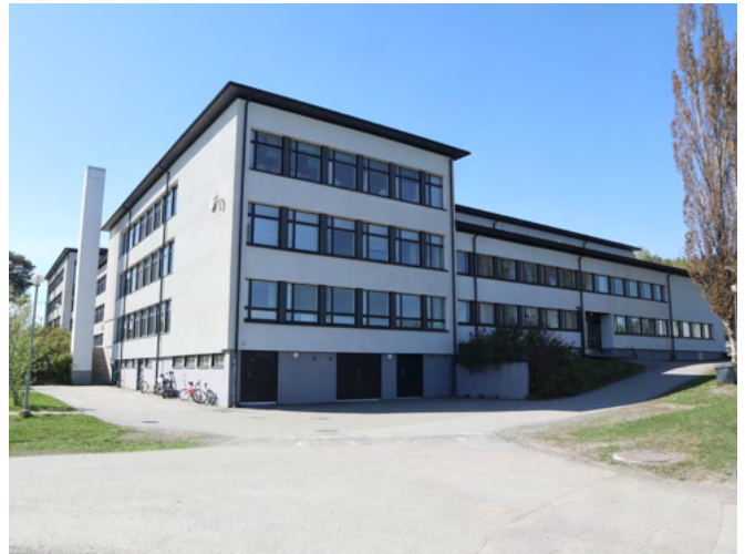
Laajennusosa pohjoisjulkisivussa näkyvät eri korkuiset massat. Nauhaikkunat korostavat rakennuksen horisontaalisuutta.
