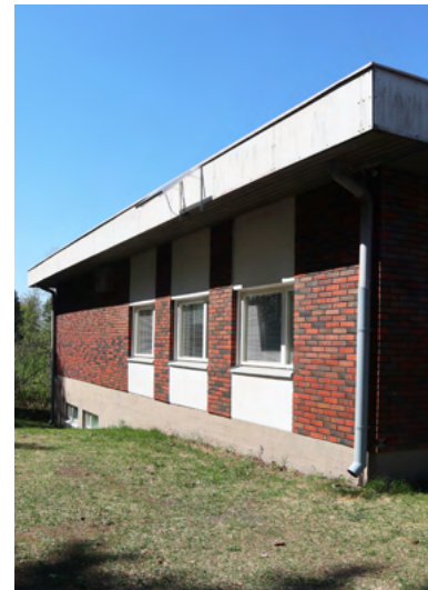
Tarttilan koulun laajennuksen aumakatto on verhoiltu muodinmuokaiseksi tasakatoksi mineriittilevyin.
