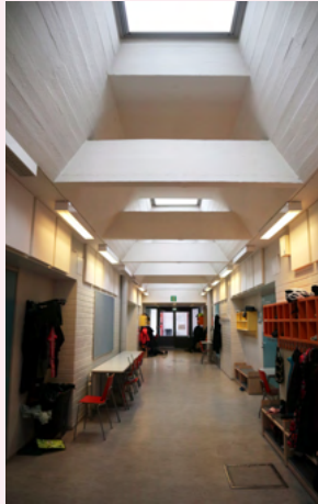
Yksikerroksisen Normaalikoulun käytävässä on kattoikkunat.
