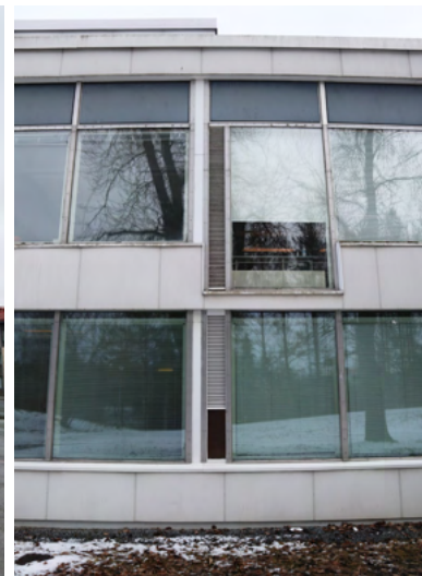
Takahuhdin koulun julkisivua.
