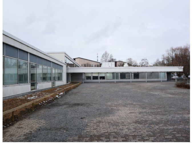
Vasemmalla luokkahuoneita ja edessä pitkä katosaihe, joka johtaa koulun sisäänkäynnille.
