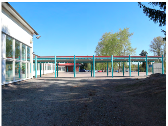
Sisäänkäynti korostuu pitkällä välituntikatoksella, joka on rakennettu vuonna 2003.
