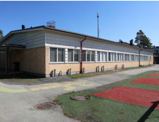
Myös työpajasiiven julkisivussa on käytetty puuverhousta sekä ohutrappausta tiiliverhouksen päällä. Vasemmalla näkyvässä päädyssä on alun perin ollut talonmiehenasunto.
