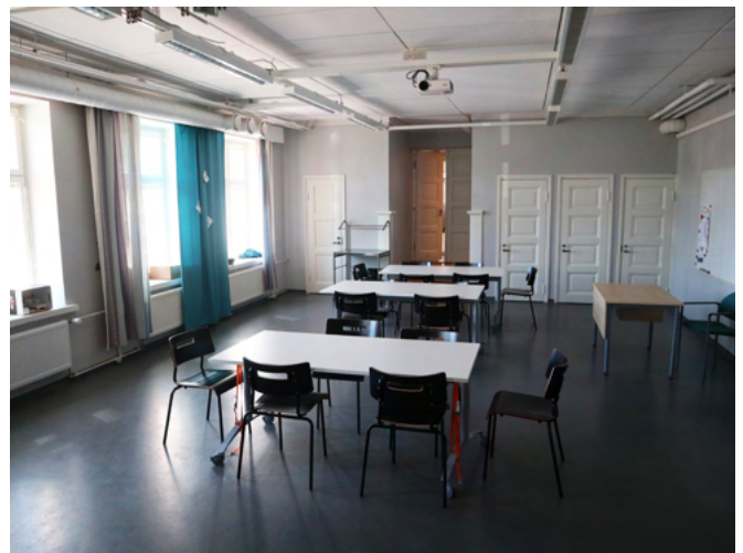
Ruokala-liikuntasali kuvattuna lavalta. Vanhoja peiliöitä on säilynyt, muutoin tila on täysin saneerattu.
