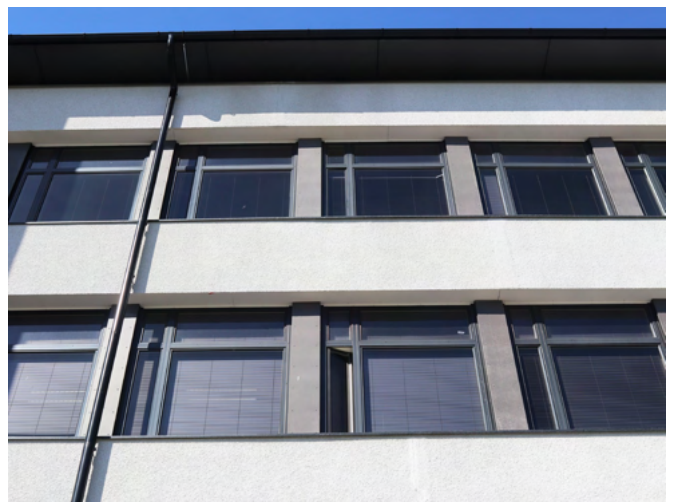
Laajennus on ollut tiilipintainen, mutta se on eristerapattu vuosien 2010-2012 peruskorjauksessa. Nauhaikkunoiden luoma horisontaalinen ilme on kuitenkin säilynyt julkisivuissa.
