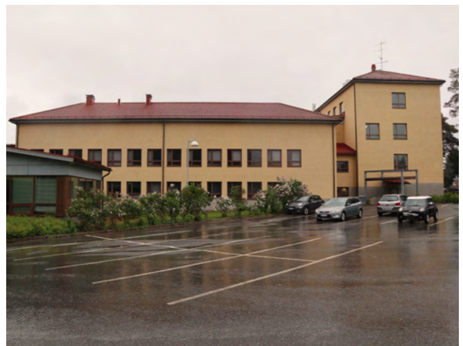
Koulun vanhimmat osat ovat 1950-luvulta. Oikealla vanhin, vuonna 1952 valmistunut osa, ja edessä 1955 valmistunut fysiikan ja kemian opetuksen siipi. Vasemmalla ruokalan laajennus 2010-luvulta.
