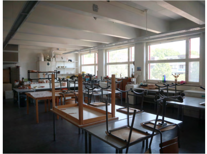
60-luvun laajennukseen sijoittuva kuvataideluokassa näkyvät kantavat betonipalkistot.
