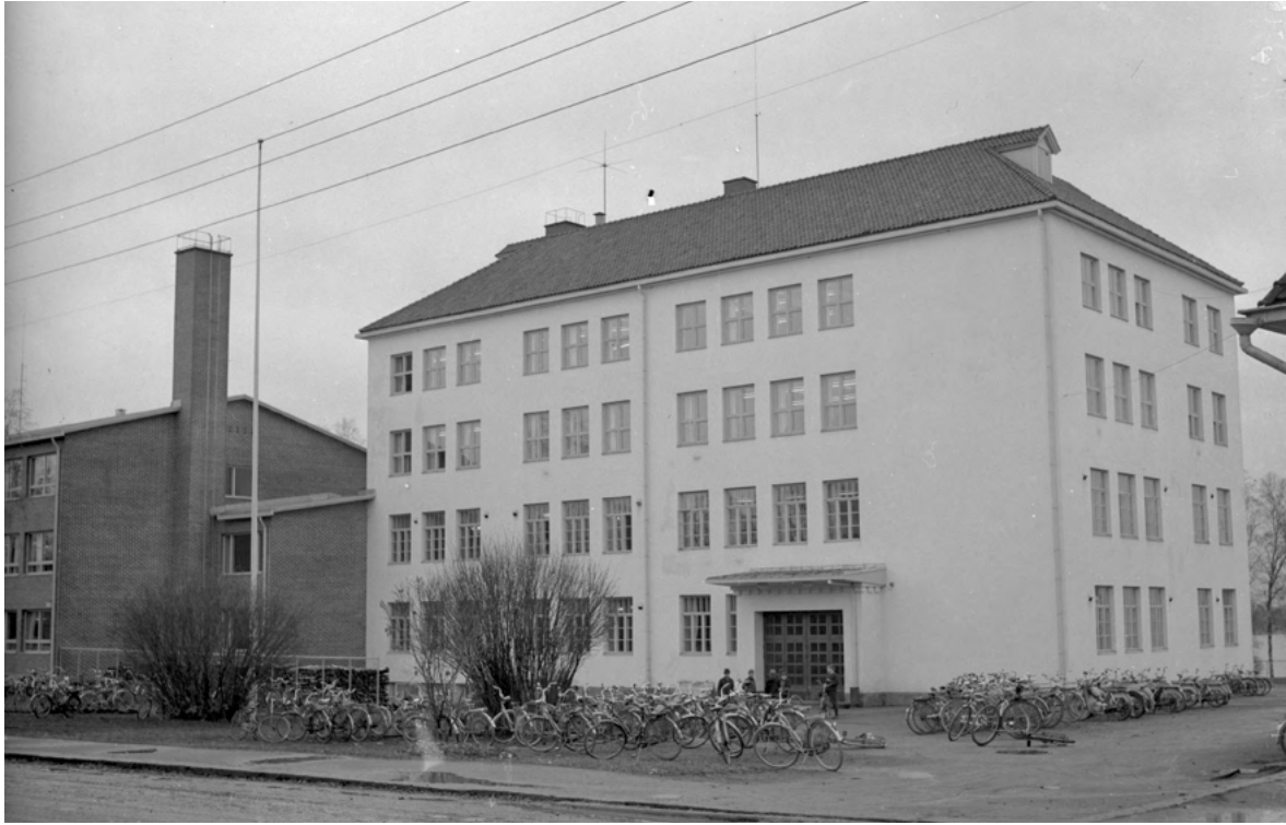
Vammalan yhteiskoulu 24.10.1964. Vasemmalla näkyvä 60-luvun rakennus täydentää valkoista, alun perin 1920-luvulla rakennettua koulua. Laajennus- ja täydennysosat olivat aikakaudella tyypillisiä, ja kouluja on monesti laajennettu myös 1960-luvun jälkeen. (Kuva: Reino Branthin, Vapriikin kuva-arkisto.)
