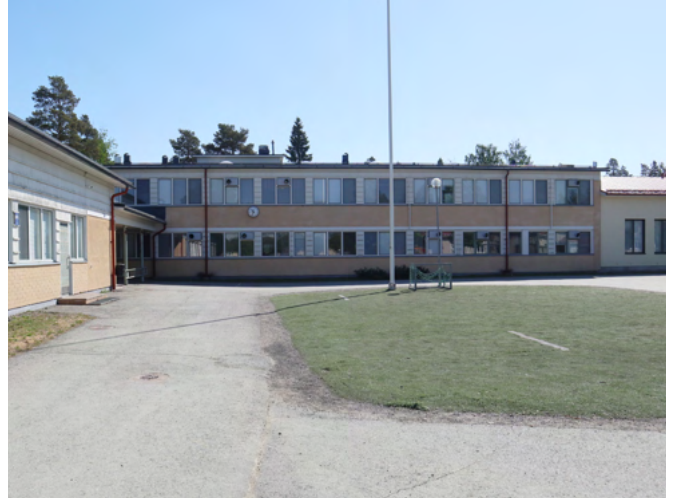
1960-luvun osassa on nauhamaisesti sommitellut ikkunat, ikkunoiden väliin jää lautaverhoilulla rustikoidut ikkunapilarit sekä kellertäväksi slammattu tiiliverhous. Vasemmalla samaan aikaan valmistunutta yksikerroksista työpajasiipeä.
