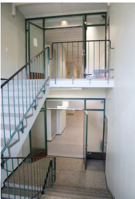
Eteläisessä porrashuoneessa on säilynyt 1960-luvun materiaaleja: metalliset pinnakaiteet ja mosaiikkibetonipinnat.
