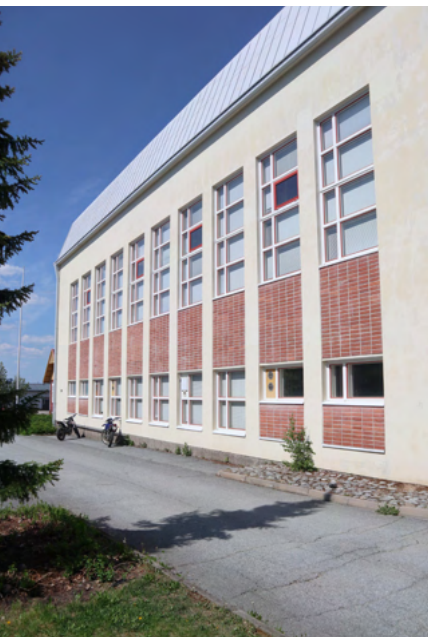
Laajennus on julkisivuiltaan rapattu, ikkunoiden alapuolella on näkyvä rappamatonta tiiltä, jossa on votsilimitys.
