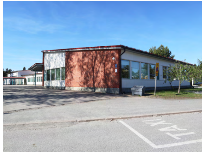
Moision koulun vuoden 2003 laajennus jatkaa alkuperäistä julkisivuilmettä punatiilellä ja sileäpintaisella kivilevyllä. Osa muistuttaa 1960-luvulle tyypillistä arkkitehtuuria.
