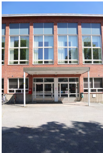
Pääsisäänkäynti avautuu Marttilankadulle. Sen yläpuolella on liikuntasalin suuret ikkunat.
