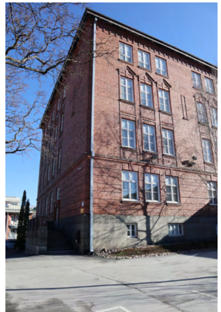
Ensimmäisessä kerroksessa on käytetty ristilimitystä ja ylemmissä vuorolimitystä. Kivijalka on graniittia.
