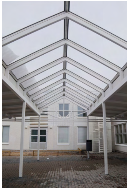
Vuonna 1990 valmistui kouluun laajennus, joka jatkaa vaaleaa julkisivuilmettä.
