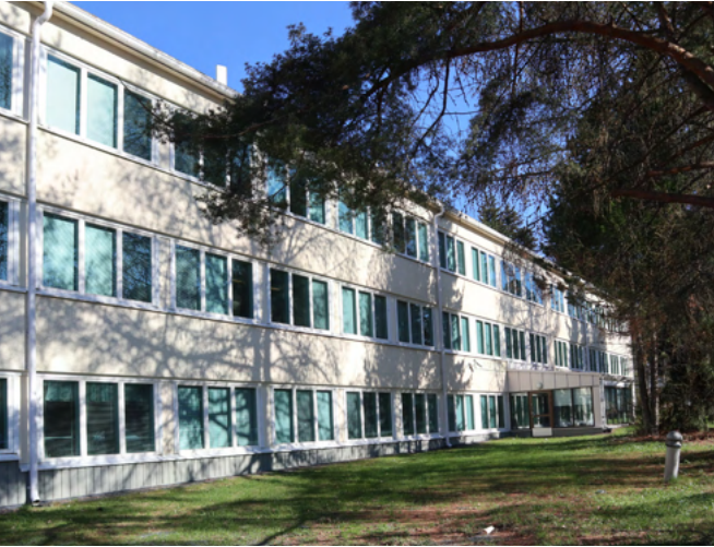
1960-luvulla rakennettujen osien yhtenäinen, nauhamainen julkisivu kaakon suuntaan.
