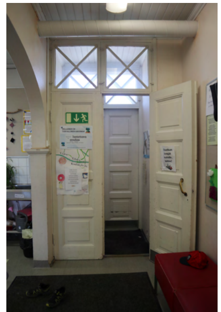
Alkuperäisen osan sisäänkäynti. Puupeiliöiden päällä on salmiakkiruutuiset ikkunat.
