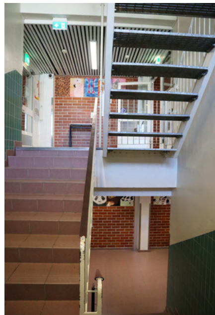
1960-luvulla rakennetun osan porras-huone. Alkuperäisiä materiaaleja ei ole juuri säilynyt.
