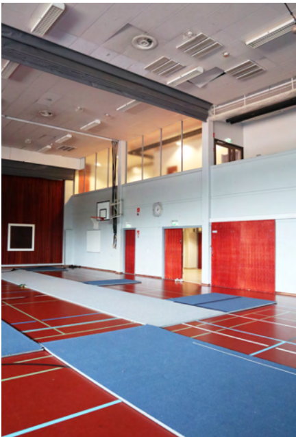
Liikuntasalissa on alkuperäisiä betoni- ja tiilirakenteita sekä lankalasi-ikkunoita.
