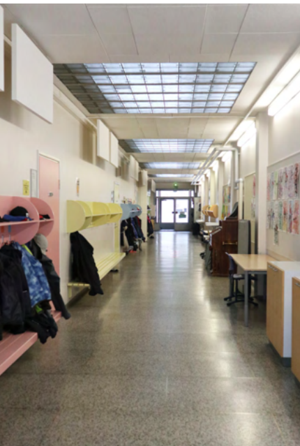
Luokkahuonekäytävällä on lasitiiliset kattoikkunat.
