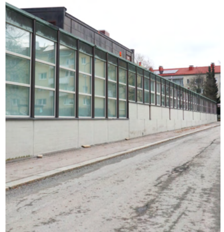
Työpaja- eli T-siiven eteläjulkisivussa ikkunoita erottavat tummat ikkunapilarit.
