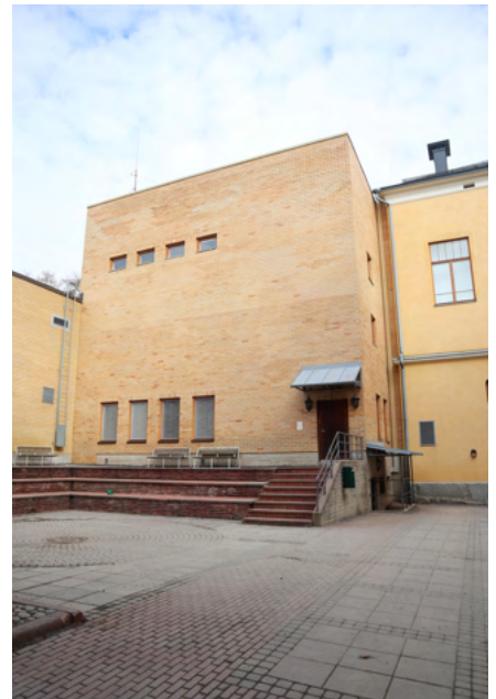
1965 valmistuneen laajennuksen sisäpihan julkisivu on hillitty ja umpinainen.
