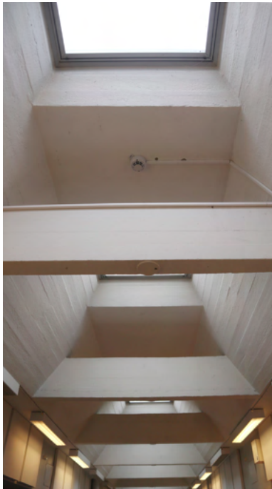
Lautamuottivaletut betonipinnat kattoikkunan rakenteina luovat Normaalkoulun keskikäytävään luonnetta.
