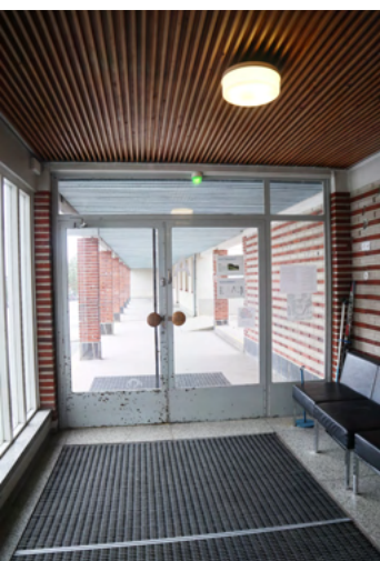
Tuulikaapissa on puupaneloitu katto sekä alkuperäiset teräsovet pyöreine vetimineen.
