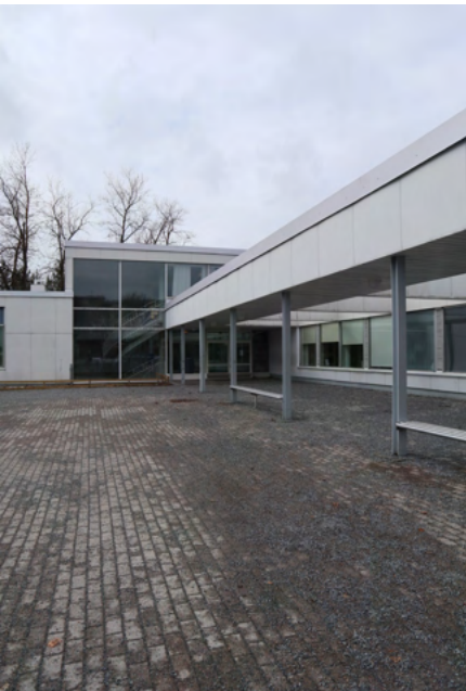
Katos johtaa kahden kerroksen korkeeseen aulatilaan. Katoksessa on suuret valoaukot.
