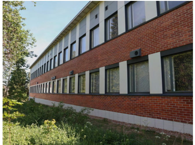
Länsijulkisivultaan luokkahuonesiipi on kaksikerroksinen. Julkisivuilme perustuu nauhaikkunoiden ja tiiliverhouksen vuorotteluun.
