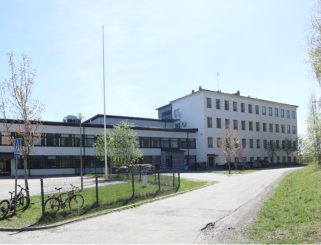
Oikealla Toijalan yhteiskoulun vanhempi, 1950-luvun alussa rakennettu osa. 1960-luvulla rakennusta laajennettiin pohjoisosaan sijoitetulla, pääosin 2-3-kerroksisella massalla.
