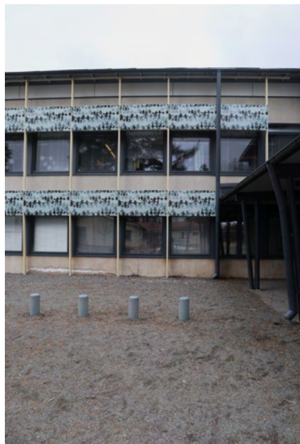
Vanhassa 1960-luvun osassa on nauhamaiset ikkunat ja betonielementit.
