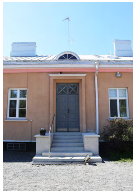
Vanhan klassistisen rakennuksen sisäänkäynti on juhlava puisin pariovin, salmiakki-ikkunoin sekä kivisin portain. Ullakkokerroksessa on lunetti-ikkunoita.
