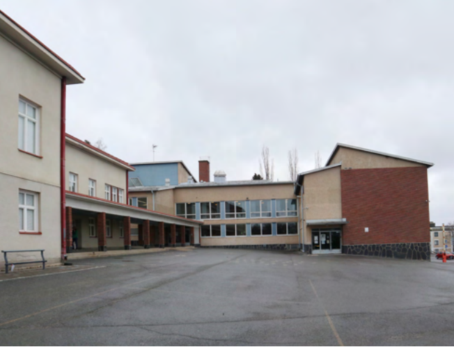
Kirkkoharjun koulun vanha osa vasemmalla ja vuonna 1959 valmistunut laajennusosa edessä.
