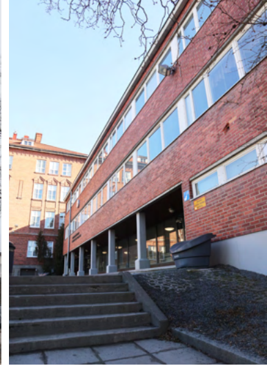
Tampereen Juhannuskylässä sijaitsevan Tammerkosken koulun rakenne on betoninen ja tiili on verhouksena julkisivussa. Rakenusmassan alle jää pilarikäytävällä erotettu sisäänkäyntikatot.
