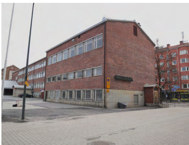
Vireillä olevassa asemakaavamuutoksessa suojeltaneen kuvassa näkyvä eteläpäätty.
