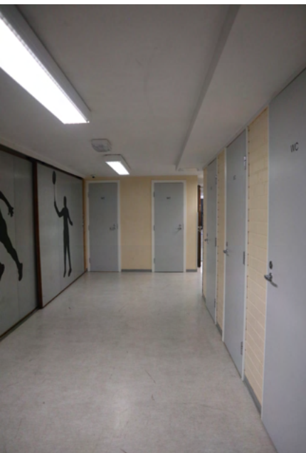
Pohjakerros laajennusosassa, vasemmalla liikuntasali.
