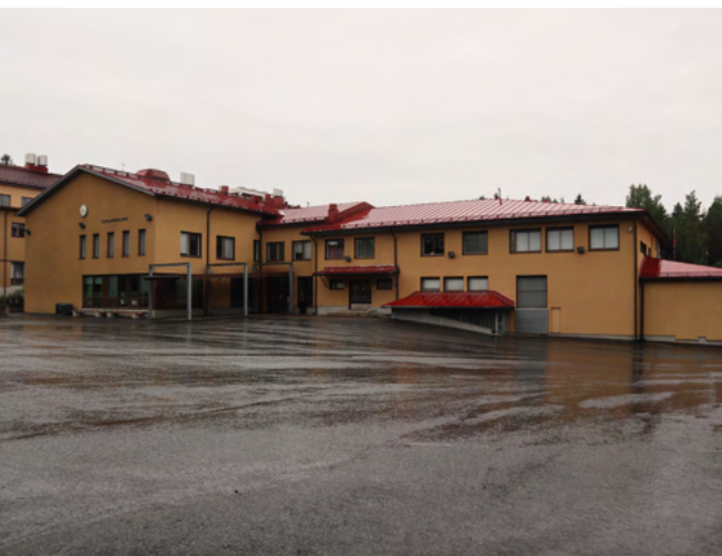
Koulun pohjoispuolelle sijoittuu välituntihiha. Vasemmalla lukion laajennus 2010-luvulta. Oikealla 1980-luvulla rakennettu auditoriolaajennus, jonka takana 1960-luvun liikuntasalisipi.
