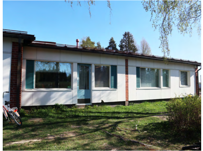
Osa vanhasta opettajien asuntolasiivestä on säilynyt alkuperäisessä asussaan. Osa asunnoista purettiin vuoden 2010 muutoksissa.
