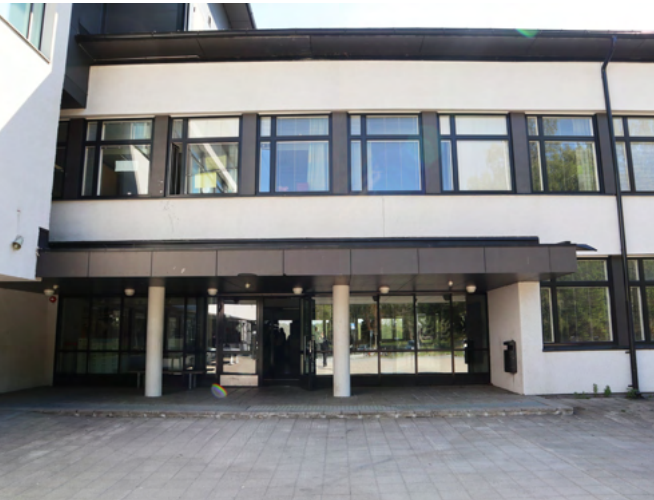
Pääsisäänkäyntiä kehystävät kaksi lautamuottivalettua betonipilaria. Ikkunanauhojen tummat karmi- ja puiteosat sekä harmaat ikkunapilarit luovat kontrastin uudehkolle valkoiselle rappauspinnalle.
