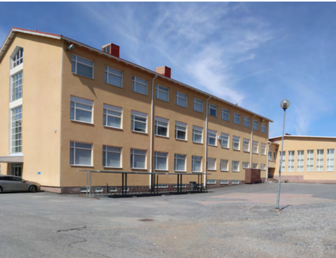
1950-luvulla rakennettiin luokkahuonesiiven lisäksi myös liikunta-juhlasali, joka oli huomattavasti nykyistä pienempi. Oikealla näkyy alkuperäinen korkea ikkunasommitelma.
