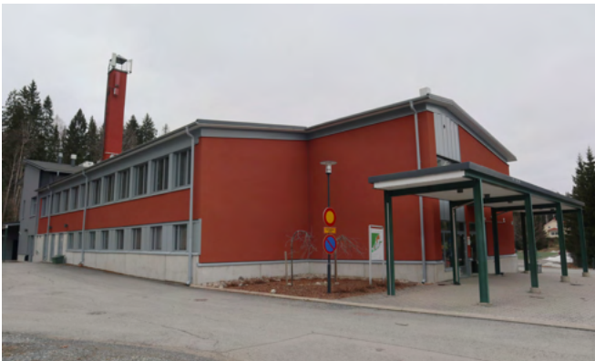
1950-luvun lopulla valmistuneen osan ulkoasu on muutettu 2010-luvun alun saneerauksessa vastaamaan laajennusosaa.
