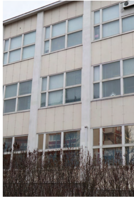
Pitkissä julkisivuissa on käytetty mineritiilevyä ja betonipilastereita.
