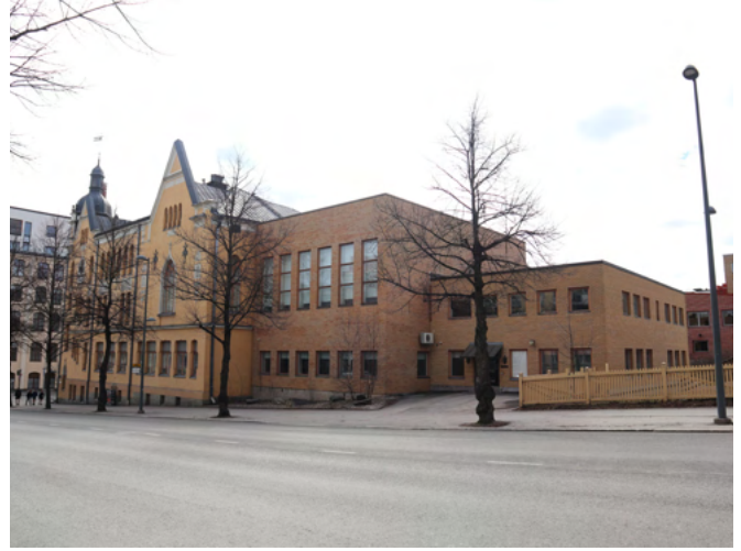
Samskolanin alkuperäinen osa kuvassa vasemmalla, vuoden 1965 laajennus keskellä ja vuoden 1973 laajennus oikealla.
