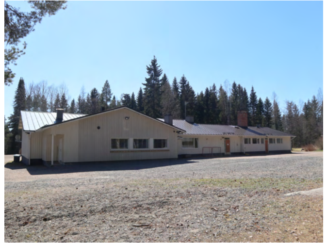
Vasemmalla näkyvä laajennusosa jatkaa alkuperäisen osan ilmettä samalla kattomuodolla ja julkisivulaudoituksella.
