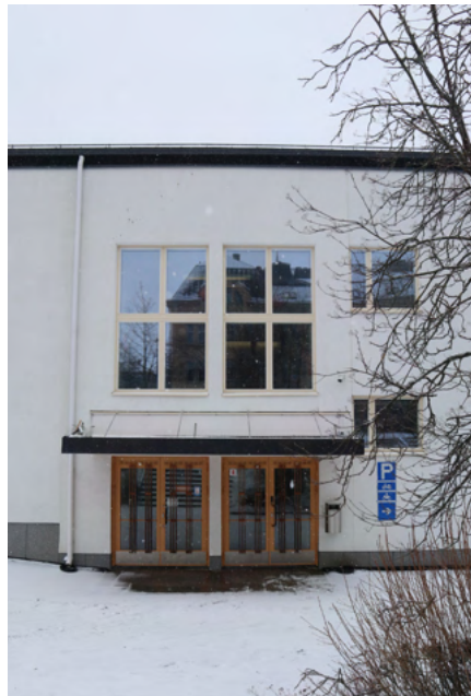
Alkuperäinen sisäänkäynti sisäpihan puolella pohjoisjulkisivulla.
