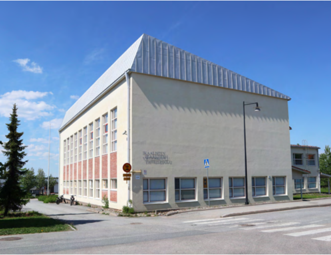
Vuonna 1960 valmistui laajennus yhteiskoulurakennukselle. Laajennukseen sijoitettiin liikunta-juhlasali sekä muutamia luokkahuoneita.
