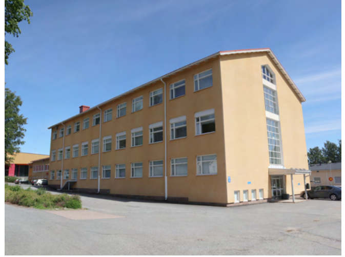
Vuonna 1952 valmistunut ja vuonna 1960 kerroksella korotet- tu luokkahuonesiipi edustaa 1950-lukulaista kouluarkkitehtuu- ria: pitkänmallinen, satulakattoinen massa rapatuin julkisivuin.
