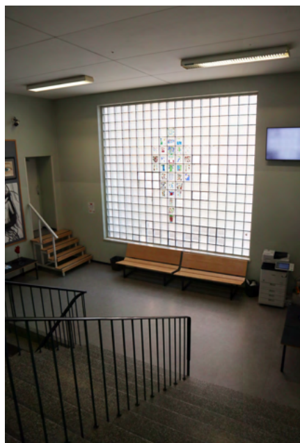
Laajennuksen pohjoispuolisessa porrashuoneessa on suuri lasitiili-ikkuna.
