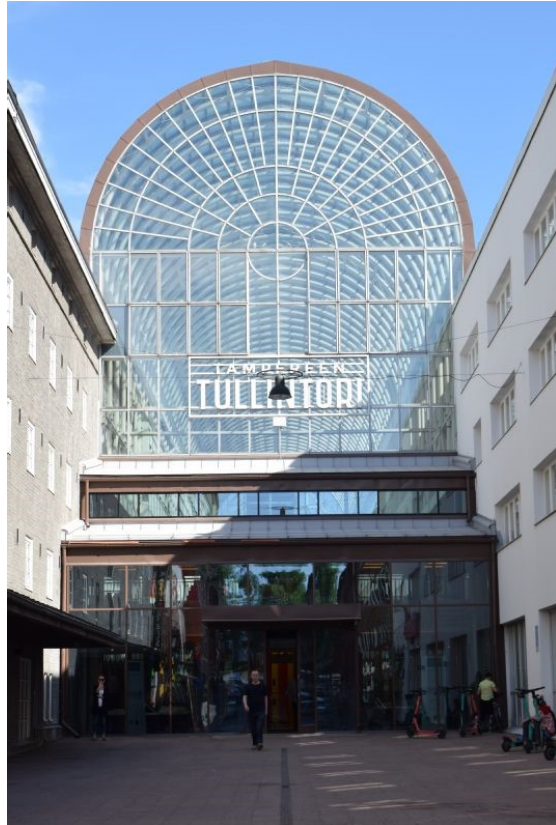
KYY 544 : 7649 Kauppakeskus Tullintorin Sumeliuksenkadun sisäänkäynti. Sanni Hujanen 24.05.2024
