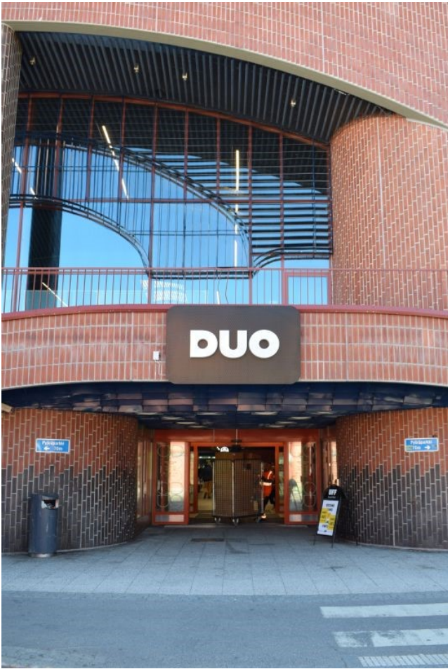
KYY 544 : 7626 Hervannan liikekeskuksen / Kauppakeskus Duon Insinöörinkadun sisäänkäynti. Sanni Hujanen 22.05.2024
