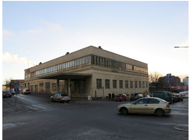
KYY 117 : 641 Autotuonnin talon julkisivua pohjoiseen ja itään. Henrik Mattjus 18.12.2013
