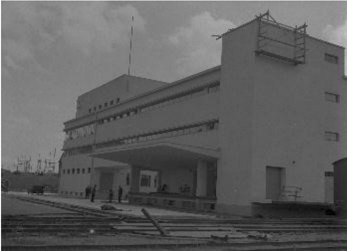
AL : 2109:12 SOK:n varastorakennus. K.O Lumme
