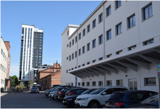
KYY 544 : 7641 Kauppakeskus Tullintorin kulma ja Pakkahuone. Sanni Hujanen 24.05.2024
