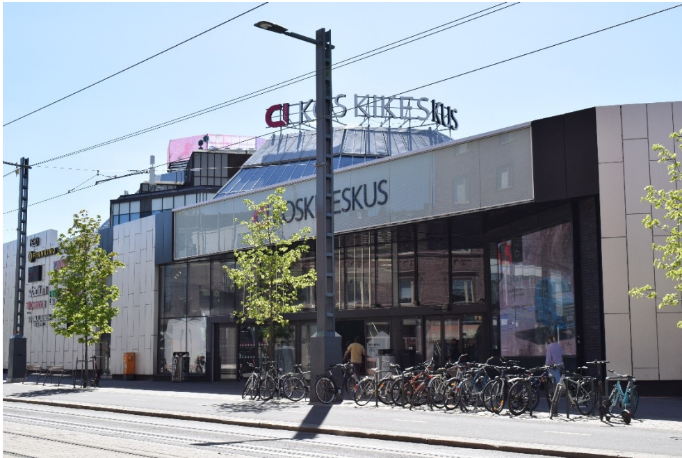
KYY 544: 7596 Koskikeskuksen Koskenportin sisäänkäynti. Sanni Hujanen 20.05.2024
