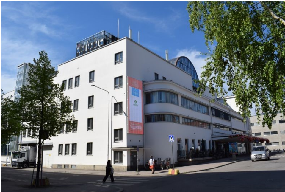
KYY 544 : 7646 Kauppakeskus Tullintori Hammarenin- ja Tullikadun kulmassa. Sanni Hujanen 24.05.2024
