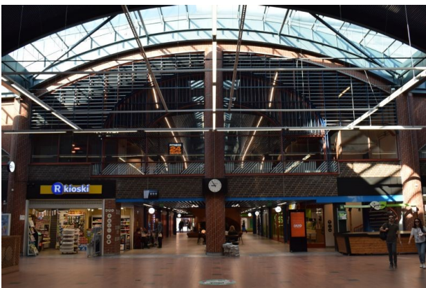
KYY 544 : 7633 Hervannan liikekeskus / Kauppakeskus Duo, vanha julkisivu uuden laajennusosan aulassa. Sanni Hujanen 22.05.2024
