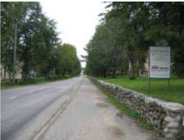
Sillanpäänkadun reunassa oleva kivimuuri.
