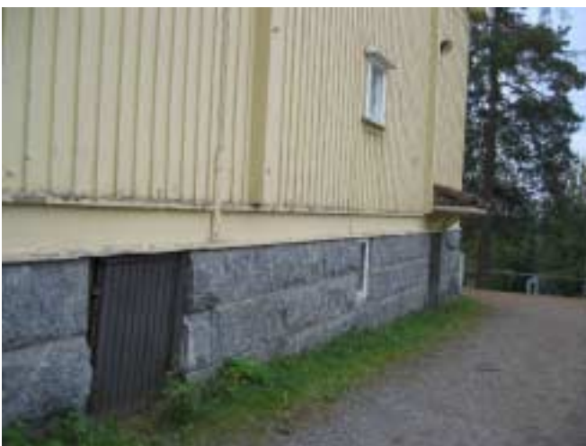
Yläkoulun perusmuuri on hakattua kiveä.
