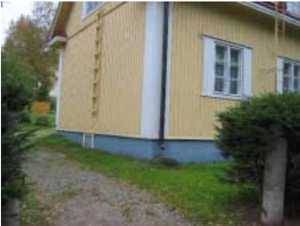
Kiviset portinpylvään Sillanpäänkadun varressa.
