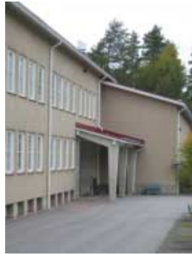
Uusitut yksilappeiset katokset.
