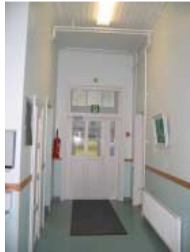
Yläkoulun aulan säilyneitä rakenteita.
