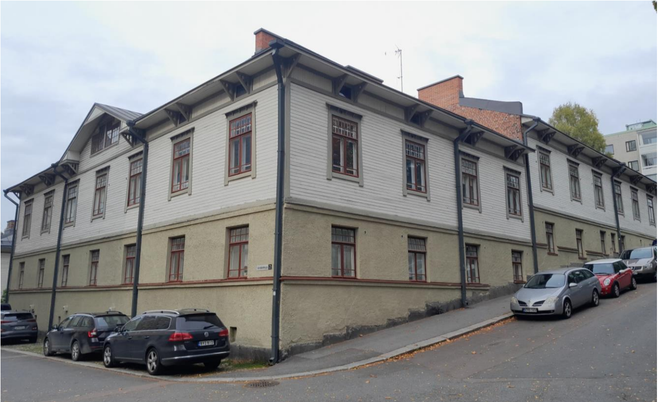
Kuva 99. Annikin puutalokorttelin julkisivu Salhojankadun ja Annikinkujan risteyksestä katsottuna.
