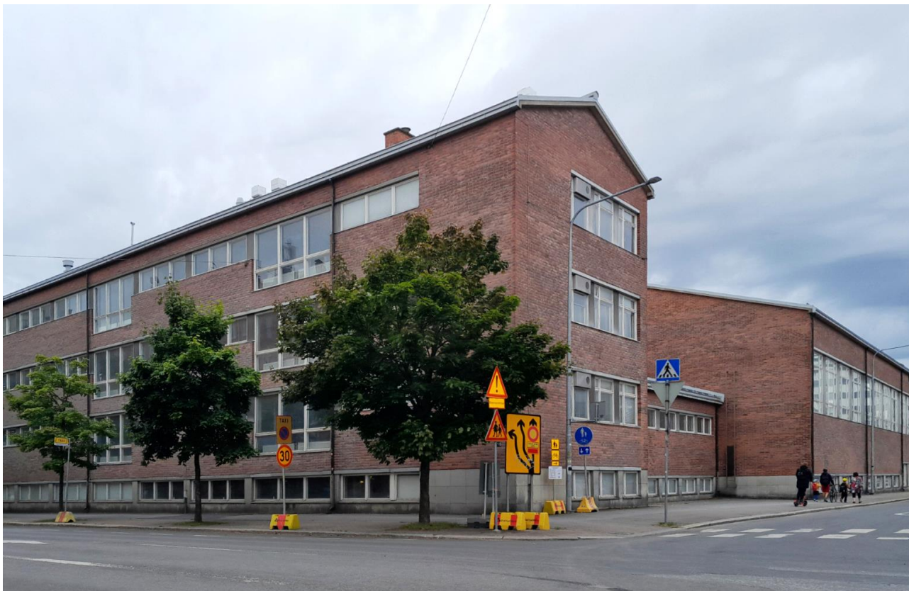
Kuva 104. Olavi Suvitien suunnitelma punatiilinen koulun laajennusosa Kalevan puistotien ja Väinöläkadun risteyksestä katsottuna.
