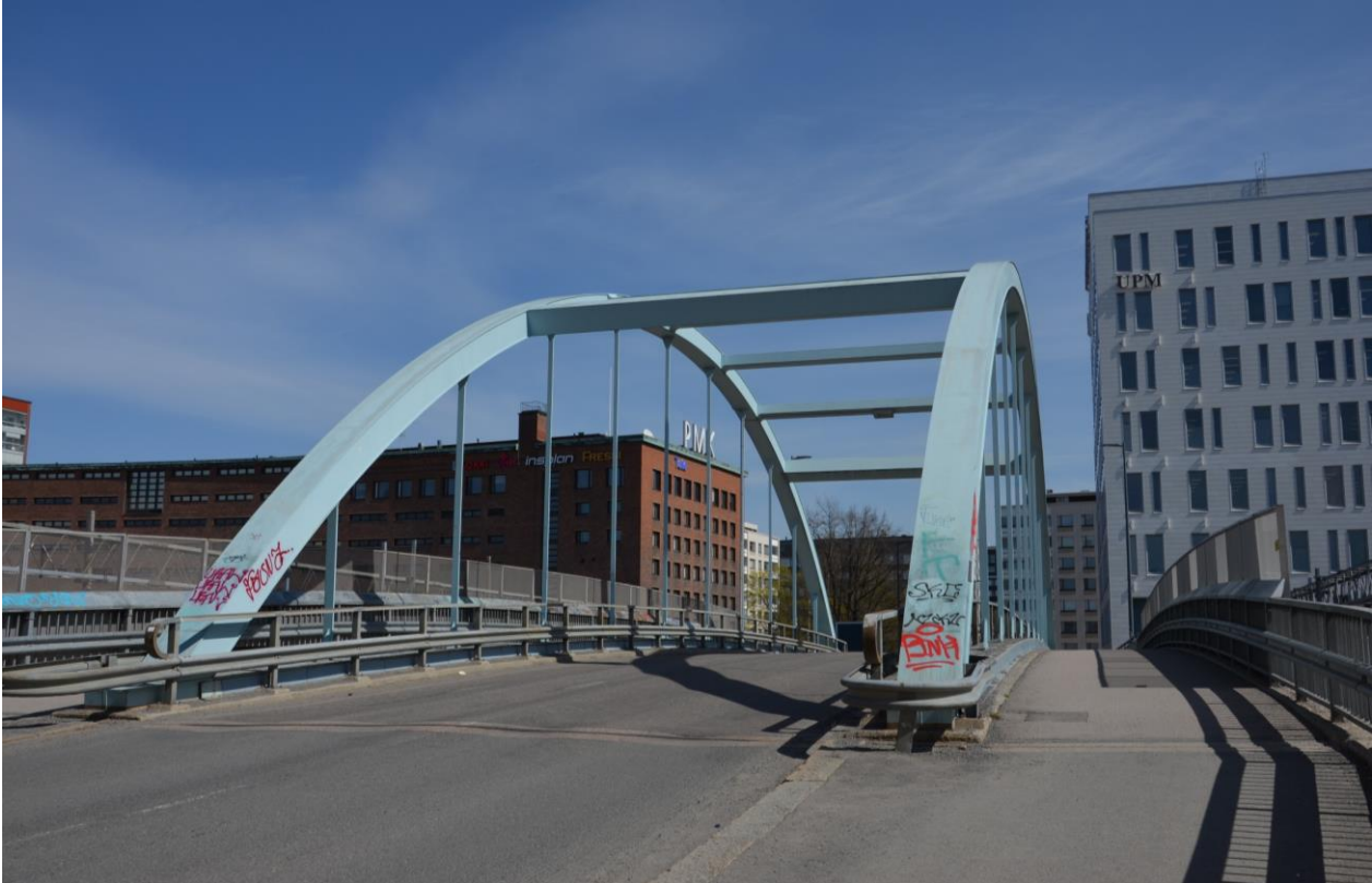
Kuva 114. Erkkilän silta. Lähde: Siiri-tietopalvelu.
