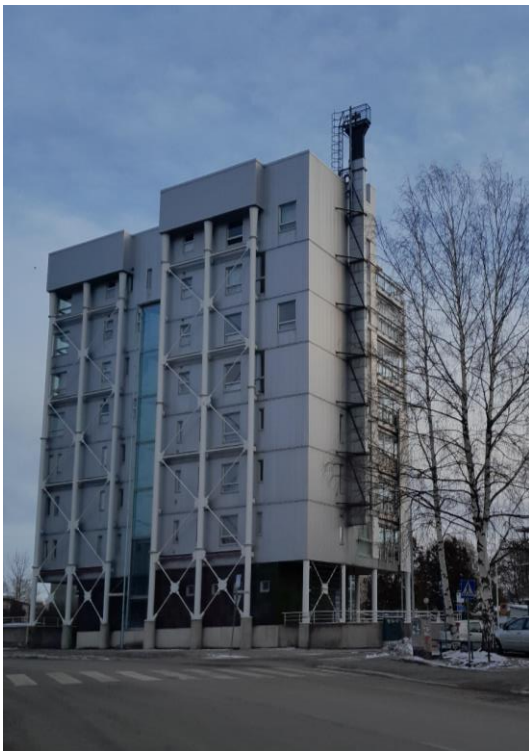
Kuva 112. Terästammela Pohjolankadun ja Salhojankadun risteyksestä katsottuna.
