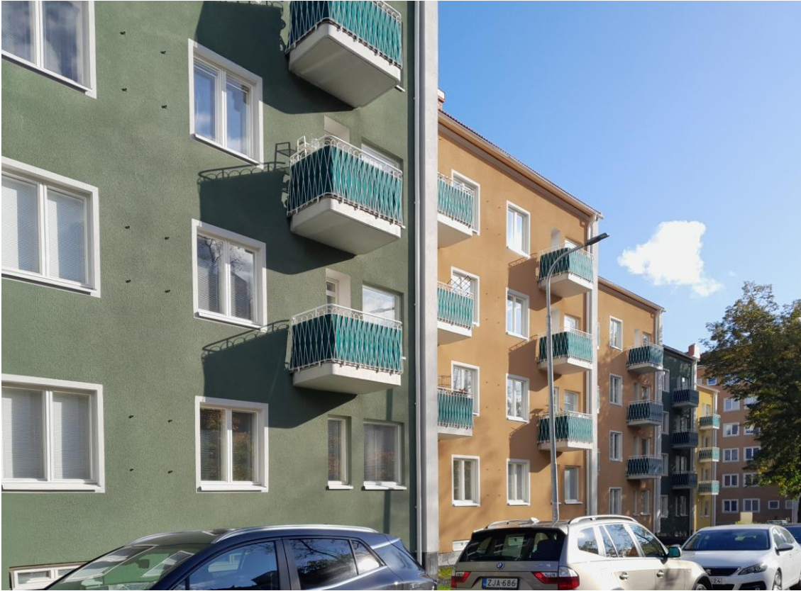
Kuva 30. Amurinlinnan korttelin katujulkisivua Mustanlahdenkadun puolella.
