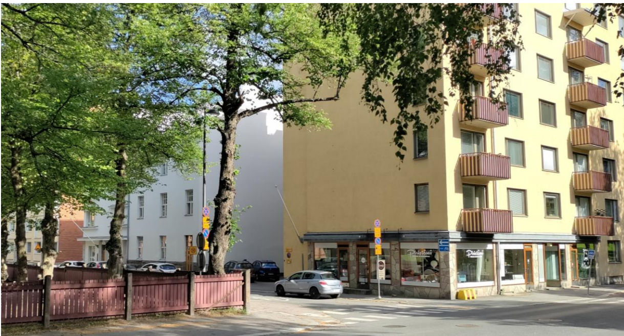
Kuva 39. Näkymä Hallituskadun länsipäästä, Marianpuiston kohdalta kohti itää.
