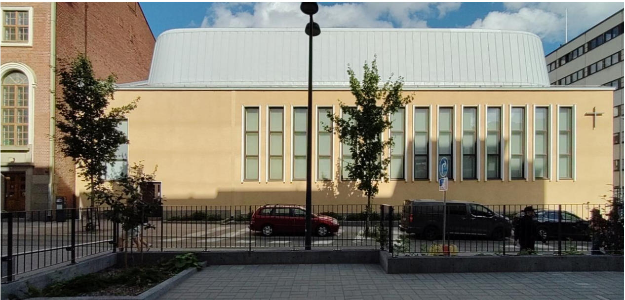
Kuva 70. Tampereen helluntaiseurakunnan rakennus Kyttälänkadulla.
