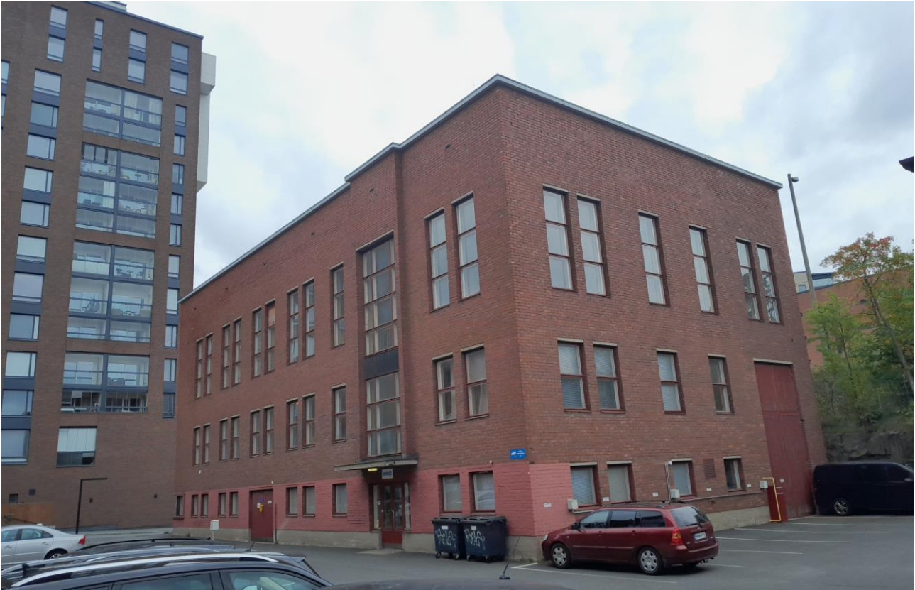
Kuva 56. Laboratoriorakennus (nro 136-4) kuvattuna lännestä, taustalla Ranta-Tampellan asuinkerrostaloja.
