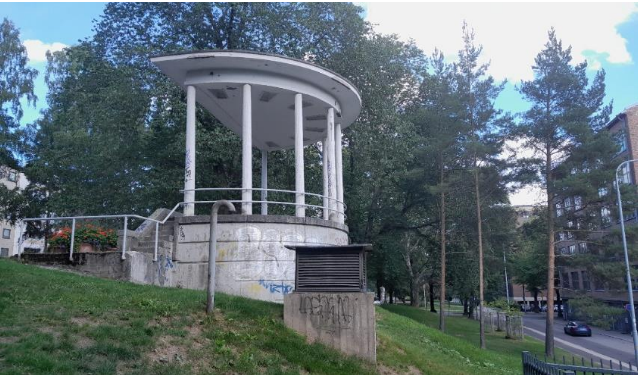
Kuva 101. Uusklassismin tyylipiirteiden mukainen esiintymislava Pinninkadun päätteenä rinteessä.
