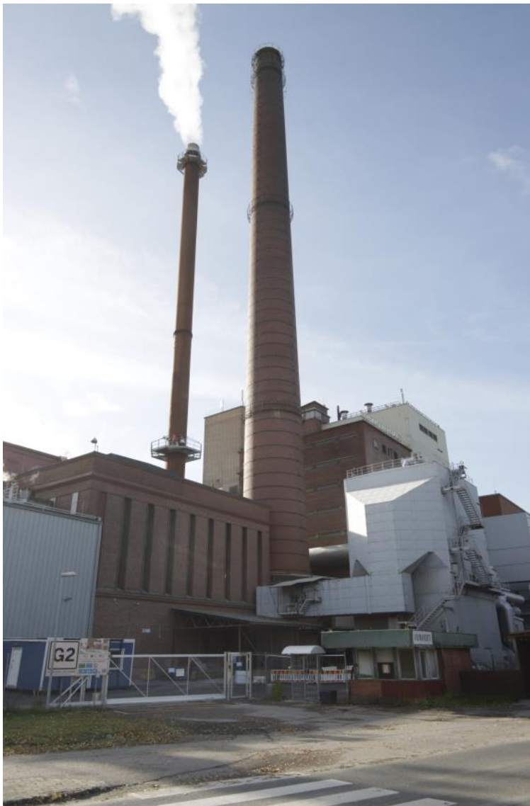
Kuva 1 Mäntän tehtaän höyryvoimalaitoksen piiput Tehtaankadulta kuvattuna.
