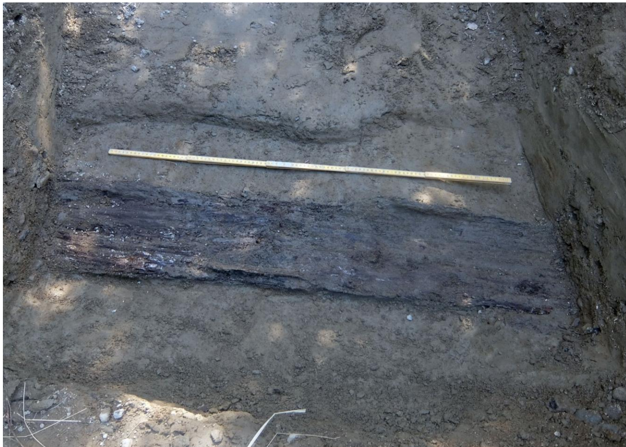
Kuva 22. Tiekerrosten alla oleva puinen salaoja koejassa 4, kuvattu luoteesta. AKDG 7400:11
