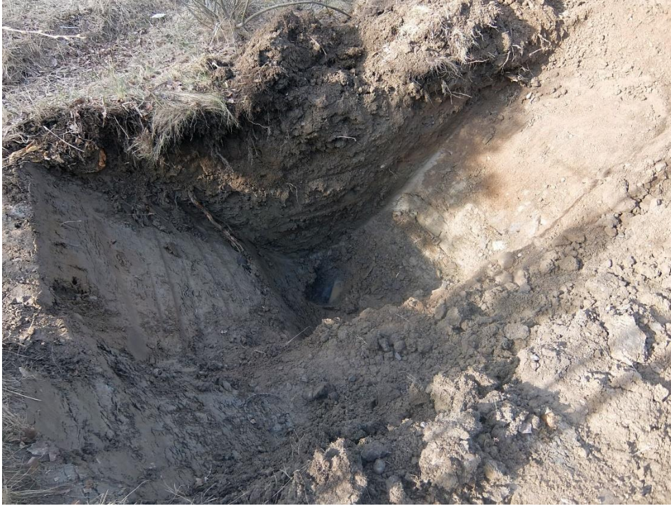
Kuva 24. Koeoja 5, jonka pohjassa näkyy moderni vesiputki. Kuvattu koillisesta. AKDG 7400:13
