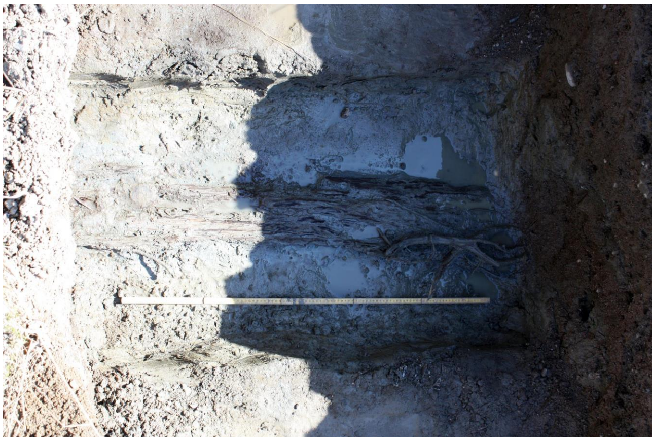
Kuva 17. Tiekerrosten alla oleva puinen salaoja koejassa 2, kuvattu luoteesta. AKDG 7400:6
