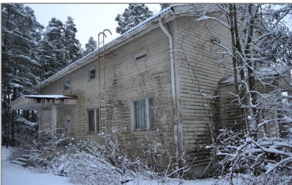
Rakennus 10: entinen konttorirakennus kiinteistötunnus 20-2-39-25 rakennustunnus 1008223540 rakennusaika 1945
