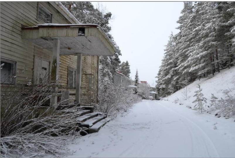
Kuva 64. Pääsisäänkäynnin yllä on pylväiden kannattelema, reunasta pystypaneloitu ja kulmistaan pyöristetty lippakatos. Kuvaussuunta länteen.
