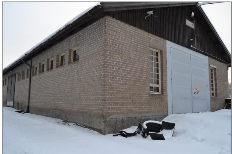
Kuva 28. Varastorakennuksen länsipääty eli vanhin osa.
