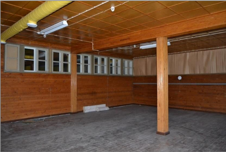
Kuva 19. Kuva yläkerrasta rakennuksen länsipäädystä, entisen karamellipakkaamon tiloista. Ensimmäisen ja toisen laajennusosan raja näkyy sisätiloissa seinän ikkunarivistössä.
