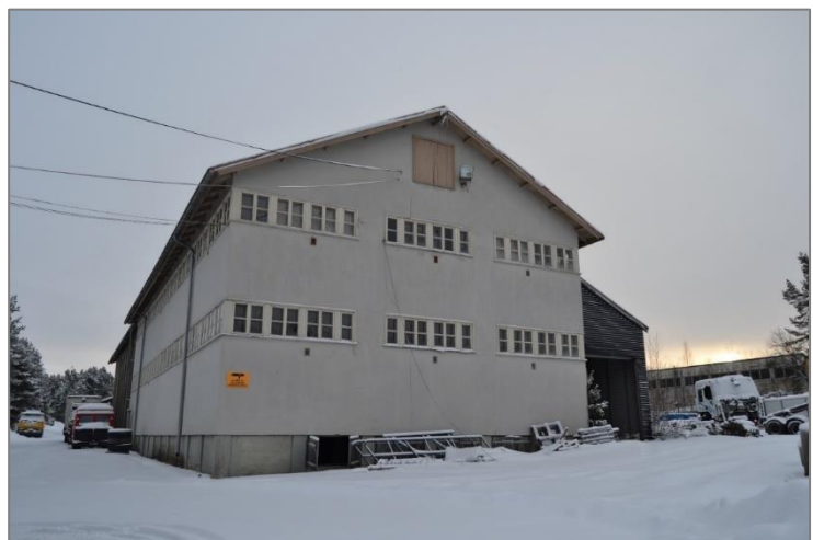
Kuva 13. (ylhäällä) Eteläsivun katoksen alla olevista ikkunoista alimmat on peitetty levyillä.
