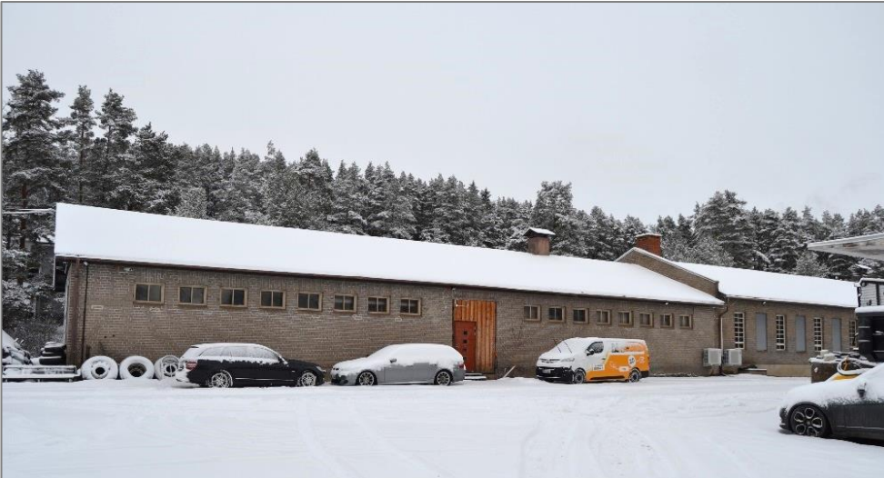
Kuva 30. Varastorakennuksen alkuperäinen osa kuvattuna etelästä. Rakennuksen keskellä oleva ovi on muutettu.
