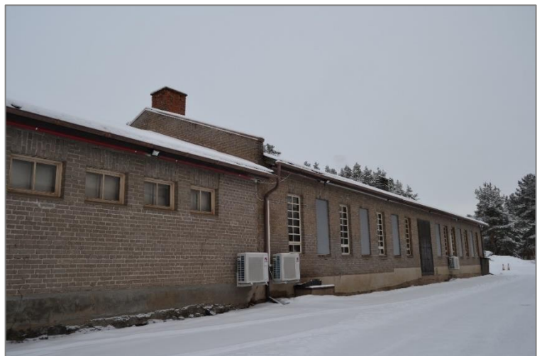
Kuva 27. Rakennuksen eteläisivua alkuperäisen rakennusosan (vasemmalla) ja laajennuksen liitoskohdasta.
