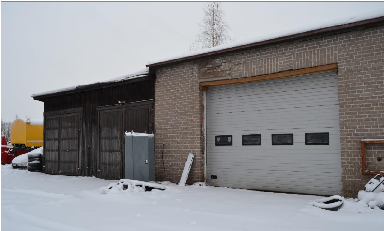
Kuva 24. Kattilahuoneen eteläisivun alkuperäisten ikkunoiden paikalla on nyt nosto-ovi. Ikkuna-aukkojen yläpuoliset tiilikuvioinnit näkyvät vielä julkisivussa. Vasemmalla oleva puinen halli on rakennettu Postin omistajakaudella, ilmakuvatarkastelun perusteella vuoden 1956 jälkeen.
