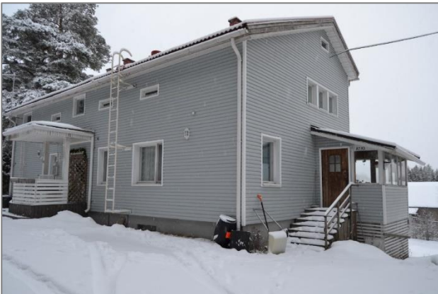
Kuva 60. Rakennus nro 9, ns. kakkostalon, länsipääty ja pohjoissivua. Päädyn kuisti on rakennettu joskus 1980-luvun alun jälkeen.
