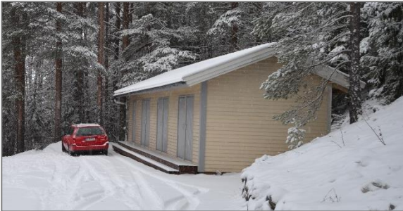
Rakennus 7: piharakennus kiinteistötunnus 20-2-39-25 rakennustunnus ei tunnusta rakennusaika 1940–1950-luku
