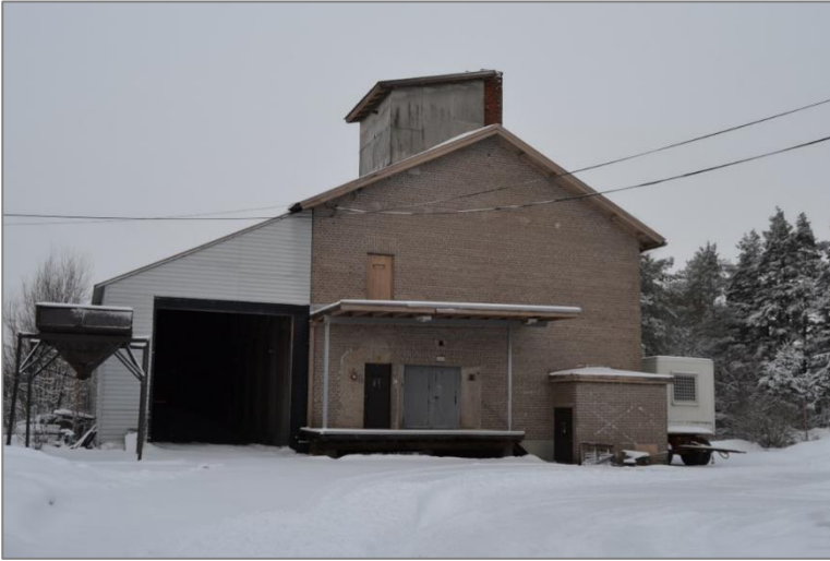
Kuva 10. (ylhällä) Tehdasrakennuksen itäpääty. Lippakatoksen yläpuolinen ovi on ollut palouloskäynti, jolta johti alun perin portaat alas.
