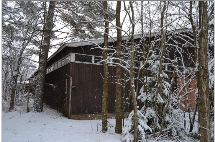
Kuva 7. Varastorakennus kuvattu koilliskulmalta.
