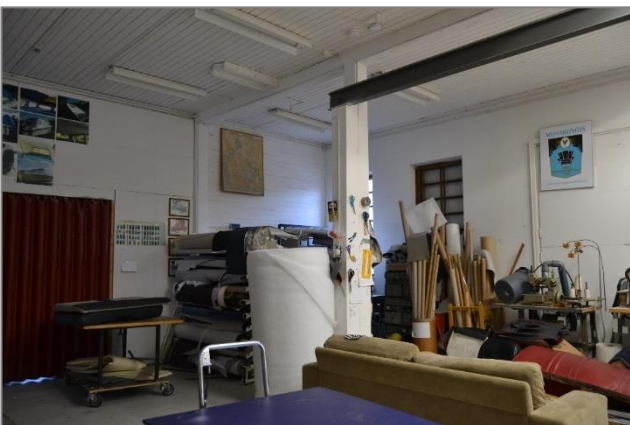
Kuva 34. Kuva varastorakennuksen laajennusosasta, nykyisestä Akaan verhoonon liiketilasta. Tilat ovat Postin aikaisessa asussaan. Seinät ovat suurimmaksi osaksi maalattuja kiviseiniä, katossa on valkeaksi maalattu lautapanelointi.
