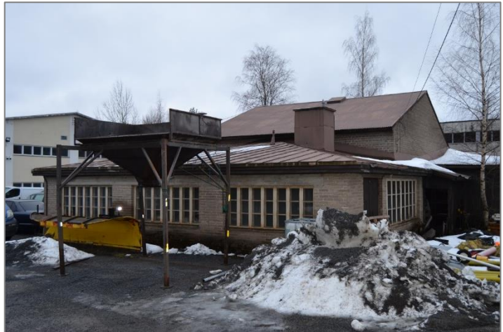
Kuva 22. Rakennus kuvattuna luoteiskulmalta. Edessä näkyvä, aumakattoinen osa on korjaamo.
