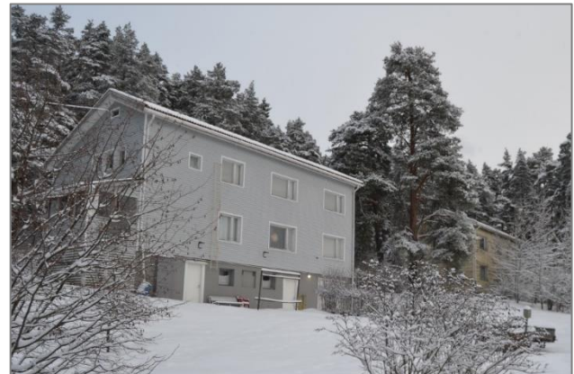
Kuva 59. Kakkostalo, nro 9, kuvattuna pihan puolelta eteläisivulta. Eteläjulkisivu on säilynyt rakentamisaikaisessa asussaan (vertailukuva Kauria 2019, s. 14).
