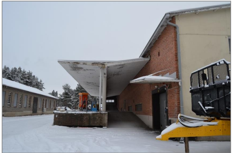
Kuva 35. Rakennuksen pohjoissivulla on ylöspäin taittuva betonikatos. Ajoluiskan vieressä seinässä on lasitiili-ikkunoita.
