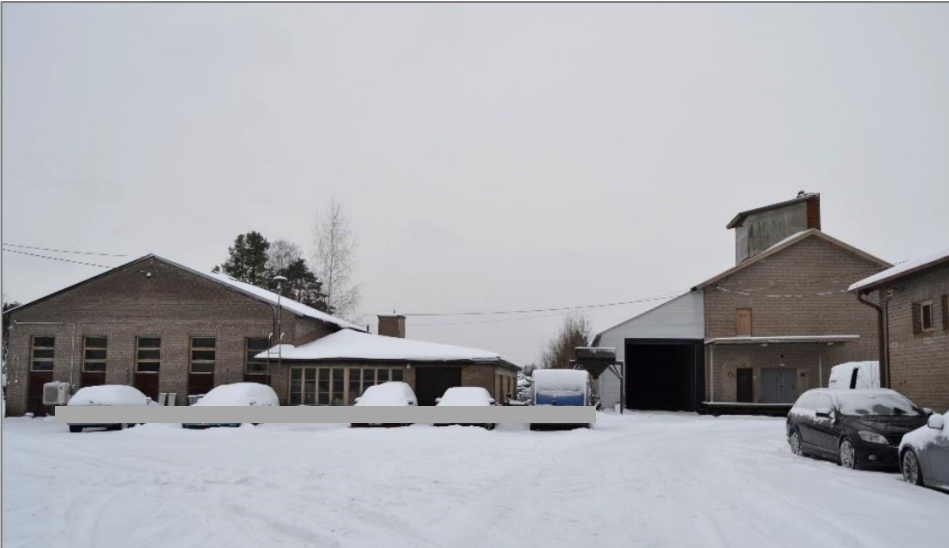
Kuva 4. Vasemmalla entinen kattilahuone ja korjaamo, oikealla entisen tehdasrakennuksen pääty. Oikeassa laidassa näkyy Chymoksen varaston kulma. Kuvaussuunta länteen.
