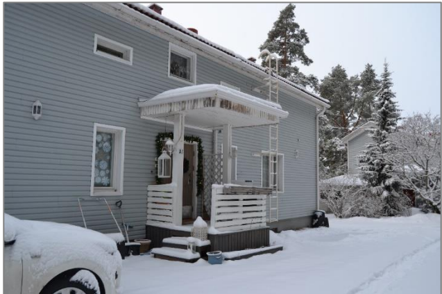
Kuva 55. Itäisemmän asuinrakennuksen (nro 9), ns. kakkostalon, pohjoissivu.
