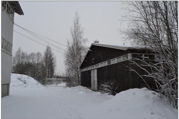
Kuva 8. Rakennuksen eteläpäätty. Kuvan vasemmassa reunassa näkyy entisen Chymoksen tehtaän länsipäättyä.
