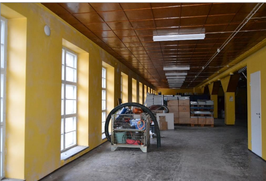
Kuva 17. Kuva tehtaan vanhimman osan yläkerrasta. Ulkoseinän ikkunarivistö on rakennuksen pohjoisovilla.
