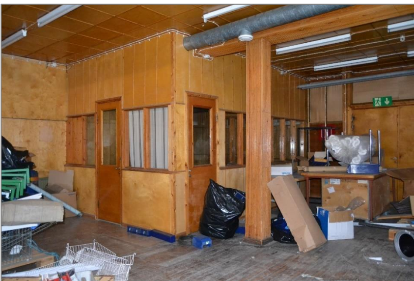
Kuva 14. Kuva keskikerroksen varasto- ja lähetysoaston työnjohdon kopista. Oikealla näkyvät pariovet johtavat lastauslaiturille rakennuksen eteläsivulla. Osasto on säilynyt sisustukseltaan lähes alkuperäisenä. Vain kopista vasemmalle sijainnut ”liukumäki” on poistettu. (Kauria 2019, s. 60.)
