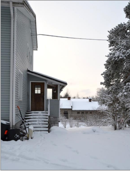
Kuva 79. Kuva Chymoksen asuinalueelta, ns. kakkostalon päädystä etelän suuntaan. Asuintalojen ja tehdasalueen näkemäyhteys on tärkeä alueen luonteen hahmottamiseksi.
