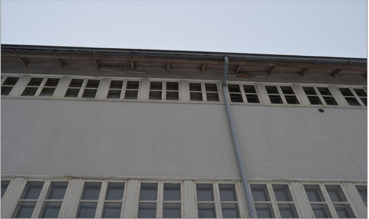
Kuva 80. Tehdasrakennuksen laajennusosan pohjoissivua.
