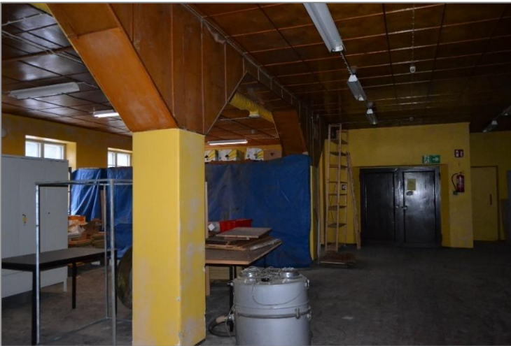
Kuva 18. Kuva tehtaan vanhimman osan yläkerrasta. Tilassa sijaitsi alun perin karamellitehtaan konesali.
