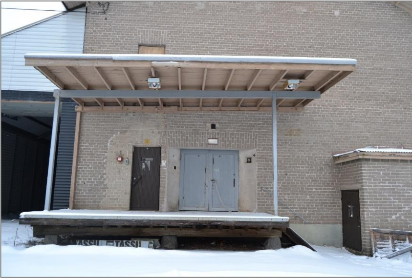
Kuva 16. Itäpäädyn lippa on rakennettu Postin omistajakaudella. Pariovista on käynti tavarahissiin. Tiilisen rakennusosan ikkuna- ja oviaukkojen yläpuolelle on tehty koristemuurausta tiilien suuntaa vaihtamalla.
