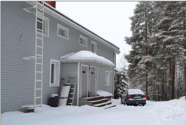
Kuva 54. Asuinrakennuksen (nro 8) pohjoissivua.
