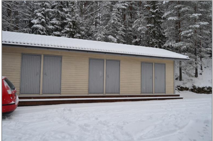
Kuva 53. Piharakennus kuvattuna eteläsivulta.
