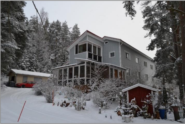
Kuva 57. Läntisemmän asuinrakennuksen (rakennus nro 8) länsipäädyn laajennus vuodelta 2006.
