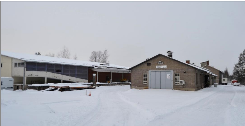
Kuva 3. Teollisuusaluetta kuvattuna koillisesta. Vasemmalla Postin entinen keskusvarasto, oikealla Chymoksen varastorakennus.
