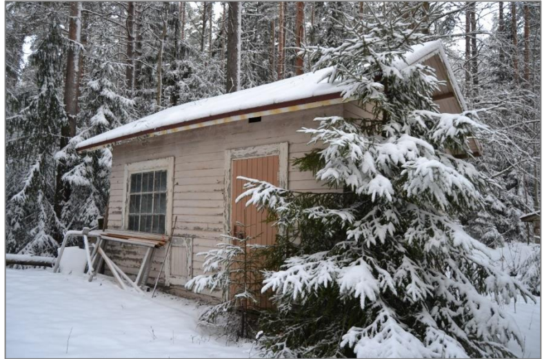
Kuva 69. Rakennus kuvattuna kaakkoiskulmalta.
