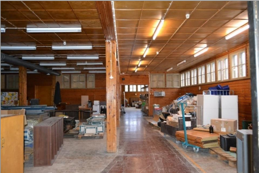
Kuva 15. Kuva on otettu tiilisen rakennusosan ja ensimmäisen laajennusosan rajalta länteen päin keskikerroksesta (1. maanpäällinen kerros). Lähes kaikissa keski- ja yläkerroksen katoissa on alkuperäinen puupanelointi ohuine listoituksineen.
