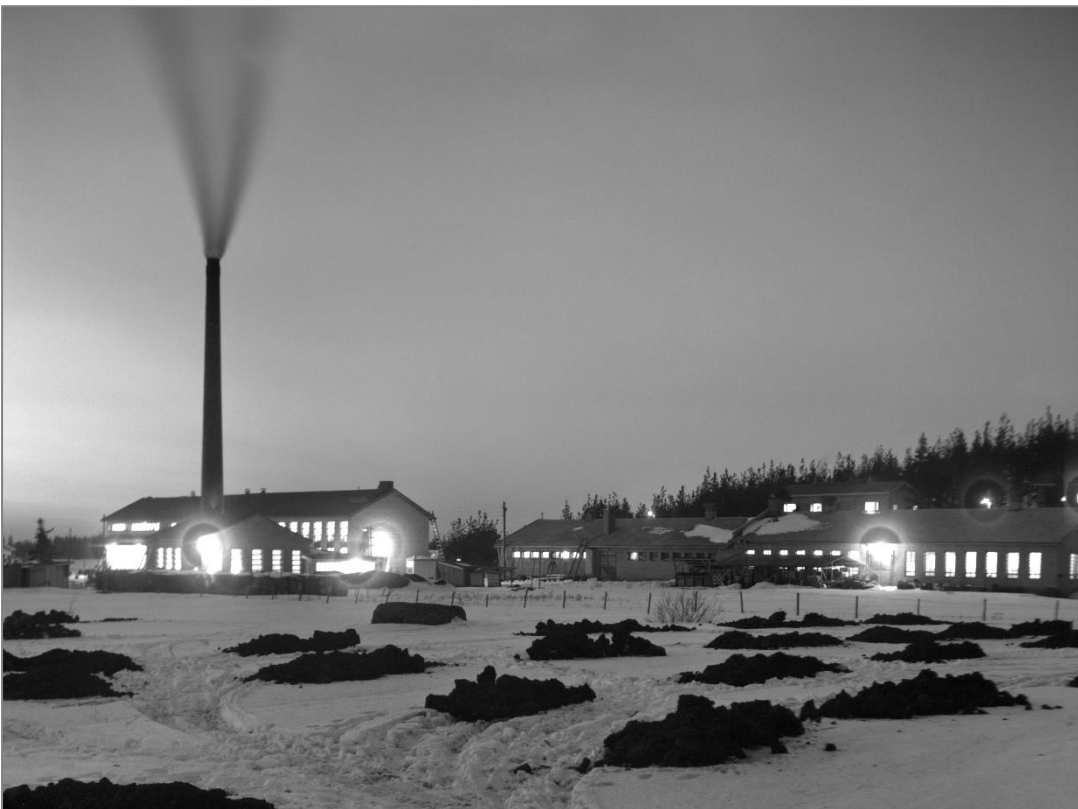
Kuva 2. Chymoksen Toijalan tehdasalue kuvattuna etelän suunnasta 10.3.1950. Tehdasalueen ympäristö on vielä tuolloin ollut peltoa. Vasemmalla näkyvät nykyiseen mittaansa laajennettu tehdas ja sen edessä kattilahuone piippuineen. Oikealla on nykyiseen pituuteensa laajennettu varistorakennus, jonka takaa loistaa asuintalojen valoja. Kuvaaja: Veikko Kanninen. Tampereen museot, Vapriikin kuva-arkisto.
