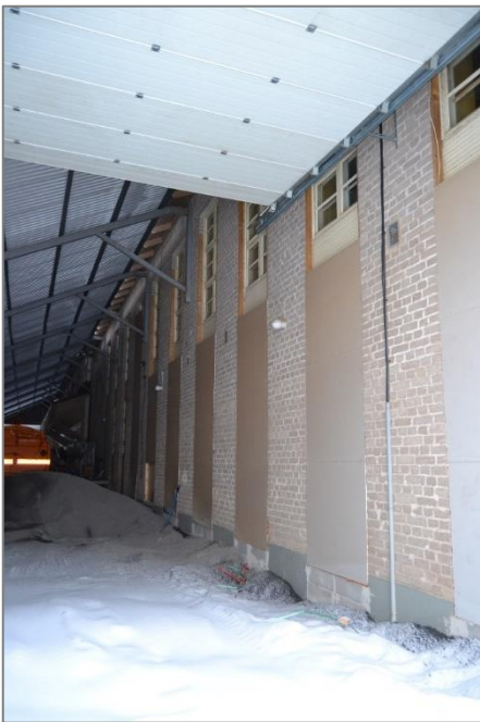
Kuva 13. (ylhäällä) Eteläsivun katoksen alla olevista ikkunoista alimmat on peitetty levyillä.
