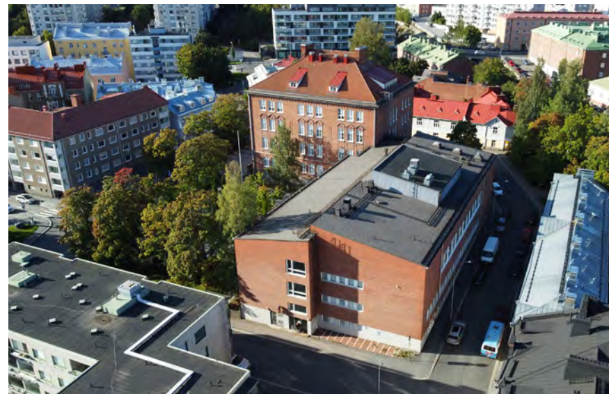
Punatiilisen koulurakennuksen alkuperäinen osa ja etualalla oleva 1960-luvun laajennus kuvattuna syyskuussa 2023. Laajennuksen itälapeella oleva ilmanvaihtokonehuone on rakennettu 1990-luvulla.
