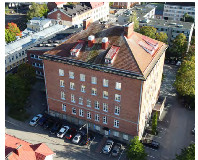
Alkuperäisen osan pohjoisjulkisivu kuvattuna syyskuussa 2023. Voimistelusalin korkeat ikkunat korvattiin 1960-luvulla kahdella matalammalla ikkunarivillä. Kellarissa kahden kapeamman ikkunan kohdalla oli 1960-luvulle asti ovet.
