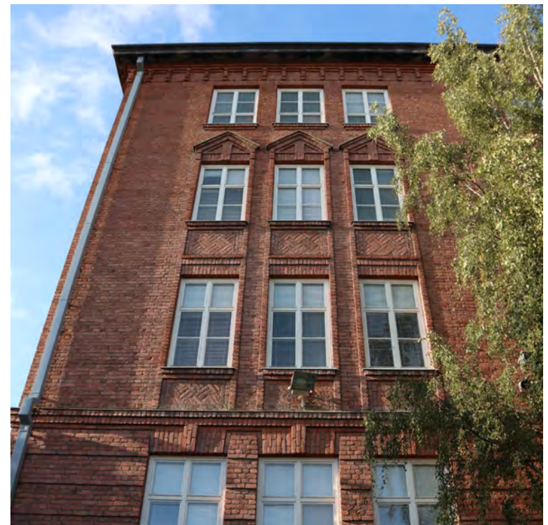
Alkuperäisen osan eteläjulkisivun koristemuurauksia kuvattuna syyskuussa 2023.
