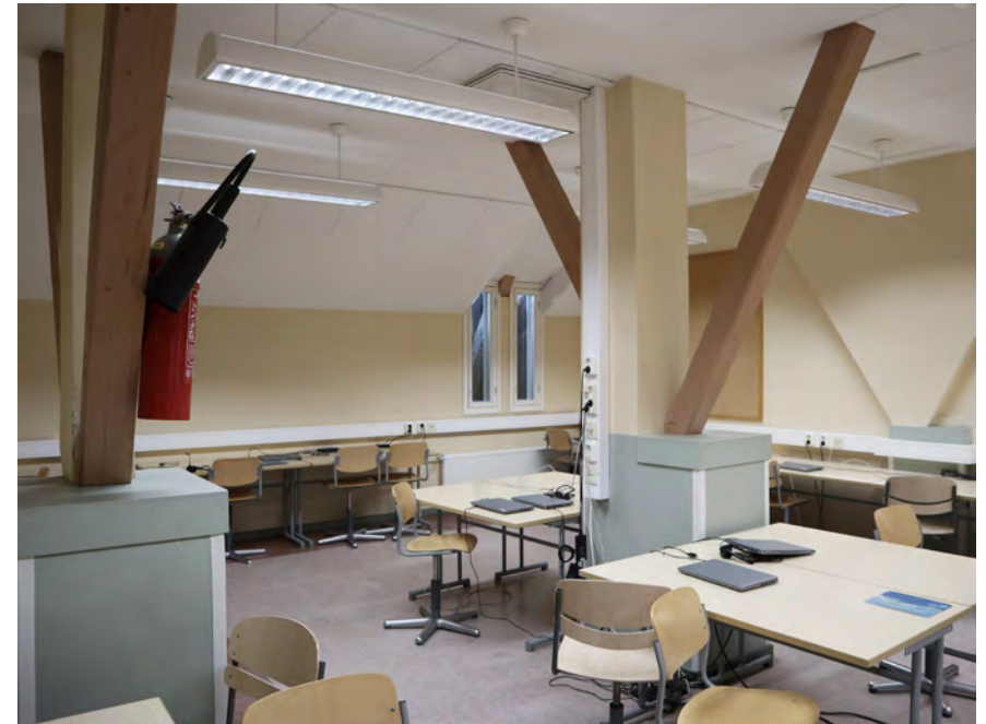
1990-luvulla alkuperäisen osan ullakolle rakennettu tietotekniikan opetustila kuvattuna elokuussa 2023. Luonnonvaloa opetustilaan saadaan kattolyhtyjen kohdalle tehtyjen sisäikkunoiden kautta.
