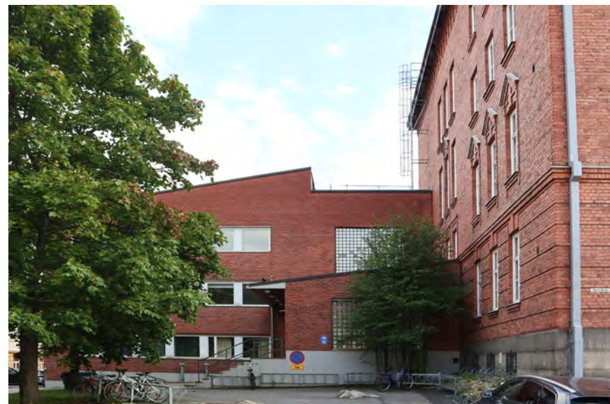
1960-luvun laajennuksen ja alkuperäisen osan koillisnurkan liitoskohta kuvattuna syyskuussa 2023. Vanha pääsisäänkäynti jäi uuden nivelkohdan sisään.
