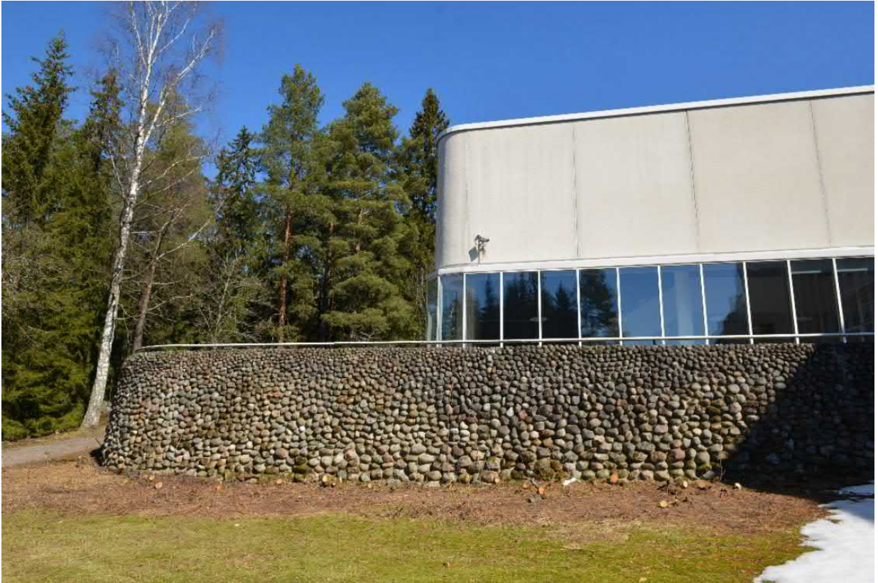
Terassin jalustan ja umpikaiteen pulterimuuri
