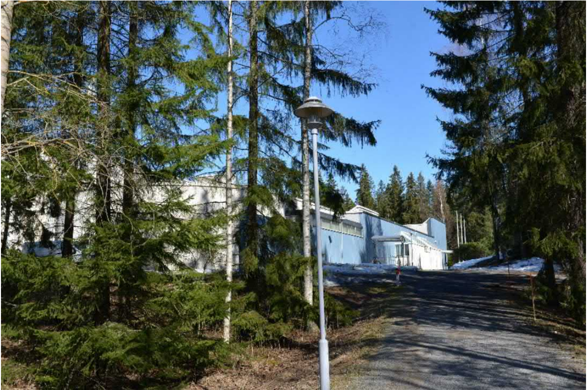
Sisääntulonäkymä kevyenliikenteenväylän suunnasta
