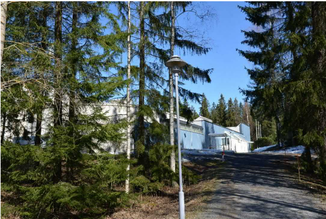
Sisääntulonäkymä kevyenliikenteenväylän suunnasta
