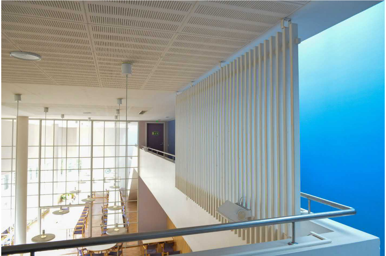
Puurimaelementti ja käytävän taustaseinä
