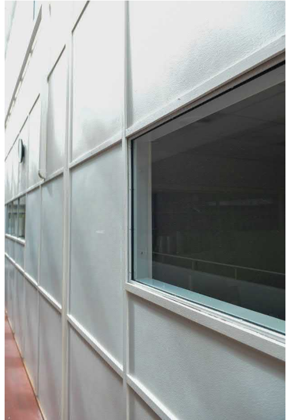
Juoksurata-alueen ja laboratoriotilojen väliseinä
