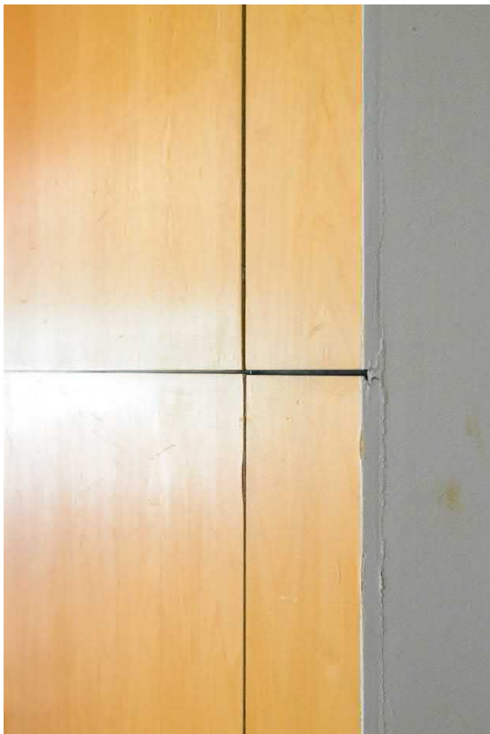
Seinäpinnan verhous, yksityiskohta
