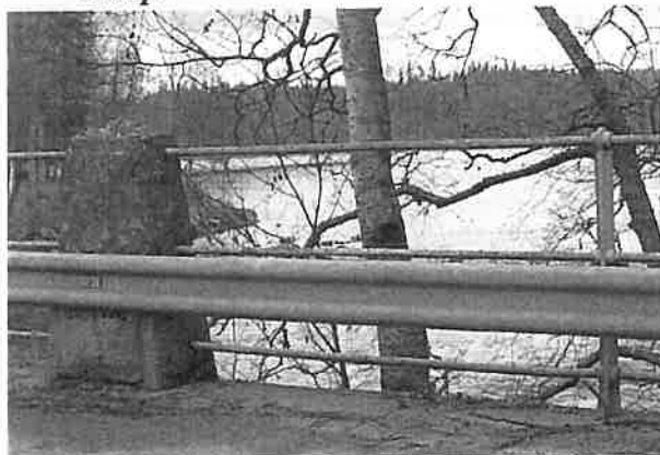
sillan vanhaa ja uutta kaidetta
