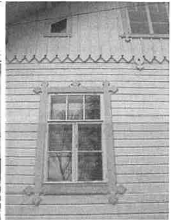
ikkunat ja vuoraus
