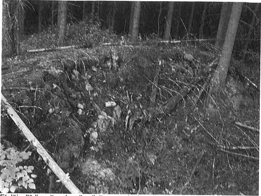
Eteläisellä linnoitusalueella sijaitseva osittain säilyneen korsu 3:n rakenteita. Korsua on tuettu yläosastaan kivillä. Kuvattu lännestä. Kuvaaja K. Luoto.
