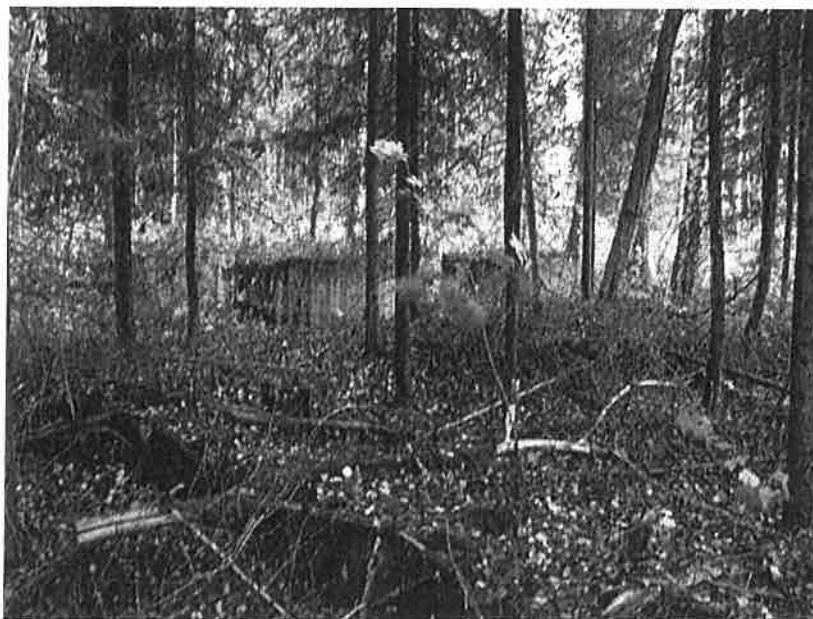
Betonisia rakenteita tehtaan alueella. Kuvaaja K. Luoto.
