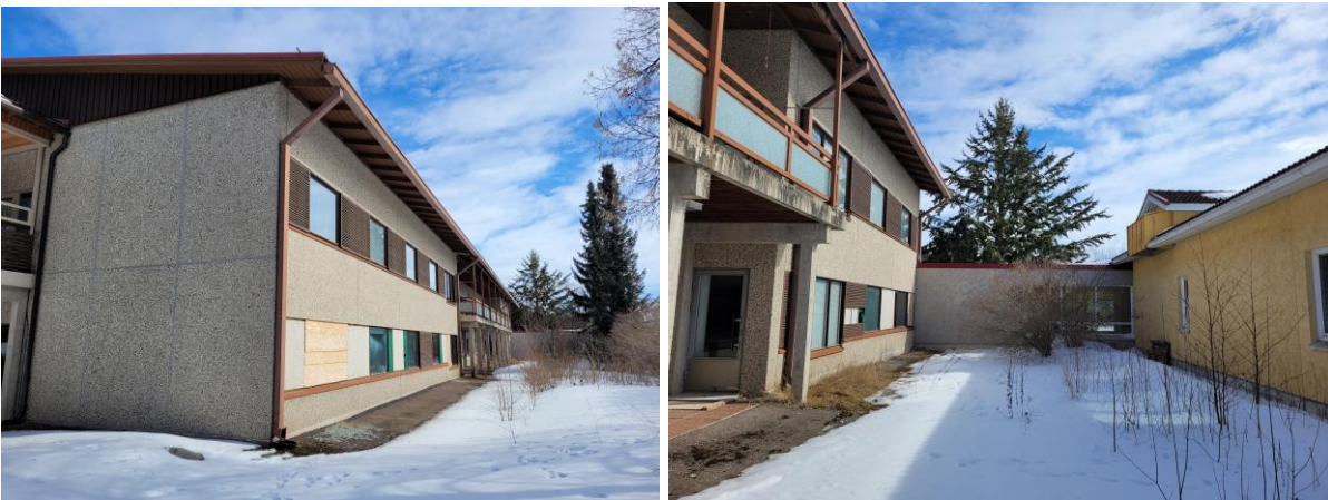
Kuva 43 Eteläjulkisivun detalleja sekä liittyminen 1990-luvun rakennusosaan.
