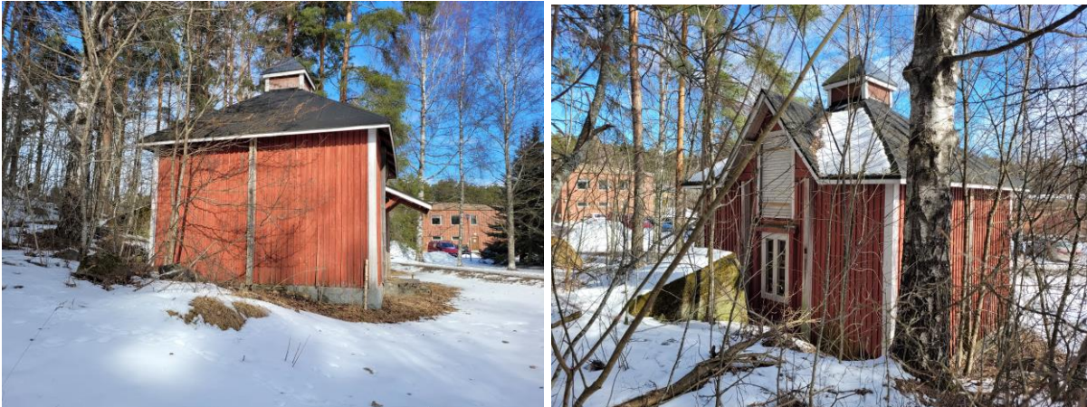
Kuva 56 Rakennuksen etelä- ja länsijulkisivut.
