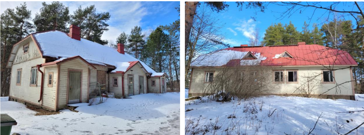
Kuva 53 Pohjoisjulkisivu ja eteläpääty (vasemmalla) sekä eteläjulkisivu (oikealla).
