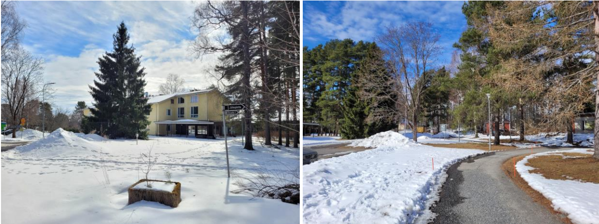
Kuva 5 Rekola-kodon pohjois- ja länsijulkisivuja (vasemmalla). Selvitysalueen pohjoispuoli on pääosin puustoa ja avointa pihapiiriä (oikealla).
