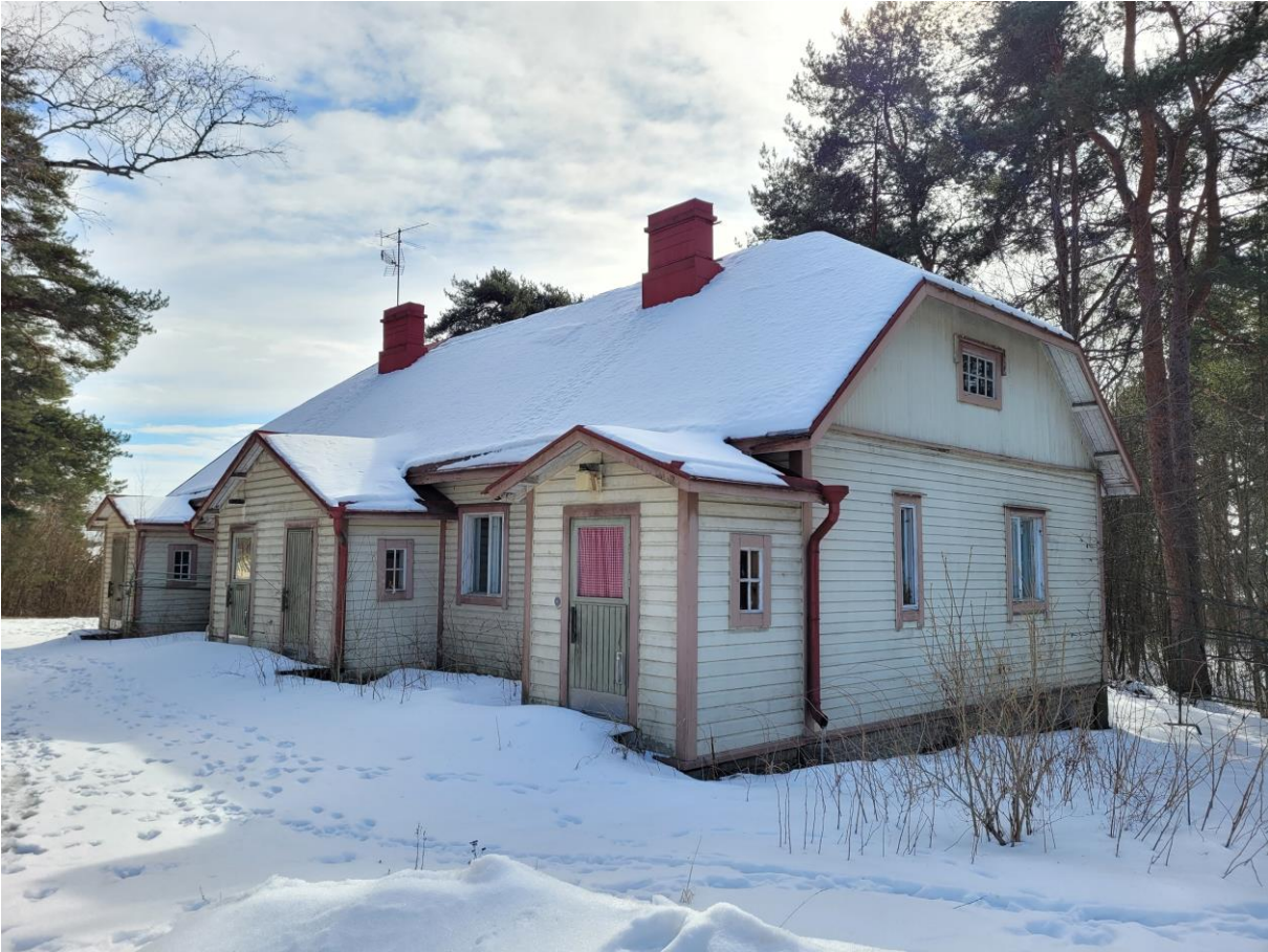
Kuva 52 Työväen asuinrakennuksen pohjoisjulkisivu ja länsipääty.
