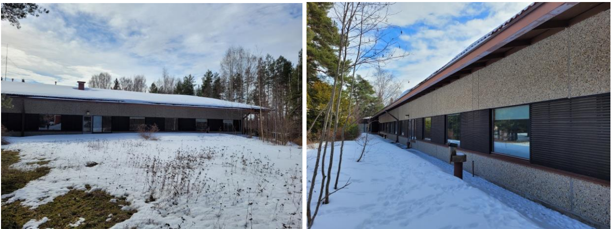
Kuva 45 Pohjoisjulkisivun leveää, mutta matalaa julkisivupintaa.
