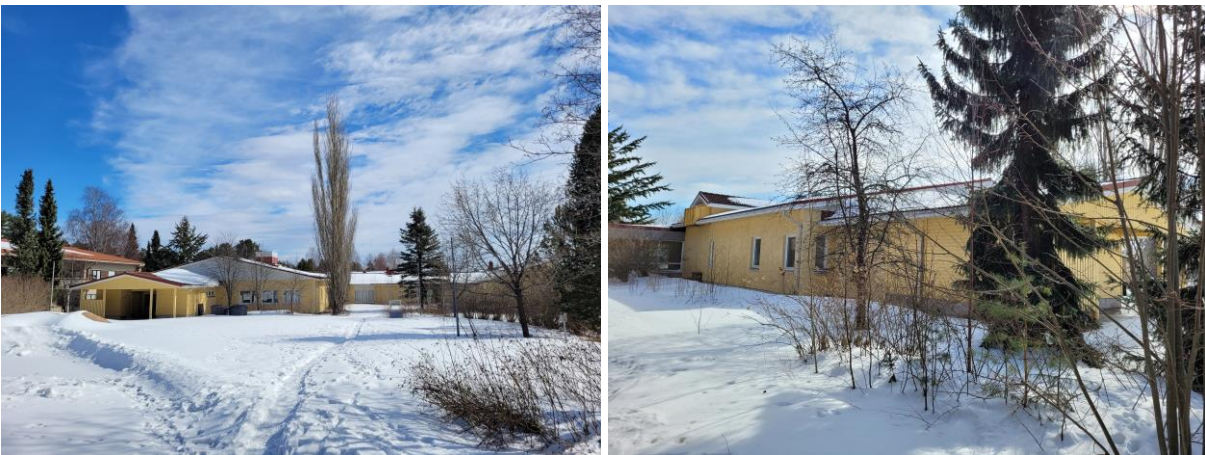
Kuva 50 Länsi- ja pohjoisjulkisivuja.
