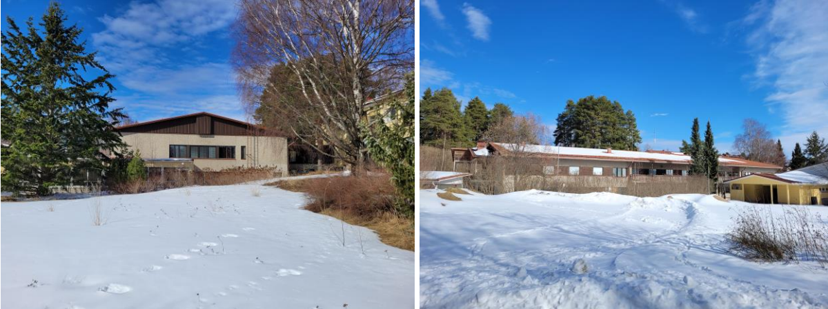
Kuva 42 Vuonna 1977 valmistuneen laajennuksen itäjulkisivu sekä eteläjulkisivu.
