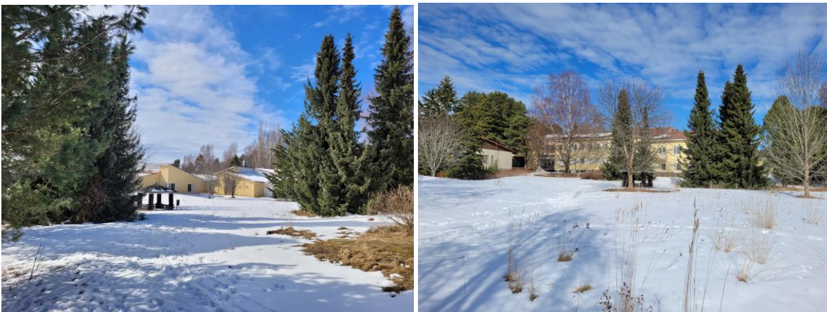
Kuva 6 Rekola-kodon uusin osa on sen eteläpuolella oleva 1990-luvulla rakennettu Hopealampi (vasemmalla). Rekola-kodon kokonaisuus muodostaa kaakkoispuolelleen suojaisen piha-alueen (oikealla).
