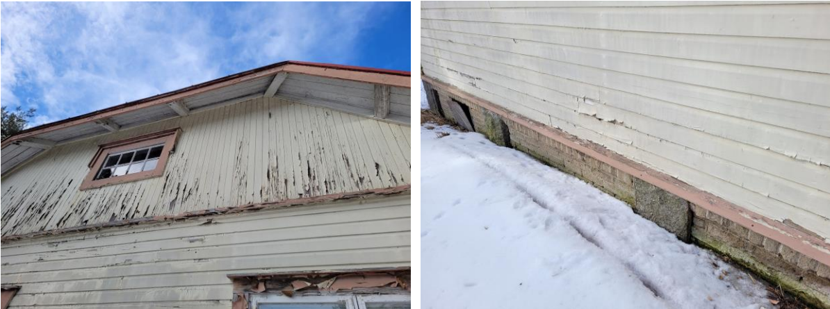
Kuva 54 Rakennuksen detaljeja: räystääslinja (vasemmalla) ja sokkeli (oikealla).
