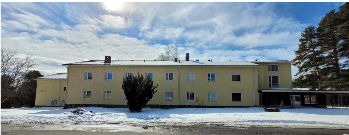
Kuva 38 Rekola-kodon vuonna 1953 valmistuneen rakennusosan pohjoisjulkisivu.
