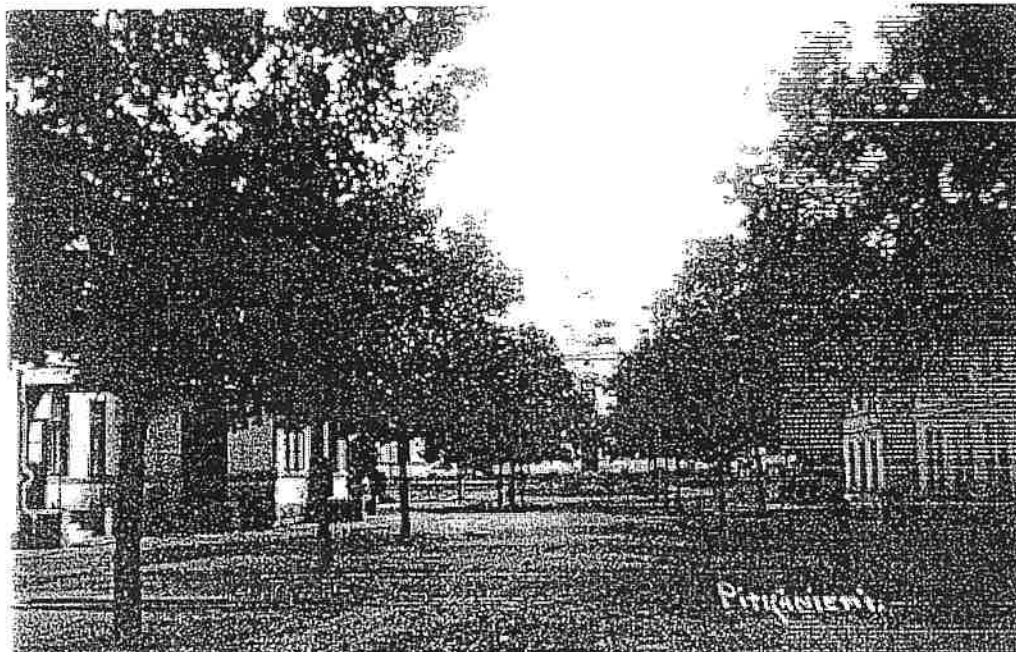
Näkymä kohti sairaalan päärakennusta vuodelta 1936. Historian kuva-arkisto.
