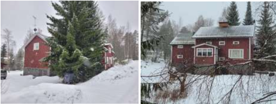
Kuva 18 Rakennuksen itäpäädyn julkisivu Taivalkunnantieltä katsottuna (vasemmalla) ja takajulkisivu Rinnekadulta (oikealla).
