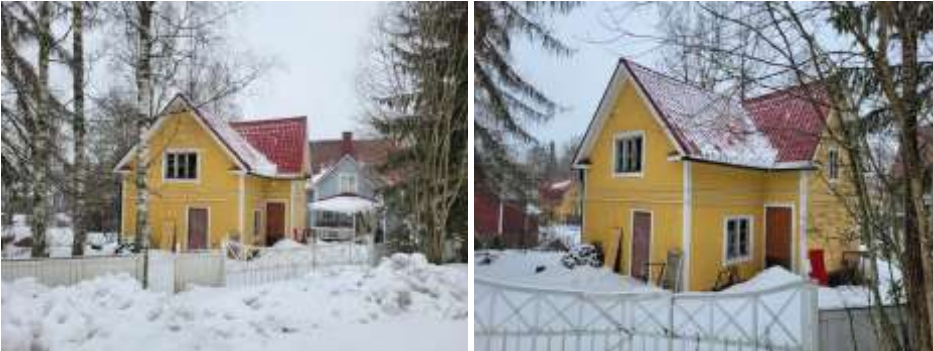
Kuva 12 Keltaisen asuinrakennuksen julkisivuja Taivalkunnantien ja Moisionkadun risteyksestä tarkasteltuna.
