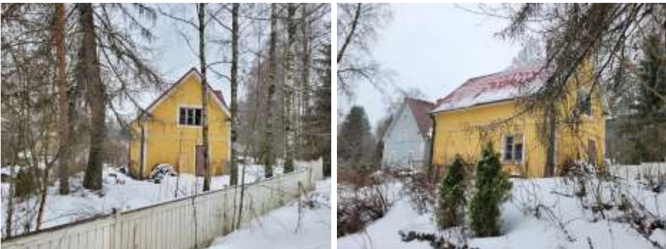
Kuva 13 Julkisivut Taivalkunnantieltä ja itäpuolella olevan naapuritalon pihapiiristä katsottuna.
