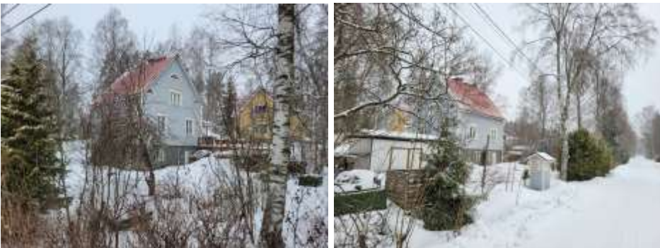
Kuva 14 Sinisen asuinrakennuksen julkisivut Rinnekadulta idästä ja lännestä nähtynä.
