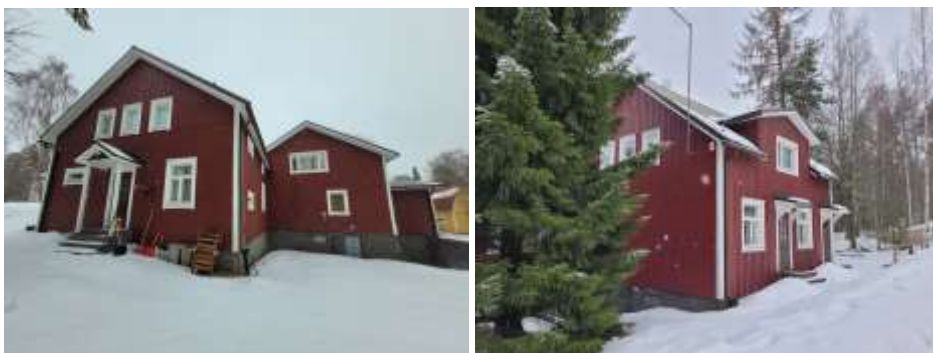
Kuva 17 Rakennuksen päätyjulkisivuja itään ja länteen.
