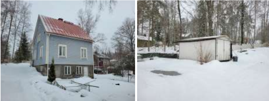
Kuva 15 Sinisen asuinrakennuksen julkisivu Rinnekadulle (vasemmalla) ja pihapiirin autotalli (oikealla).
