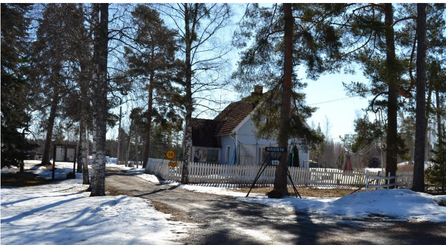
Kuva 47. Kuusiston päärakennus on kiinteistö- ja huonerekisteritietojen perusteella valmistunut 1930. Rakennus sijaitsee Lehtiniementien ja Kuusiston alueelle johtavan pihatien risteyksessä peltomaisemassa, pihapuuston ympäröimänä. Rakennuksessa on pystyvuoraus ja tiilikate.
