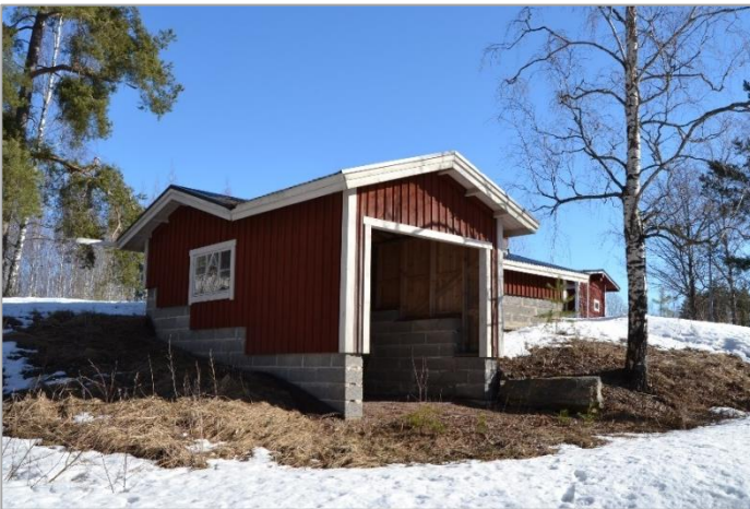
Kuva 34. Kellarikatos kuvattuna länsipuolelta.
