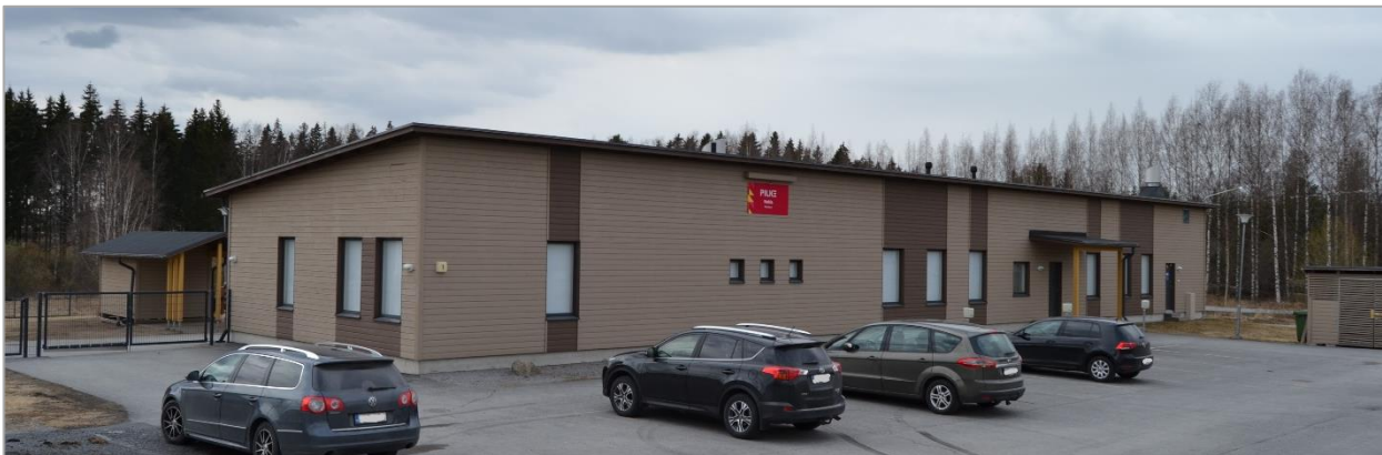
Kuva 25. Päiväkotirakennus kuvattuna Urhatuntieltä. Rakennuksessa toimii Pilke-päiväkoti.
