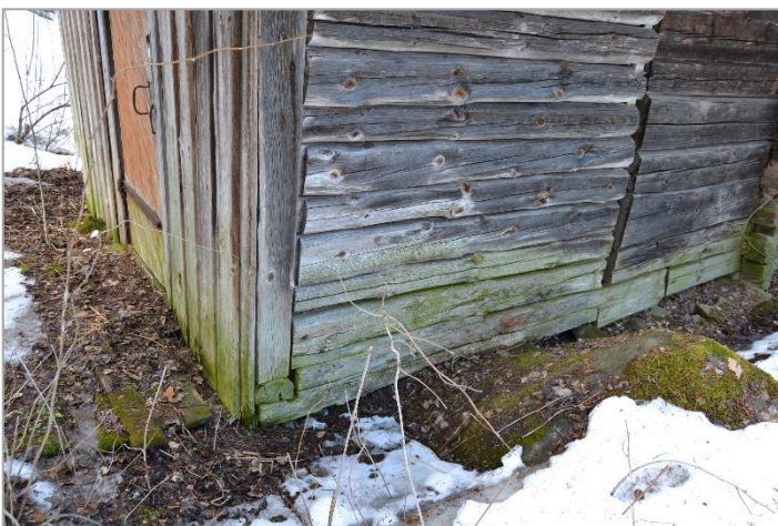
Kuva 58. Rakennusta on jatkettu eteläpäädyssä.
