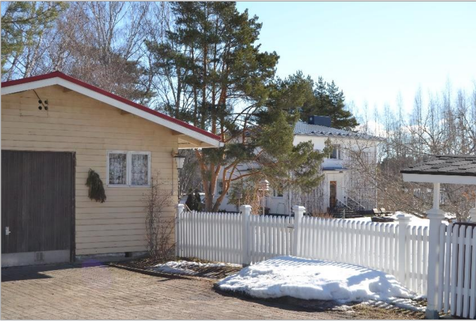
Kuva 42. Pääty tielle päin sijoittuva autotallirakennus on erotettu pääpihasta aidalla.
