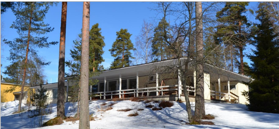
Kuva 66. Entinen kesäkotirakennus kuvattuna kaakkoiskulmalta. Rakennus on sijoitettu ympäristöönsä hyvin.
