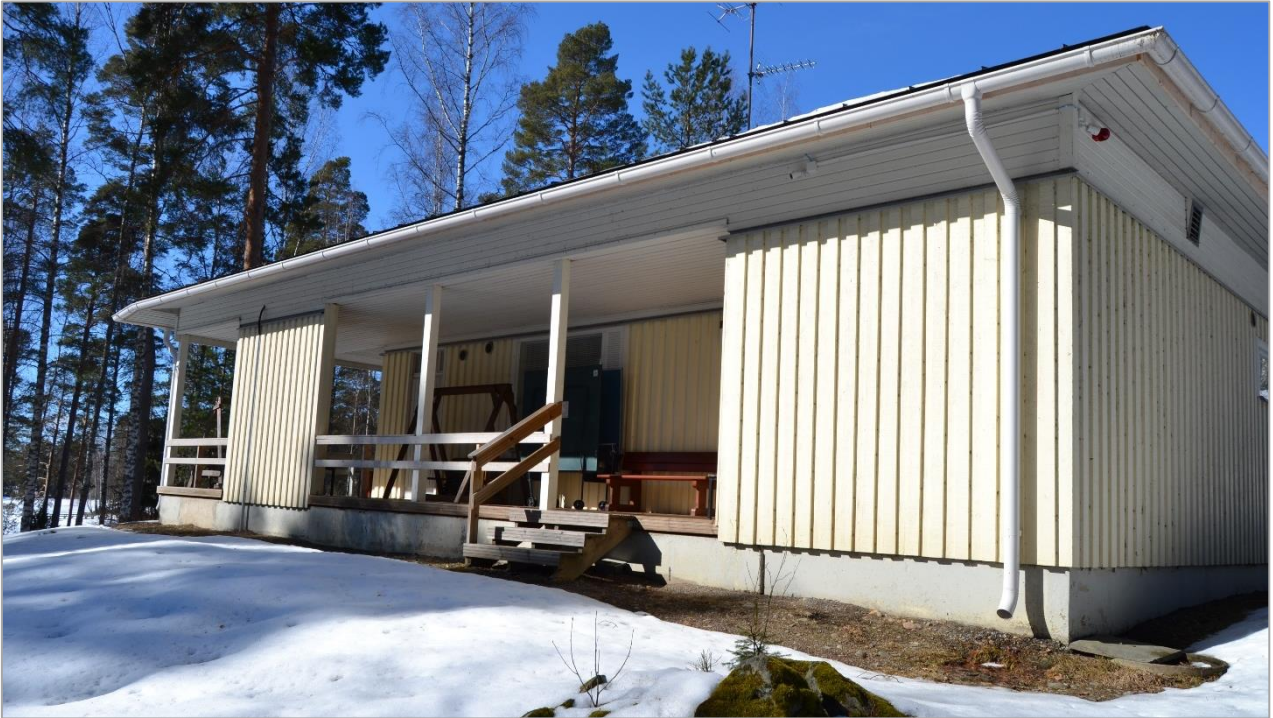
Kuva 67. Entisen kesäkotirakennuksen terassi kuvattuna itäpuolelta.
