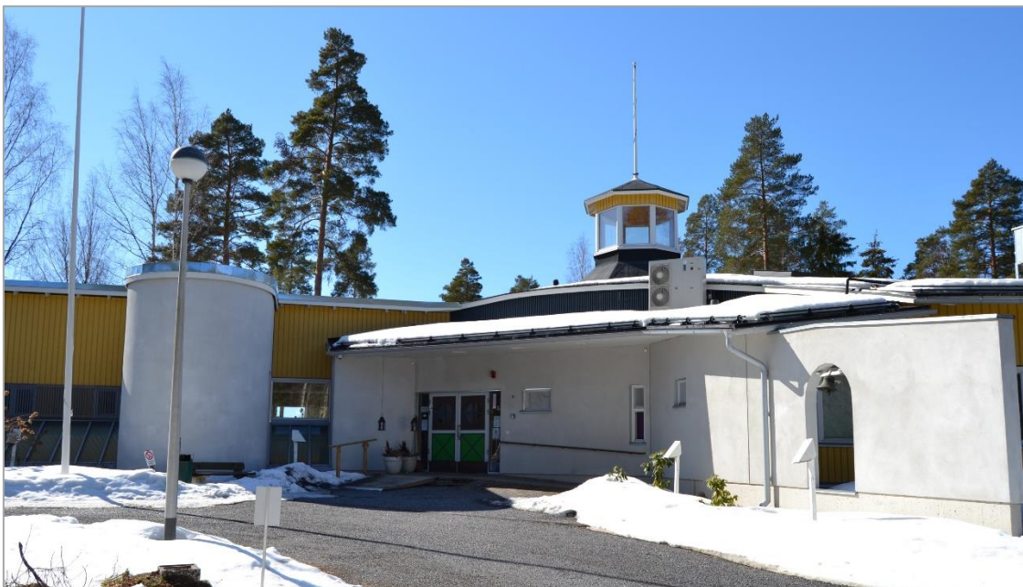
Kuva 64. Leirikeskusrakennuksen pääsisäänkäynti. Alkuperäisistä piirustuksista on poikettu sikäli, että suunnitelman mukainen betoniharkkopinta on julkisivussa korvattu sileällä betonipinnalla.
