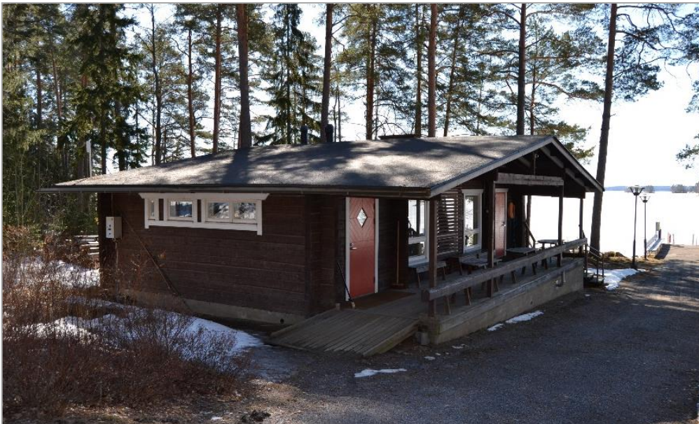
Kuva 68. Leirikeskuksen sauna kuvattuna pohjoispuolelta.
