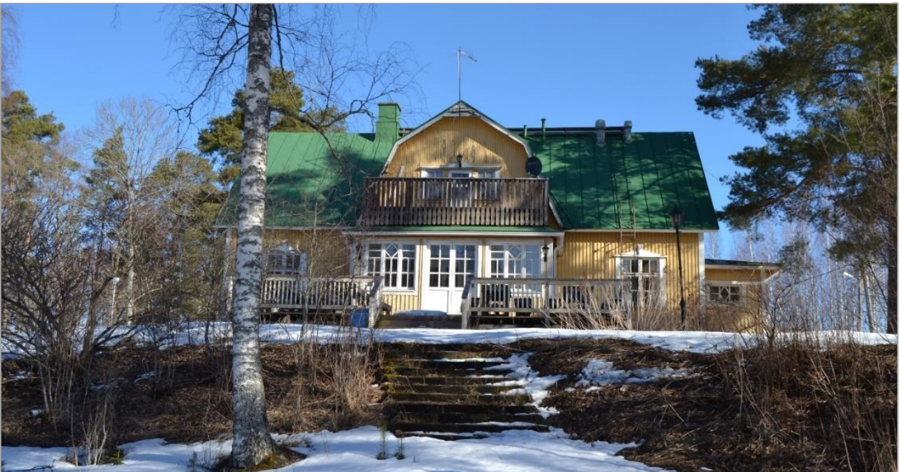
Kuva 30. Päärakennus kuvattuna etelän puolelta. Rakennukselta johtaa kiviset portaat kohti rantaa.
