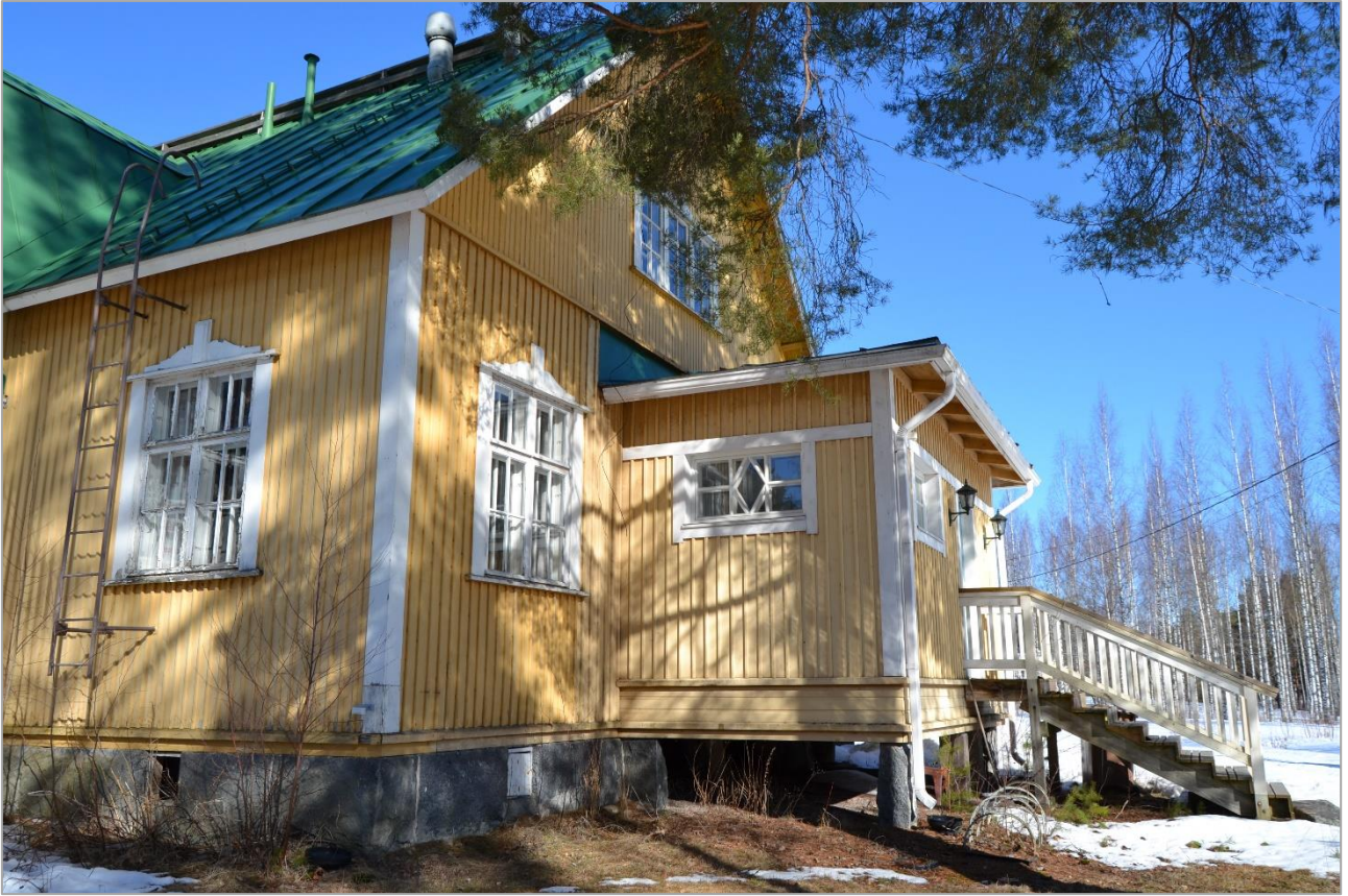
Kuva 31. Lehtiniemen päärakennuksen itäpääty kuisteineen.
