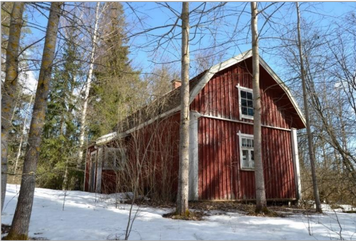
Kuva 57. Sotkalinna asuinrakennus kuvattuna Sotkalinmankadulta päin.
