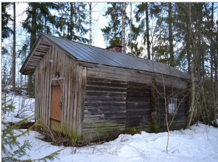
Kuva 59. Hirsirakennus kuvattuna idän puolelta.
