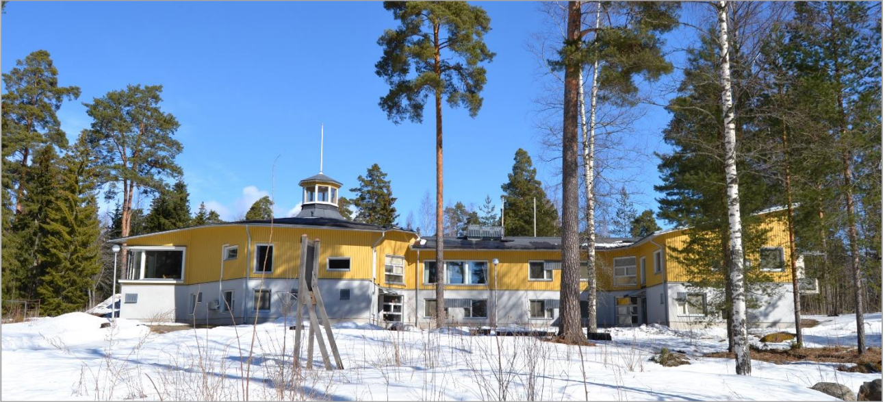
Kuva 65. Leirikeskusrakennuksen eteläjulkisivu kuvattuna rannan puolelta.
