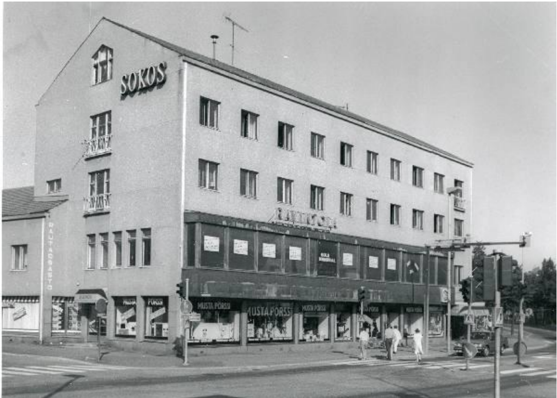
Kuva 1. Keski-Hämeen rakennus (kuva kopioitu osoitteesta www.kotiseutuarkisto.fi )
