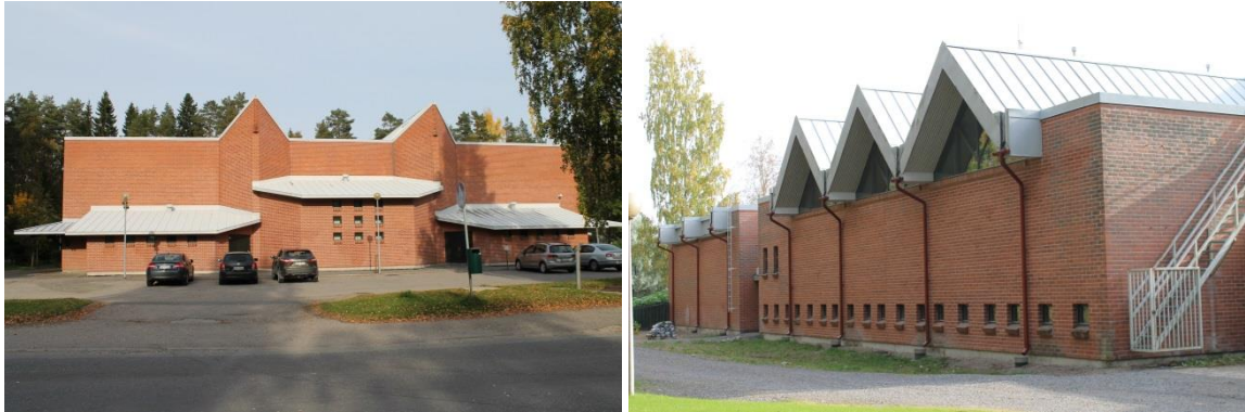
Kuva 4-19 Vasemmalla Rantatien puoleinen julkisivu ja oikealla pohjoisen puoleinen julkisivu.
