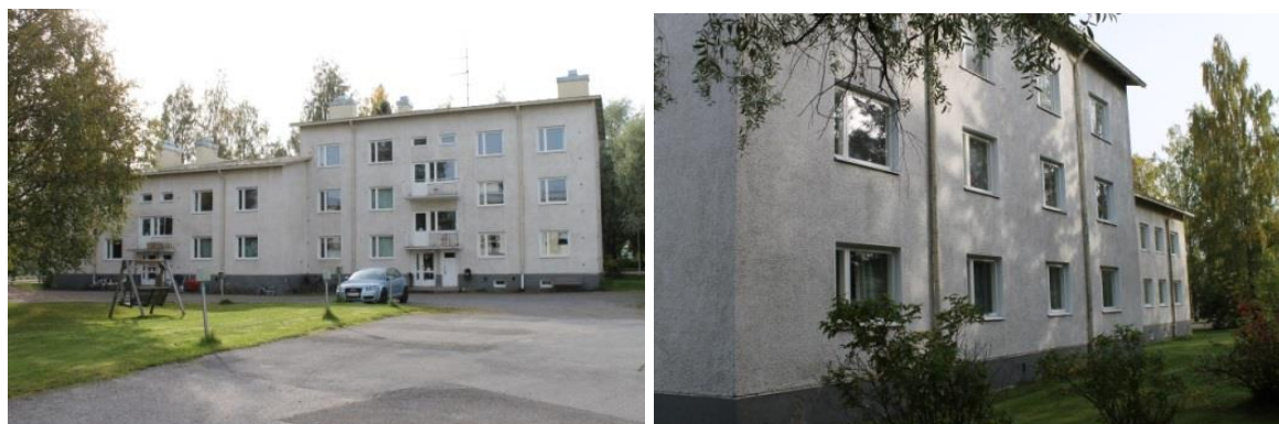
Kuva 4-15 Vasemmalla rakennuksen sisäpihan puoleinen julkisivu ja oikealla Rantatien puoleinen julkisivu.
