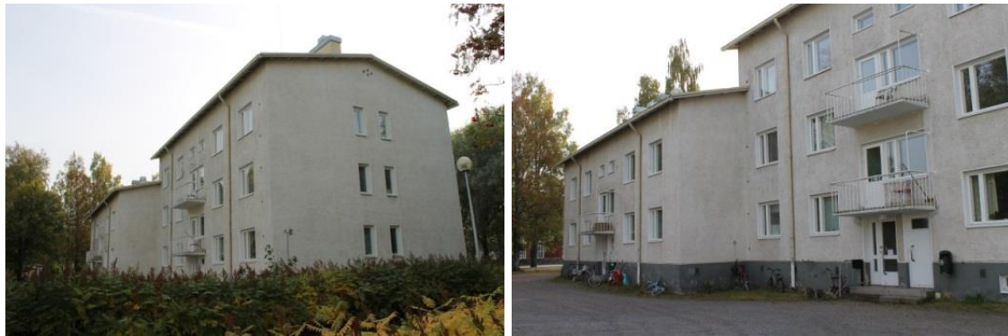
Kuva 4-16 Asuntolan julkisivut ovat säilyneet aikakaudelleen ominaisina.
