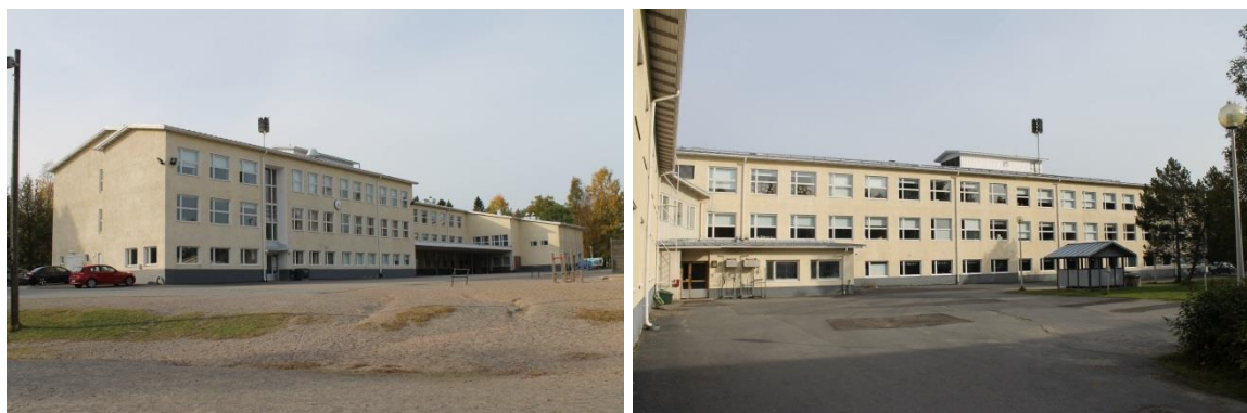
Kuva 4-12 Vasemmalla koulun julkisivu itään ja oikealla sisäpihan puoleinen julkisivu.
