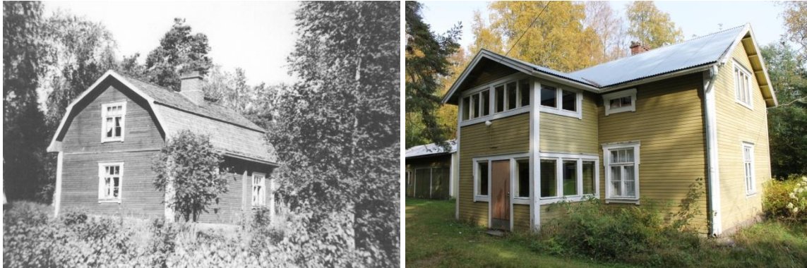
Kuva 4-23 Päärakennus ennen kattomuutosta (Kuva: Ykspetäjä) ja kattomuutoksen jälkeen.
