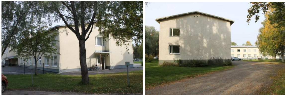
Kuva 4-13 Vasemmalla koulun laajennusosaa ja oikealla asuinrakennuksen pääty Rantatien suuntaan.
