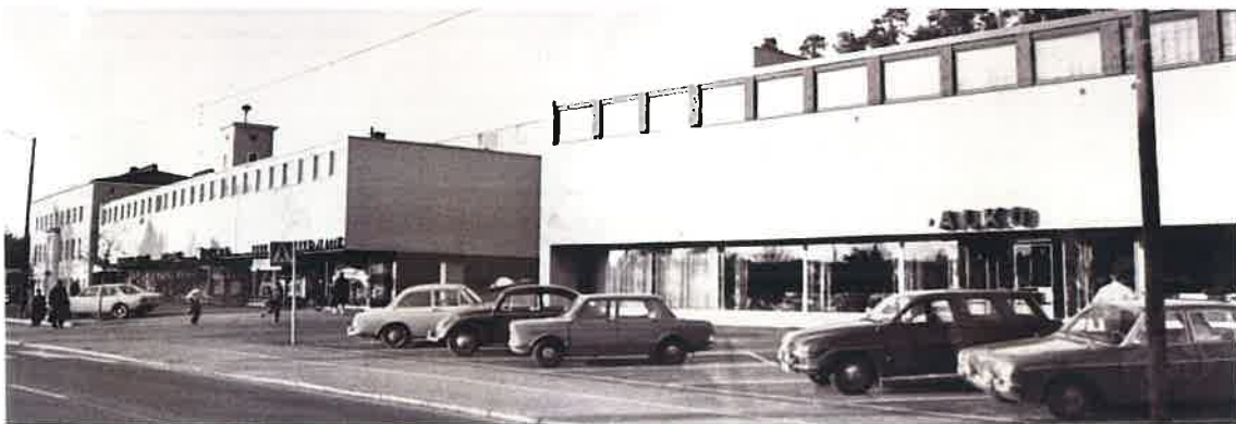
Alla Kuohunharjun 1960-luvulla rakennetut liiketilat. Kuva otettu 1980-luvulla. Kuvalähteet: Kangasala-Seura
