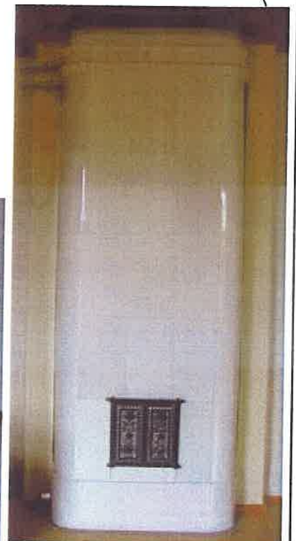
Salin alkuperäinen uuni
