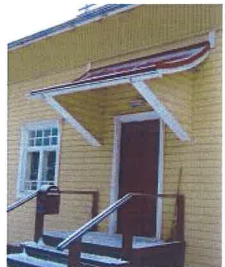
Länsipuolen ovi ja katos
