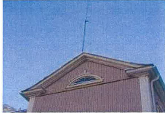
2. Etelän puoleisen julkisivun päätykolmio
