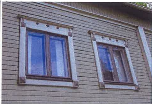
1. Asuinrakennus vasemmalla ylhäällä pohjoisesta, alakuvassa kaakosta. Yläkuvassa ikkunat koillisen puoleiselta julkisivulta.
