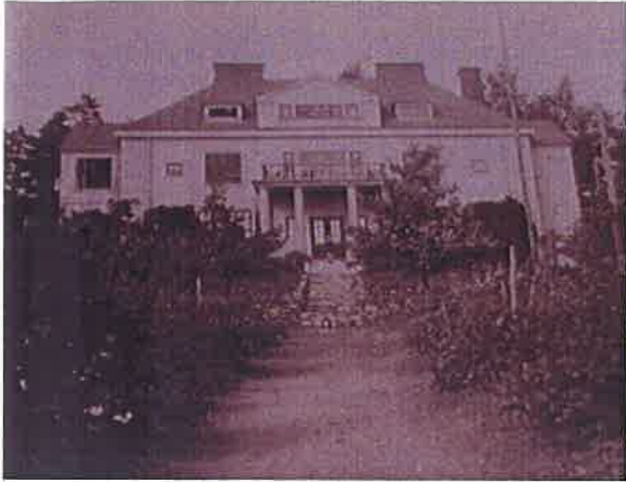
1. Asuinrakennus etelästä uudistusten jälkeen 1920-30-luvulta.
