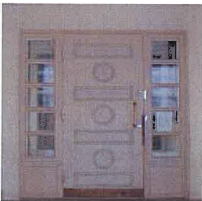
1. Vanha kansakoulu, ulko-ovi etelän puoleisella sivulla, katoksen alla.
