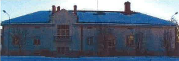
1. Vanha kansakoulu, pohjoisen puoleinen julkisivu.
