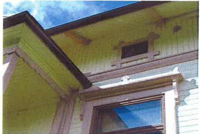
1. Asuinrakennus; eteläsivun konsolit ja ikkunan vuorilaudan koristeet.
