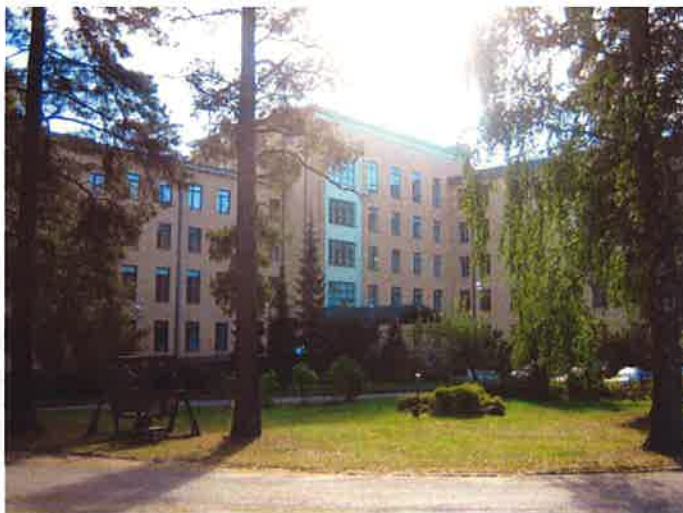
Kuva 7. Sairaalarakennus luoteesta katsottuna
