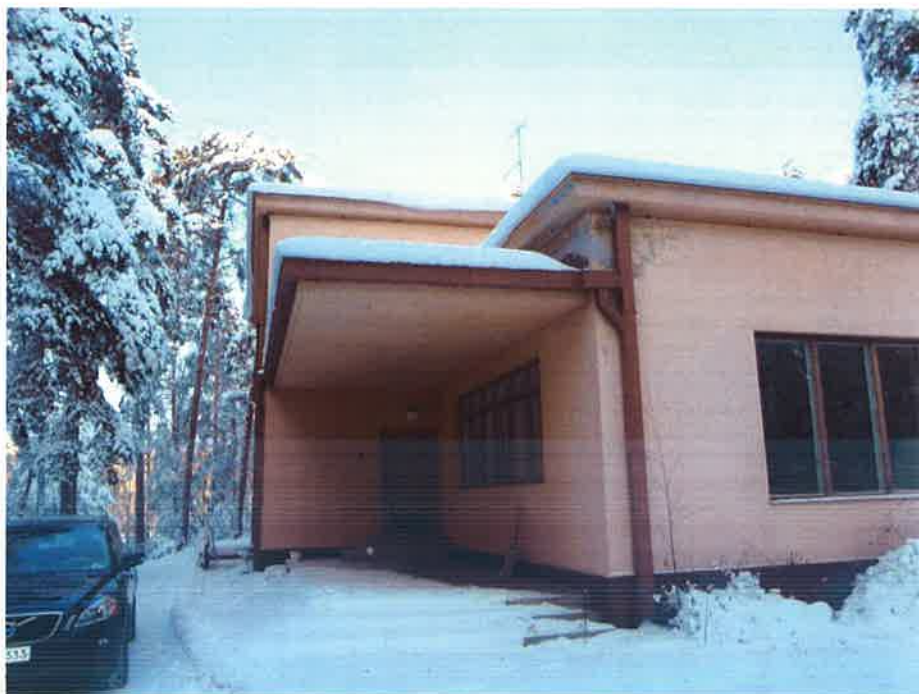
Kuva. Tietolan pääsisäänkäyntiä korostaa leveä katos.
