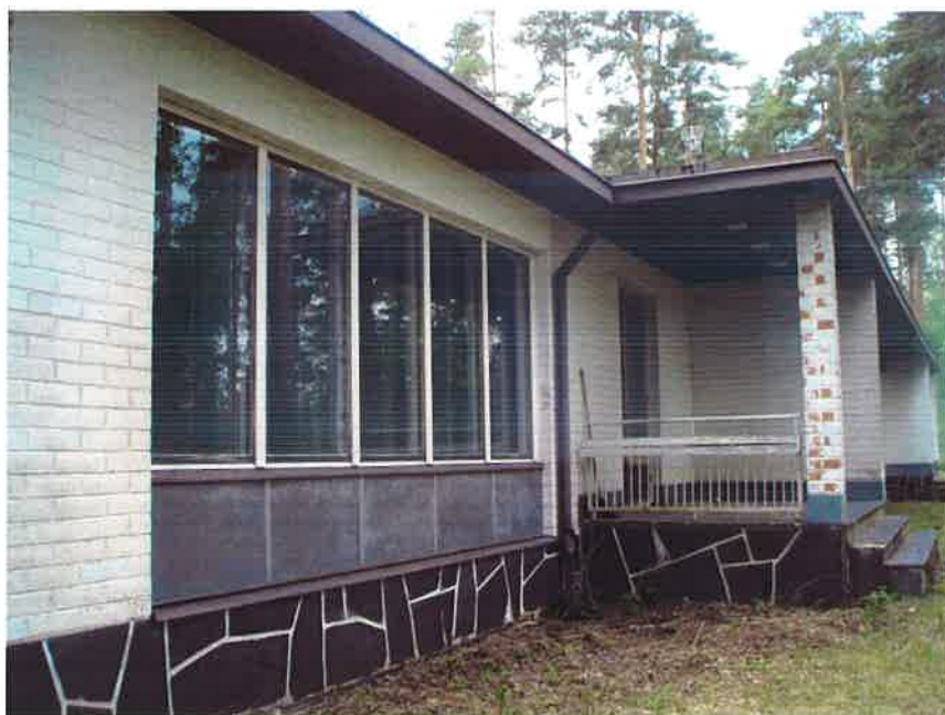
Kuva. Rikulan järvenpuolen julkisivu.
