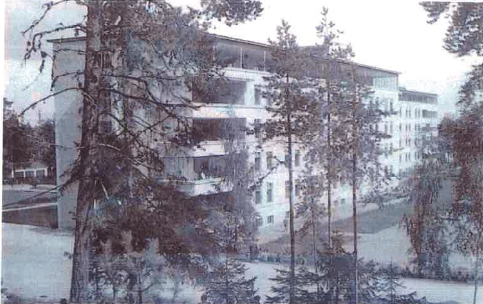
Kuva. B-siiven eteläpuolella on näkyvissä alkuperäiset avoimet hallit potilaiden päivämakuuta varten.
