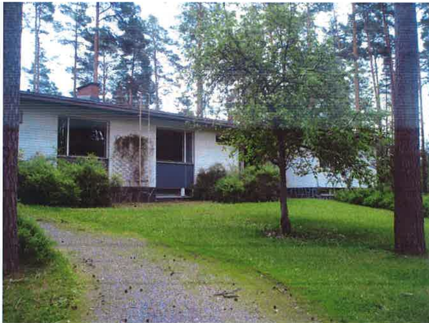
Kuva. Rikulan länsipuolen julkisivu.
