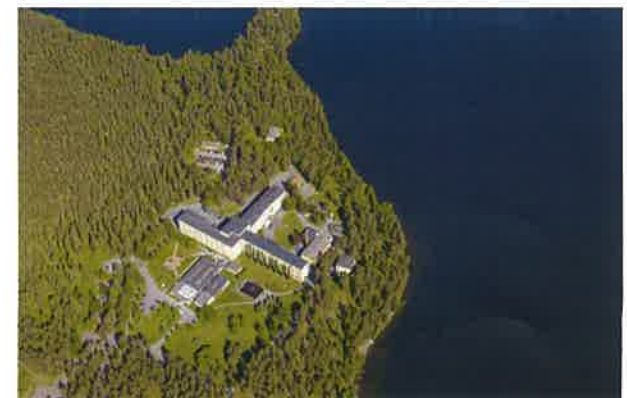
Ilmakuva 2000-luvun alusta.
