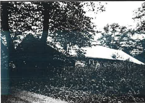
Idän puoleista julkisivua ja pohjoispäätä.
