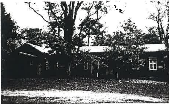
Etelän puoleinen julkisivu.
