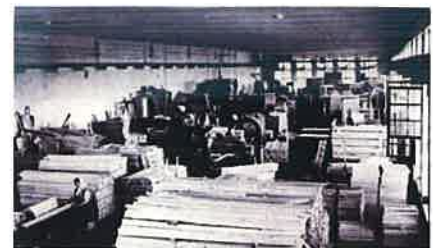
Puurakennetehtaan ovien kasaus- ja liimausosasto, kuva 1940-luvun lopulta tai 1950-luvulta (AA (VTA))
