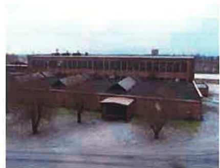
Kuva vaneritehtaan katolta. Takana korkeampi puurakennetehtas vuodelta 1947, etualalla lastulevytehtaan viimeistelyosastolaajennus vuodelta 1956. Puurakennetehtaan pohjoisjulkisivu on alun perin muodostanut lähes identtisen parin vaneritehtaan vuonna 1951 valmistuneelle laajennusosalle.
