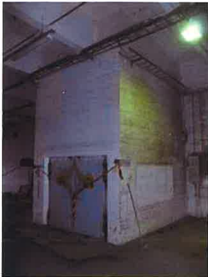
Vanerin tuotantoprosessia palvellut hissi rakennuksen 2. kerroksessa
