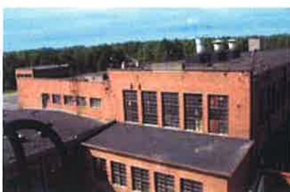
Rakennuksen itäpääty voimalaitoksen katolta kuvattuna, etualalla muuntamolaajennus (KI)
