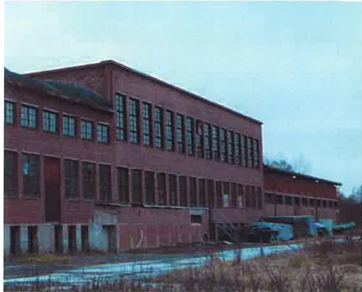
Laajennusosan pohjoisen puoleinen julkisivu
