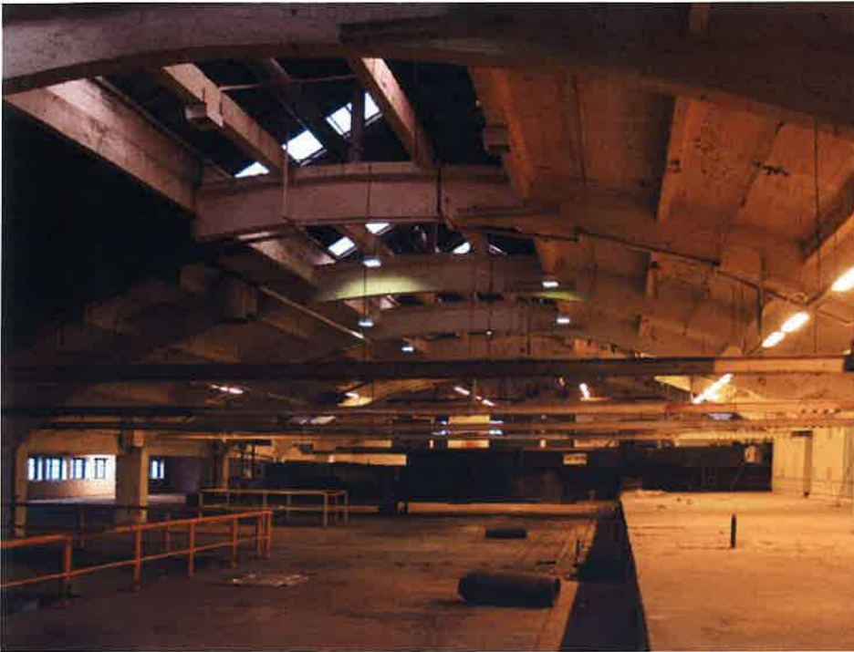
Entisen lasitehtaan kattorakenteita.
