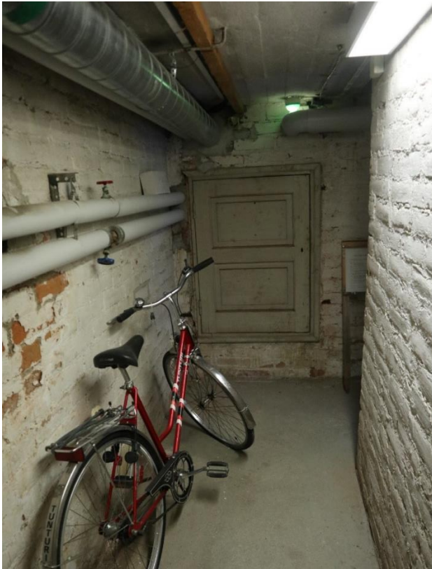
Kuva 72. Kellaria kiertävä huoltokäytävä on säilynyt alkuperäisenä.
