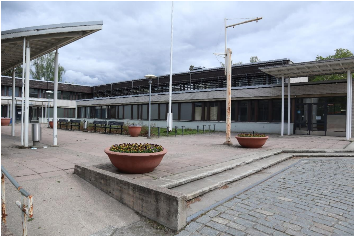
Kuva 92. Virastotalo liittyy katulinjaan matalan betoniportaikon kautta. Vähäeleinen piha-alue on tyypillinen saman aikakauden liikekeskuksille.
