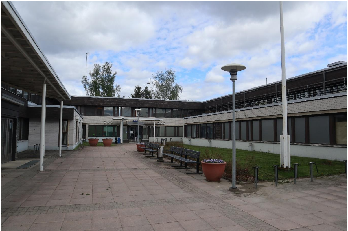
Kuva 30. Vuonna 1969 valmistunut valtion virastotalo muodostaa atrium-tyyppisen pihan Kangasala-taloa vastapäätä.
