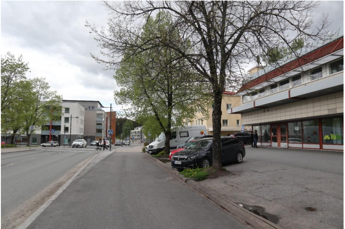
Kuva 28. Näkymä Harjusolan liikerakennuksen kohdalta länteen.
