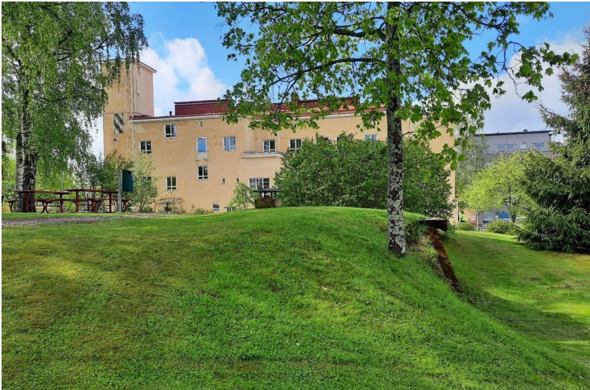
Kuva 39. Kaupungintalon takapihalla on tiilirakenteinen, osittain betonoitu maakellari.
