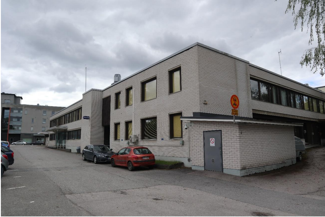
Kuva 88. Julkisivu kaakkoon. Tässä kulmassa on aiemmin ollut korkea savupiippu.
