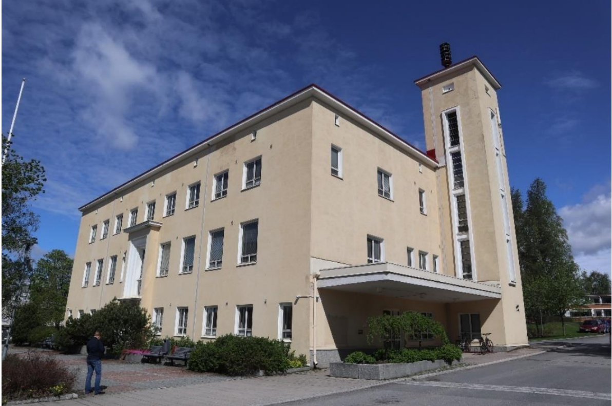
Kuva 41. Kaupungintalon itäpäädyssä on letkutorni ja lippakatos muistona palokunnan toimimisesta rakennuksessa.
