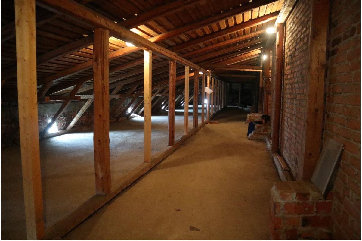
Kuva 73. Ullakon kattotuolirakenteet.
