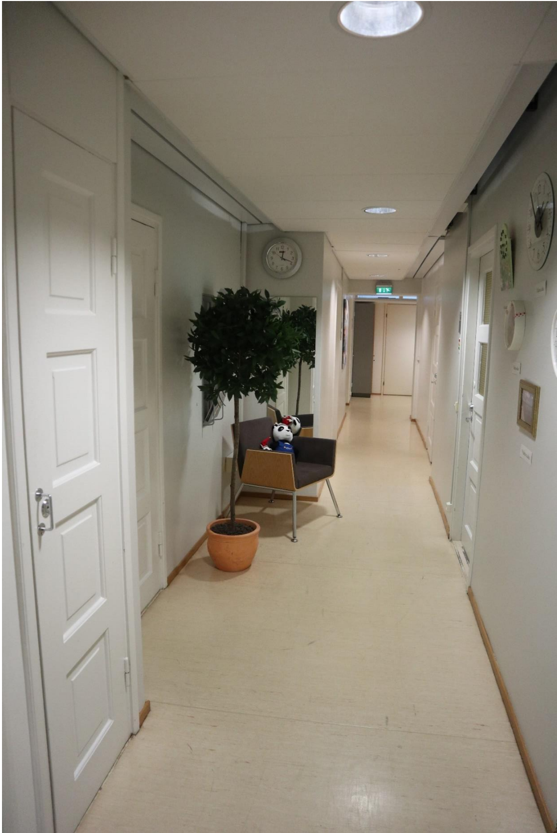
Kuva 65. Kolmannessa kerroksessa on säilynyt eniten peiliovia.
