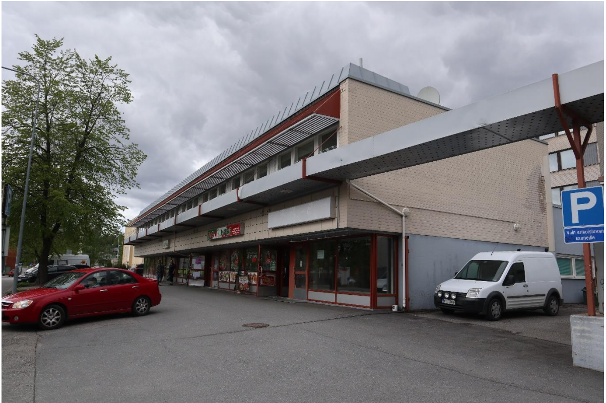
Kuva 95. Liikerakennus Harjusola I.
