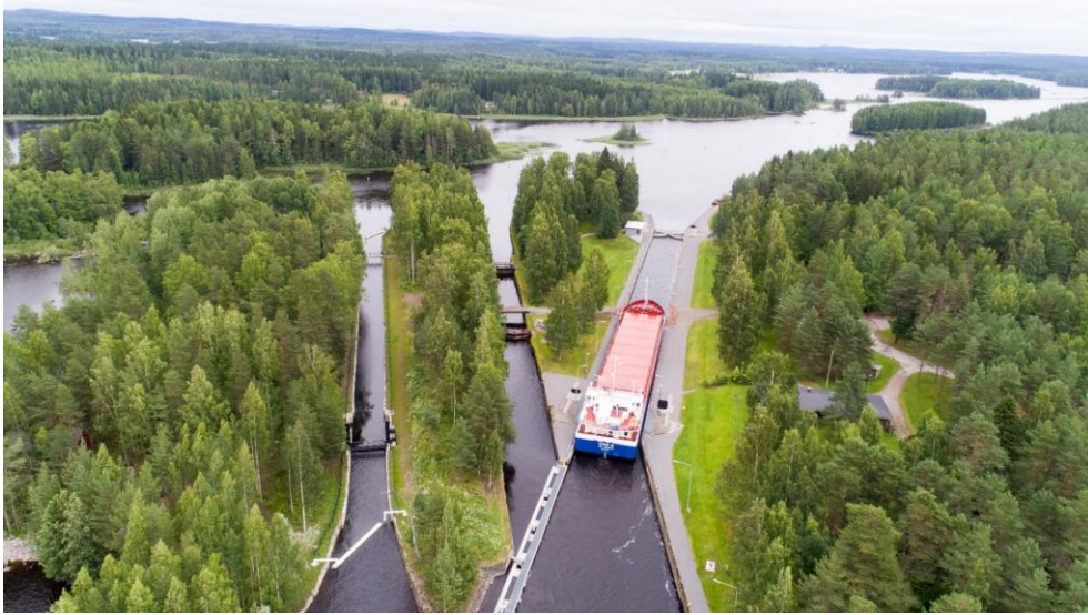
Kuva 19. Konnuksen kanavalla on säilynyt sekä 1867 valmistunut sulku-kanava että 1919 valmistunut vanha uittosulku, joka rakennettiin vanhimman 1841 valmistuneen kanavan tilalle. Vanhojen kanavien yläkanavat suljettiin kulkujohteilla Varkauden ja Kuopion välisen syväväylätöiden yhteydessä, kun rakennettiin Konnuksen neljäs kanava, joka avattiin liikenteelle 1972.
