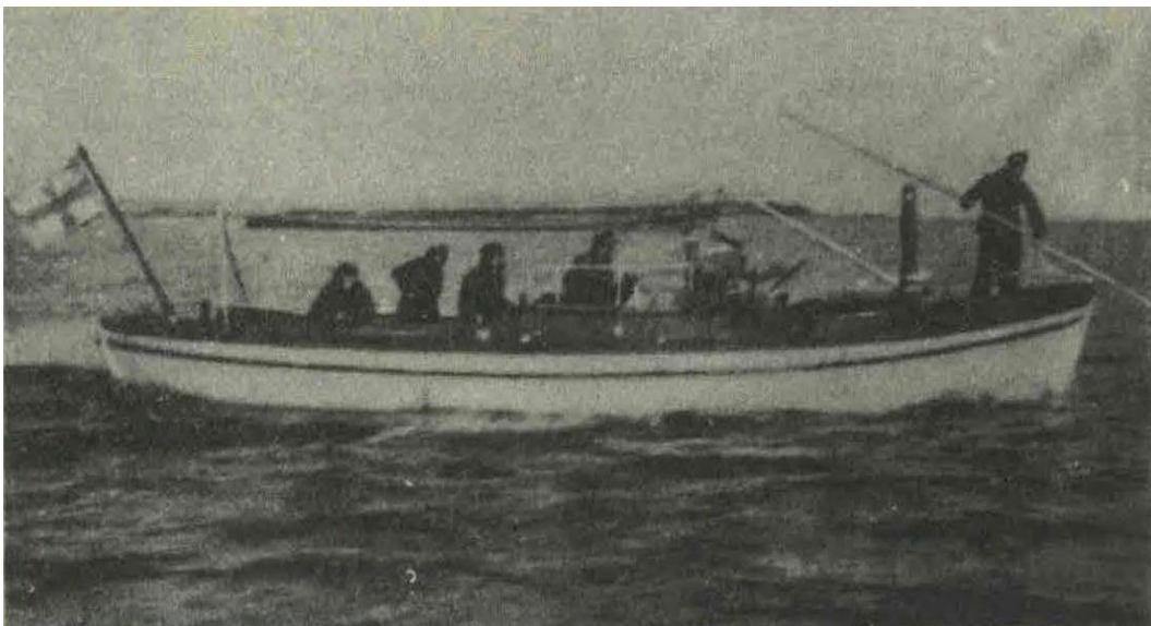
Kuva 3. Sauvaluotausta moottoriveneellä 1920- tai 30-luvulla. (Merenmittaukset Suomessa 1947).
