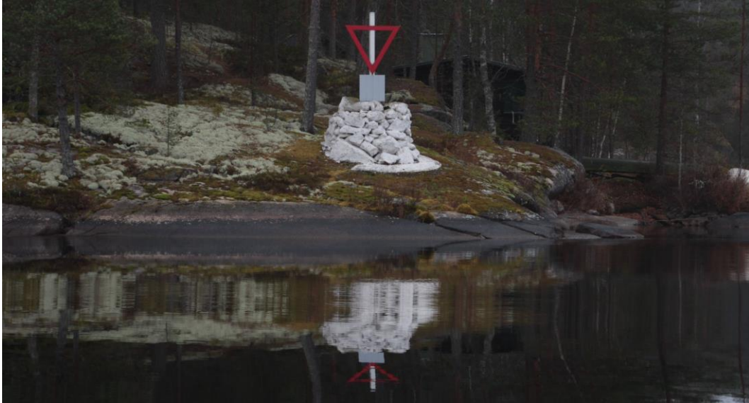
Kuva 31. Kärsäniemen kummeli Puulavedellä. Puulan kummelit on restauroitu 1990-luvulla ja niissä on säilyneistä kummeleista parhaiten näkyvissä järjestelmän alkuperäinen ajatus. Jokainen kirkkailla perusväreillä maalattu huippumerkki on erilainen. Huippumerkin alapuolella näkyy kummeliin lisätty heijastinlevy.
