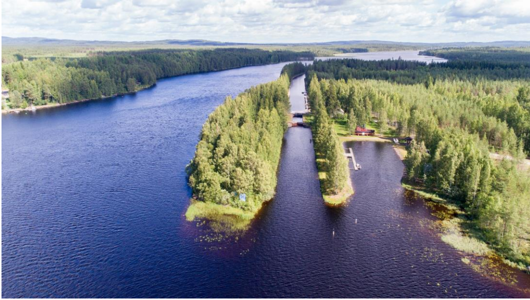
Kuva 13. Pielisjoen kanavista parhaiten alkuperäisen muotonsa ja ympäristönsä on säilyttänyt Jakokosken kanava, jossa on toiminut myös kanavamuseo. Kanava on säilynyt kivisulkuseksi 1900-luvun alussa uusittuna. Kanavanhoitajan asunto pihapiireineen on myös jäljellä. Liikenteellisen merkityksensä Pielisjoen kanavat menettivät veden pinnan noustua voimalaitosten rakentamisen vuoksi.
