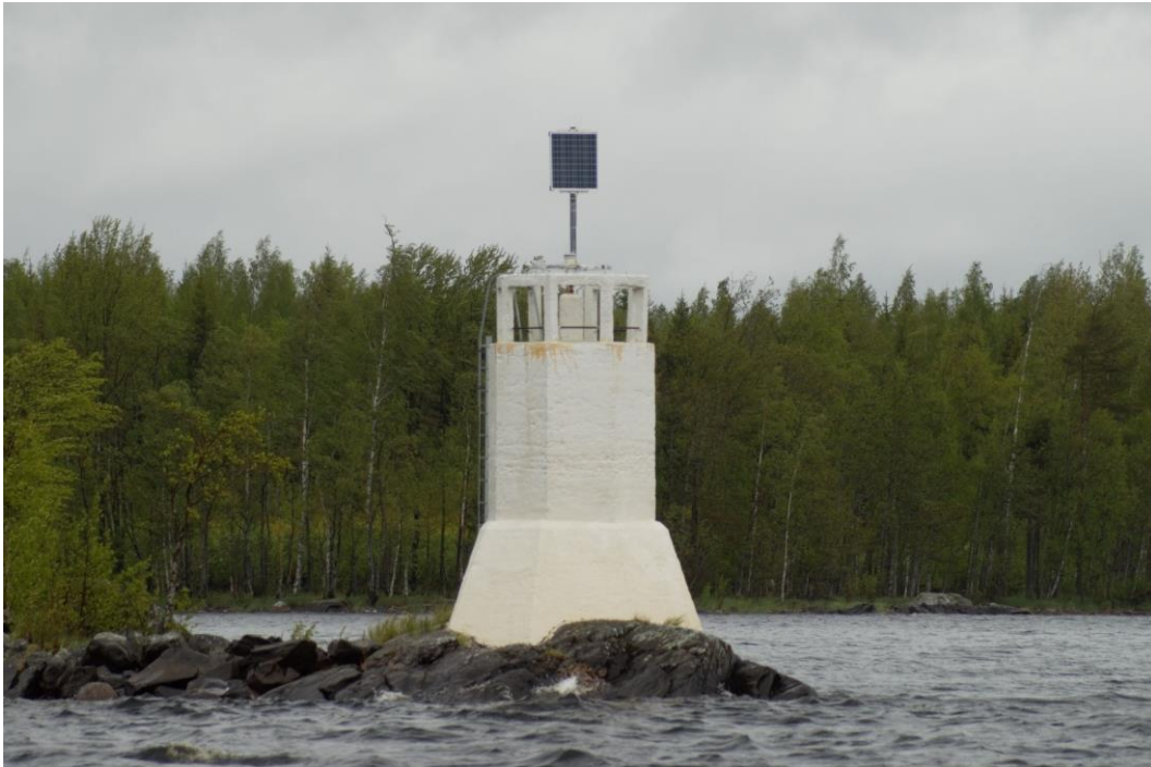
Kuva 43. Papinsaaren 1944 valettu loistotorni oli tyypillinen loistojen jalustan muoto sisävesillä 1920-luvulta 1960-luvulle. Betoni-torneja valettiin monen muotoisena ja monenlaisella tasanteella varustettuna. Jalustan sisällä säilytettiin loiston polttoaineena käytettyä kaasua. Papinsaaren loisto on laitteiltaan uusittu 1977 ja myöhemmin vaihdettu aurinkosähkölle.
