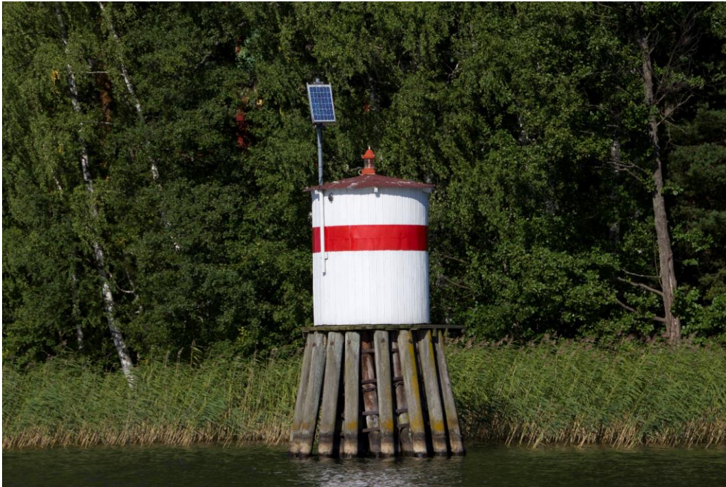
Kuva 41. Oinassaaren pyöreä duc d'alberin päällä seisova puuloisto on ainoa säilynyt tyyppinsä edustaja. Loistokojua on muutettu myöhemmin. Ilmeisesti loiston alkuperäinen sijainti on ollut Hinttola.
