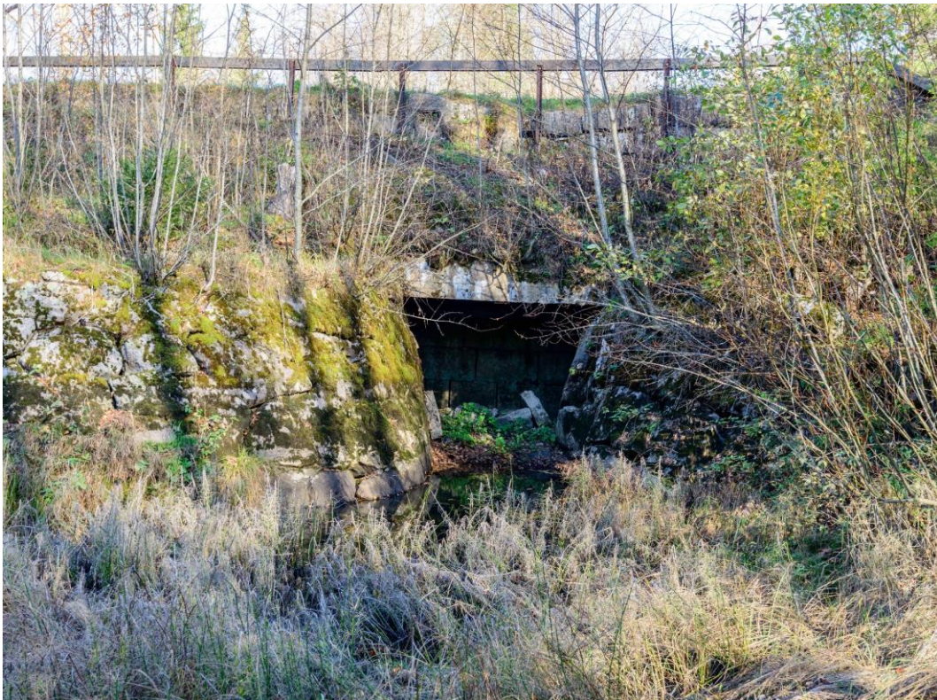
Kuva 12. Soskuanjoki alittaa vanhan kanavan uoman Kansolassa. Kuvassa Kansolan kulvertin myöhemmin rakennettu itäosa, joka on pahasti pusikoitunut.
