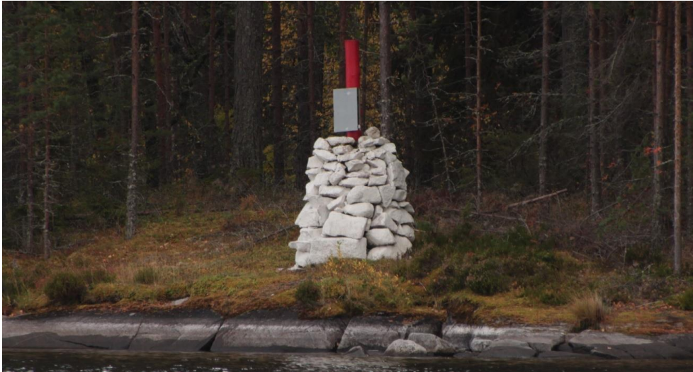
Kuva 34. Ruotoniemen kummi Konnevedellä on tyypillinen 1930-luvun kivikummi. Siinä ei ilmeisesti ole ollut huippumerkkiä, vaan erottumisen keinona on salon väri.
