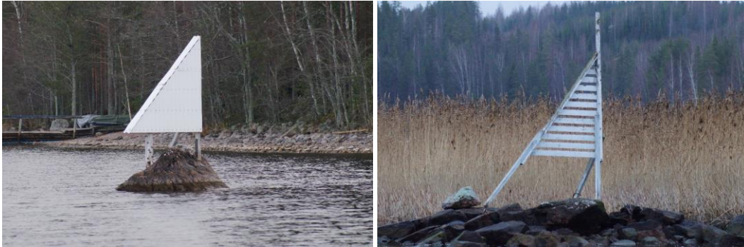
Kuva 35. Suuren Jänkäsalon edustalla seisova Jysmänniemen (Jysminniemen) kummeli on tyypillinen Saimaan syväväylillä käytetty kolmiokummeli, jota on kutsuttu myös linjatauluksi. Rakenteeltaan merkki on puuta ja päällystetty levyllä. Ensimmäinen kummeli samalla paikalla oli jo 1860-luvulla. Pien-Kontiosaaren kummeli Savonlinnassa taas edustaa samaa merkkityyppiä yksinkertaisimmillaan.
