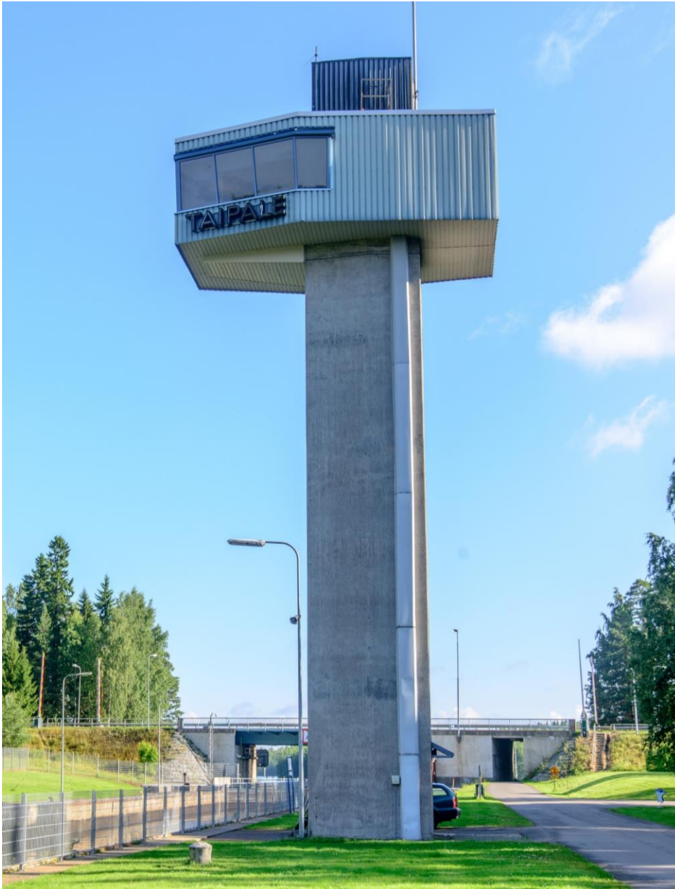
Kuva 22. Taipaleen kanavan monumentaalinen ohjauskeskus edustaa tyylikkäästi 1960-luvun modernismia.
