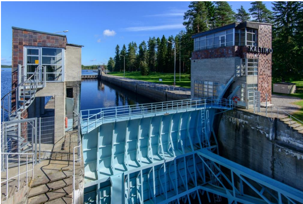
Kuva 20. Kaltimon vesivoimalaitokseen yhdistetty kanava oli ensimmäinen uittokanava, jossa käytettiin vaaka-akselisia sektoriporotteja. Taustalla näkyvä yläportti laskeutuu veden alle ja etualan alaportti nousee ylös sähkömoottoreiden voimalla sulutuksen aikana.
