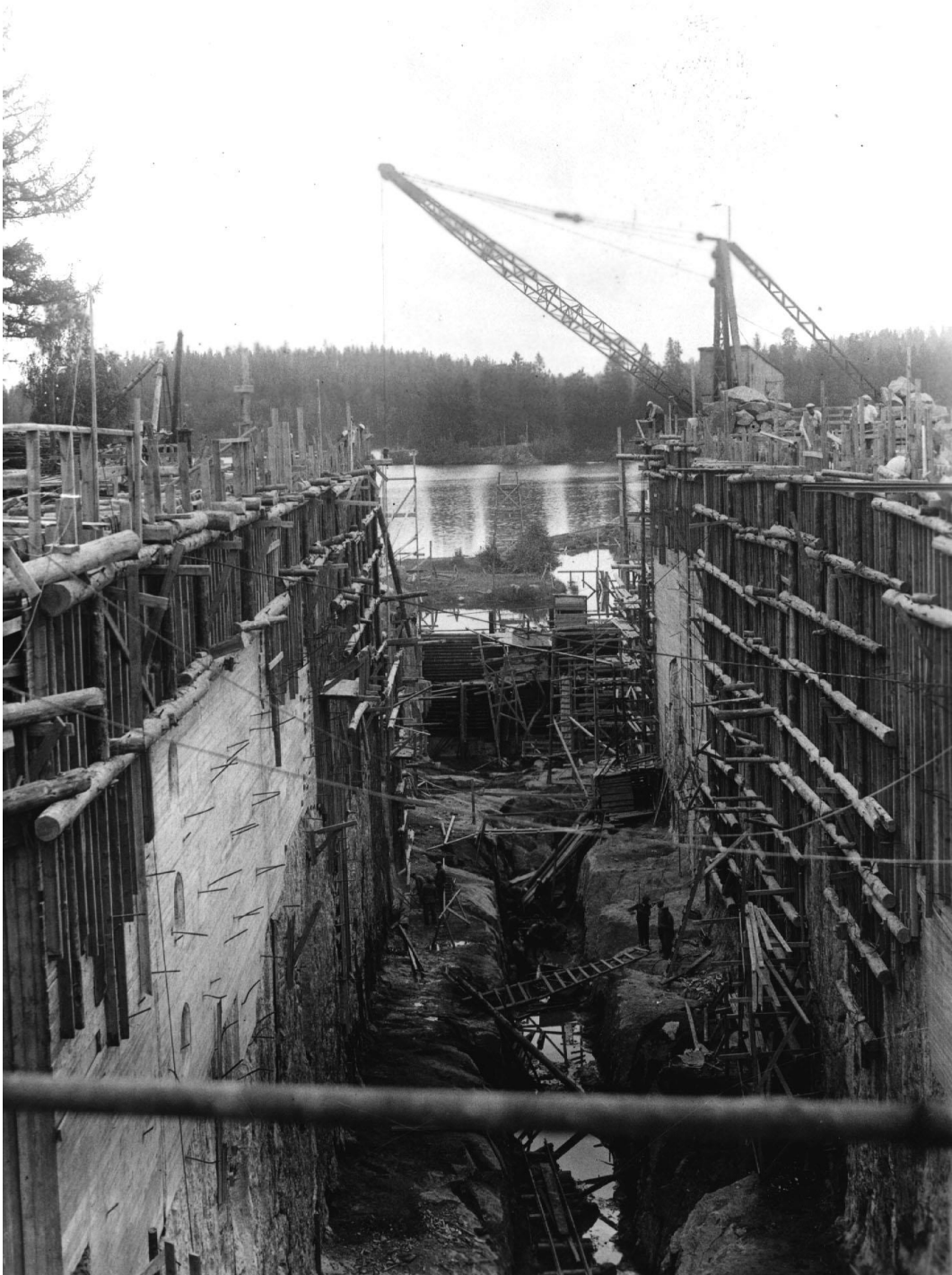
Kuva 18. Lietjärven suursulun rakennustyömaa kesällä 1937. (Kuva: Kanavamuseo).
