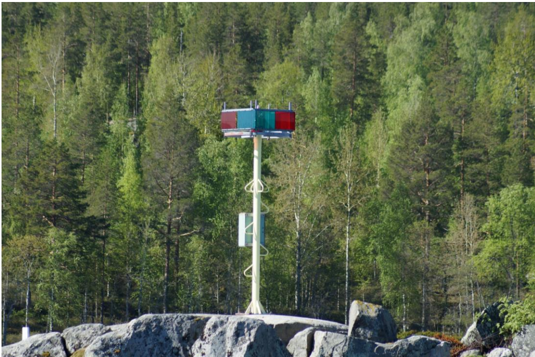
Kuva 47. Uramonsalmen loisto on tyypillinen 1970-luvulla rakennettu sähköparistolla toimiva sektoriloisto.
