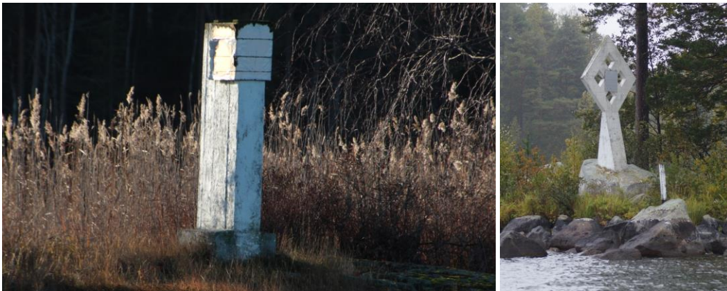
Kuva 33. Petäjäsaaren suorakaiteenmuotoinen betonikummeli Ruotsalaisella on lähes sadan vuoden iästään huolimatta säilynyt hyvin. Kaatiosaaren näyttävä betonikummeli Mallasveden Hirvonselällä näyttää reitin kohti Roineen Tossanselkää. Muiden kummeleiden tapaan myös betonikummeleihin on lisätty heijastinlevy pimeänäkyvyyden vuoksi.
