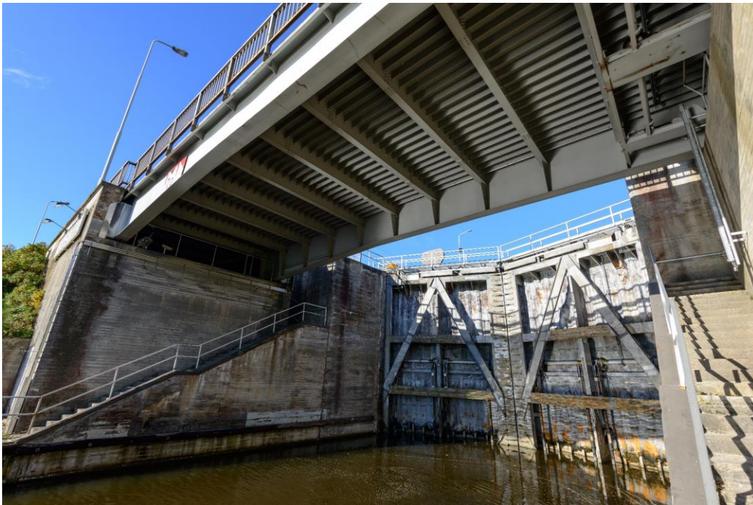
Kuva 24. Soskuan sulun alaportti sulun ulkopuolelta kuvattuna. Sulun edessä sijaitsee teräksinen läppäsilta.
