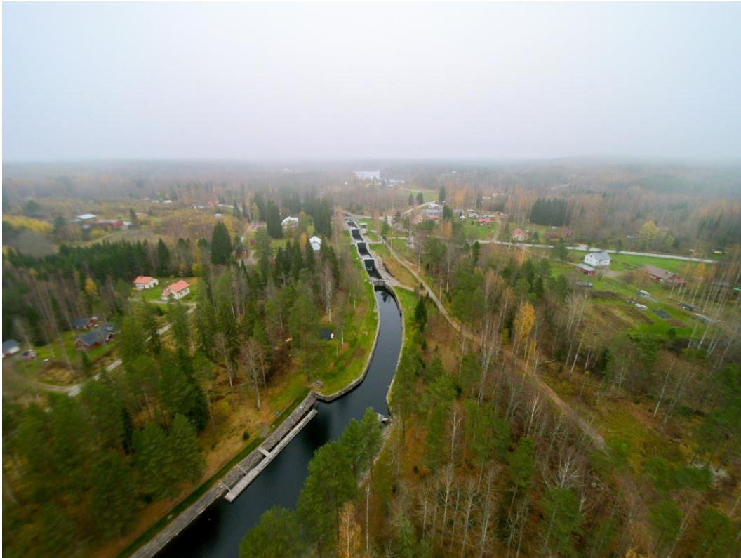
Kuva 14. Varistaipaleen sulkukanava Juojärven reitillä oli ensimmäisiä betonirakenteisia kanavia Suomessa. Kiviverhoilussa kanavassa käytettiin kuitenkin vielä puuportteja, minkä vuoksi putouskorkeus jouduttiin jakamaan neljään sulkualtaaseen. Kanavan ympäristö on säilynyt erittäin hyvin.
