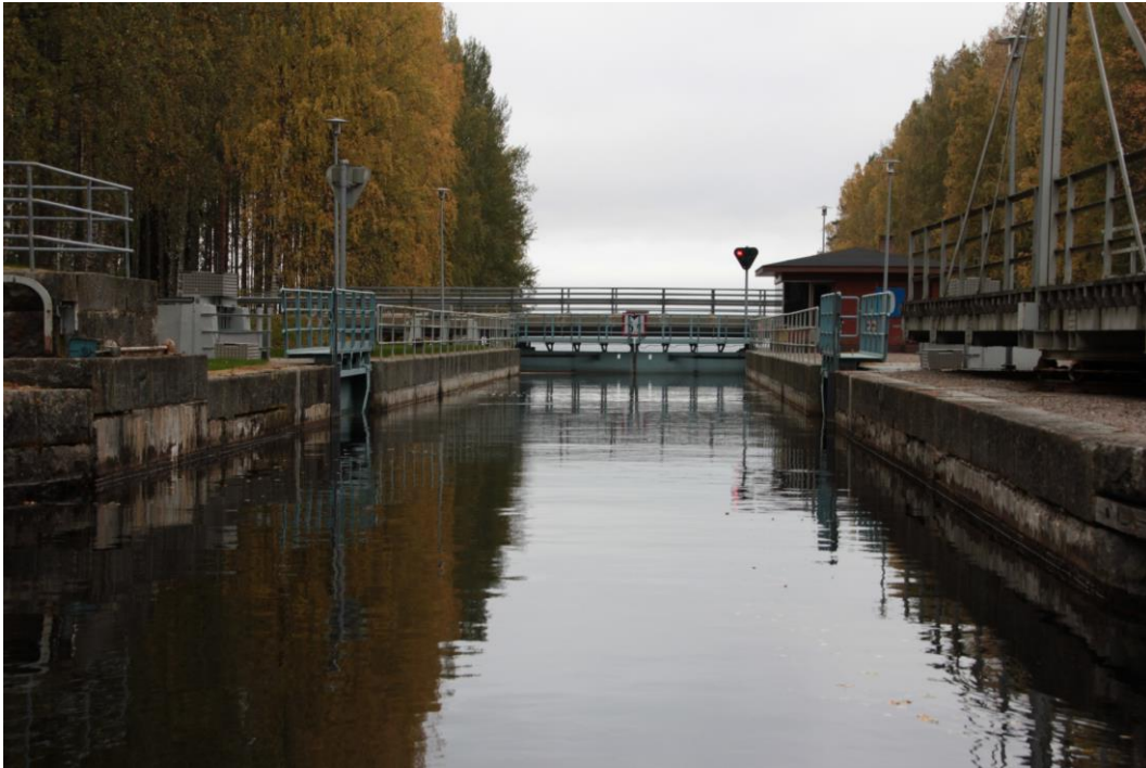
Kuva 16. Kaikki lisveden ja Keiteleen välille 1918–1927 rakennetut sulku-kanavat ovat säilyneet varsin hyvin. Kiesimän sululla on säilynyt myös kanavan alun perin ylittänyt teräsrakenteinen kääntösilta mekanismeineen.
