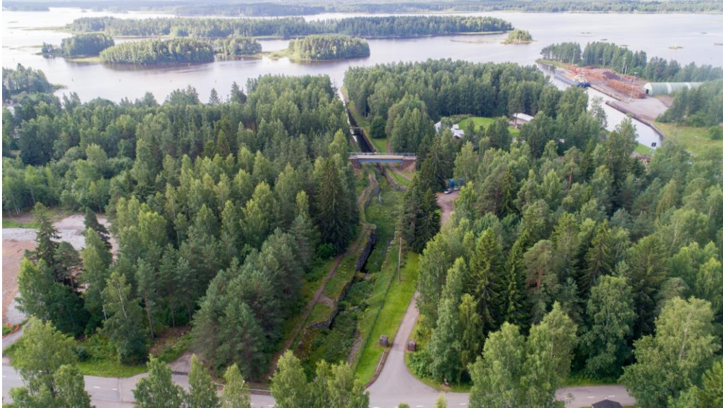
Kuva 8. Taipaleen vanhan kanavan kivirakenteet ovat säilyneet varsin hyvin. Kanavan keskellä on näkyvissä välikanavan allas, jossa sulutettavat alukset mahtuivat sivuuttamaan toisensa.
