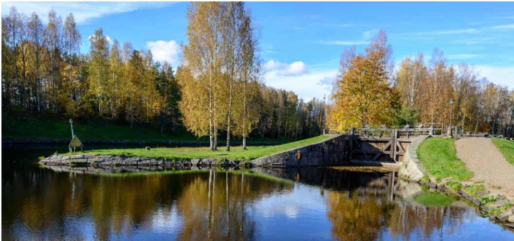
Kuva 10. Pien-Mustolan sulku entisöitiin vuonna 2008. Sulun alaportin vieressä näkyvät alkuperäiset kaarevat erittäin tarkasti muuratut kivrakenteet. Vasemmalla Saimaan uuden kanavan avoväylää.
