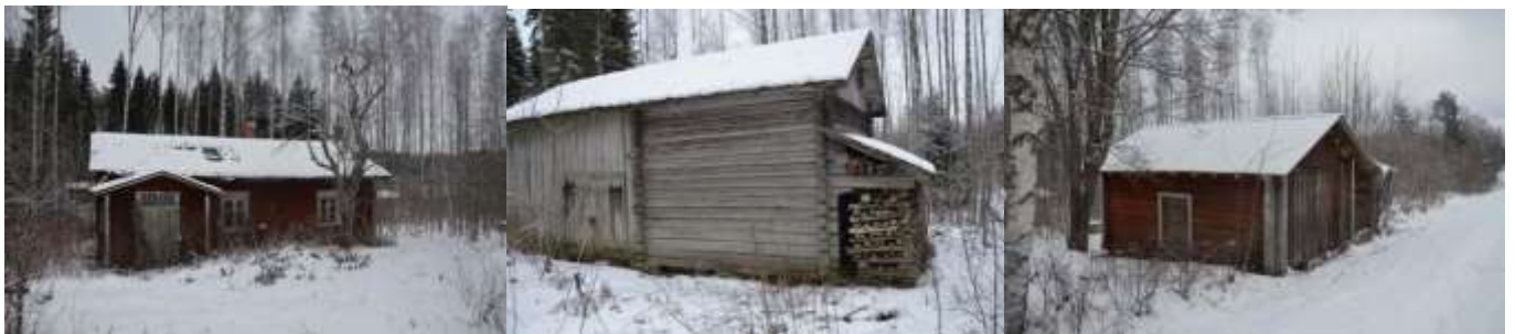
Kuvat: Koiviston rakennuksia, asuinrakennus, riihi ja aitta
