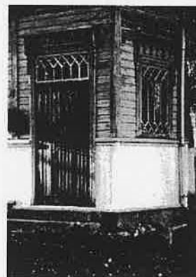
Kuva 16. Ulkolaudoitusta on järkevää korjata uusimalla vain vaurioituneet kohdat. Pohjoisen puolella vanhakin laudoitus on yleensä hyväkuntoinen.
