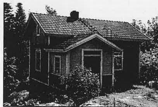
Kuva 14. Kuisti suojaa ja korostaa rakennuksen sisäänkäyntiä.
