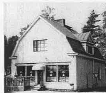
Kuva 5. 1920-luvulta oleva mansardikattoinen Koski-Baari on maisemallisesti ja paikallisesti merkittävä rakennus.
