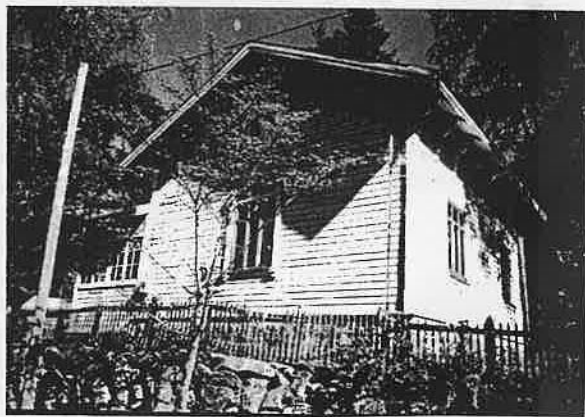
Kuva 4. Ratamestarin talo on rakennettu kirkon ja Siurontien väliseen rinteeseen vuonna 1895.
