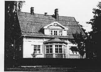
Kuva 3. Siurontien varteen rakennettiin suurimmat talot, kuvassa entisen sahanjohtajan talo 1920-luvulta.
