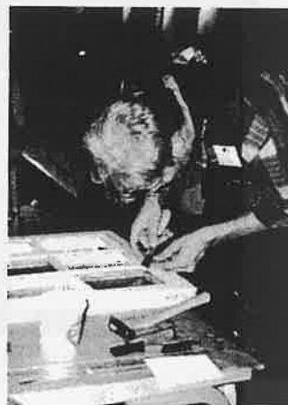
Kuva 13. Ikkunan kittäystä. Kitiin korvaaminen lasituslistalla lyhentää ikkunan ikää, koska puulistaa ei saa yhtä tiiviisti lasia vasten kuin kittiä.
