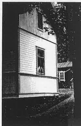
Kuva 8. Yksityiskohtien: mm. listojen ja laudoituksen säilyttäminen takaa rakennuksen kokonaisilmeen säilymisen.
