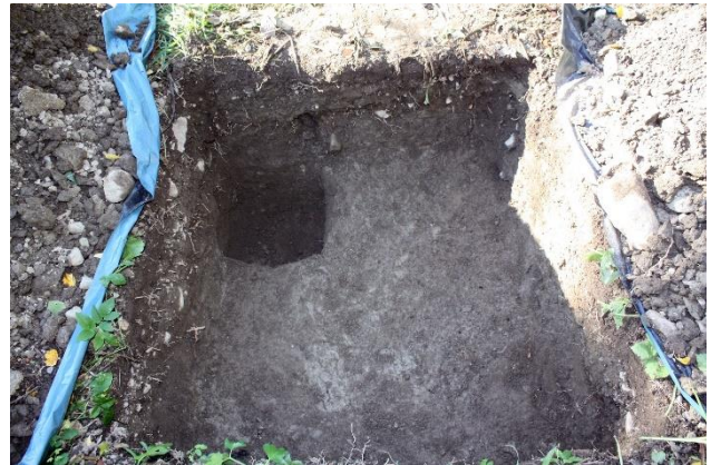
Kuva 12. Tutkimuskohteella olevan asuinrakennuksen pohjoispuolelle suunnitellulle putkilinjalle kaivettu koekuoppa nro 14, kuvattu koillisesta. AKDG 7055:19
