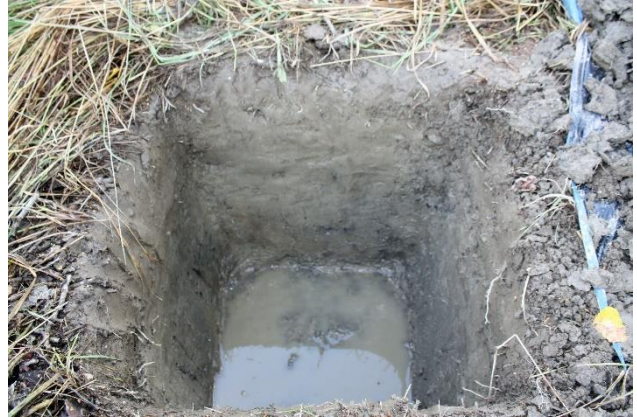
Kuva 14. Tutkimuskohteella olevan asuinrakennuksen itäpuolelle suunnitellulle putkilinjalle kaivettu koekuoppa nro 12, kuvattu etelästä. AKDG 7055:17
