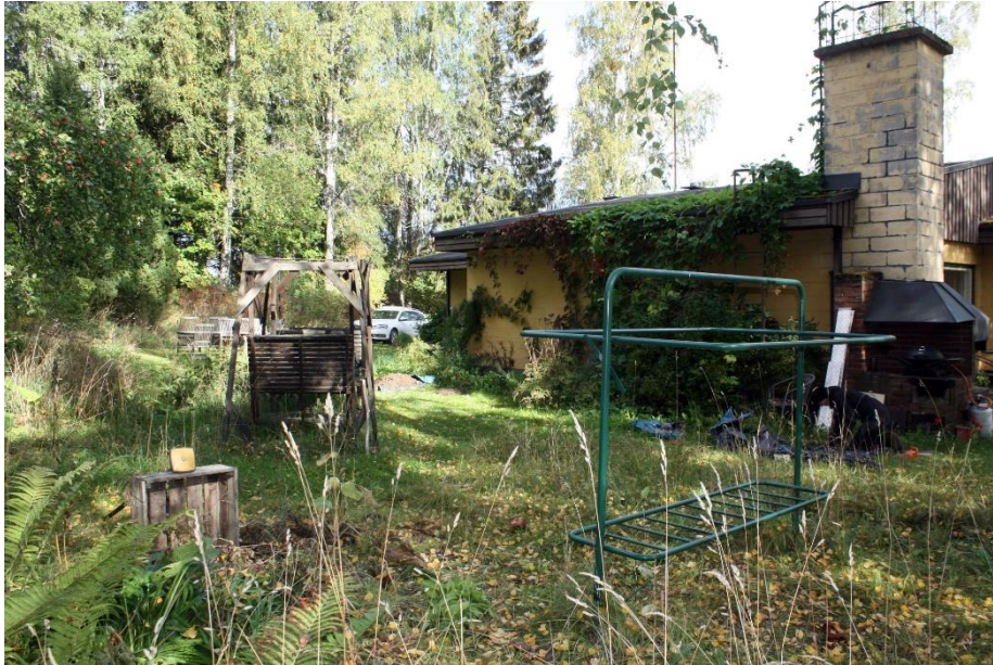
Kuva 18. Tutkimuskohteella olevan asuinrakennuksen lounaispuoleinen piha, johon asuinrakennuksen salaojitusta on suunniteltu. Kuvattu etelästä. AKDG 7055:8
