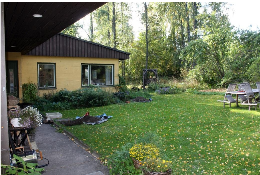
Kuva 17. Tutkimuskohteella olevan asuinrakennuksen länsipuoleinen piha, johon asuinrakennuksen salaojitusta on suunniteltu. Kuvattu pohjoisesta. AKDG 7055:7
