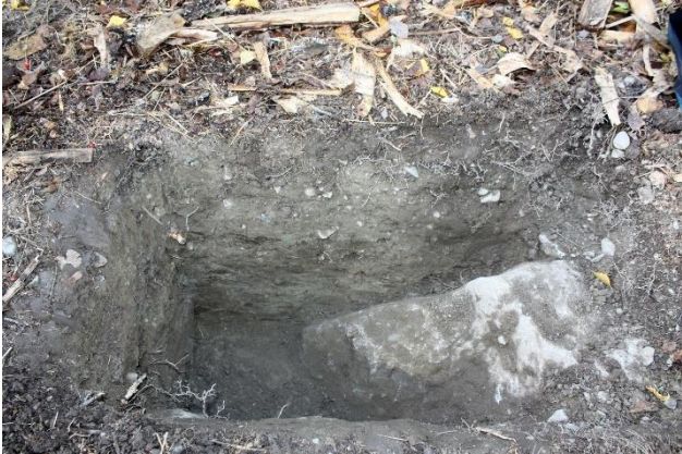
Kuva 13. Tutkimuskohteella olevan ajoluiskan kohdalle suunnitellulle putkilinjalle kaivettu koekuoppa nro 13, kuvattu kaakosta. AKDG 7055:18
