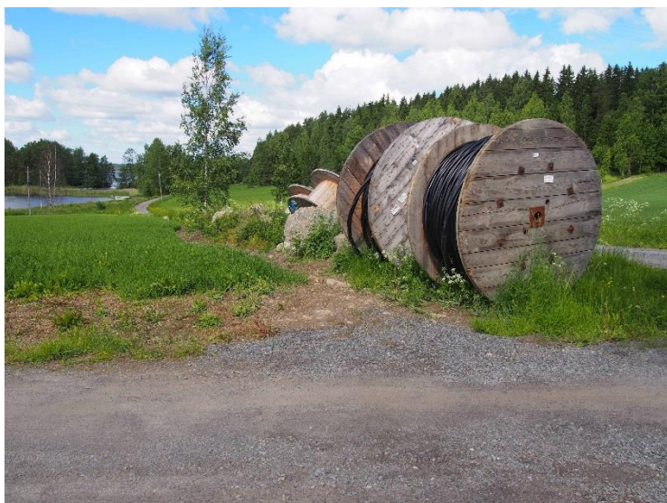
Kuva 22. Valvottavaksi määriteltyä ja ilman valvontaa kaivettua maakaapelilinjaa Uuramontien varressa Viekkalantien länsipuolella. Kuvattu idästä. (Kuva: Sastamala Karkunkylä koekaivaus 2017:16)
