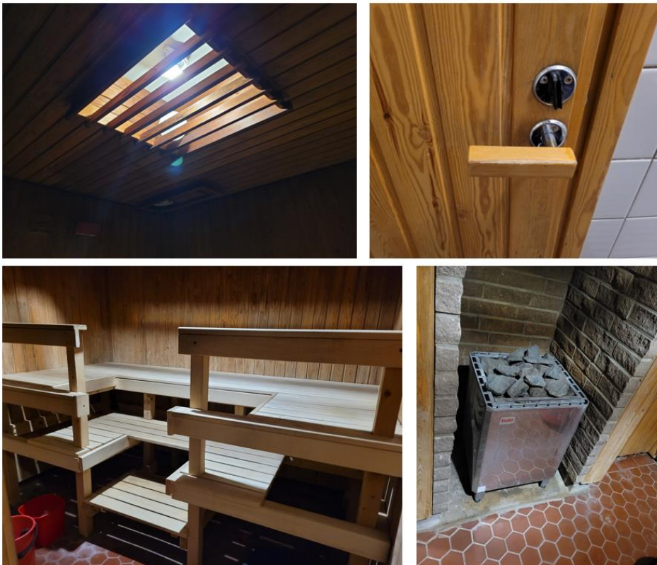
Kuva 32. Saunatilat ovat pitkälti alkuperäisessä kunnossaan. Saunatilat edustavat selvästi 1980-luvun alkua vaalean puun ja valkoisen kaakelin yhdistelmällä sekä katon puuritiläisen valaisimen osalta. Saunassa on samaa hexagonaalista lattialaattaa, kuin rakennuksen WC-tiloissa.
