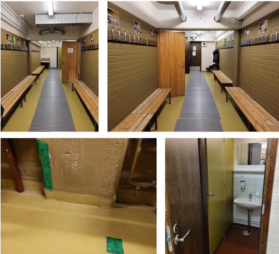
Kuva 29. Hallin pukuhuoneiden sisustus koostuu yksinkertaisista puupenkeistä ja naulakoista. Pukuhuoneiden lattiat ovat seinälle taitettua muovimattoa. Pukuhuoneiden WC-tilat ovat samannäköiset yleisön WC-tilojen kanssa.
