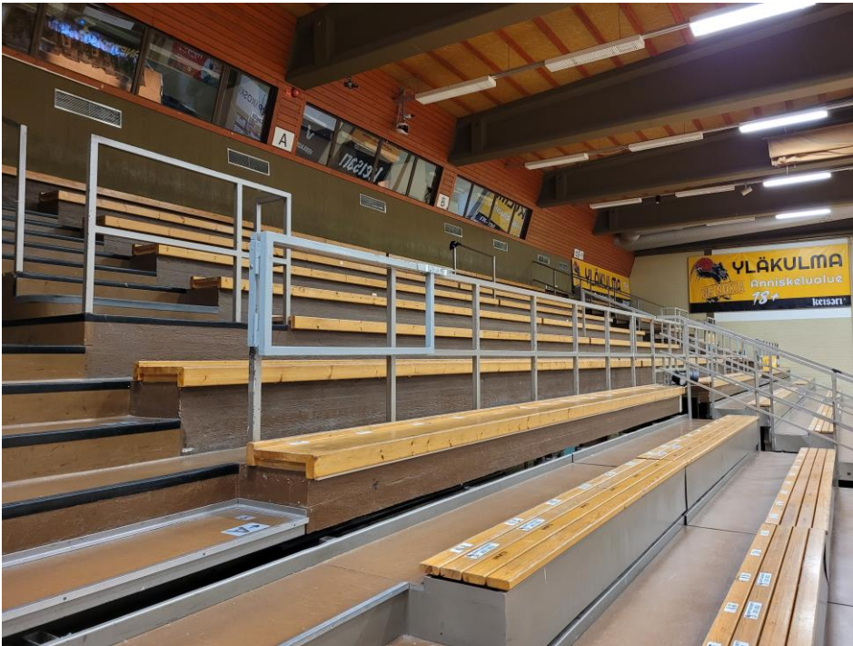
Kuva 26. Hallin katsomo vetää 750 henkilöä. Katsomon takana on selostamotilat ja teknisiä tiloja. Katsomorakenne on alemmilla osillaan teräs rakenteinen ja ylempillä osillaan betoninen.
