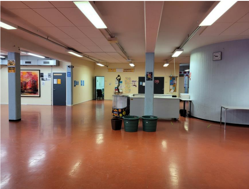
Kuva 18. Pääsisäänkäynnin sisäntuloaulasta on kulku hallin katsomoihin, WC-tiloihin, naulakoille sekä Tredun opetustiloihin. Sisäntuloaulan lattia on ruskeaa vinyylimattoa. Pilarit ja osa seinistä on maalattu harmaiksi, loput seinistä valkoisiksi. Aulassa on 1980-luvulle tyypillisiä kattokiskoihin kiinnitettyjä loisteputkivalaisimia.
