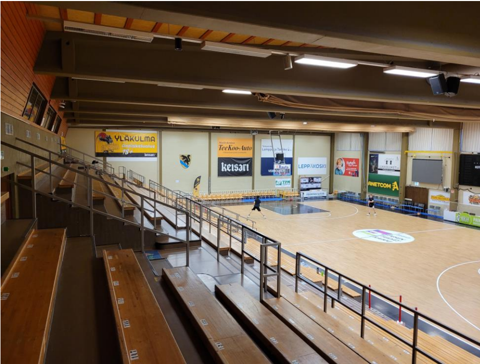
Kuva 24. Liikuntahallin lattia on siirtoparkettia. Kahdeksan metrin korkuisessa tilassa on katon rajassa sijaitsevat suuret ikkunat kaakon suuntaan.
