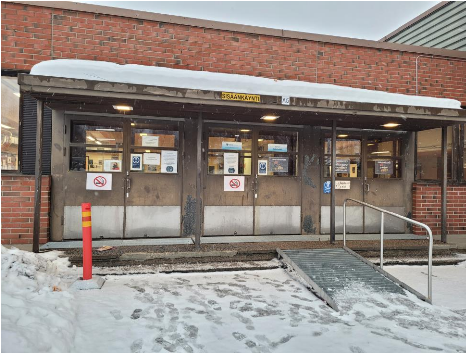
Kuva 16. Palloiluhallin pääsisäänkäynti sijaitsee rakennuksen matalamman välisiiven lounaisella sivulla. Tuulikaapin kautta sisääntuloaulaan vievien alumiiniovien yläpuolella on peltinen suojakatos.
