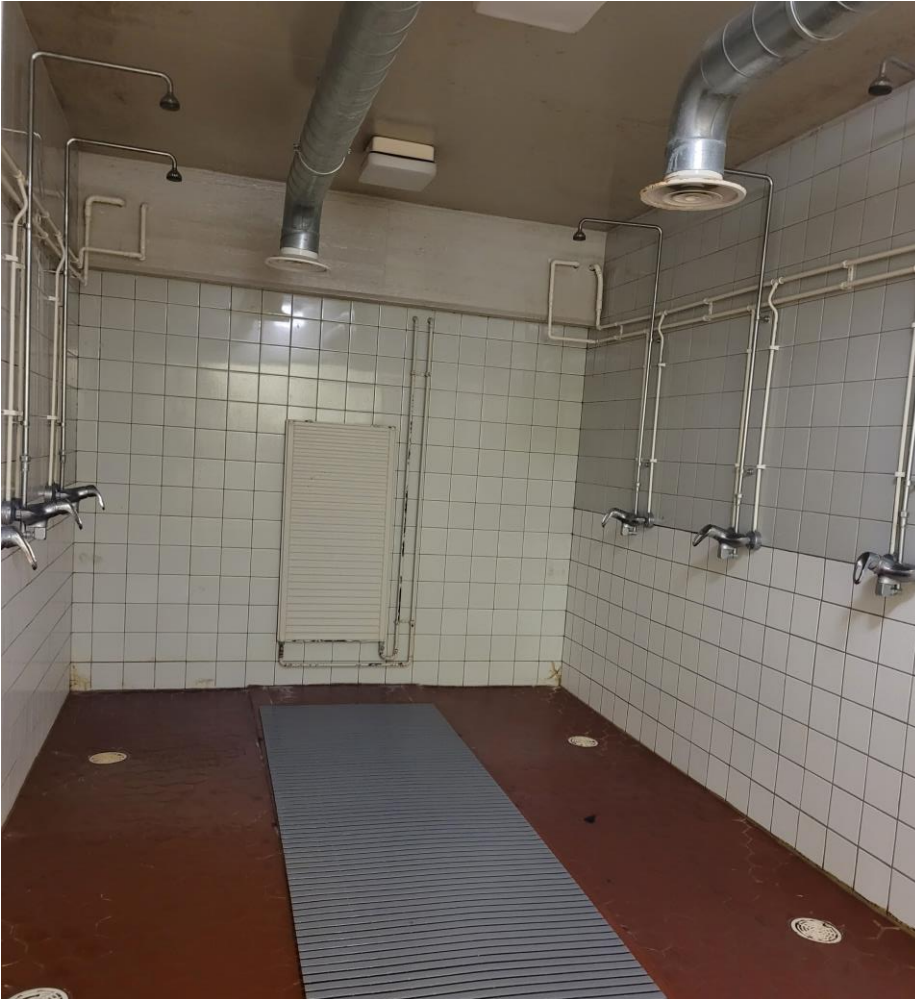
Kuva 30. Pukuhuoneiden suihkutiloja ei ole jaettu yksittäisiin koppeihin. Suihkutilat ovat huonokuntoiset ja askeettiset.
