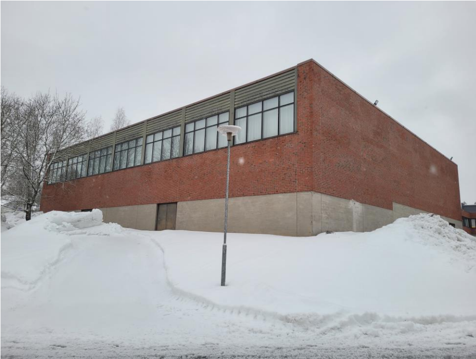
Kuva 8. Palloiluhallin kaakkoinen ja koillinen julkisivu puiston puolelta kuvattuna. Hallin puistonpuoleiset sivut ovat suurta ikkunarivistöä lukuun ottamatta ilmeettömiä ja tasaisia.
