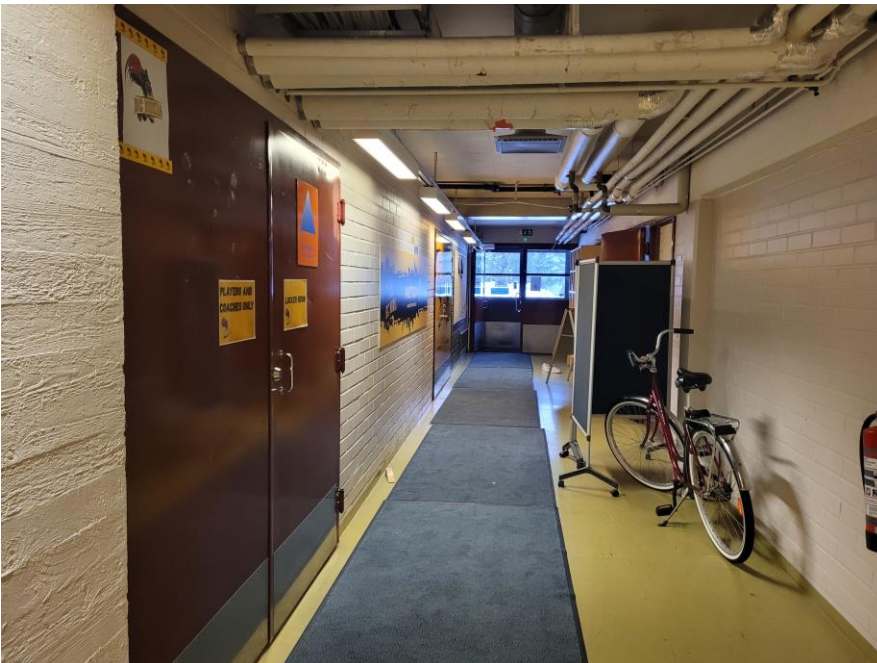
Kuva 23. Pelaajien ja henkilökunnan sisäänkäynti johtaa suoraan pukuhuoneisiin ja kentälle. Koillisen sisäänkäynnin lattia on seinille taitettua muovimattoa ja seinät valkoiseksi maalattua betonia ja tiiliseinää. Katon talotekniikka on jätetty esille.
