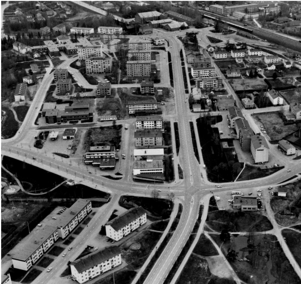
Kuva: 25 Lentokuva vuodelta 1979. Etualalla Poutuntien asuinrakennuksia, pohjoisosassa Kavolinkadun asuinrakennukset. Keskellä Nokianvaltatie. Valokuva Tuomas Koponen https://oloneuvos.kuvat.fi/ .
