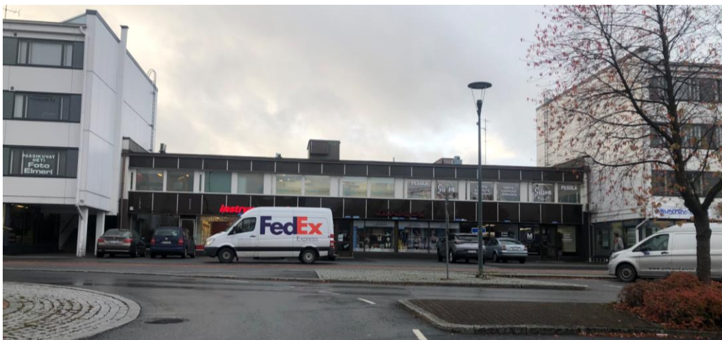
Kuva: 84 Massoitelun vaihtelua Välikadun suuntaan. Vasemmalta lähtien kohteet 16, 15 ja 14.
