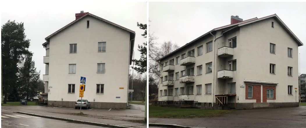
Kuva: 75 Päätyjulkisivuja Poutuntien suuntaan.
