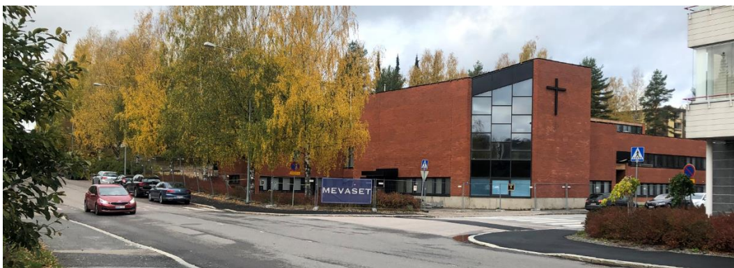
Kuva: 20 Ev.lut. seurakuntakeskus vuodelta 1979 Maununkadun ja Korkeemäenkadun risteyksessä odottaa purkua inventointihetkellä 10/2020.
