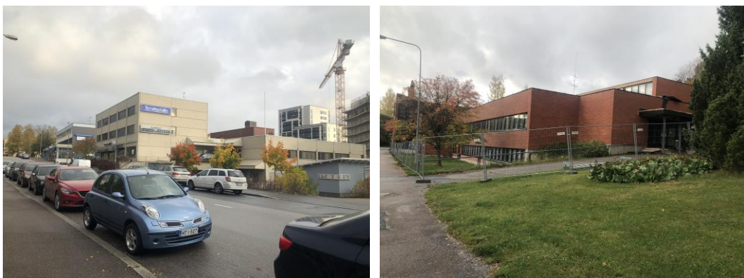
Kuva: 61 Vasemmalla: Näkymä Korkeemäenkadulta pohjoiseen. Oikealla: Ev. lut seurakuntakeskus Korkeemäenkadun suunnasta kohti Maununkatua.
