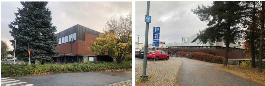
Kuva: 82. Vasemmalla: Tuuliharjunkadun ja Poutuntien risteyksessä sijaitsevan Helluntaiseurakunnan julkisivu (kohde nro 13). Oikealla: uimahalli (kohde nro 12) sijaitsee Välikadun ja Välimäenkadun risteyksessä. Sen takapiha aukeaa puistomaisena Tuuliharjunkatua ja Poutunpuistoa kohti.
